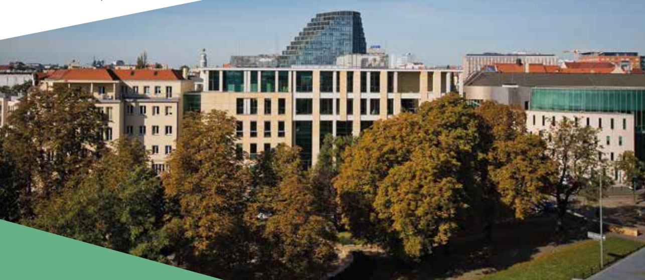
Widok na budynek C oraz D
