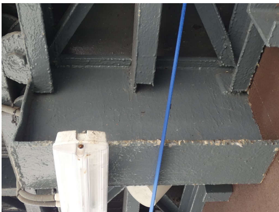
Fot. 133, 134 Kondygnacja 7 (Poziom +28.50) Elewacja Wschodnia – wspornik w osiach 14/G. Brak widocznych uszkodzeń wspornika.
