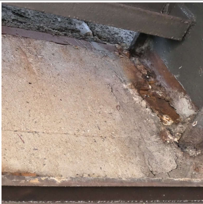
Fot. 102 Kondygnacja 7 (Poziom +28.50) Elewacja Zachodnia – belka w osiach 10/F-G. Przestrzeń między elementami wypełniona zaprawą i gruzem. Zarysowania powierzchni zaprawy. Brak widocznych uszkodzeń belki przy podporze.
