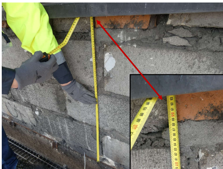
Fot. 20 Kondygnacja 7 (Poziom +28.50) Elewacja Wschodnia – widok ściany murowanej w osiach 14/H-I. Wysokość ściany murowanej ~95 cm. Grubość podlewki między belką żelbetową a ścianą ~6 cm. Element murowy bezpośrednio pod profilem stalowym (brak podlewki).
