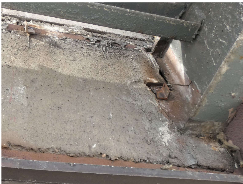
Fot. 125 Wspornik stalowy w miejscu oparcia belek żelbetowych (widok z dołu)
