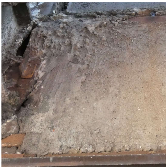
Fot. 100 Kondygnacja 7 (Poziom +28.50) Elewacja Zachodnia – belka w osiach 10/F-G. Spękania i zarysowania powierzchni zaprawy. Brak widocznych uszkodzeń belki przy podporze.
