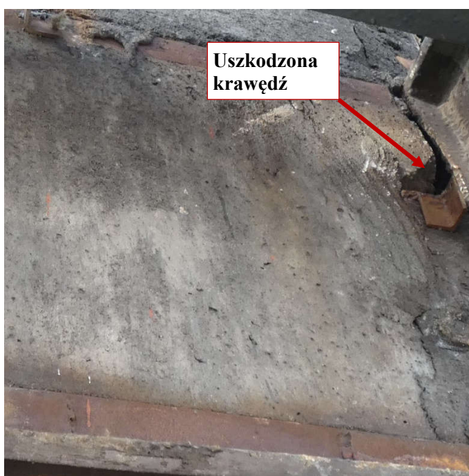
Fot. 67 Kondygnacja 7 (Poziom +28.50) Elewacja Wschodnia – belka w osiach 14/H-I. Uszkodzona krawędź elementu. Spękania i zarysowania powierzchni zaprawy.
