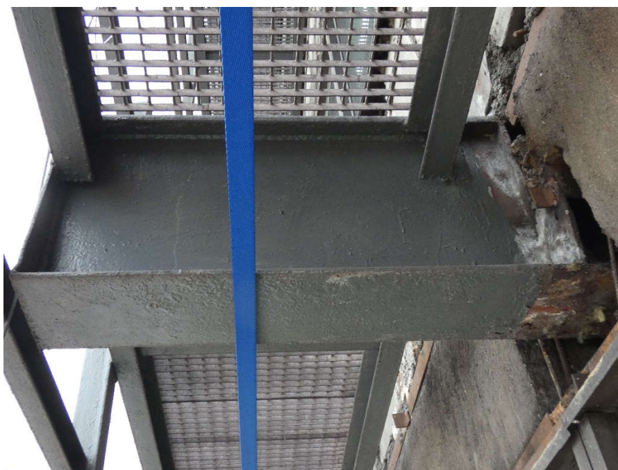
Fot. 167, 168 Kondygnacja 7 (Poziom +28.50) Elewacja Południowa – wspornik w osiach 12/E. Brak widocznych uszkodzeń wspornika.
