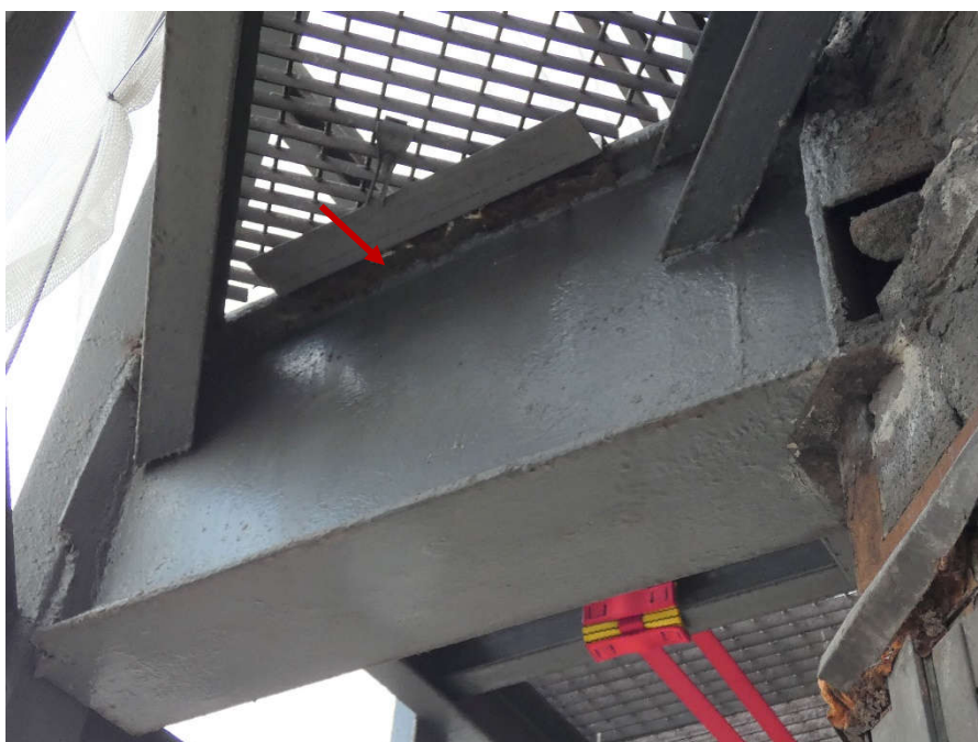
Fot. 171, 172 Kondygnacja 7 (Poziom +28.50) Elewacja Południowa – wspornik w osiach 14/E. Ślady korozji pasa górnego. Brak widocznych uszkodzeń wspornika.
