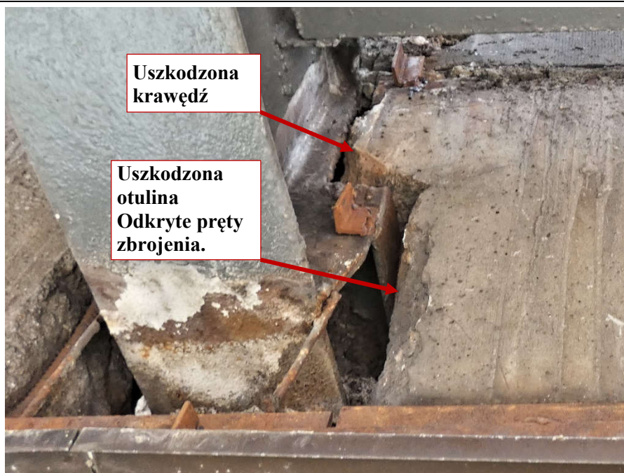
Fot. 120 Kondygnacja 7 (Poziom +28.50) Elewacja Południowa – belka w osiach 13-14/E. Uszkodzona otulina. Odkryte pręty zbrojenia. Brak podlewki wspornika stalowego.
