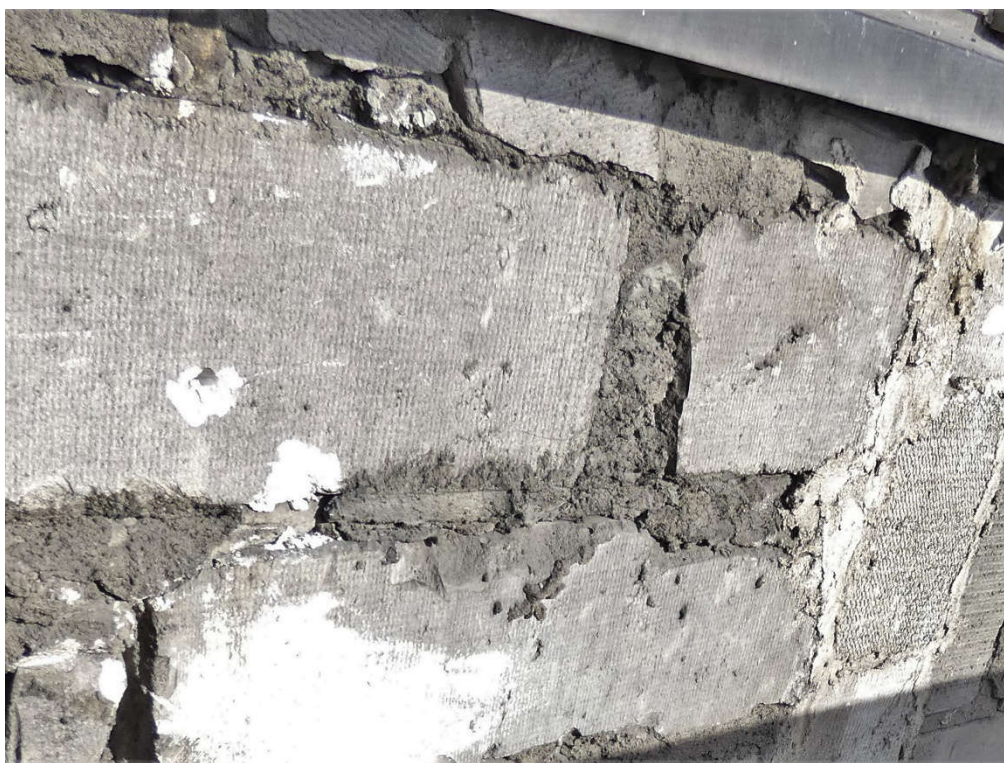
Fot. 11 Przykład zwińczenia ściany zaprawą i gruzem.
