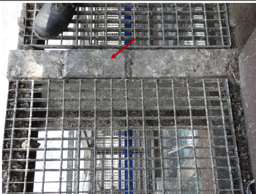
Fot. 132 Kondygnacja 7 (Poziom +28.50) Elewacja Wschodnia – wspornik w osiach 14/F (widok z góry) Pozostałości po drabinie ewakuacyjnej. Brak widocznych uszkodzeń wspornika.
