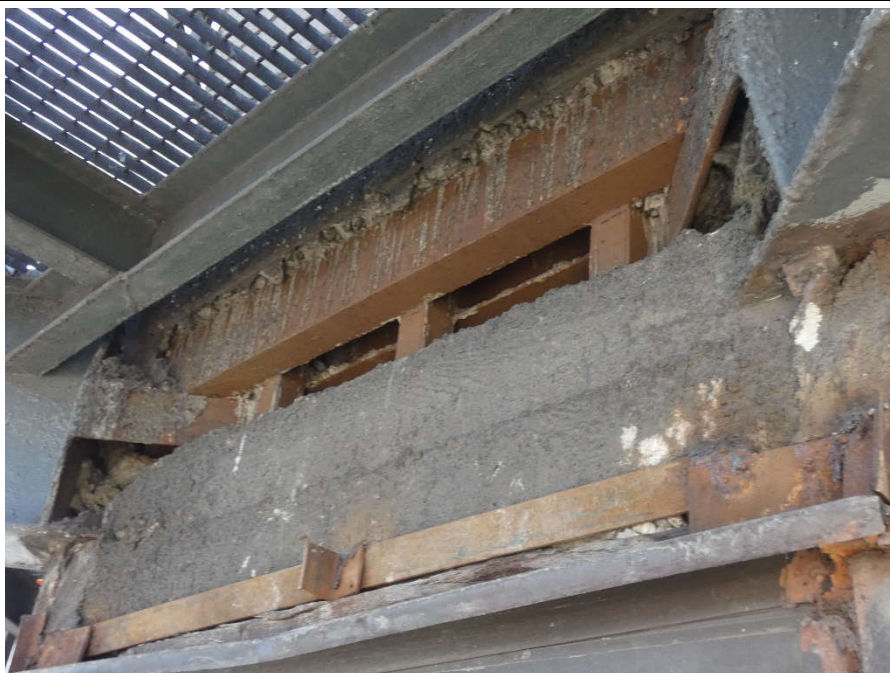
Fot. 68 Kondygnacja 7 (Poziom +28.50) Elewacja Wschodnia – belka w osiach 14/I. Całkowite odkrycie stalowych profili ceowych opartych na wspornikach stalowych.
