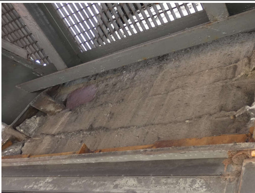
Fot. 108 Kondygnacja 7 (Poziom +28.50) Elewacja Zachodnia – belka w osiach 10/E.
