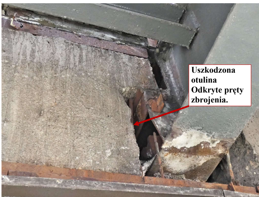
Fot. 119 Kondygnacja 7 (Poziom +28.50) Elewacja Południowa – belka w osiach 12-13/E. Uszkodzona otulina. Odkryte pręty zbrojenia. Brak podlewki wspornika stalowego.
