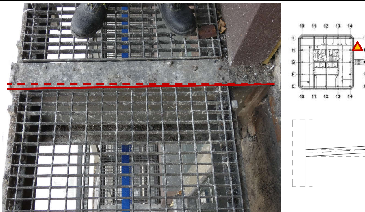
Fot. 137 Kondygnacja 7 (Poziom +28.50) Elewacja Wschodnia – wspornik w osiach 14/H (widok z góry) Przemieszczenie wspornika w kierunku osi I. Brak widocznych uszkodzeń wspornika.
