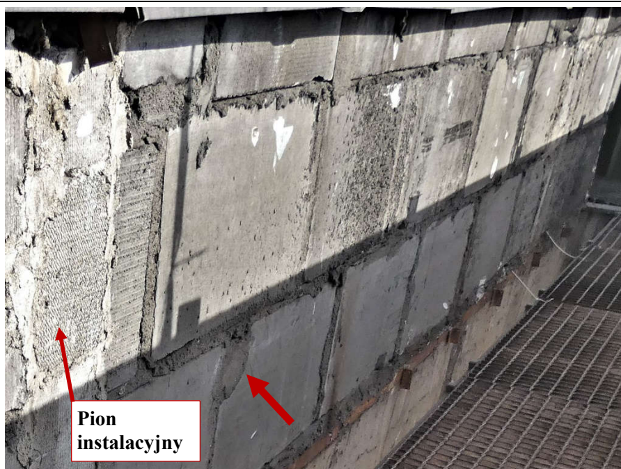
Fot. 59 Kondygnacja 7 (Poziom +28.50) Elewacja Południowa – widok ściany murowanej w osiach 13-14/E. Zbyt duże wymiary spoin. Wykonanie ściany z uszkodzonych elementów murowych 36x60 cm. Zwieńczenie ściany z elementów murowych 12x60 cm. Wypełnienie ubytków między elementami i uszkodzonych miejsc zaprawą. Zamknięcie pionu instalacyjnego.
