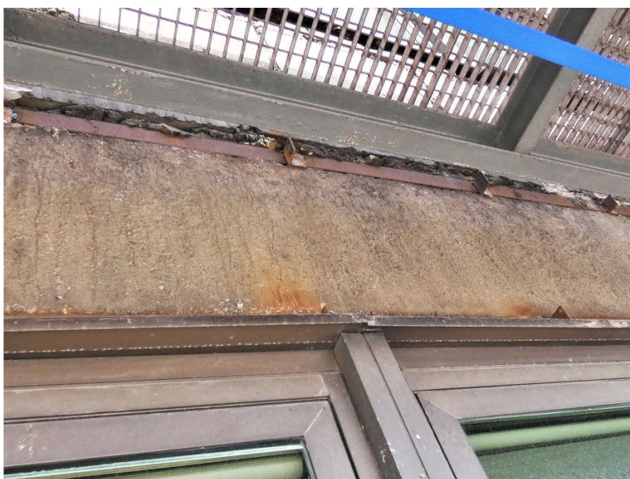
Fot. 114 Kondygnacja 7 (Poziom +28.50) Elewacja Południowa – belka w osiach 11-12/E. Brak widocznych uszkodzeń belki w przęśle
