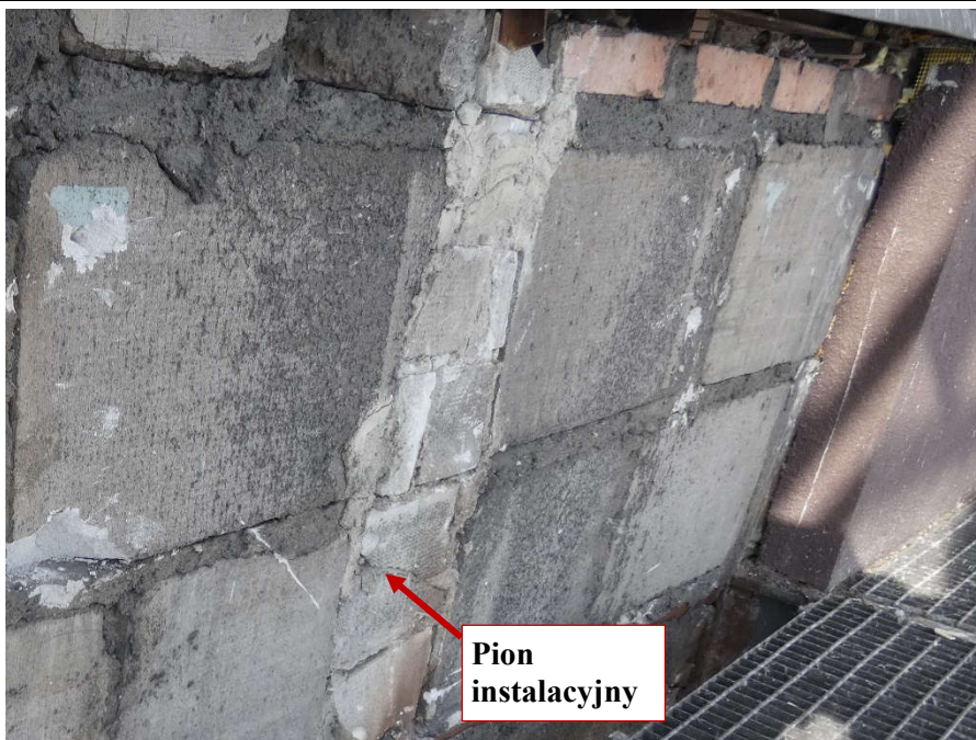
Fot. 17 Kondygnacja 7 (Poziom +28.50) Elewacja Wschodnia – widok ściany murowanej w osiach 14/E-F. Zbyt duże wymiary spoin. Zwieńczenie ściany z ceramicznych elementów murowanych gr. 6,5 cm. Pion instalacyjny zamknięty zaprawą i gruzem.
