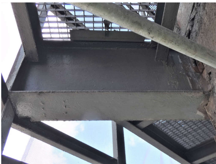
Fot. 140, 141 Kondygnacja 7 (Poziom +28.50) Elewacja Północna – wspornik w osiach 14/I. Ślady korozji pasa górnego. Brak widocznych uszkodzeń wspornika.
