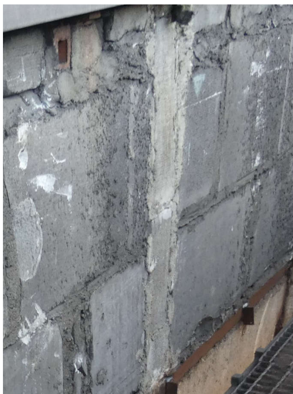
Fot. 14 Zamknięcie pionu instalacyjnego
