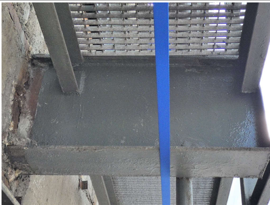
Fot. 159 Kondygnacja 7 (Poziom +28.50) Elewacja Zachodnia– wspornik w osiach 10/F (widok z dołu) Brak widocznych uszkodzeń wspornika.
