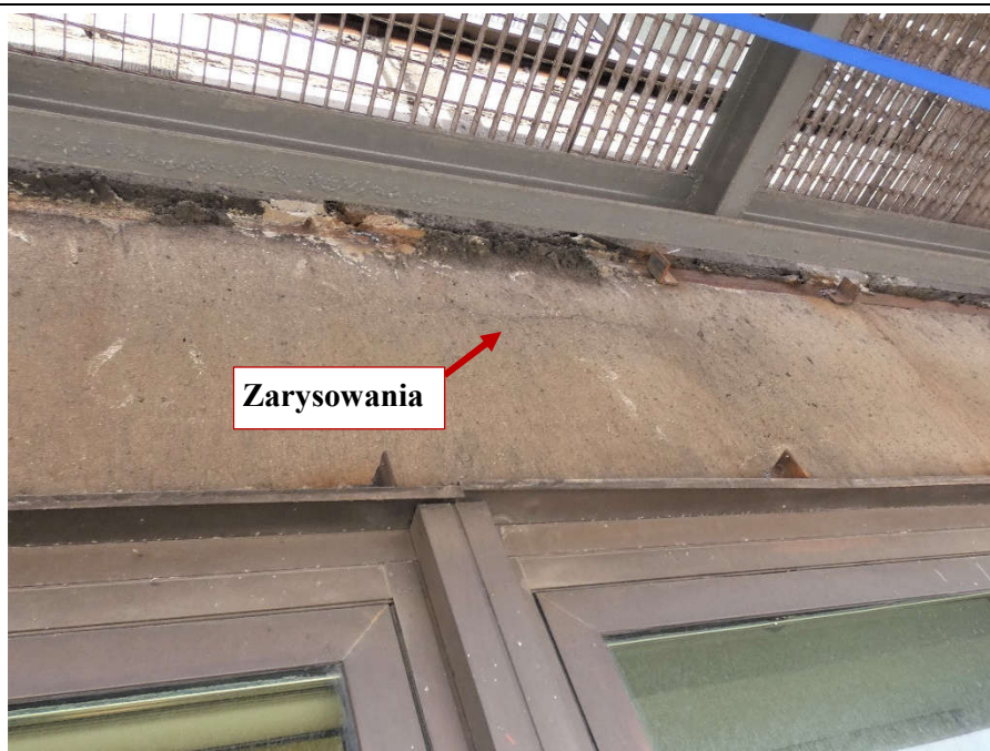
Fot. 111 Kondygnacja 7 (Poziom +28.50) Elewacja Południowa – belka w osiach 10-11/E. Zarysowanie belki w przęśle na wysokości miejsca oparcia.
