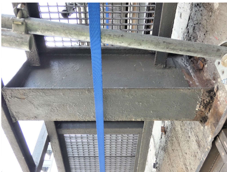
Fot. 142, 143 Kondygnacja 7 (Poziom +28.50) Elewacja Północna – wspornik w osiach 13/I. Brak widocznych uszkodzeń wspornika.
