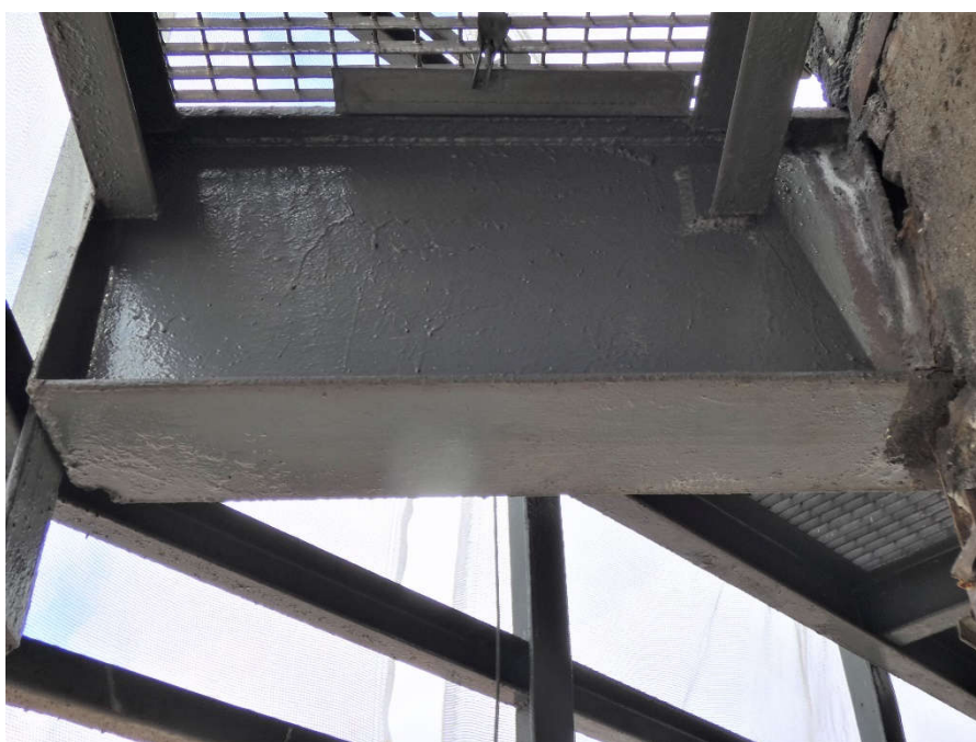
Fot. 151, 152 Kondygnacja 7 (Poziom +28.50) Elewacja Zachodnia– wspornik w osiach 10/I (widok z dołu) Brak widocznych uszkodzeń wspornika.
