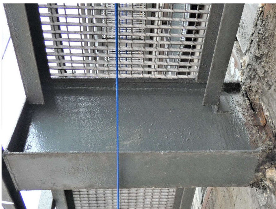
Fot. 157, 158 Kondygnacja 7 (Poziom +28.50) Elewacja Zachodnia– wspornik w osiach 10/G. Brak widocznych uszkodzeń wspornika.
