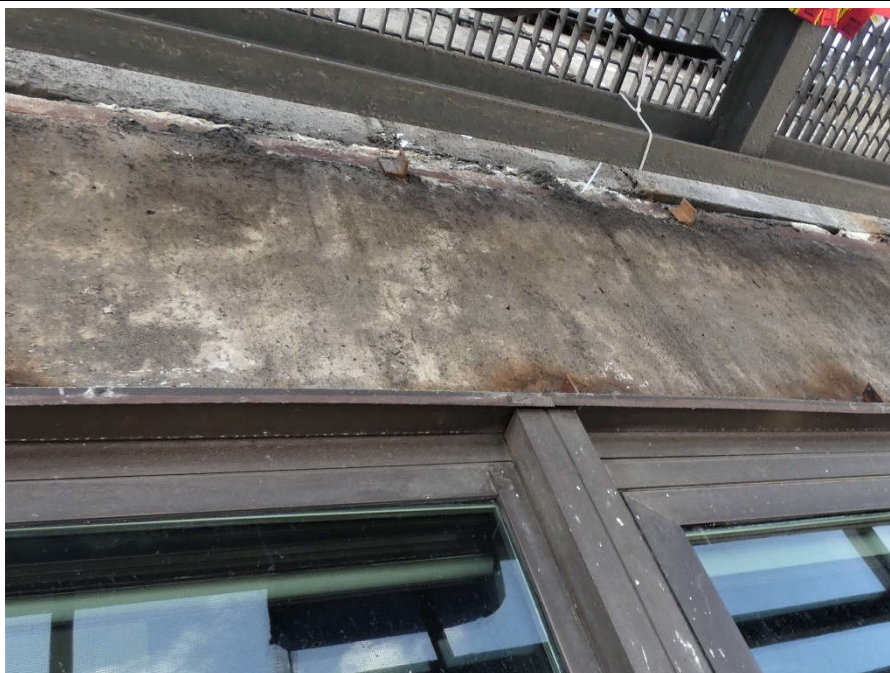
Fot. 66 Kondygnacja 7 (Poziom +28.50) Elewacja Wschodnia – belka w osiach 14/H-I. Brak widocznych uszkodzeń belki w przęśle.
