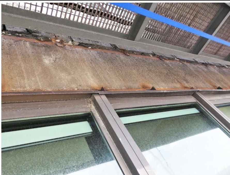
Fot. 118 Kondygnacja 7 (Poziom +28.50) Elewacja Południowa – belka w osiach 12-13/E. Brak widocznych uszkodzeń belki w przęśle.
