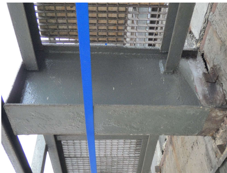
Fot. 154, 155 Kondygnacja 7 (Poziom +28.50) Elewacja Zachodnia– wspornik w osiach 10/H (widok z dołu) Brak widocznych uszkodzeń wspornika.
