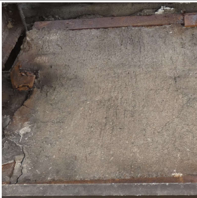
Fot. 113 Kondygnacja 7 (Poziom +28.50) Elewacja Południowa – belka w osiach 11-12/E. Spękania i zarysowania powierzchni zaprawy. Brak widocznych uszkodzeń belki przy podporze.
