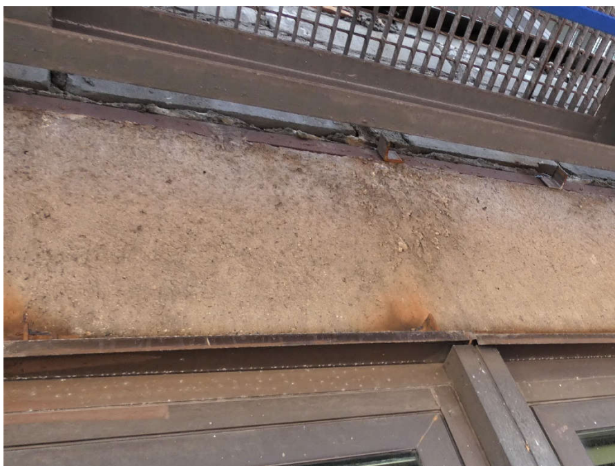
Fot. 101 Kondygnacja 7 (Poziom +28.50) Elewacja Zachodnia – belka w osiach 10/F-G. Brak widocznych uszkodzeń belki w przęśle.
