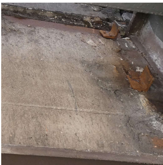
Fot. 112 Kondygnacja 7 (Poziom +28.50) Elewacja Południowa – belka w osiach 10-11/E. Przestrzeń między elementami wypełniona zaprawą. Zarysowania powierzchni zaprawy. Brak widocznych uszkodzeń belki przy podporze.
