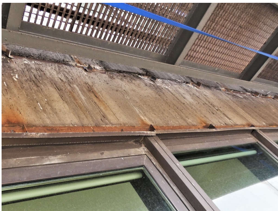
Fot. 121 Kondygnacja 7 (Poziom +28.50) Elewacja Południowa – belka w osiach 13-14/E. Brak widocznych uszkodzeń belki w przęśle.
