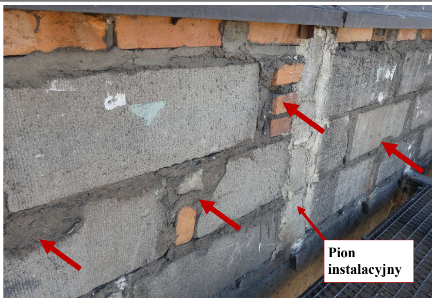
Fot. 25 Kondygnacja 7 (Poziom +28.50) Elewacja Północna – widok ściany murowanej w osiach 13-14/I.
