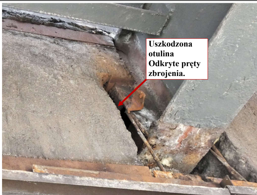
Fot. 115 Kondygnacja 7 (Poziom +28.50) Elewacja Południowa – belka w osiach 11-12/E. Uszkodzona otulina. Odkryte pręty zbrojenia. Brak podlewki wspornika stalowego.
