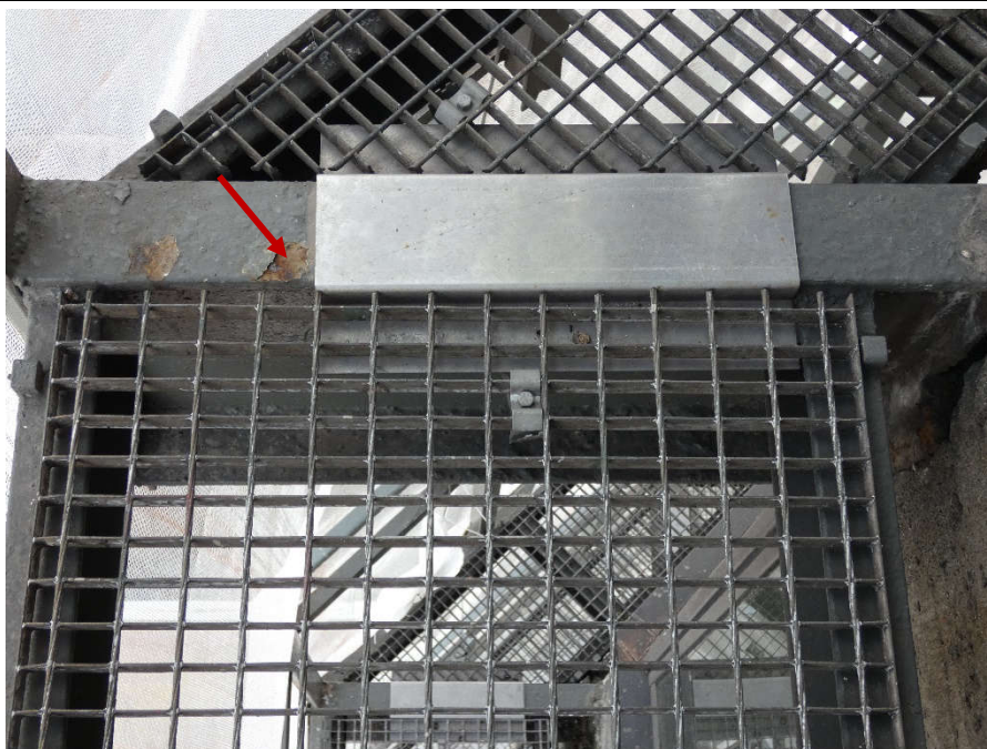
Fot. 153 Kondygnacja 7 (Poziom +28.50) Elewacja Zachodnia– wspornik w osiach 10/I (widok z góry) Ślady korozji pasa górnego. Brak widocznych uszkodzeń wspornika.
