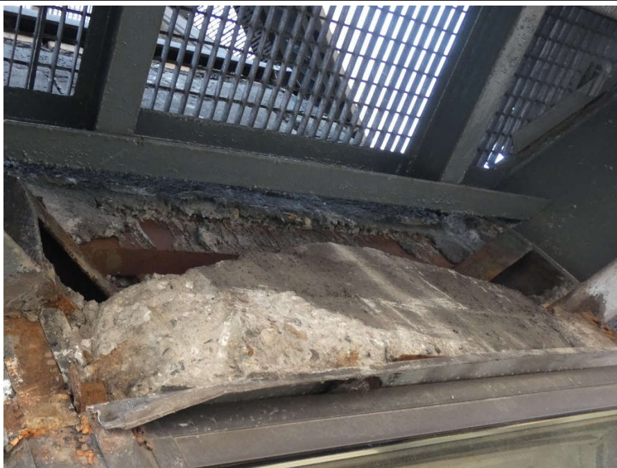
Fot. 89 Kondygnacja 7 (Poziom +28.50) Elewacja Północna – belka w osiach 10/I. Całkowite odkrycie stalowych profili ceowych opartych na wspornikach stalowych.
