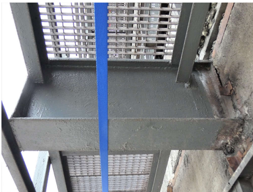
Fot. 165, 166 Kondygnacja 7 (Poziom +28.50) Elewacja Południowa – wspornik w osiach 11/E. Brak widocznych uszkodzeń wspornika.
