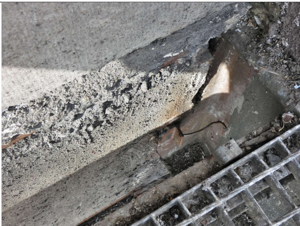
Fot. 124 Wspornik stalowy w miejscu oparcia belek żelbetowych (widok z góry)
