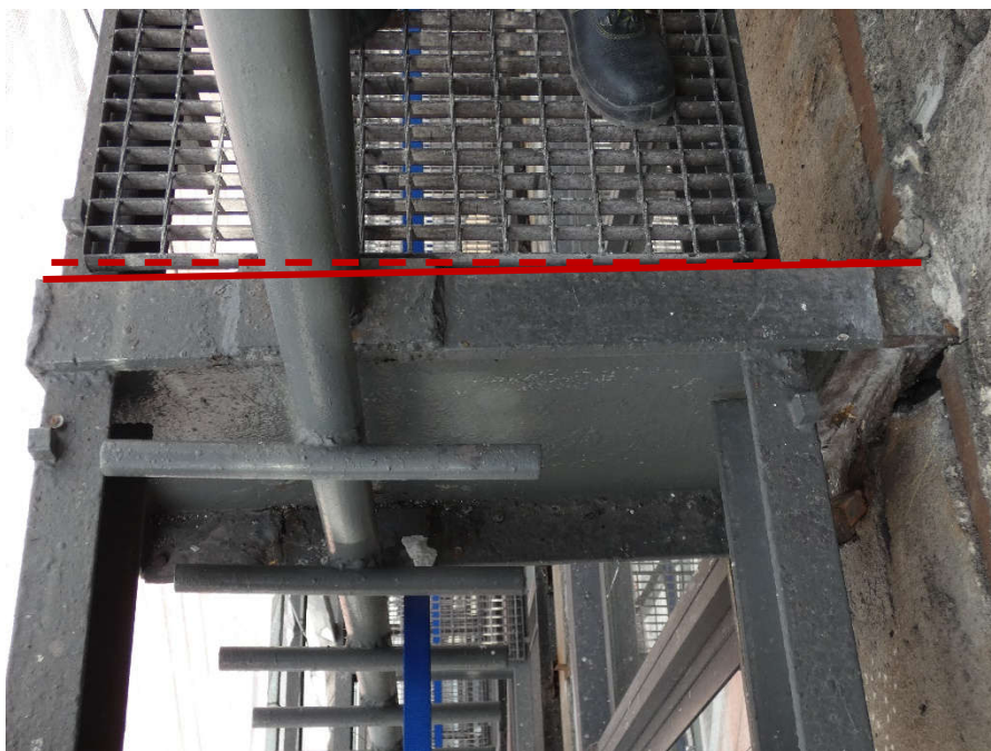
Fot. 160 Kondygnacja 7 (Poziom +28.50) Elewacja Zachodnia– wspornik w osiach 10/F (widok z góry) Przemieszczenia wspornika w kierunku osi E. Brak widocznych uszkodzeń wspornika.
