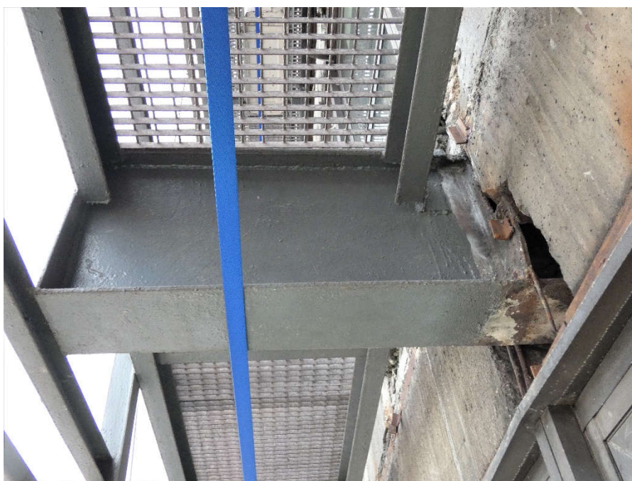
Fot. 169, 170 Kondygnacja 7 (Poziom +28.50) Elewacja Południowa – wspornik w osiach 13/E. Przemieszczenie wspornika w kierunku osi 14. Brak widocznych uszkodzeń wspornika.
