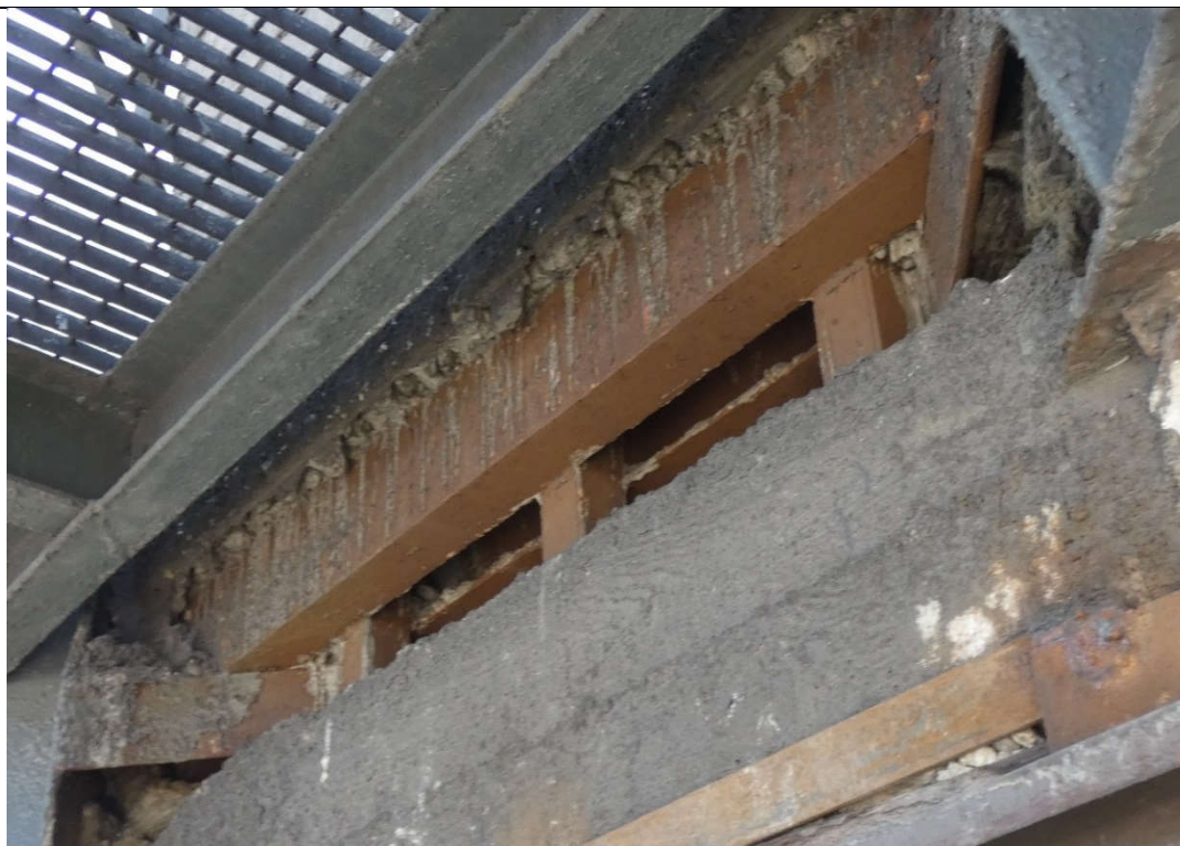
Fot. 173 Konstrukcja naroża nad kondygnacją 7
