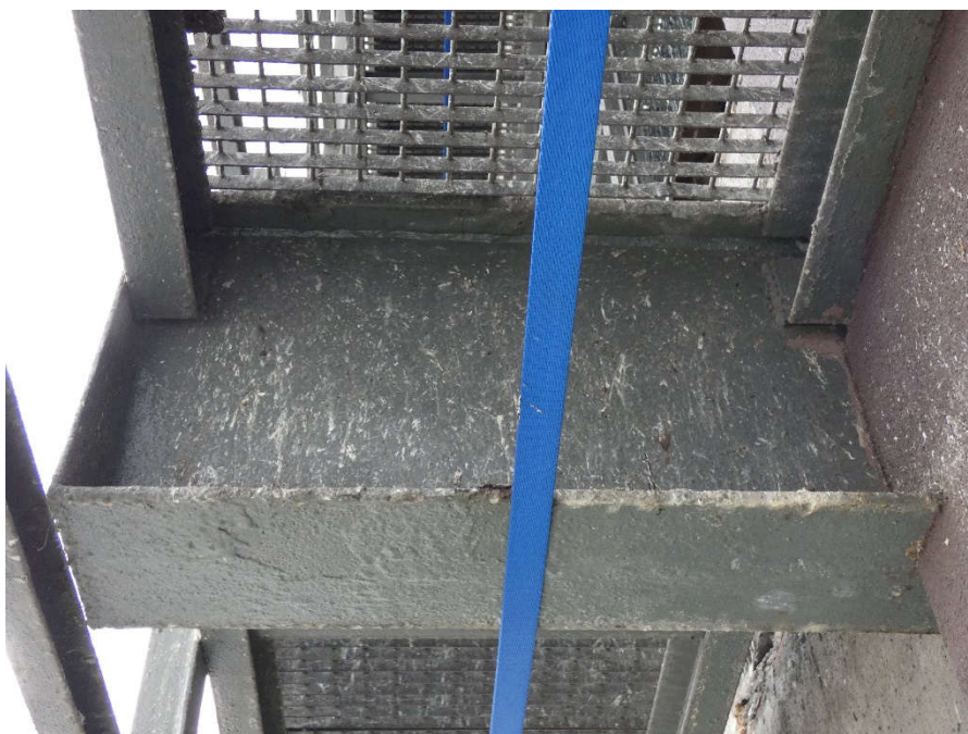
Fot. 130, 131 Kondygnacja 7 (Poziom +28.50) Elewacja Wschodnia – wspornik w osiach 14/F (widok z dołu) Brak widocznych uszkodzeń wspornika.
