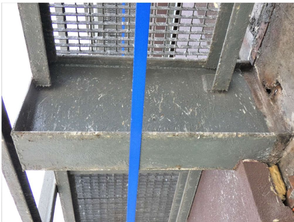
Fot. 126 Wspornik stalowy (widok z boku)
