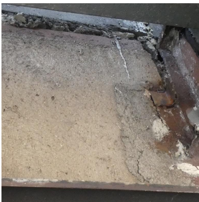
Fot. 91 Kondygnacja 9 (Poziom +35.10) Elewacja Zachodnia – belka w osiach 10/H-I. Przestrzeń między elementami wypełniona gruzem i zaprawą. Zarysowania powierzchni zaprawy. Brak widocznych uszkodzeń belki przy podporze.
