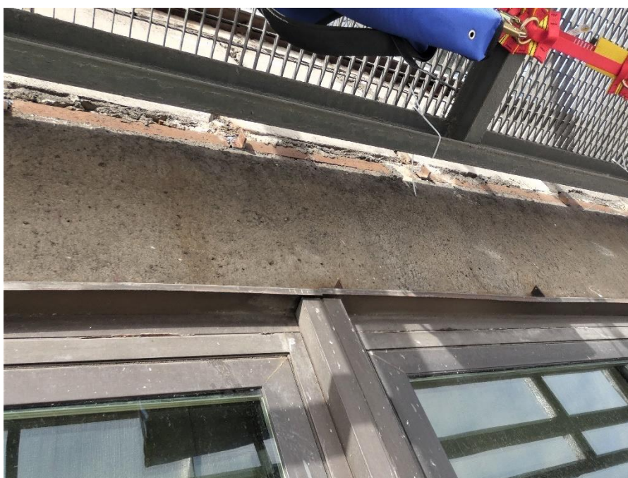
Fot. 70 Kondygnacja 9 (Poziom +35.10) Elewacja Wschodnia – belka w osiach 14/H-I. Brak widocznych uszkodzeń belki w przęśle.
