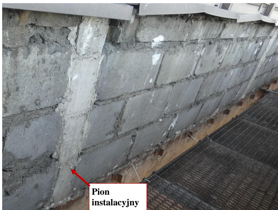
Fot. 36 Kondygnacja 9 (Poziom +35.10) Elewacja Zachodnia – widok ściany murowanej w osiach 10/H-I.
