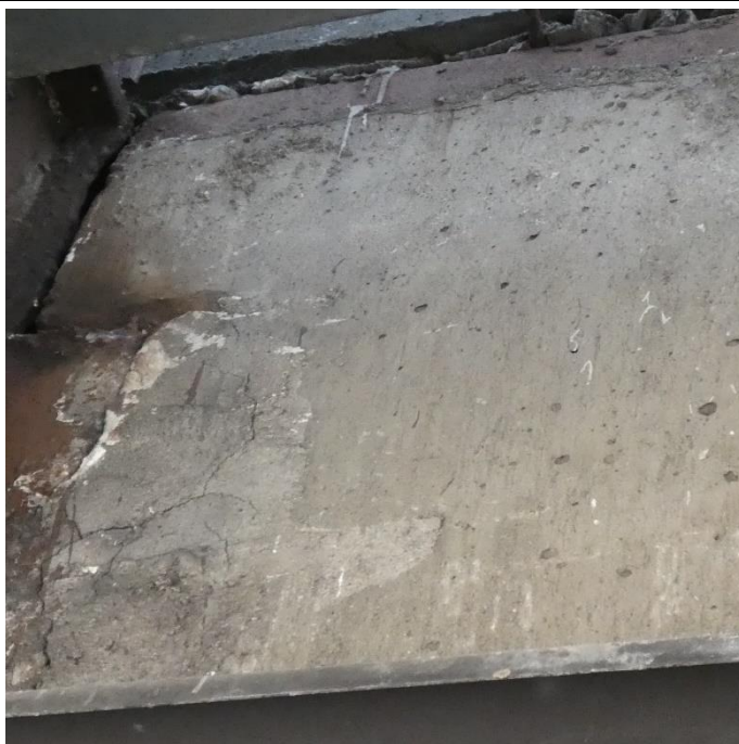
Fot. 92 Kondygnacja 9 (Poziom +35.10) Elewacja Zachodnia – belka w osiach 10/G-H. Zarysowania powierzchni zaprawy. Brak widocznych uszkodzeń belki przy podporze.
