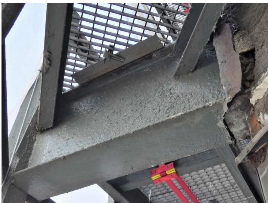
Fot. 134, 135 Kondygnacja 9 (Poziom +35.10) Elewacja Wschodnia – wspornik w osiach 14/I. Brak widocznych uszkodzeń wspornika.
