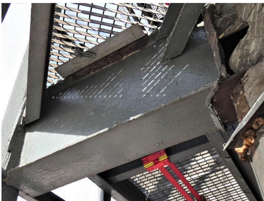
Fot. 157, 158 Kondygnacja 9 (Poziom +35.10) Elewacja Zachodnia– wspornik w osiach 10/E. Brak widocznych uszkodzeń wspornika.
