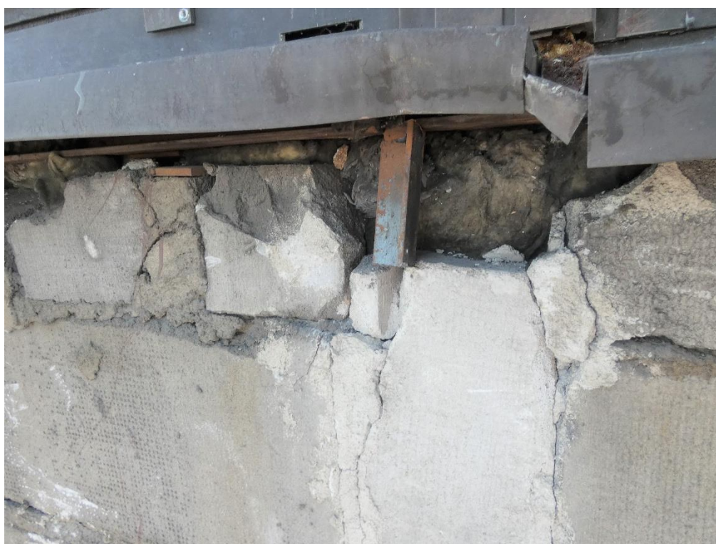
Fot. 9 Przykład zwieńczenia ściany gruzem.
