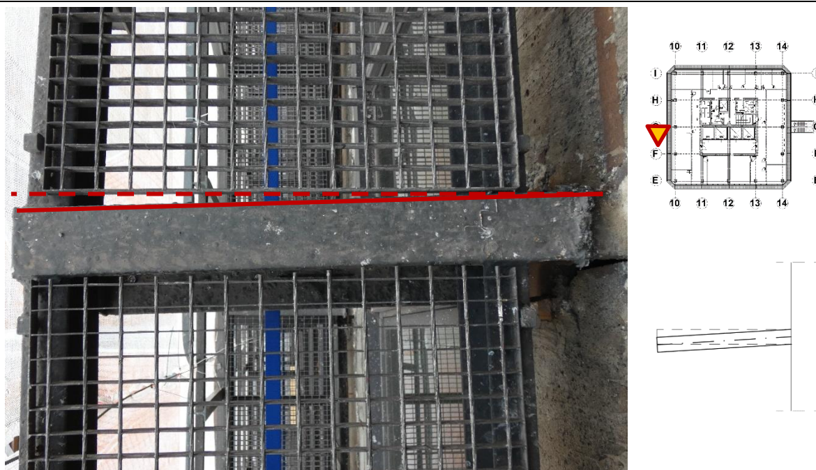
Fot. 153 Kondygnacja 9 (Poziom +35.10) Elewacja Zachodnia– wspornik w osiach 10/G (widok z góry) Przemieszczenie wspornika w kierunku osi F. Brak widocznych uszkodzeń wspornika.
