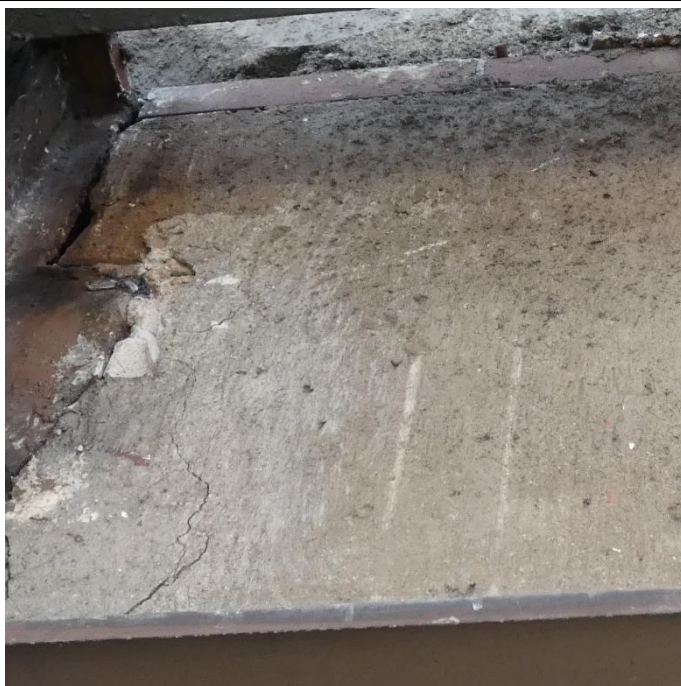
Fot. 82 Kondygnacja 9 (Poziom +35.10) Elewacja Północna – belka w osiach 11-12/I. Zarysowania powierzchni zaprawy. Brak widocznych uszkodzeń belki przy podporze.
