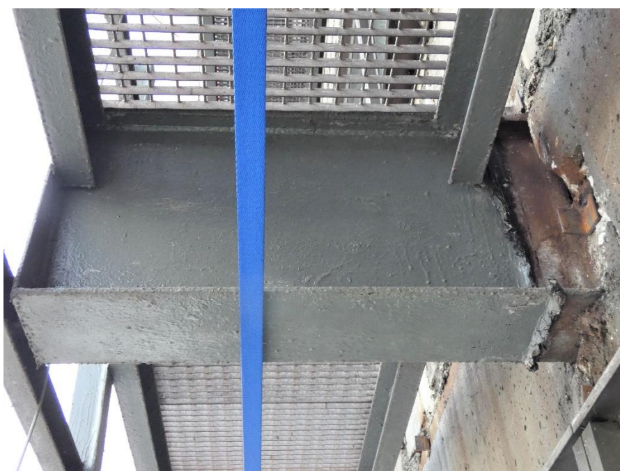
Fot. 164, 165 Kondygnacja 9 (Poziom +35.10) Elewacja Południowa – wspornik w osiach 12/E. Brak widocznych uszkodzeń wspornika.
