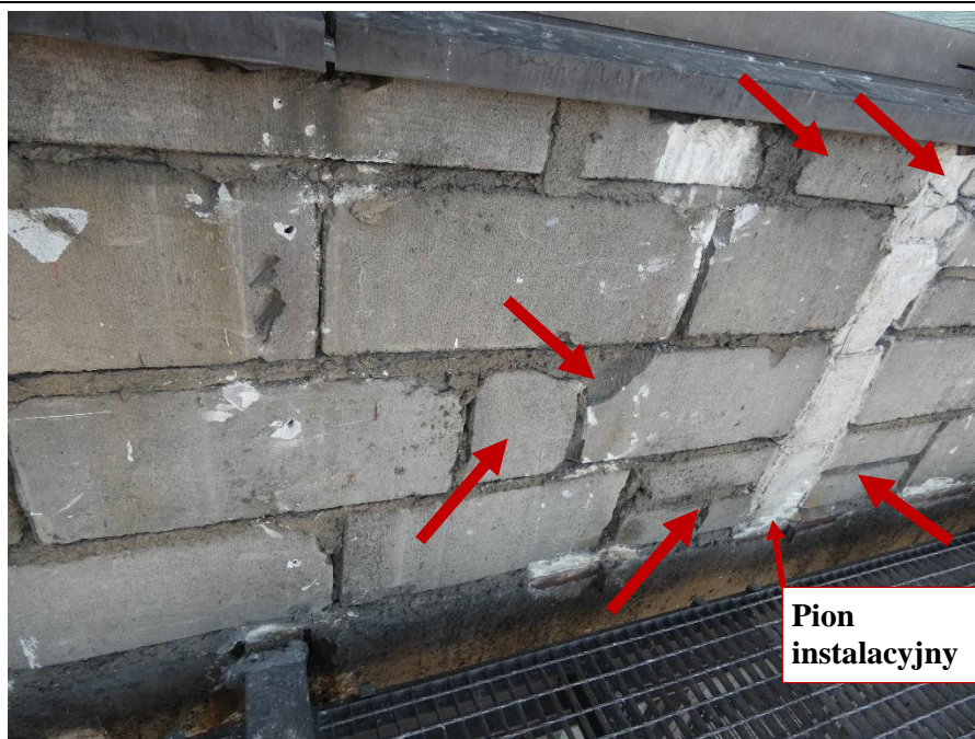
Fot. 31 Kondygnacja 9 (Poziom +35.10) Elewacja Północna – widok ściany murowanej w osiach 10-11/I.
