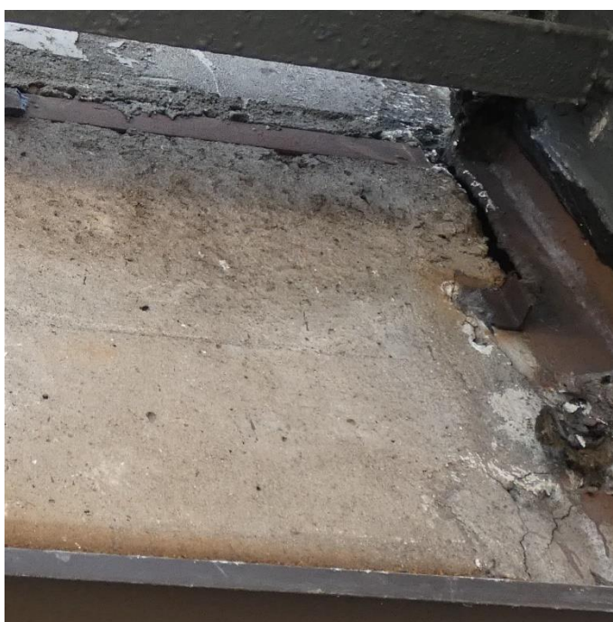
Fot. 87 Kondygnacja 9 (Poziom +35.10) Elewacja Północna – belka w osiach 10-11/I. Zarysowania powierzchni zaprawy. Brak widocznych uszkodzeń belki przy podporze.
