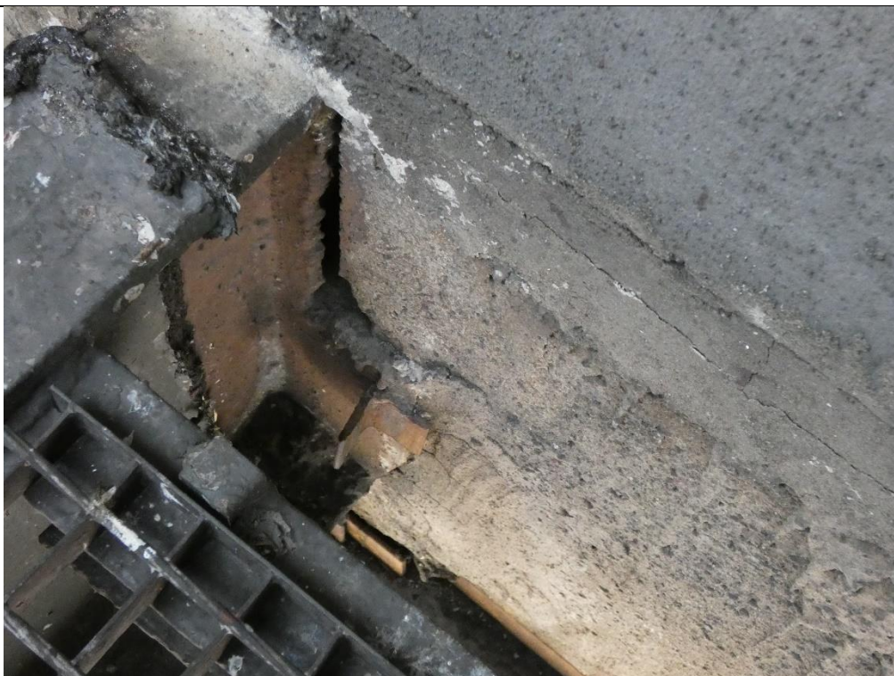
Fot. 120 Wspornik stalowy w miejscu oparcia belek żelbetowych (widok z góry)
