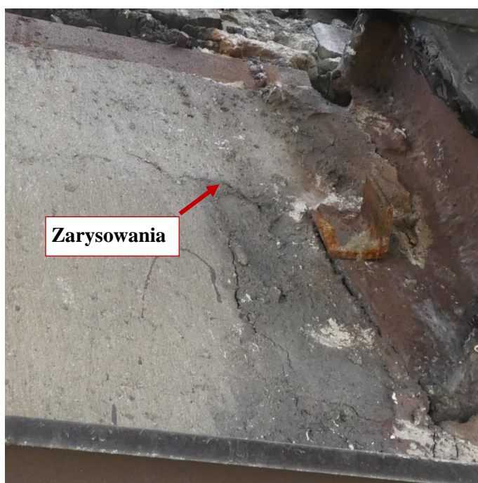
Fot. 106 Kondygnacja 9 (Poziom +35.10) Elewacja Południowa – belka w osiach 10-11/E. Przestrzeń między elementami wypełniona zaprawą. Zarysowanie belki na wysokości miejsca oparcia. Zarysowania powierzchni zaprawy.
