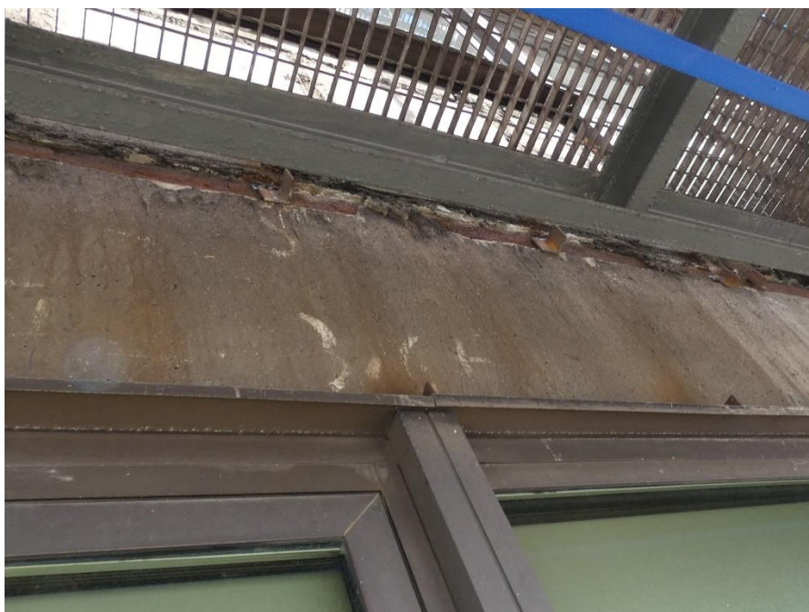
Fot. 112 Kondygnacja 9 (Poziom +35.10) Elewacja Południowa – belka w osiach 12-13/E. Brak widocznych uszkodzeń belki w przęśle.
