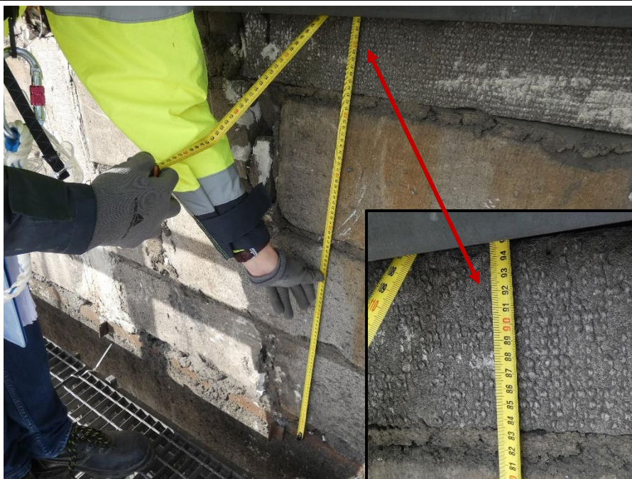
Fot. 19 Kondygnacja 9 (Poziom +35.10) Elewacja Wschodnia – widok ściany murowanej w osiach 14/H-I. Wysokość ściany murowanej ~95 cm. Grubość podlewki między belką żelbetową a ścianą ~6 cm. Element murowy bezpośrednio pod profilem stalowym (brak podlewki).
