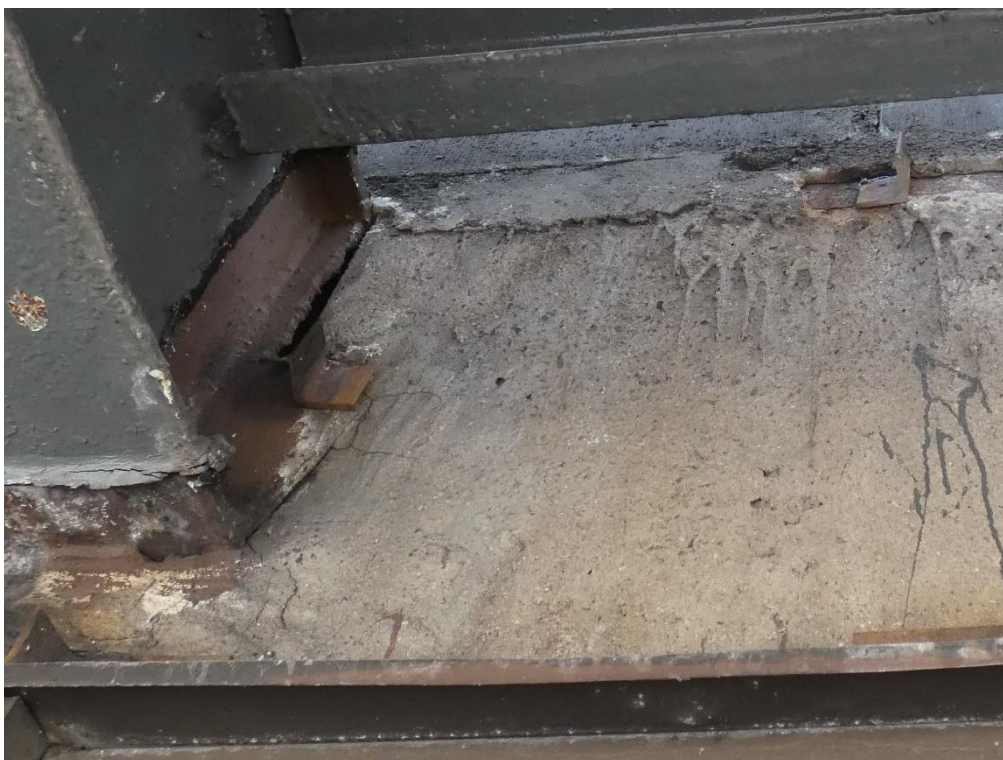
Fot. 121 Wspornik stalowy w miejscu oparcia belek żelbetowych (widok z dołu)
