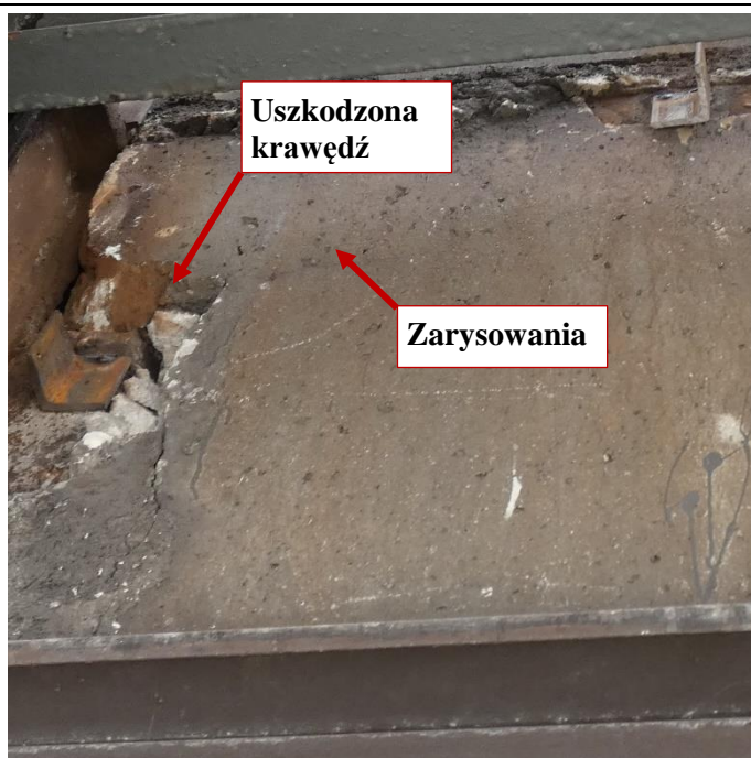
Fot. 111 Kondygnacja 9 (Poziom +35.10) Elewacja Południowa – belka w osiach 12-13/E. Uszkodzona krawędź elementu. Przestrzeń między elementami wypełniona zaprawą i gruzem. Zarysowanie belki na wysokości miejsca oparcia. Zarysowania powierzchni zaprawy.
