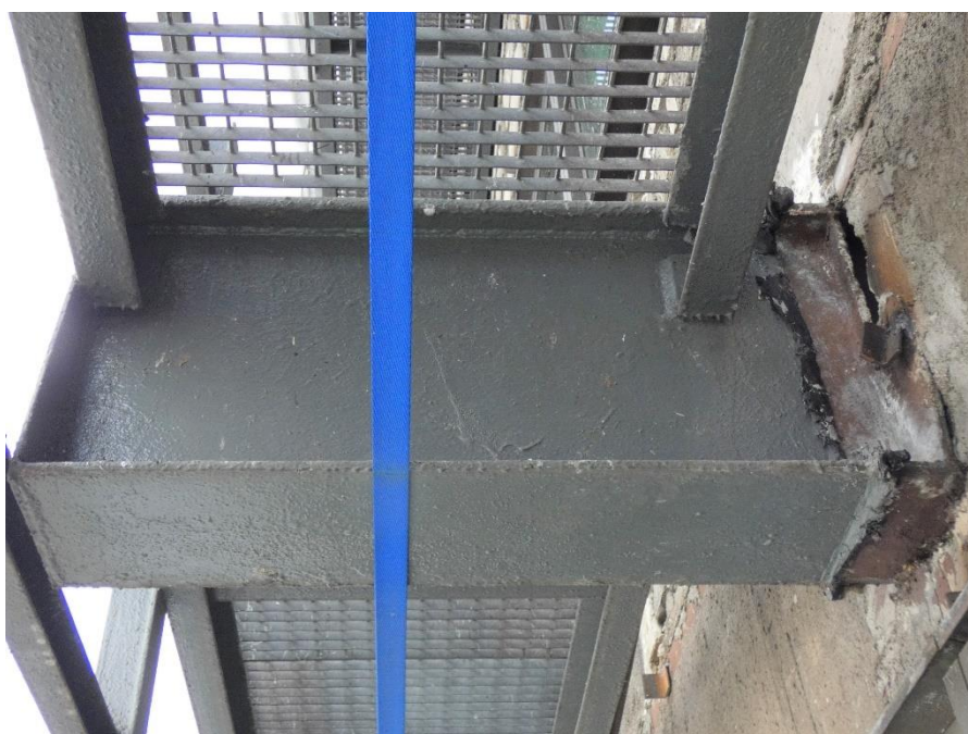
Fot. 142, 143 Kondygnacja 9 (Poziom +35.10) Elewacja Północna – wspornik w osiach 11/I. Brak widocznych uszkodzeń wspornika.
