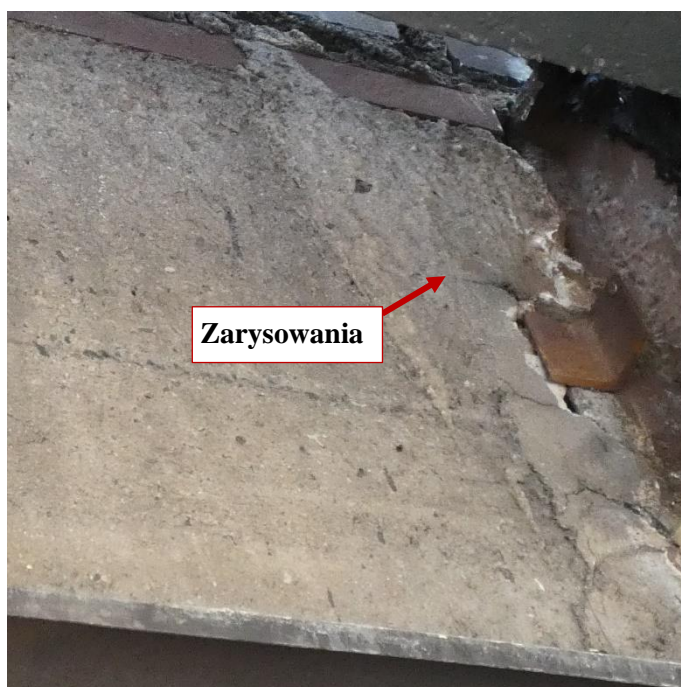
Fot. 97 Kondygnacja 9 (Poziom +35.10) Elewacja Zachodnia – belka w osiach 10/F-G. Zarysowanie belki na wysokości miejsca oparcia. Zarysowania powierzchni zaprawy.
