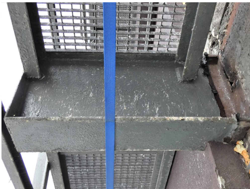
Fot. 122 Wspornik stalowy (widok z boku)
