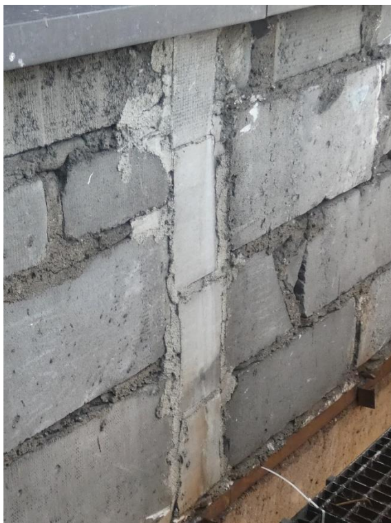
Fot. 12 Przykład zamknięcia pionu instalacyjnego.
