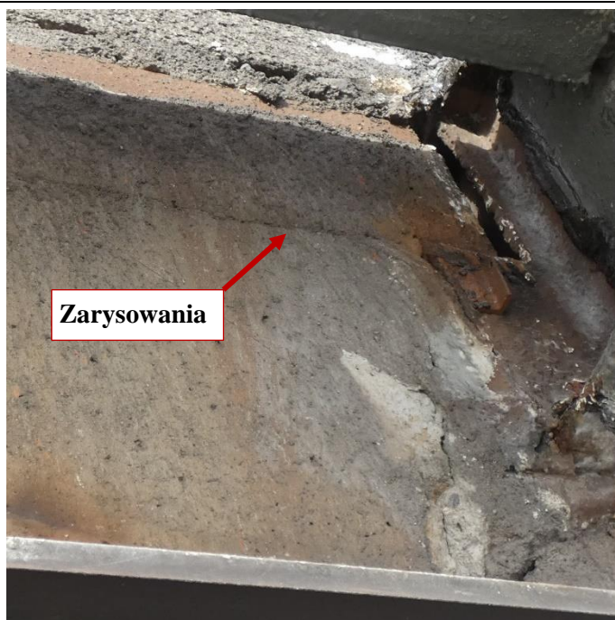
Fot. 71 Kondygnacja 9 (Poziom +35.10) Elewacja Wschodnia – belka w osiach 14/H-I. Zarysowanie belki na wysokości miejsca oparcia. Spękania i zarysowania powierzchni zaprawy.
