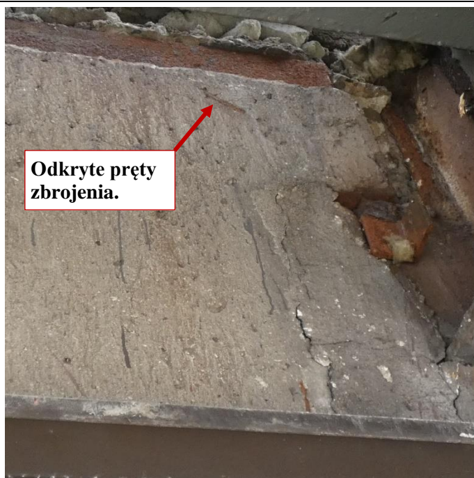
Fot. 113 Kondygnacja 9 (Poziom +35.10) Elewacja Południowa – belka w osiach 12-13/E. Odkryte pręty zbrojenia. Przestrzeń między elementami wypełniona zaprawą i gruzem. Zarysowania powierzchni zaprawy. Brak widocznych uszkodzeń belki przy podporze.
