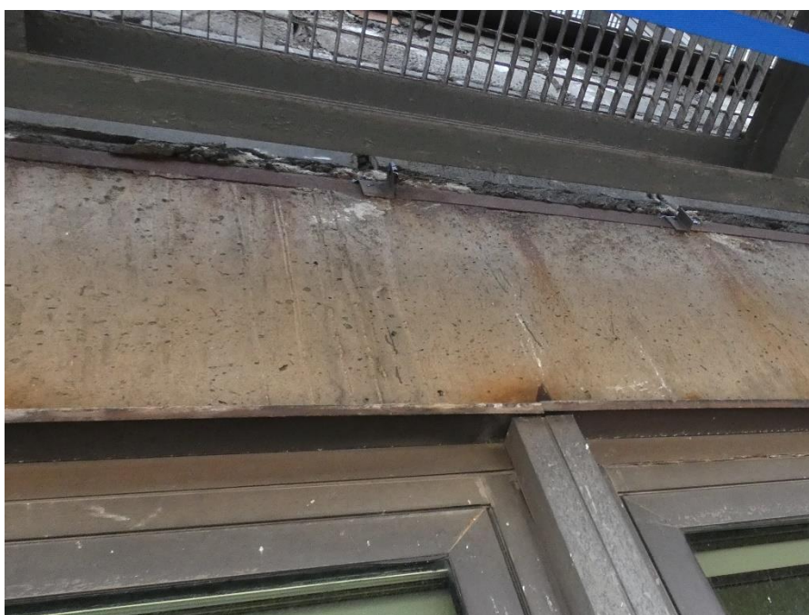
Fot. 93 Kondygnacja 9 (Poziom +35.10) Elewacja Zachodnia – belka w osiach 10/G-H. Brak widocznych uszkodzeń belki w przęśle.
