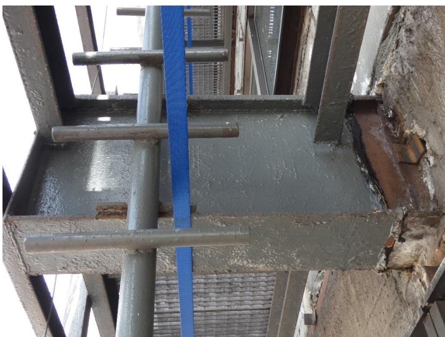
Fot. 154, 155 Kondygnacja 9 (Poziom +35.10) Elewacja Zachodnia– wspornik w osiach 10/F (widok z dołu) Brak widocznych uszkodzeń wspornika.
