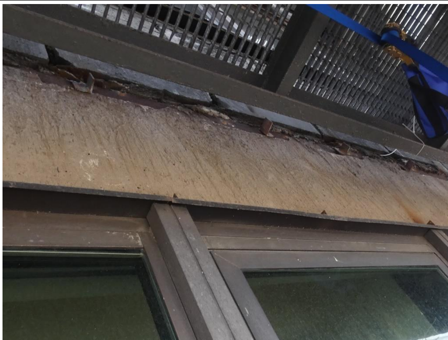
Fot. 100 Kondygnacja 9 (Poziom +35.10) Elewacja Zachodnia – belka w osiach 10/E-F. Brak widocznych uszkodzeń belki w przęśle
