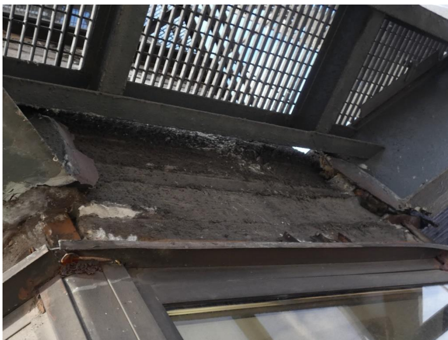
Fot. 72 Kondygnacja 9 (Poziom +35.10) Elewacja Wschodnia – belka w osiach 14/I. Brak możliwości pomiaru głębokości oparcia i określenia zastosowanych rozwiązań konstrukcyjnych. Brak widocznych uszkodzeń.
