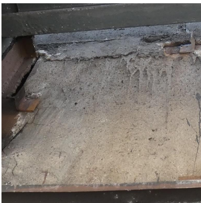
Fot. 95 Kondygnacja 9 (Poziom +35.10) Elewacja Zachodnia – belka w osiach 10/F-G. Zarysowania powierzchni zaprawy. Brak widocznych uszkodzeń belki przy podporze.
