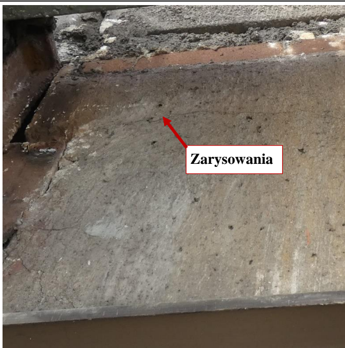
Fot. 69 Kondygnacja 9 (Poziom +35.10) Elewacja Wschodnia – belka w osiach 14/H-I. . Zarysowania belki na wysokości miejsca oparcia. Zarysowania powierzchni zaprawy
