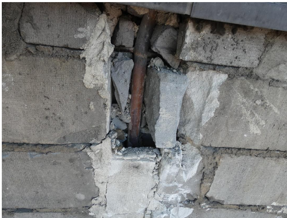
Fot. 10 Widok otwartego pionu instalacyjnego
