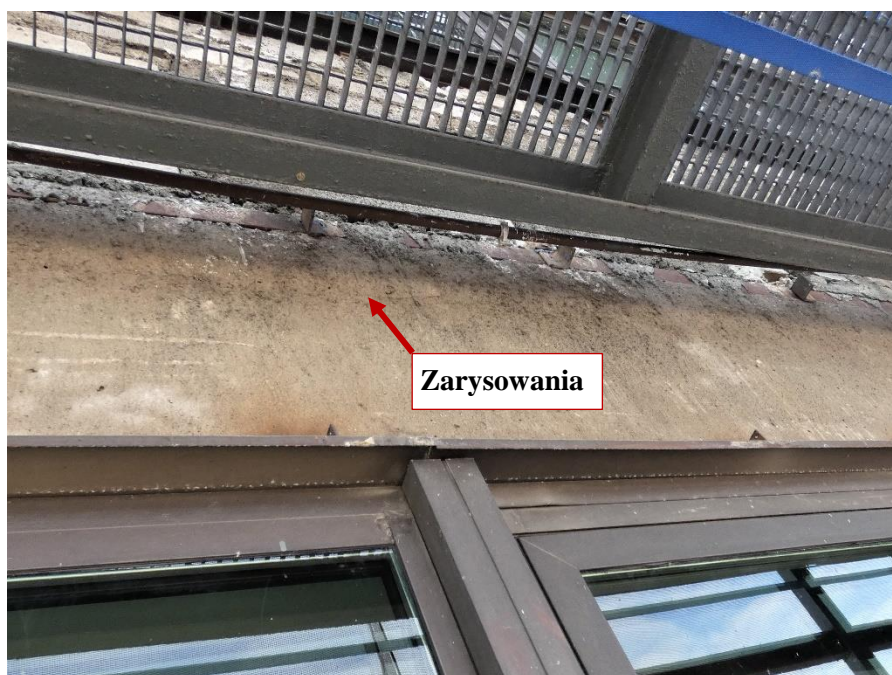
Fot. 83 Kondygnacja 9 (Poziom +35.10) Elewacja Północna – belka w osiach 11-12/I. Zarysowania belki w przęśle na wysokości miejsca oparcia.
