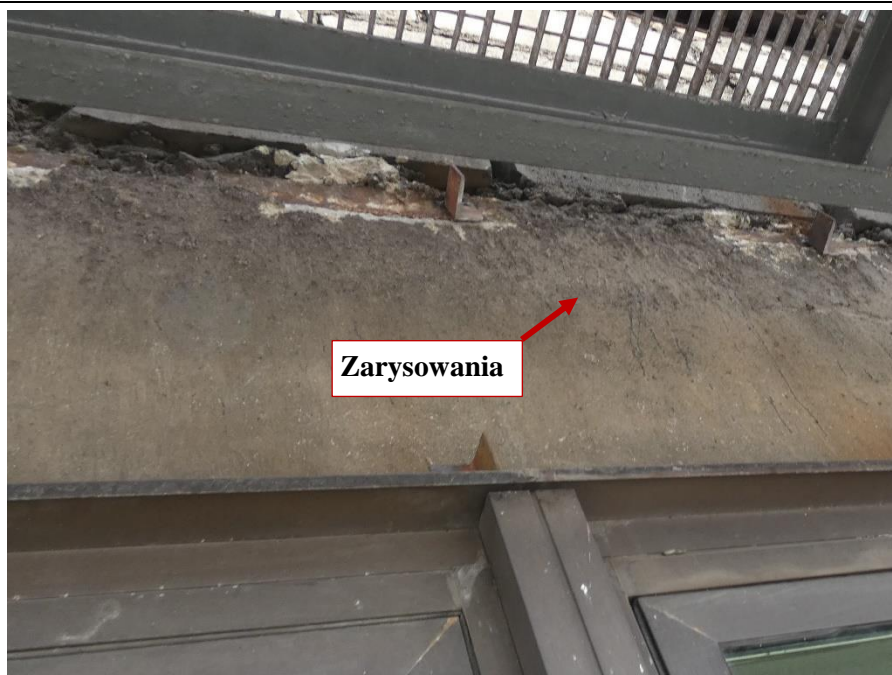
Fot. 105 Kondygnacja 9 (Poziom +35.10) Elewacja Południowa – belka w osiach 10-11/E. Zarysowanie belki w przęśle na wysokości miejsca oparcia.
