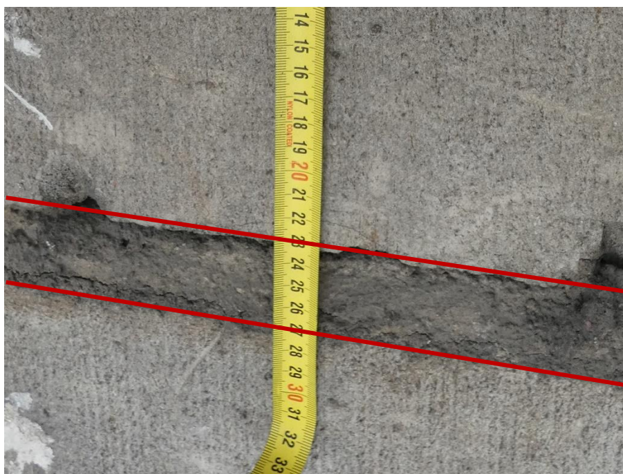
Fot. 1 Przykładowa spoina pozioma – grubość 4 cm
