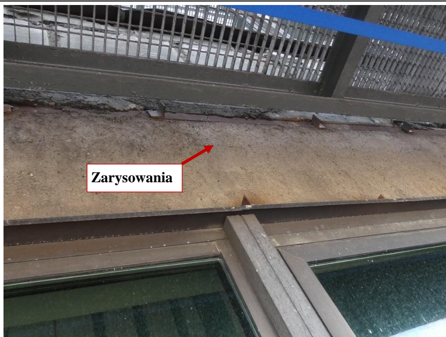
Fot. 96 Kondygnacja 9 (Poziom +35.10) Elewacja Zachodnia – belka w osiach 10/F-G. Zarysowanie belki w przęśle na wysokości miejsca oparcia.
