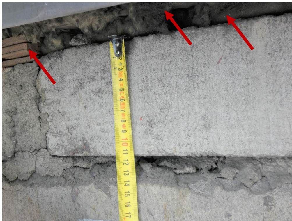
Fot. 7 Widok zwieńczenia ściany z elementów z betonu komórkowego z podkładkami stalowymi i izolacją termiczną pod profilem stalowym (bez podlewki)
