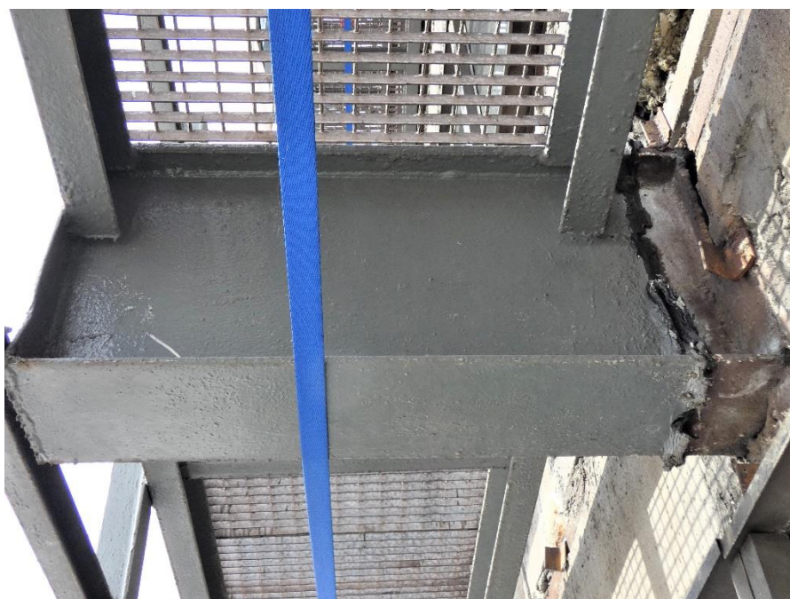
Fot. 161, 162 Kondygnacja 9 (Poziom +35.10) Elewacja Południowa– wspornik w osiach 11/E (widok z dołu) Brak widocznych uszkodzeń wspornika.
