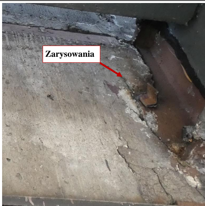
Fot. 94 Kondygnacja 9 (Poziom +35.10) Elewacja Zachodnia – belka w osiach 10/G-H. Zarysowanie elementu w miejscu oparcia. Spękania i zarysowania powierzchni zaprawy
