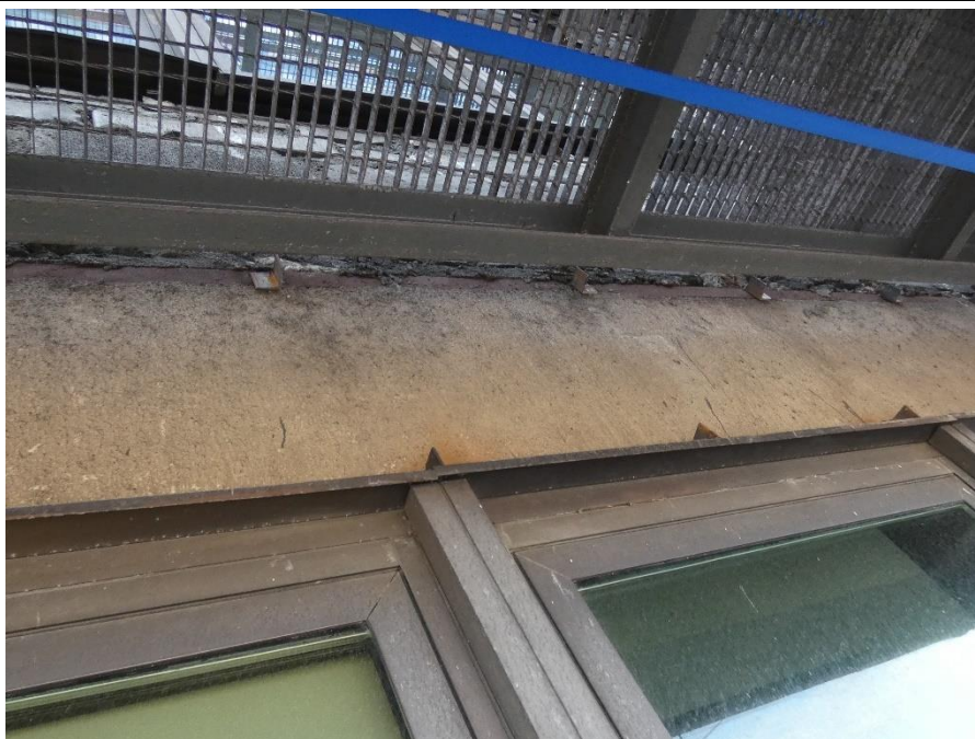
Fot. 90 Kondygnacja 9 (Poziom +35.10) Elewacja Zachodnia – belka w osiach 10/H-I. Brak widocznych uszkodzeń belki w przęśle.
