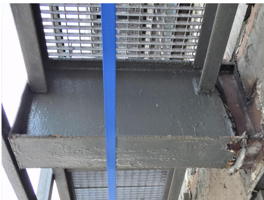
Fot. 148, 149 Kondygnacja 9 (Poziom +35.10) Elewacja Zachodnia– wspornik w osiach 10/H (widok z dołu) Brak widocznych uszkodzeń wspornika.
