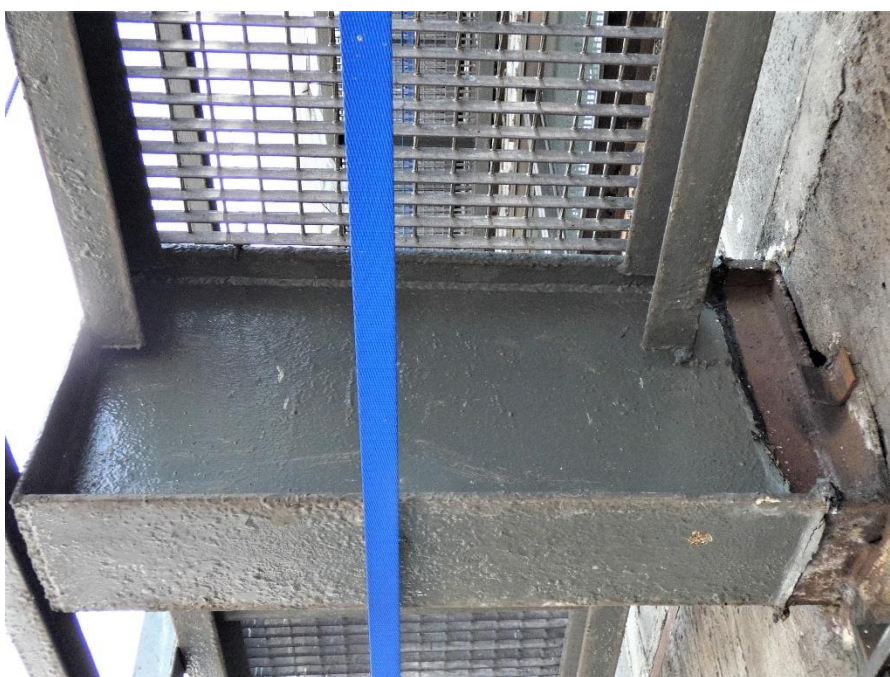
Fot. 151, 152 Kondygnacja 9 (Poziom +35.10) Elewacja Zachodnia– wspornik w osiach 10/G (widok z dołu) Brak widocznych uszkodzeń wspornika.
