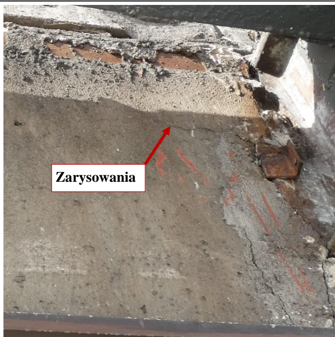
Fot. 60 Kondygnacja 8 (Poziom +31.80) Elewacja Wschodnia – belka w osiach 14/E-F. Zarysowanie belki na wysokości miejsca oparcia. Przestrzeń między elementami wypełniona zaprawą. Zarysowania powierzchni zaprawy.
