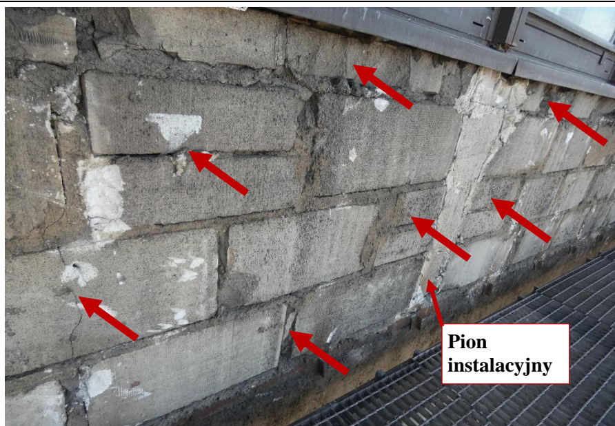
Fot. 32 Kondygnacja 8 (Poziom +31.80) Elewacja Północna – widok ściany murowanej w osiach 10-11/I.
