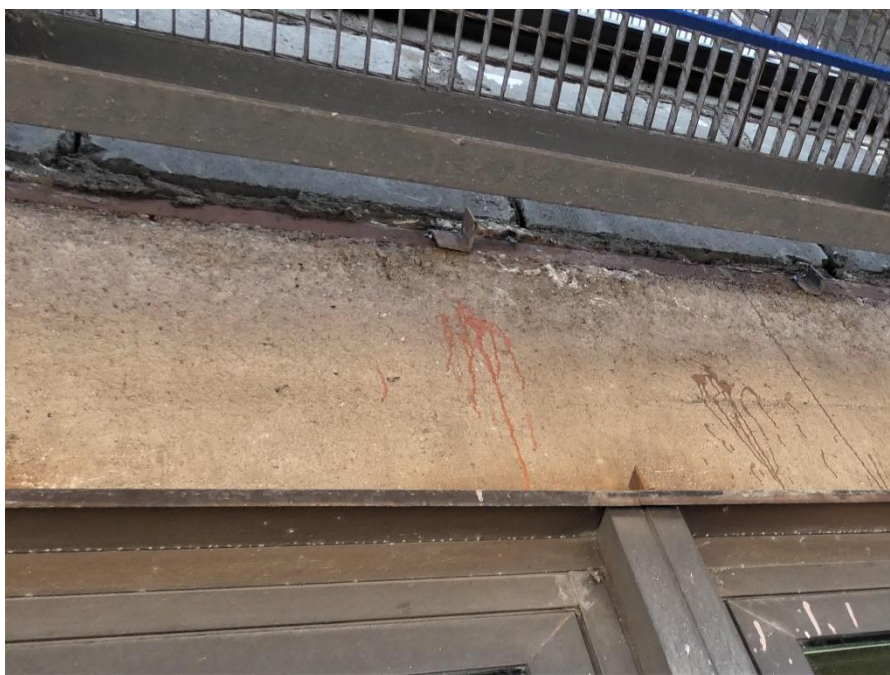
Fot. 89 Kondygnacja 8 (Poziom +31.80) Elewacja Zachodnia – belka w osiach 10/G-H. Brak widocznych uszkodzeń belki w przęśle.
