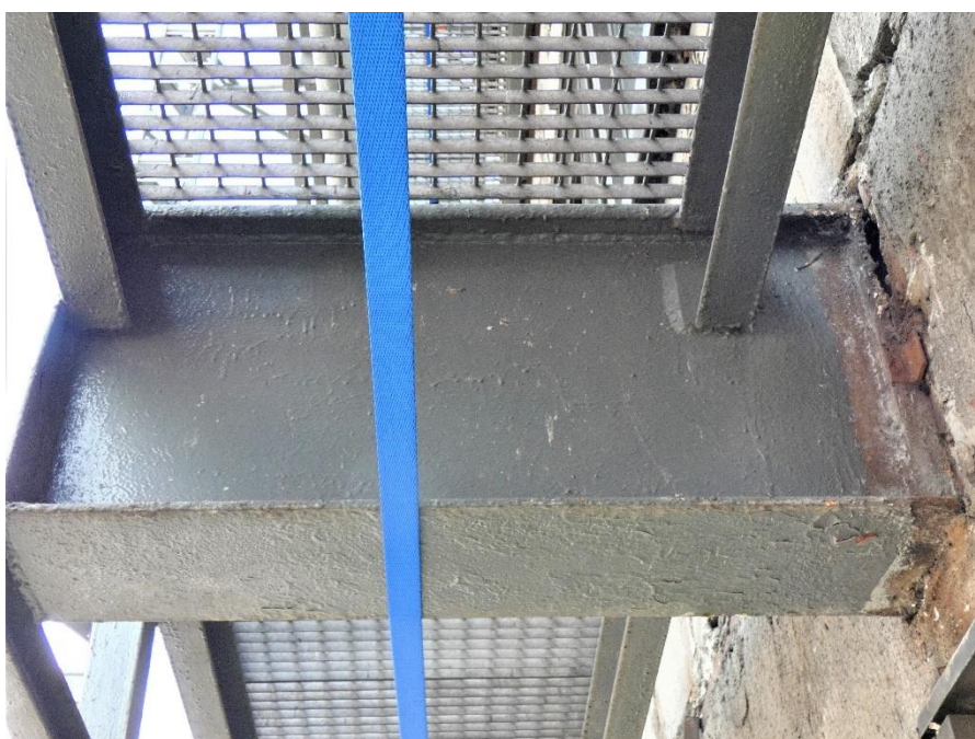
Fot. 131, 132 Kondygnacja 8 (Poziom +31.80) Elewacja Północna – wspornik w osiach 13/I. Brak widocznych uszkodzeń wspornika.
