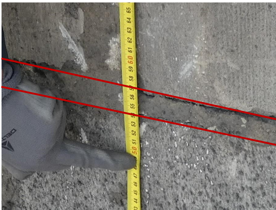
• Fot. 1 Przykładowa spoina pozioma – grubość 3 cm
