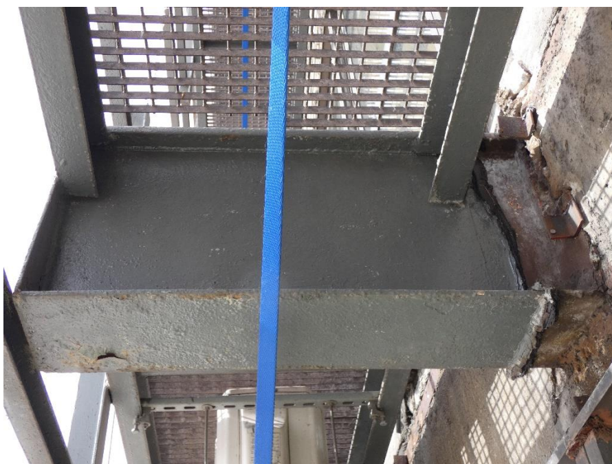
Fot. 157, 158 Kondygnacja 8 (Poziom +31.80) Elewacja Południowa – wspornik w osiach 13/E. Przemieszczenie wspornika w kierunku osi 14. Brak widocznych uszkodzeń wspornika.
