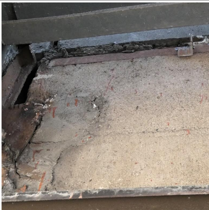
Fot. 88 Kondygnacja 8 (Poziom +31.80) Elewacja Zachodnia – belka w osiach 10/G-H. Spękania i zarysowania powierzchni zaprawy. Brak widocznych uszkodzeń belki przy podporze.
