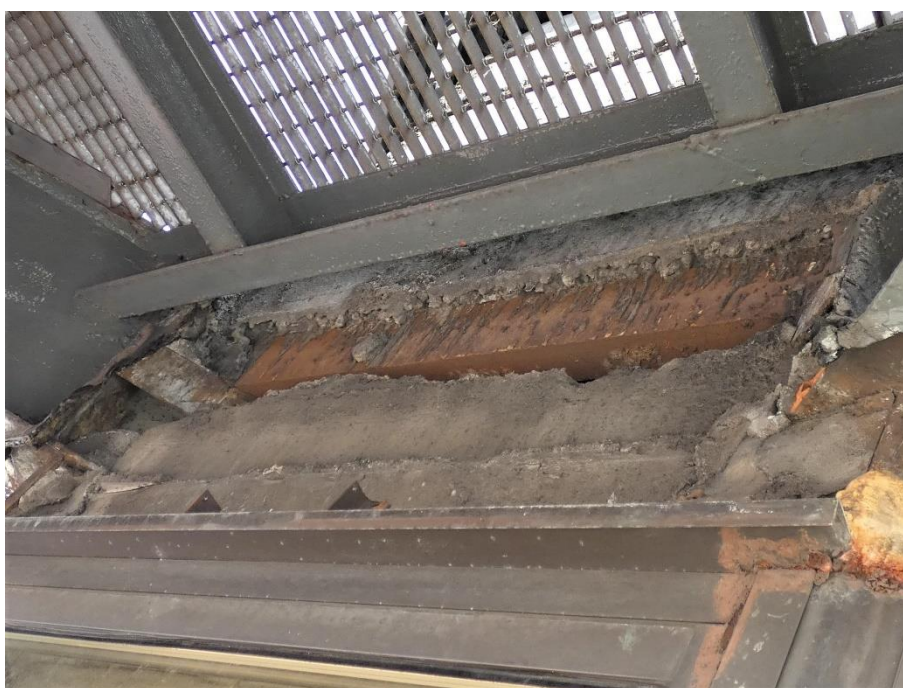
Fot. 98 Kondygnacja 8 (Poziom +31.80) Elewacja Zachodnia – belka w osiach 10/E. Uszkodzona zaprawa przykrywająca ceowniki oparte na wspornikach stalowych.
