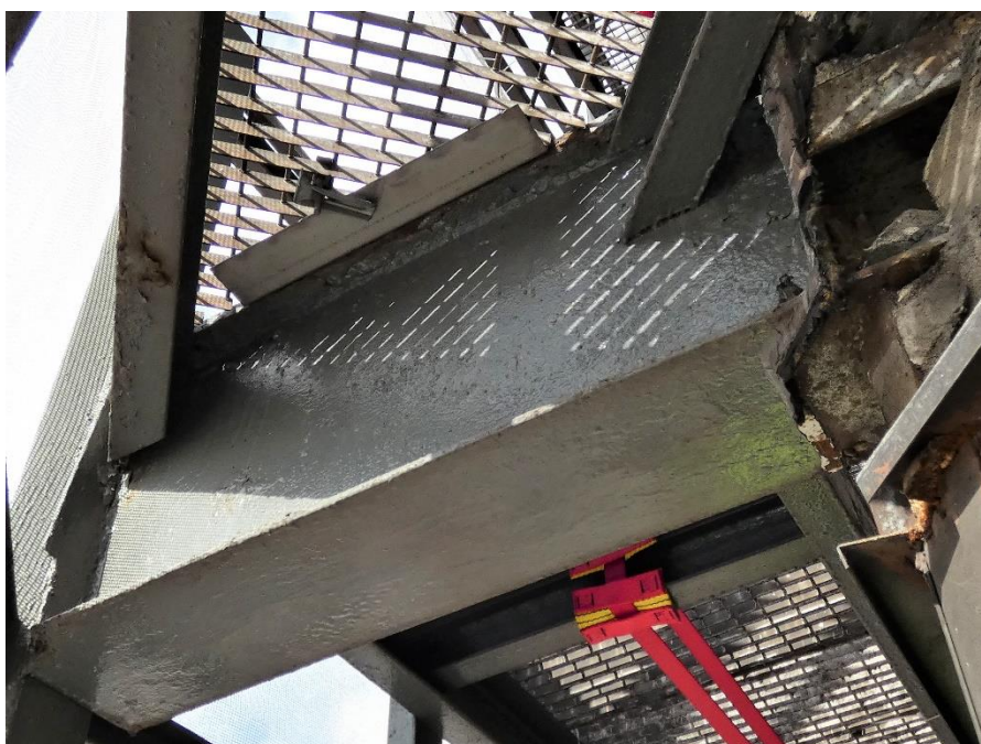
Fot. 148, 149 Kondygnacja 8 (Poziom +31.80) Elewacja Zachodnia– wspornik w osiach 10/E. Brak widocznych uszkodzeń wspornika.
