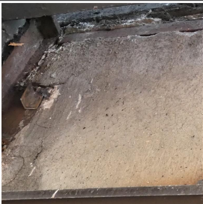
Fot. 95 Kondygnacja 8 (Poziom +31.80) Elewacja Zachodnia – belka w osiach 10/E-F. Brak widocznych uszkodzeń belki przy podporze. Zarysowania powierzchni zaprawy.
