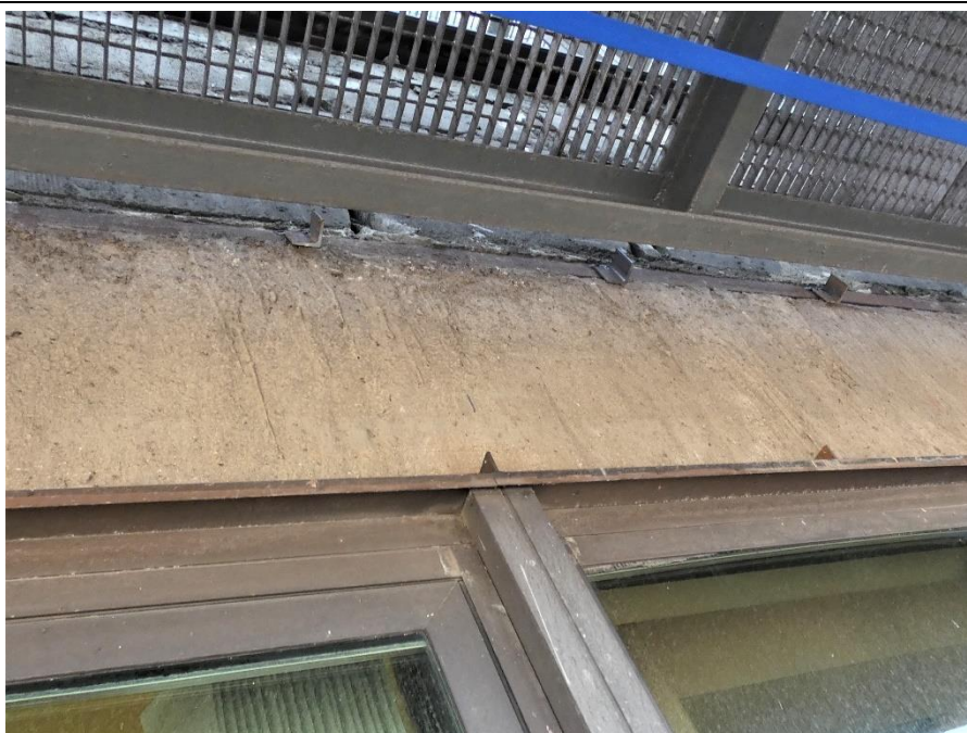
Fot. 86 Kondygnacja 8 (Poziom +31.80) Elewacja Zachodnia – belka w osiach 10/H-I. Brak widocznych uszkodzeń belki w przęśle.
