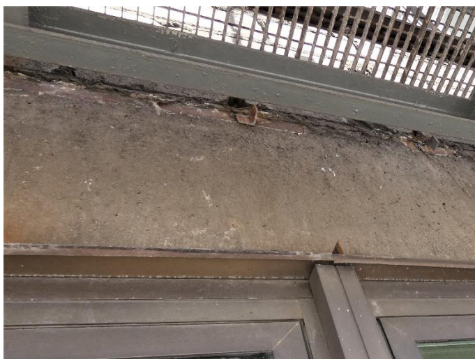
Fot. 100 Kondygnacja 8 (Poziom +31.80) Elewacja Południowa – belka w osiach 10-11/E. Brak widocznych uszkodzeń w przęśle belki
