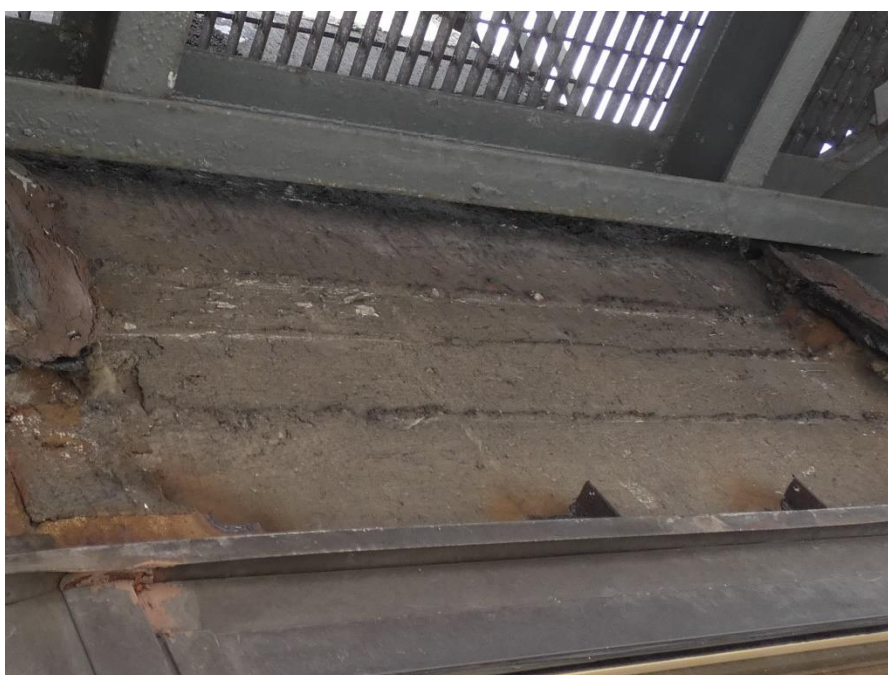
Fot. 113 Kondygnacja 8 (Poziom +31.80) Elewacja Południowa – belka w osiach 14/E. Brak możliwości pomiaru głębokości oparcia i określenia zastosowanych rozwiązań konstrukcyjnych. Brak widocznych uszkodzeń.
