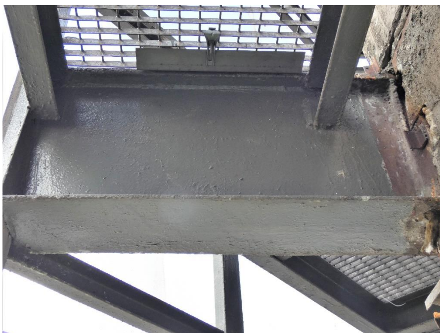
Fot. 129, 130 Kondygnacja 8 (Poziom +31.80) Elewacja Północna – wspornik w osiach 14/I. Ślady korozji pasa górnego. Brak widocznych uszkodzeń wspornika.
