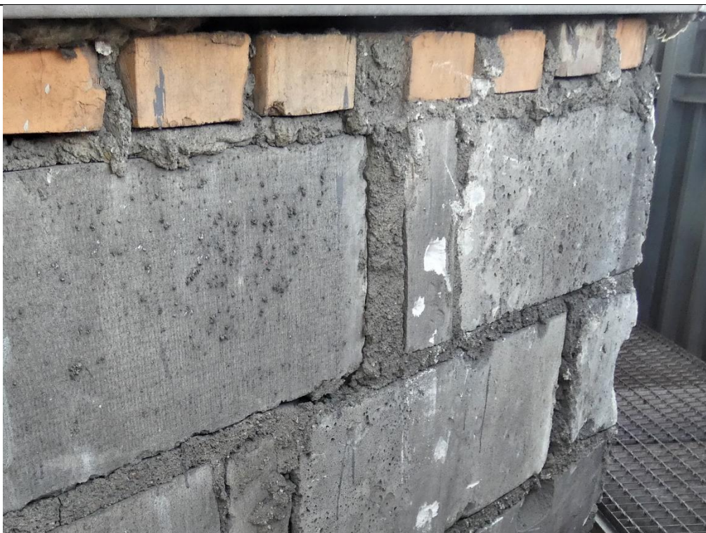
Fot. 9 Widok zwieńczenia ściany ceramicznymi elementami murowymi
