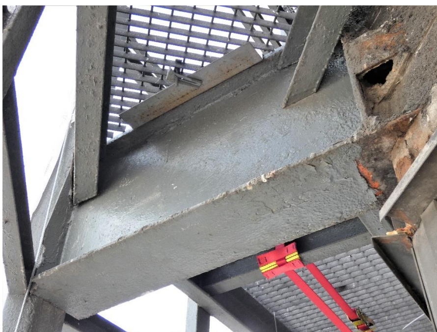
Fot. 127, 128 Kondygnacja 8 (Poziom +31.80) Elewacja Wschodnia – wspornik w osiach 14/I. Brak widocznych uszkodzeń wspornika.
