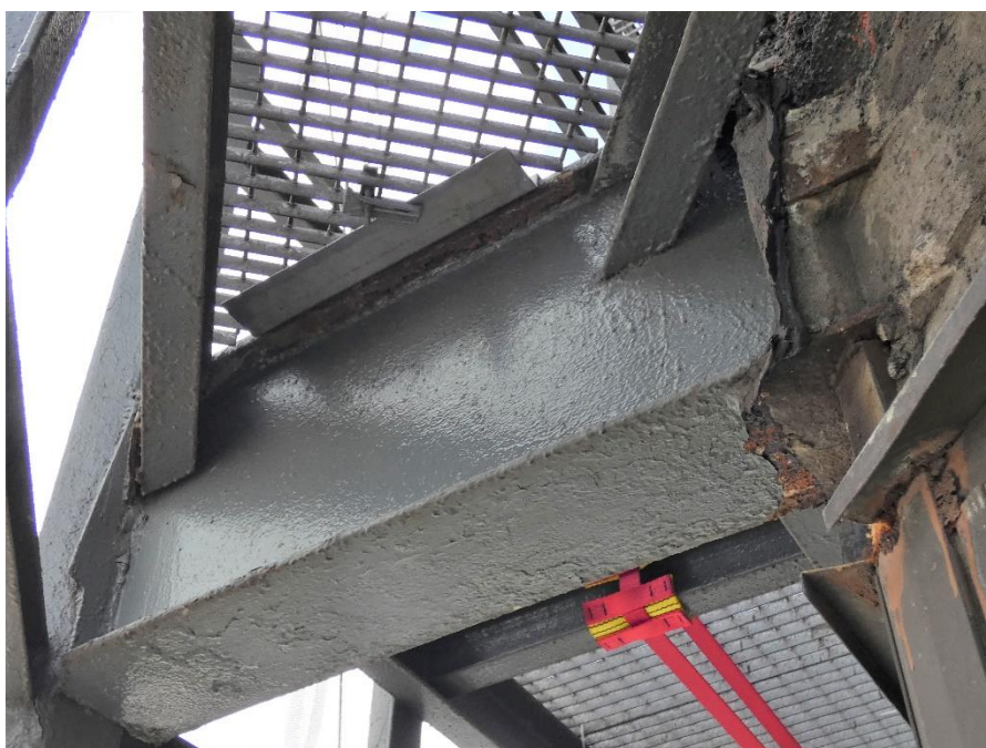
Fot. 137, 138 Kondygnacja 8 (Poziom +31.80) Elewacja Północna – wspornik w osiach 10/I. Brak widocznych uszkodzeń wspornika.
