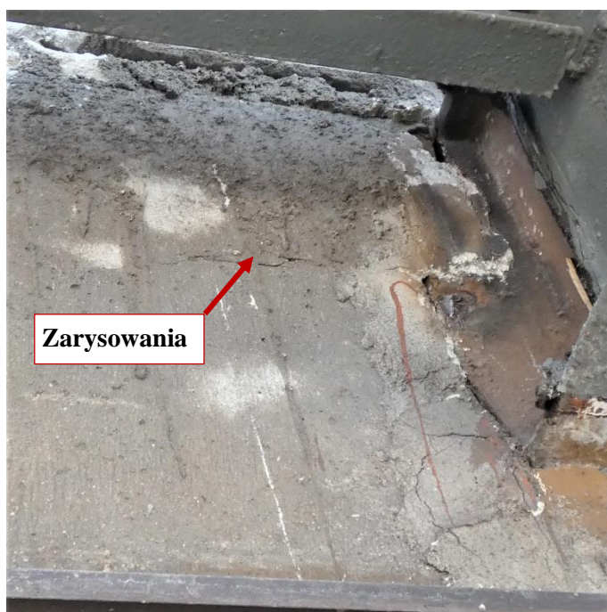
Fot. 78 Kondygnacja 8 (Poziom +31.80) Elewacja Północna – belka w osiach 11-12/I.
