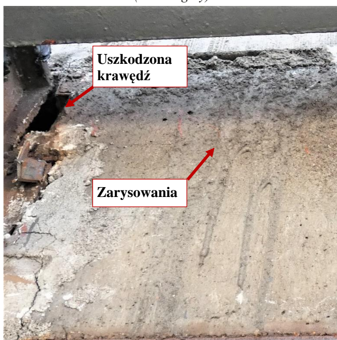
Fot. 79, 80 Kondygnacja 8 (Poziom +31.80) Elewacja Północna – belka w osiach 10-11/I. Uszkodzona krawędź elementu. Zalegający gruz w przestrzeni między elementami. Zarysowania belki na wysokości miejsca oparcia. Spękania i zarysowania powierzchni zaprawy.
