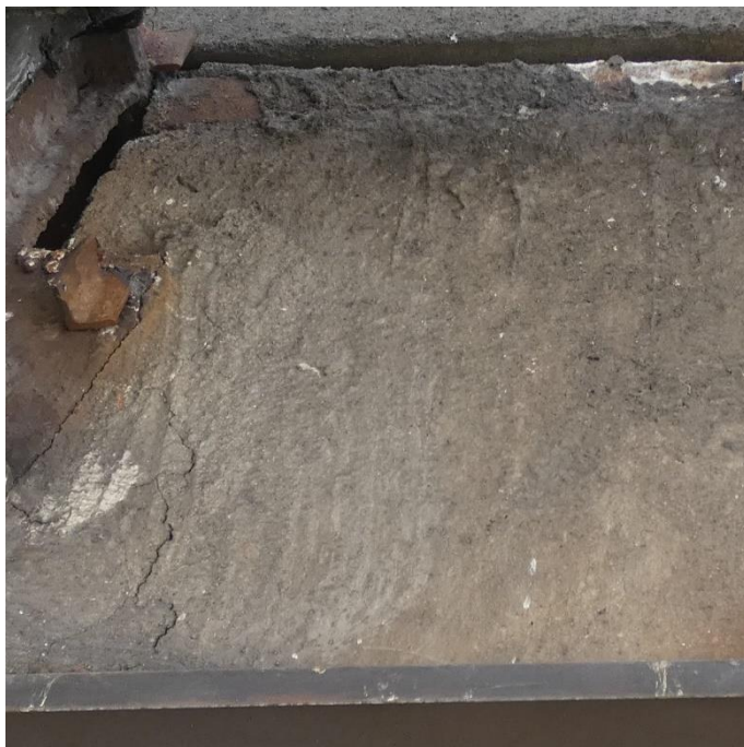
Fot. 58 Kondygnacja 8 (Poziom +31.80) Elewacja Wschodnia – belka w osiach 14/E-F. Zarysowania powierzchni zaprawy. Brak widocznych uszkodzeń belki przy podporze.
