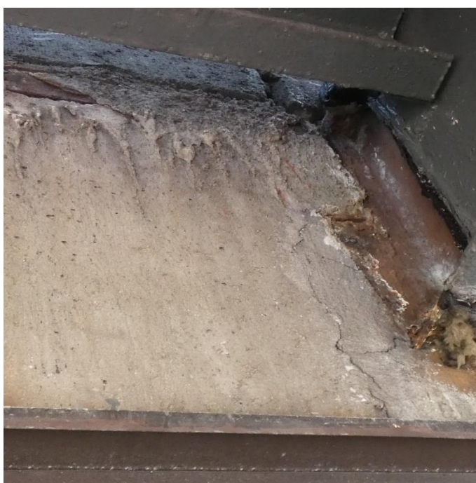
Fot. 94 Kondygnacja 8 (Poziom +31.80) Elewacja Zachodnia – belka w osiach 10/F-G. Spękania i zarysowania powierzchni zaprawy. Brak widocznych uszkodzeń belki przy podporze.
