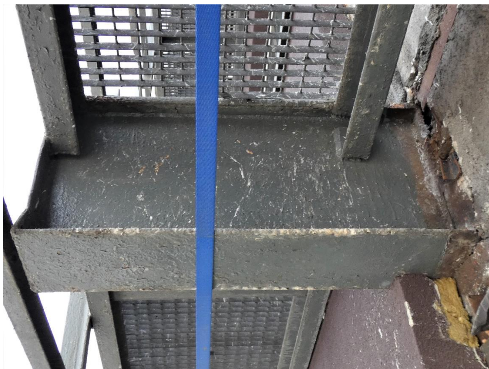
Fot. 116 Wspornik stalowy (widok z boku)
