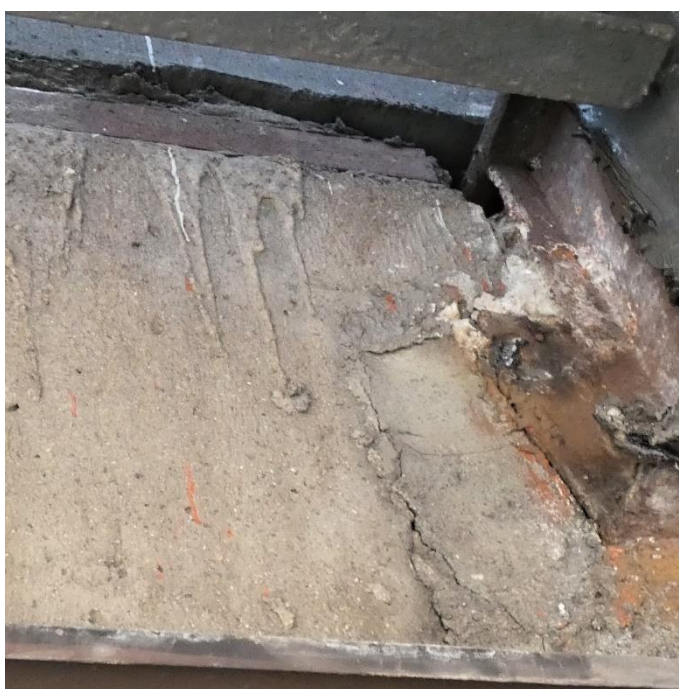
Fot. 87 Kondygnacja 8 (Poziom +31.80) Elewacja Zachodnia – belka w osiach 10/H-I. Przestrzeń między elementami wypełniona zaprawą. Spękania i zarysowania powierzchni zaprawy. Brak widocznych uszkodzeń belki przy podporze.
