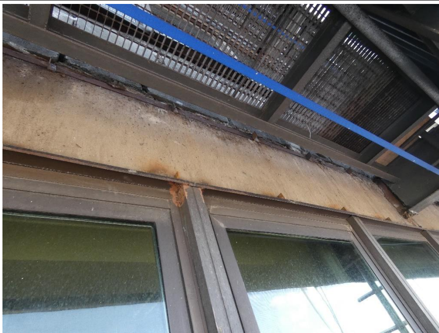
Fot. 93 Kondygnacja 8 (Poziom +31.80) Elewacja Zachodnia – belka w osiach 10/F-G. Brak widocznych uszkodzeń belki w przęśle.
