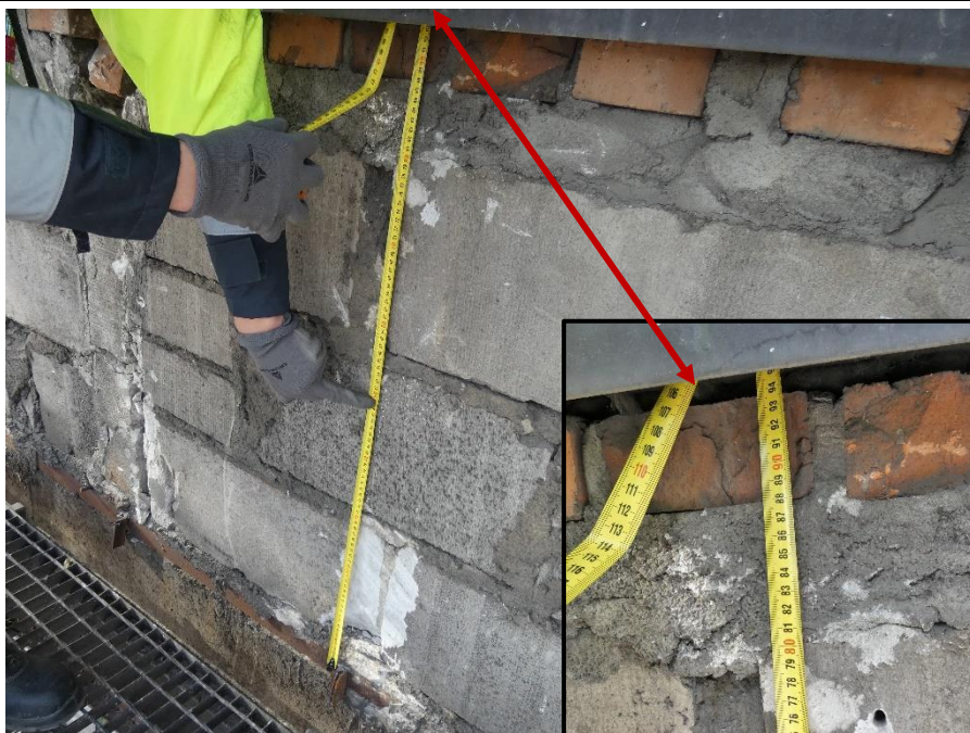
Fot. 20 Kondygnacja 8 (Poziom +31.80) Elewacja Wschodnia – widok ściany murowanej w osiach 14/H-I. Wysokość ściany murowanej ~94 cm. Grubość podlewki między belką żelbetową a ścianą ~6 cm. Element murowy bezpośrednio pod profilem stalowym (brak podlewki).
