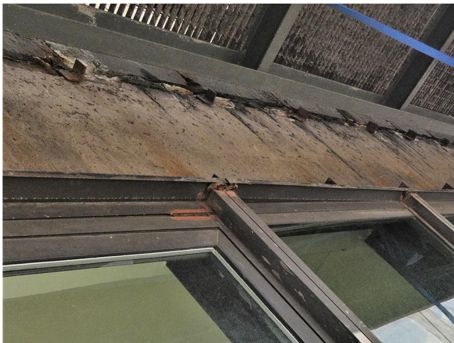
Fot. 111 Kondygnacja 8 (Poziom +31.80) Elewacja Południowa – belka w osiach 13-14/E. Brak widocznych uszkodzeń belki w przęśle.
