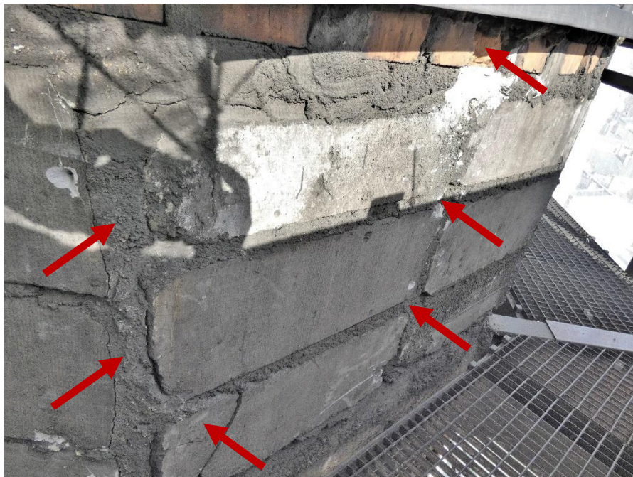
Fot. 57 Kondygnacja 8 (Poziom +31.80) Elewacja Południowa – widok ściany murowanej w osiach 14/E.
