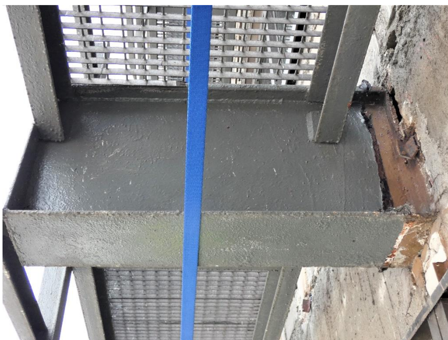
Fot. 135, 136 Kondygnacja 8 (Poziom +31.80) Elewacja Północna – wspornik w osiach 11/I. Przemieszczenie wspornika w kierunku osi 12. Brak widocznych uszkodzeń wspornika.
