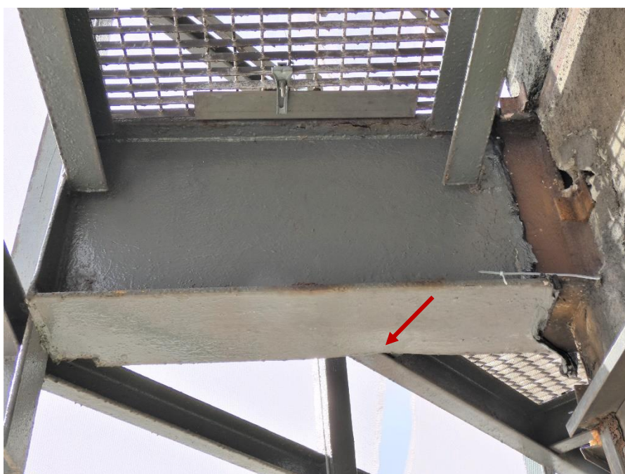
Fot. 150, 151 Kondygnacja 8 (Poziom +31.80) Elewacja Południowa – wspornik w osiach 10/E. Ślady korozji pasa górnego. Mechaniczne uszkodzenie pasa dolnego.
