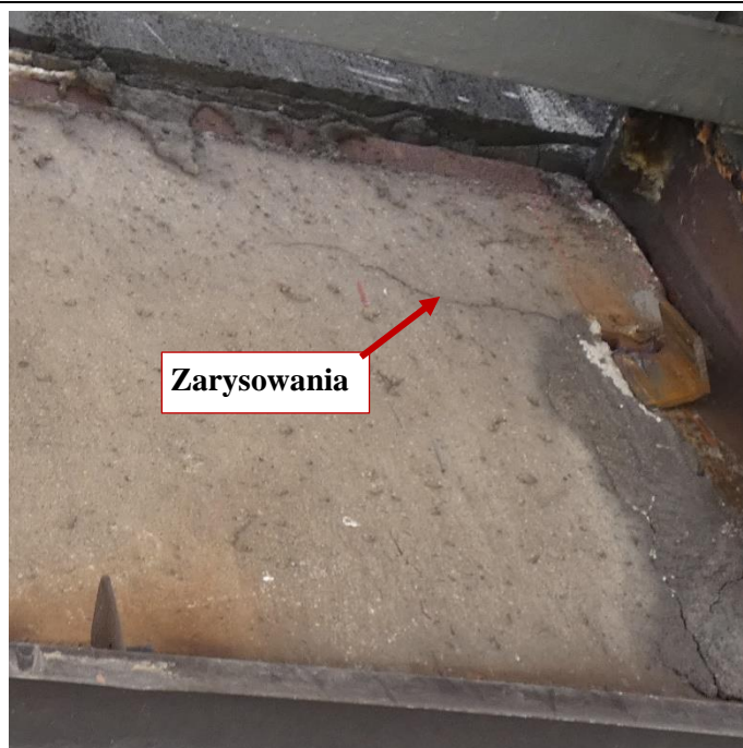
Fot. 112 Kondygnacja 8 (Poziom +31.80) Elewacja Południowa – belka w osiach 13-14/E. Zarysowania belki na wysokości miejsca oparcia. Zarysowania powierzchni zaprawy.
