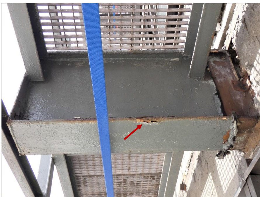
Fot. 152, 153 Kondygnacja 8 (Poziom +31.80) Elewacja Południowa– wspornik w osiach 11/E (widok z dołu) Ślady korozji pasa dolnego. Brak widocznych uszkodzeń wspornika.
