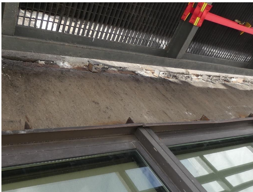
Fot. 59 Kondygnacja 8 (Poziom +31.80) Elewacja Wschodnia – belka w osiach 14/E-F. Brak widocznych uszkodzeń w przęśle belki
