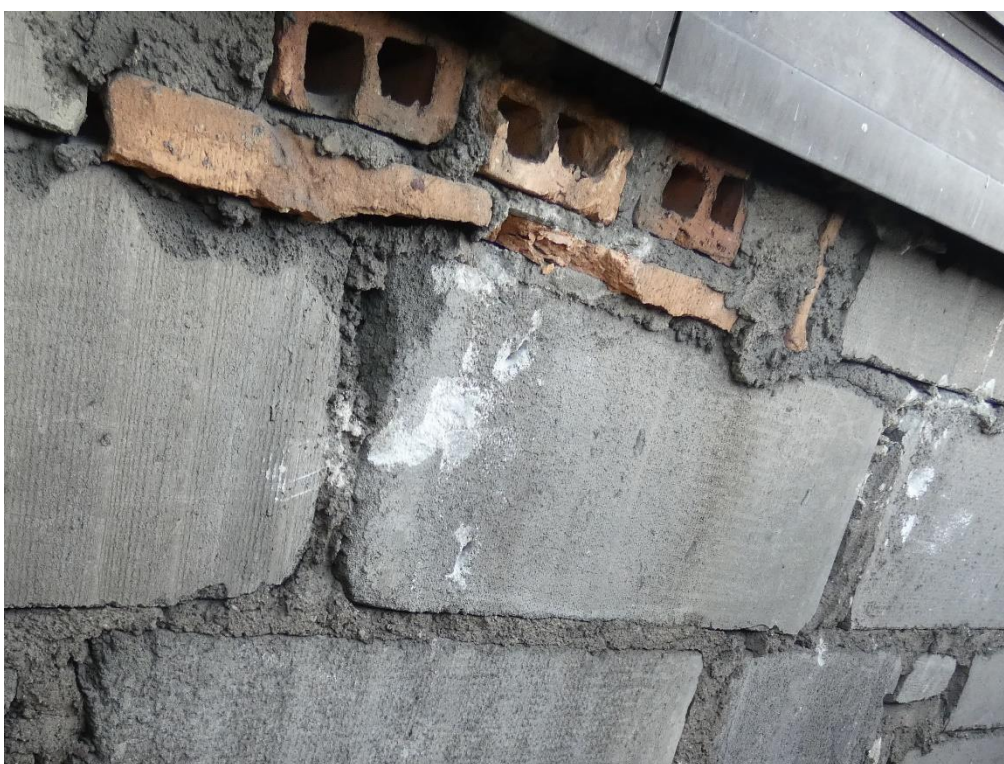
Fot. 10 Widok zwieńczenia ściany zaprawą i gruzem
