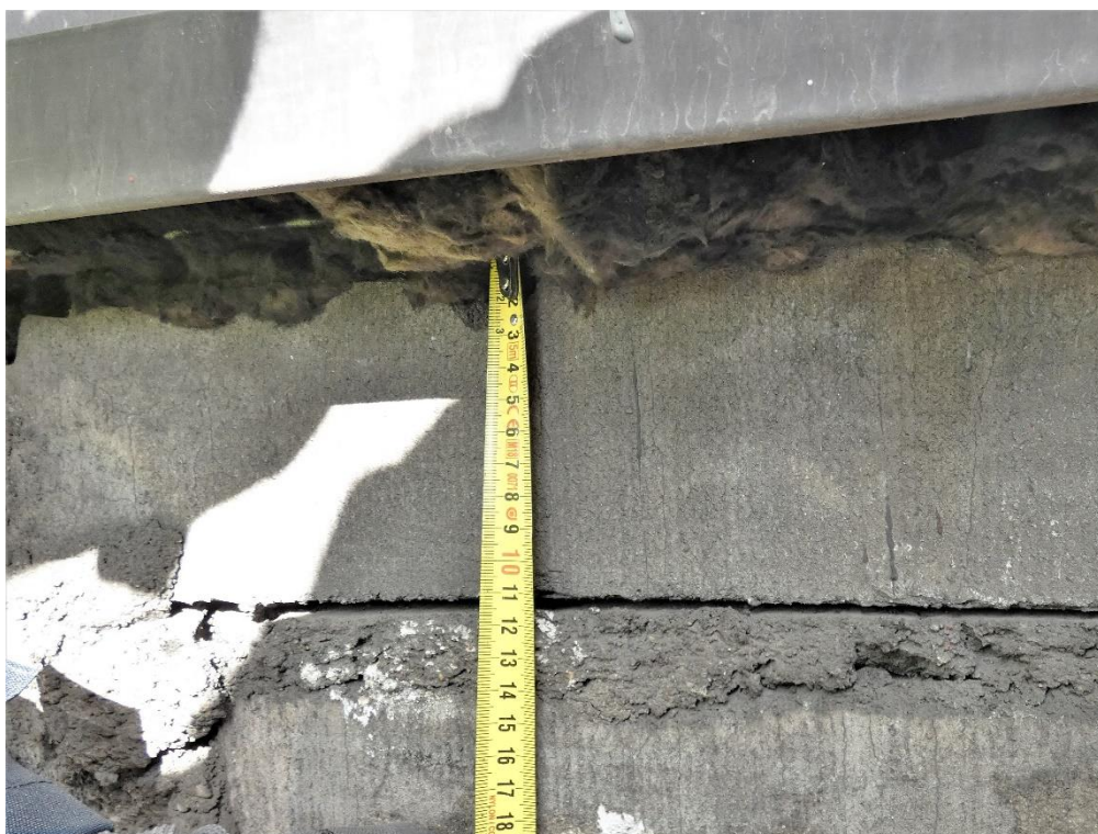
Fot. 8 Widok zwieńczenia ściany elementami z betonu komórkowego
