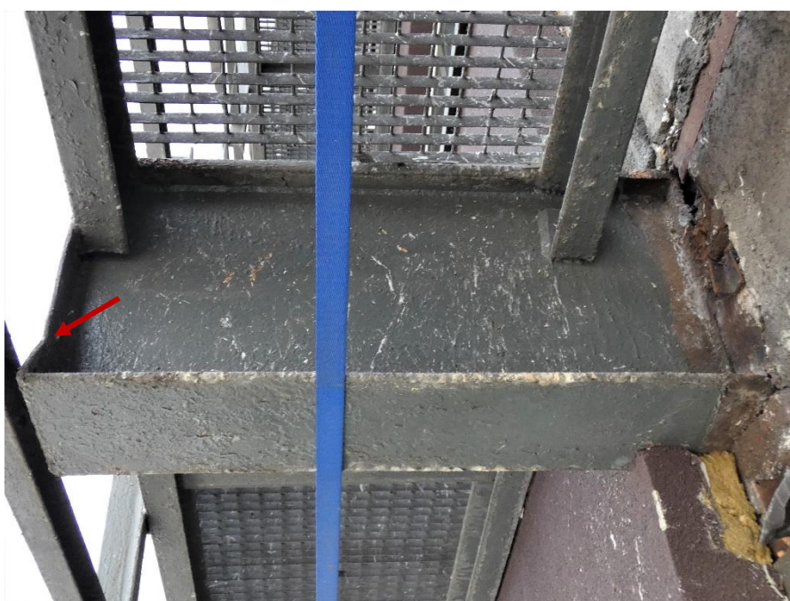
Fot. 124, 125 Kondygnacja 8 (Poziom +31.80) Elewacja Wschodnia – wspornik w osiach 14/H (widok z dołu) Mechaniczne uszkodzenie żeberka usztywniającego.
