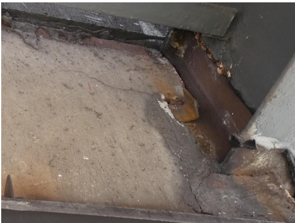
Fot. 115 Wspornik stalowy w miejscu oparcia belek żelbetowych (widok z dołu)
