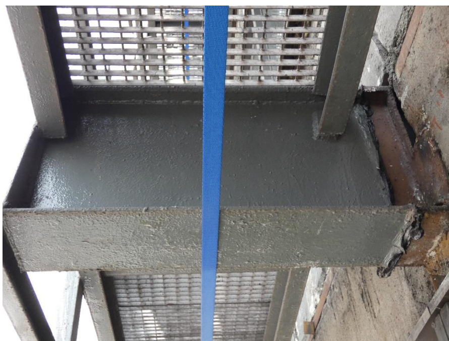
Fot. 141, 142 Kondygnacja 8 (Poziom +31.80) Elewacja Zachodnia– wspornik w osiach 10/H (widok z dołu) Brak widocznych uszkodzeń wspornika.
