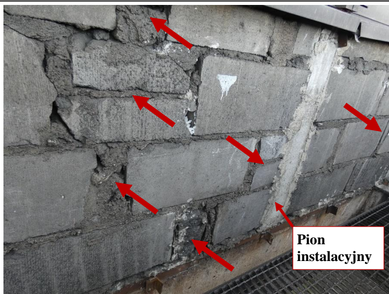
Fot. 38 Kondygnacja 8 (Poziom +31.80) Elewacja Zachodnia – widok ściany murowanej w osiach 10/H-I. Zbyt duże wymiary spoin. Wykonanie i zwieńczenie ściany z uszkodzonych elementów murowych o zróżnicowanych kształtach. Wypełnienie ubytków między elementami i uszkodzonych miejsc zaprawą i gruzem. Zamknięcie pionu instalacyjnego.
