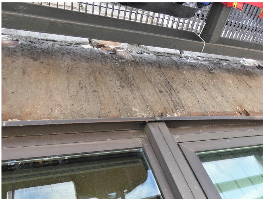
Fot. 81 Kondygnacja 8 (Poziom +31.80) Elewacja Północna – belka w osiach 10-11/I.
