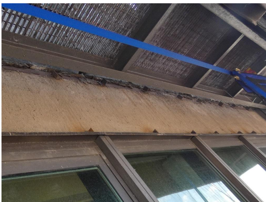
Fot. 96 Kondygnacja 8 (Poziom +31.80) Elewacja Zachodnia – belka w osiach 10/E-F. Brak widocznych uszkodzeń belki w przęśle
