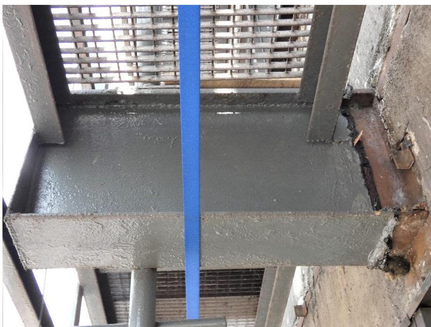
Fot. 146, 147 Kondygnacja 8 (Poziom +31.80) Elewacja Zachodnia– wspornik w osiach 10/F. Przemieszczenie wspornika w kierunku osi E. Brak widocznych uszkodzeń wspornika.
