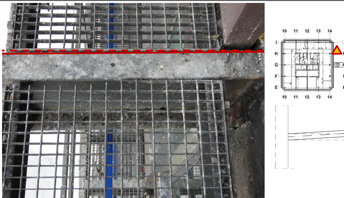
Fot. 126 Kondygnacja 8 (Poziom +31.80) Elewacja Wschodnia – wspornik w osiach 14/H (widok z góry) Przemieszczenia wspornika w kierunku osi I. Brak widocznych uszkodzeń wspornika.
