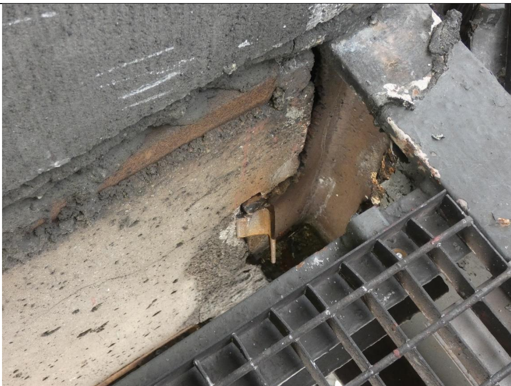
Fot. 114 Wspornik stalowy w miejscu oparcia belek żelbetowych (widok z góry)
