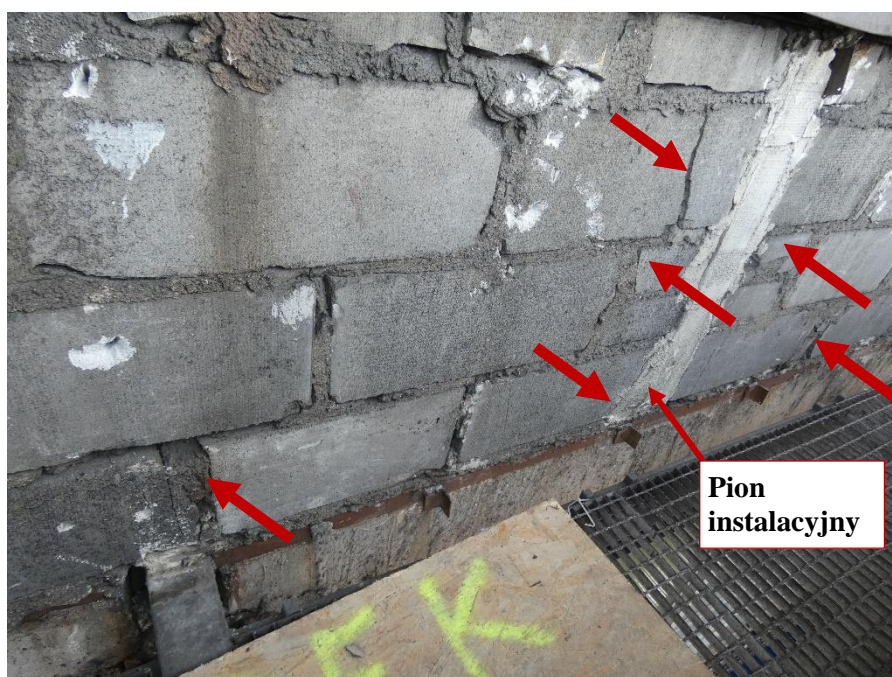
Fot. 39 Kondygnacja 8 (Poziom +31.80) Elewacja Zachodnia – widok ściany murowanej w osiach 10/G-H. Zbyt duże wymiary spoin. Spękania elementów murowych. Wykonanie i zwieńczenie ściany z uszkodzonych elementów murowych o zróżnicowanych kształtach. Wypełnienie ubytków między elementami i uszkodzonych miejsc zaprawą i gruzem. Zamknięcie pionu instalacyjnego.
