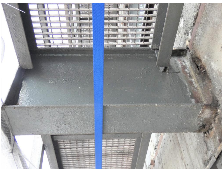
Fot. 150, 151 Kondygnacja 6 (Poziom +25.20) Elewacja Zachodnia– wspornik w osiach 10/G (widok z dołu) Brak widocznych uszkodzeń wspornika.
