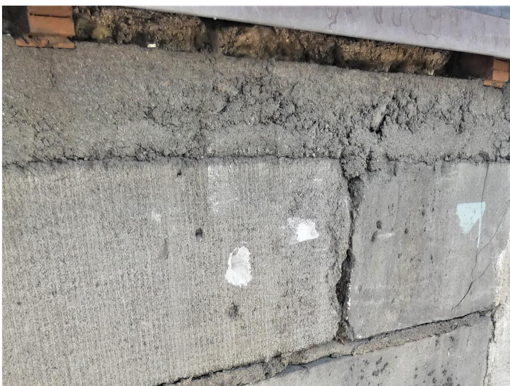
Fot. 5 Przykład zwieńczenia ściany podławką.
