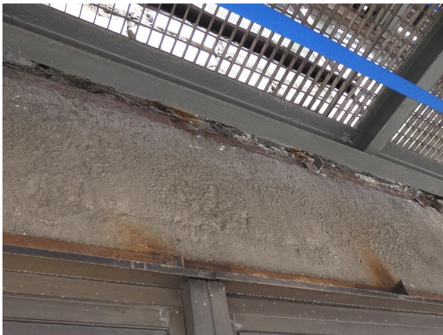
Fot. 109 Kondygnacja 6 (Poziom +25.20) Elewacja Południowa – belka w osiach 12-13/E. Brak widocznych uszkodzeń belki w przęśle.
