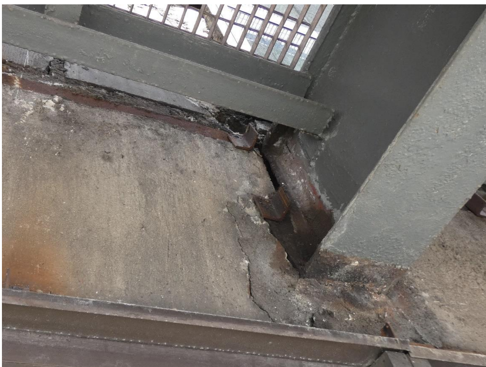
Fot. 118 Wspornik stalowy w miejscu oparcia belek żelbetowych (widok z dołu)
