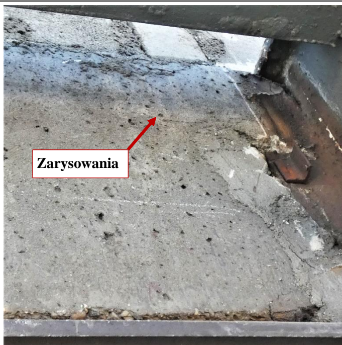
Fot. 74 Kondygnacja 6 (Poziom +25.20) Elewacja Północna – belka w osiach 12-13/I. Przestrzeń między elementami wypełniona zaprawą. Zarysowania belki na wysokości miejsca oparcia. Zarysowania powierzchni zaprawy.
