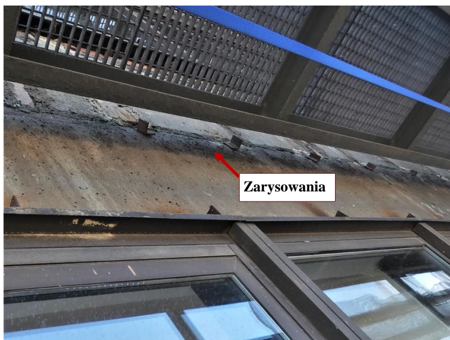
Fot. 73 Kondygnacja 6 (Poziom +25.20) Elewacja Północna – belka w osiach 12-13/I. Zarysowanie belki w przęśle na wysokości miejsca oparcia.
