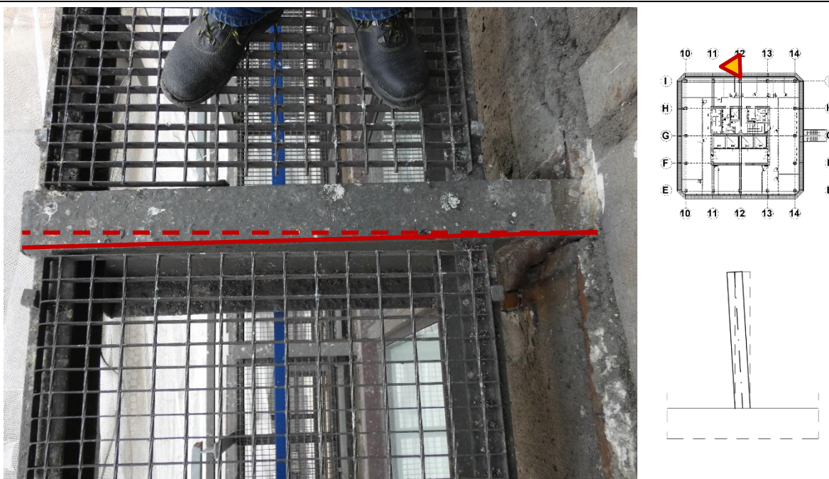
Fot. 139 Kondygnacja 6 (Poziom +25.20) Elewacja Północna – wspornik w osiach 12/I (widok z góry) Przemieszczenia wspornika w kierunku osi 11. Brak widocznych uszkodzeń wspornika.
