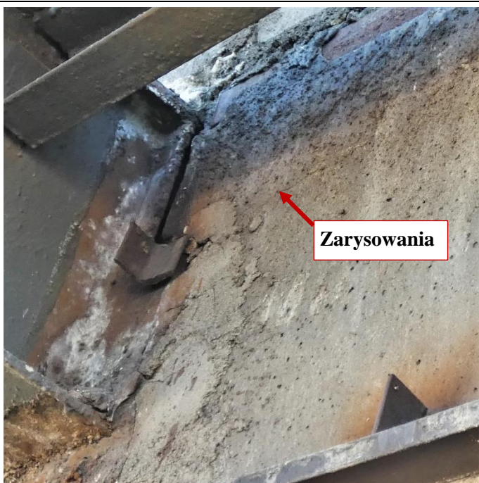
Fot. 72 Kondygnacja 6 (Poziom +25.20) Elewacja Północna – belka w osiach 12-13/I. Zarysowania belki na wysokości miejsca oparcia. Zarysowania powierzchni zaprawy.
