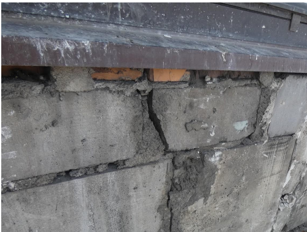
Fot. 7 Widok zwieńczenia ściany ceramicznymi elementami murowymi.
