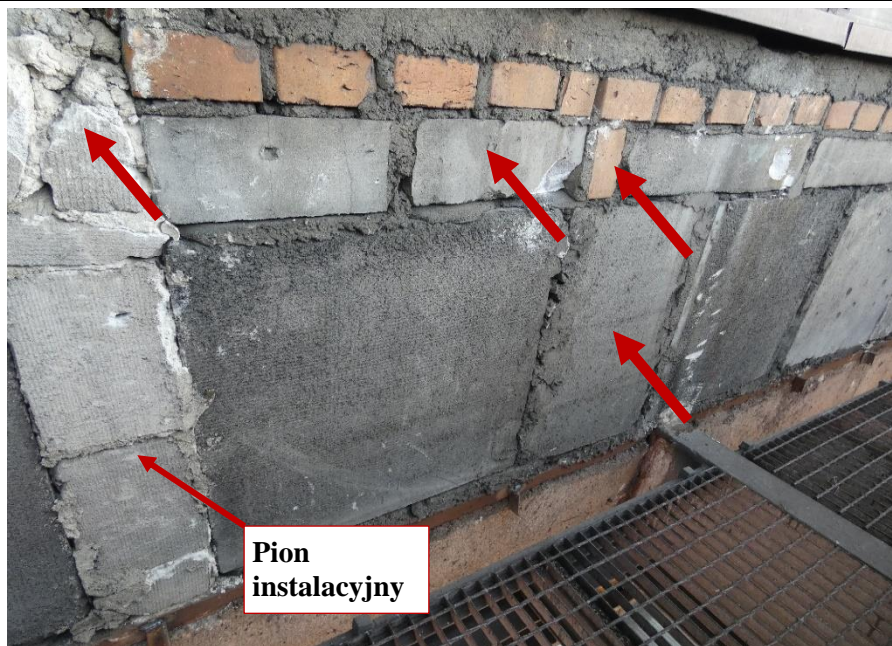
Fot. 37 Kondygnacja 6 (Poziom +25.20) Elewacja Zachodnia – widok ściany murowanej w osiach 10/G-H.
