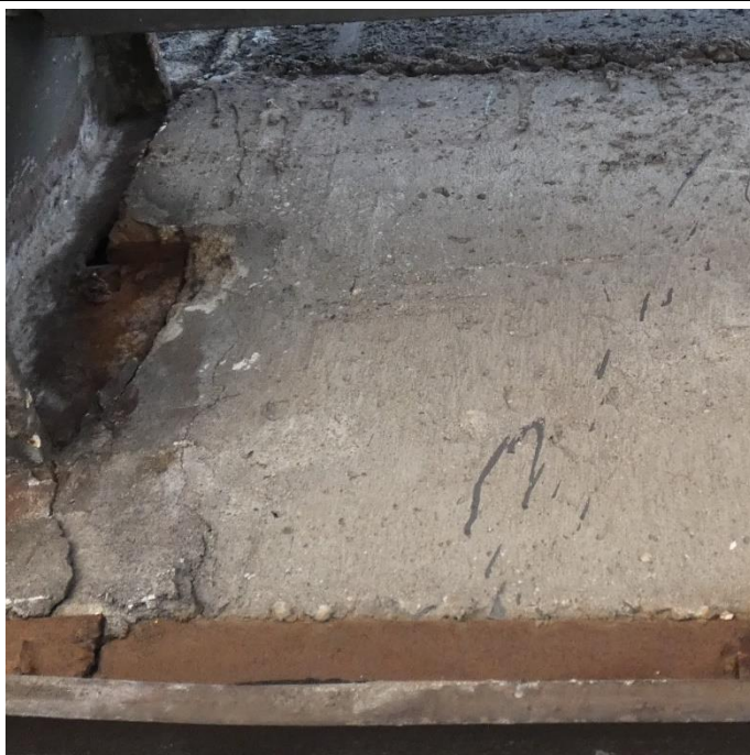
Fot. 87 Kondygnacja 6 (Poziom +25.20) Elewacja Zachodnia – belka w osiach 10/G-H. Spękania i zarysowania powierzchni zaprawy. Brak widocznych uszkodzeń belki przy podporze.
