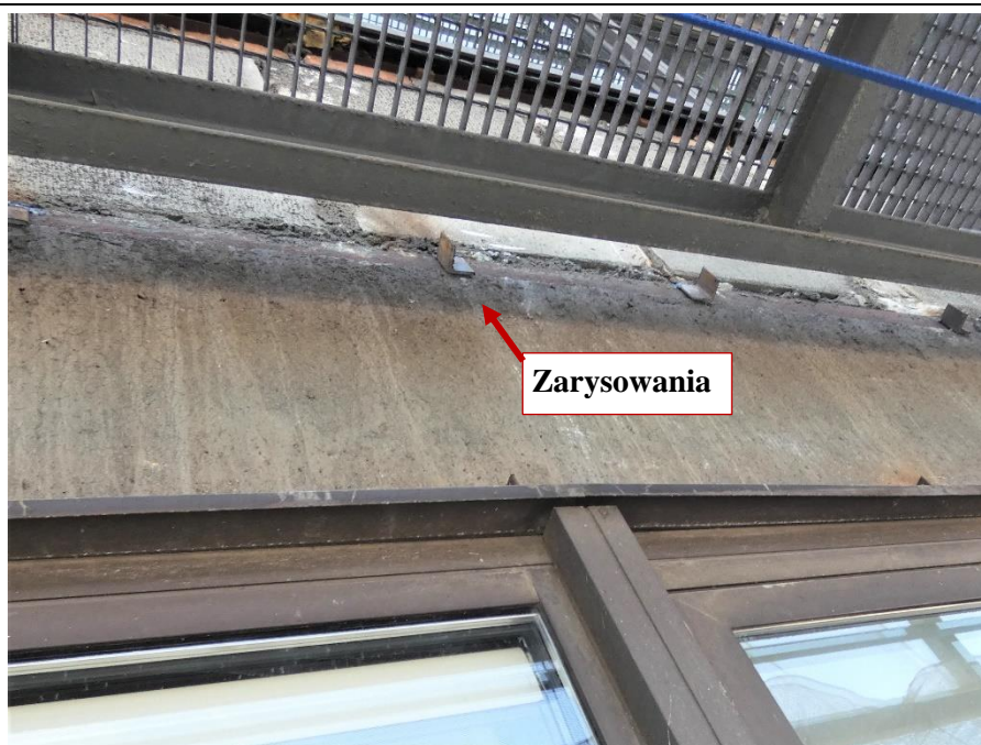
Fot. 76 Kondygnacja 6 (Poziom +25.20) Elewacja Północna – belka w osiach 11-12/I. Zarysowanie belki w przęśle na wysokości miejsca oparcia.
