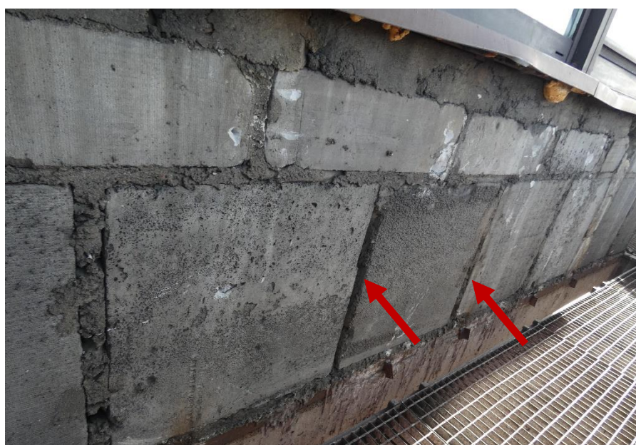
Fot. 42 Kondygnacja 6 (Poziom +25.20) Elewacja Zachodnia – widok ściany murowanej w osiach 10/E-F.
