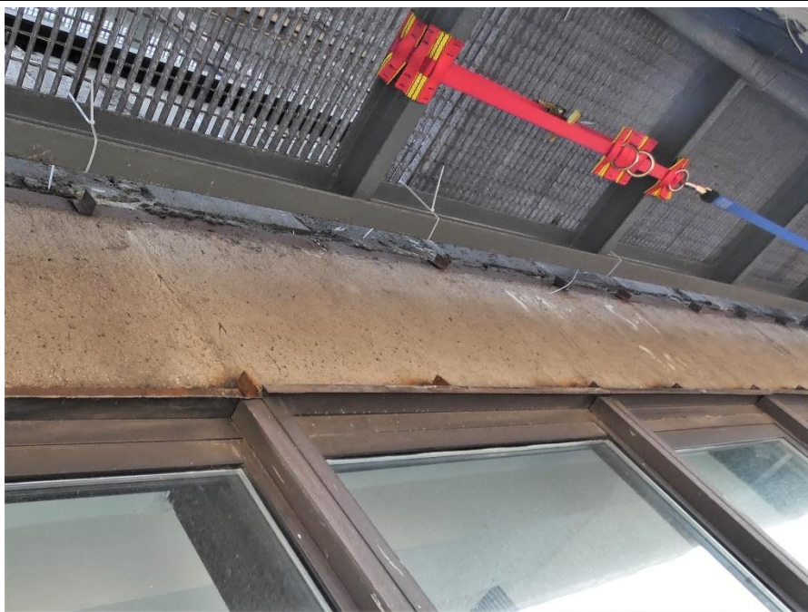
Fot. 85 Kondygnacja 6 (Poziom +25.20) Elewacja Zachodnia – belka w osiach 10/H-I. Brak widocznych uszkodzeń belki w przęśle.
