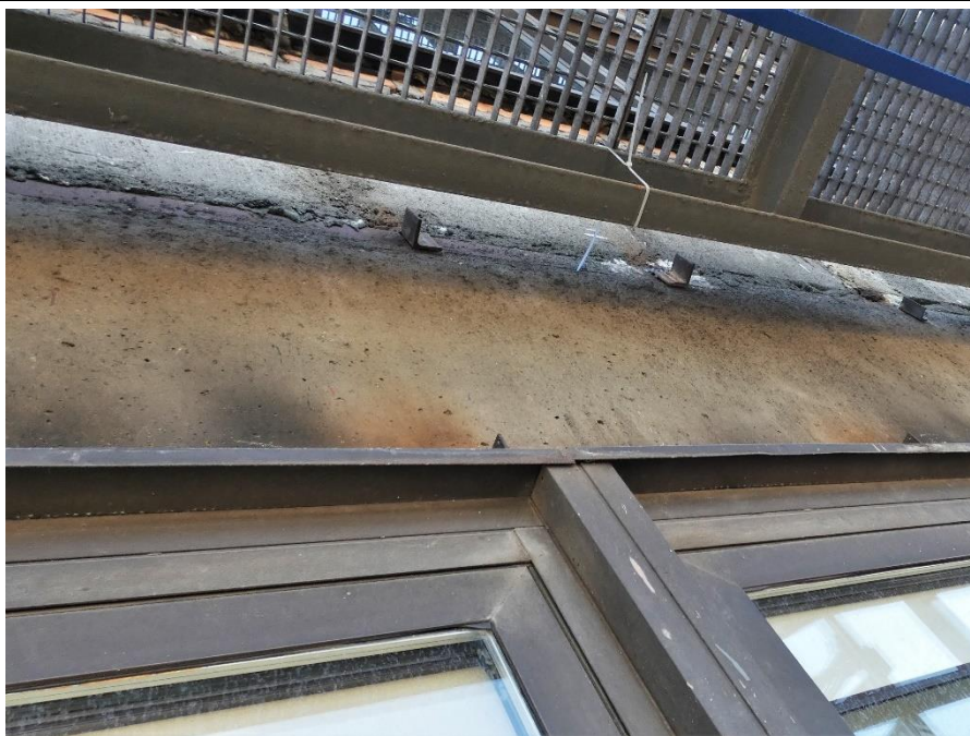
Fot. 70 Kondygnacja 6 (Poziom +25.20) Elewacja Północna – belka w osiach 13-14/I. Brak widocznych uszkodzeń belki w przęśle.
