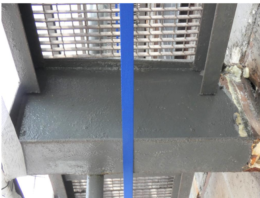
Fot. 153, 154 Kondygnacja 6 (Poziom +25.20) Elewacja Zachodnia– wspornik w osiach 10/F (widok z dołu) Brak widocznych uszkodzeń wspornika.
