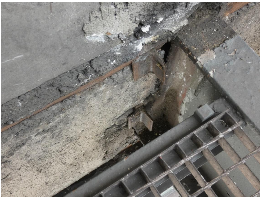
Fot. 117 Wspornik stalowy w miejscu oparcia belek żelbetowych (widok z góry)
