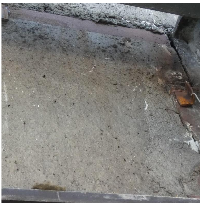
Fot. 77 Kondygnacja 6 (Poziom +25.20) Elewacja Północna – belka w osiach 11-12/I. Brak widocznych uszkodzeń belki przy podporze. Zarysowania powierzchni zaprawy.
