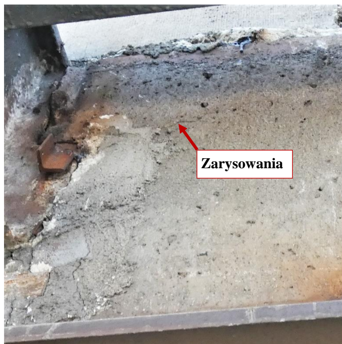
Fot. 75 Kondygnacja 6 (Poziom +25.20) Elewacja Północna – belka w osiach 11-12/I. Przestrzeń między elementami wypełniona zaprawą. Zarysowania belki na wysokości miejsca oparcia. Zarysowania powierzchni zaprawy.
