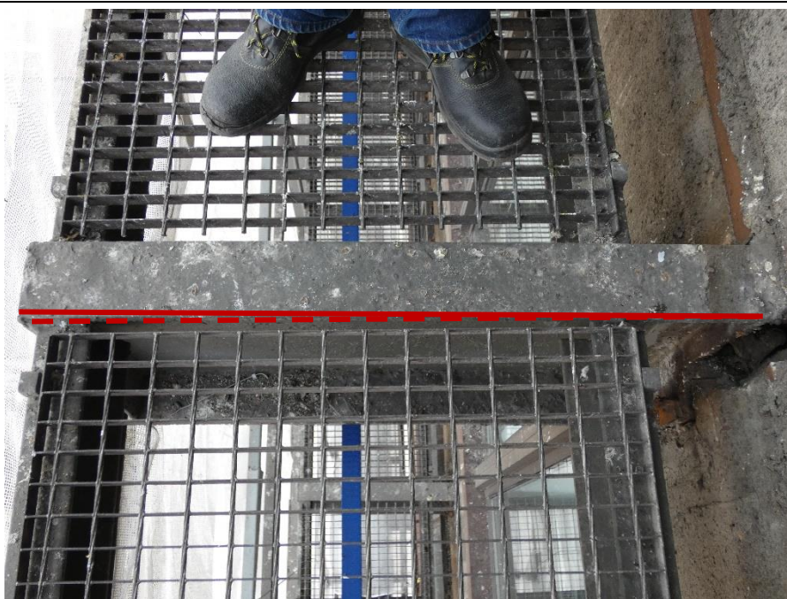
Fot. 142 Kondygnacja 6 (Poziom +25.20) Elewacja Północna – wspornik w osiach 11/I (widok z góry) Przemieszczenia wspornika w kierunku osi 12. Brak widocznych uszkodzeń wspornika.
