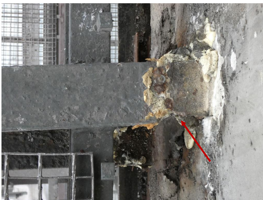
Fot. 155, 156 Kondygnacja 6 (Poziom +25.20) Elewacja Zachodnia– wspornik w osiach 10/F (widok z góry) Przemieszczenie wspornika w kierunku osi E. Uszkodzenie pasa górnego, szerokość pasa przy murze 8,5 cm.
