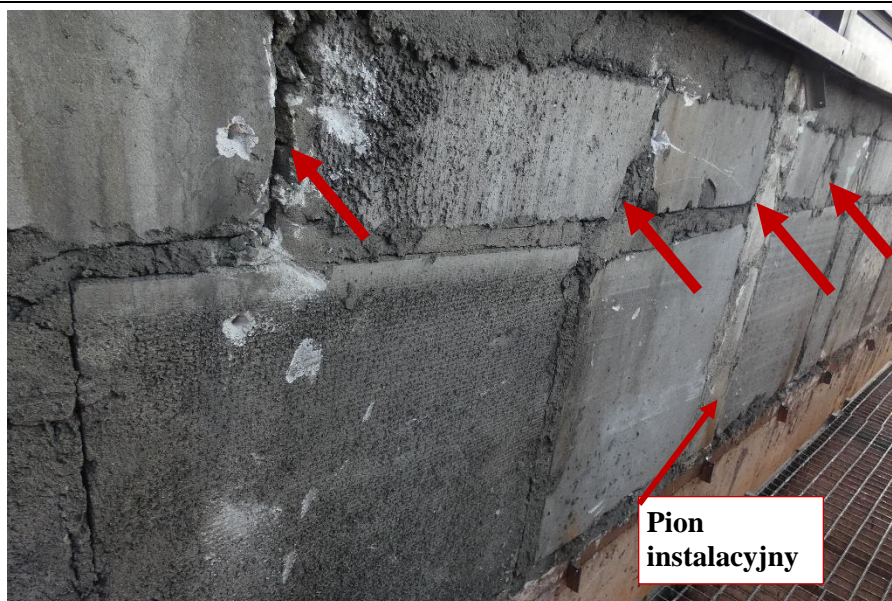
Fot. 41 Kondygnacja 6 (Poziom +25.20) Elewacja Zachodnia – widok ściany murowanej w osiach 10/E-F.
