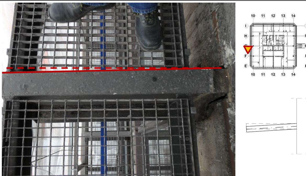
Fot. 152 Kondygnacja 6 (Poziom +25.20) Elewacja Zachodnia– wspornik w osiach 10/G (widok z góry) Przemieszczenie wspornika w kierunku osi F. Brak widocznych uszkodzeń wspornika.
