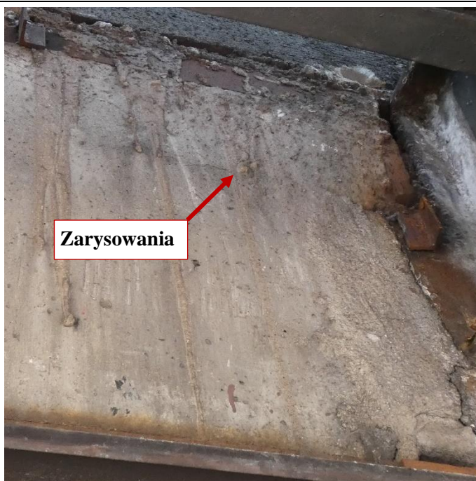
Fot. 89 Kondygnacja 6 (Poziom +25.20) Elewacja Zachodnia – belka w osiach 10/G-H. Zarysowanie elementu w miejscu oparcia. Spękania i zarysowania powierzchni zaprawy
