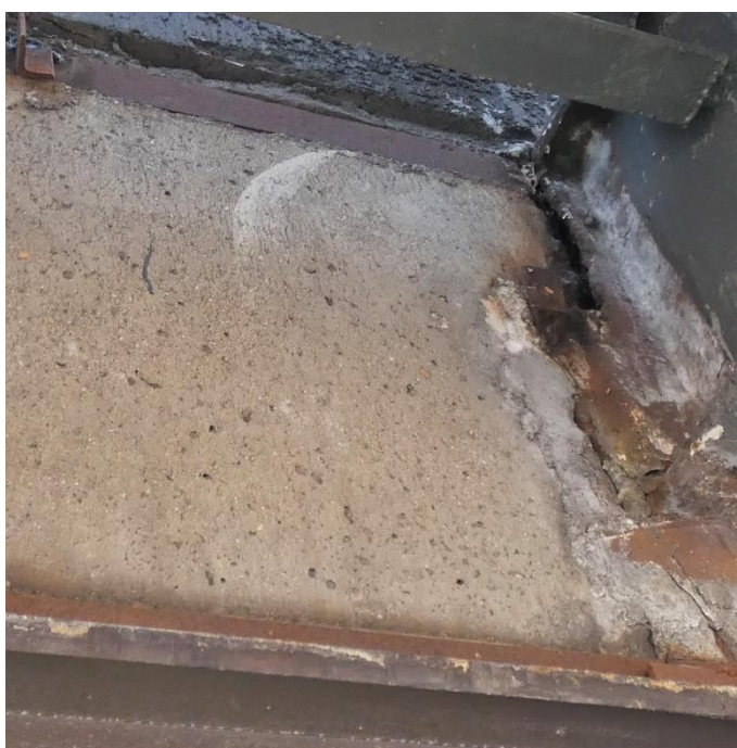
Fot. 86 Kondygnacja 6 (Poziom +25.20) Elewacja Zachodnia – belka w osiach 10/H-I. Spękania i zarysowania powierzchni zaprawy. Brak widocznych uszkodzeń belki przy podporze.
