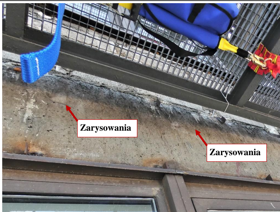
Fot. 80 Kondygnacja 6 (Poziom +25.20) Elewacja Północna – belka w osiach 10-11/I. Zarysowania belki w prześle na wysokości miejsca oparcia.
