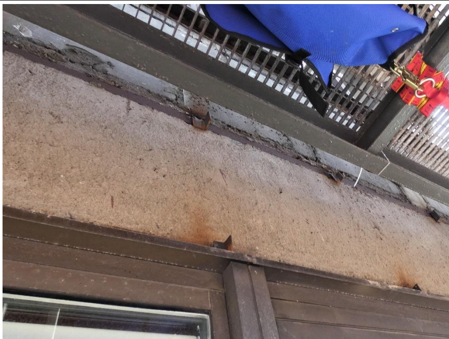
Fot. 96 Kondygnacja 6 (Poziom +25.20) Elewacja Zachodnia – belka w osiach 10/E-F. Brak widocznych uszkodzeń belki w przęśle
