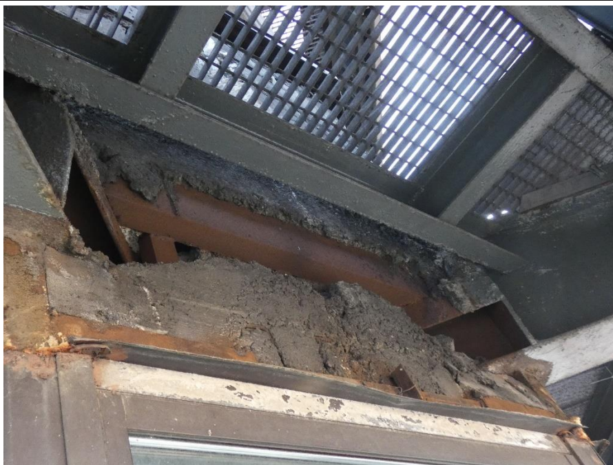
Fot. 82 Kondygnacja 6 (Poziom +25.20) Elewacja Północna – belka w osiach 10/I. Całkowite odkrycie stalowych profili ceowych opartych na wspornikach stalowych.
