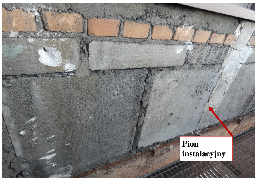
Fot. 38 Kondygnacja 6 (Poziom +25.20) Elewacja Zachodnia – widok ściany murowanej w osiach 10/F-G.
