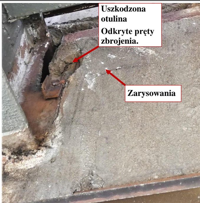
Fot. 108 Kondygnacja 6 (Poziom +25.20) Elewacja Południowa – belka w osiach 12-13/E. Uszkodzona otulina. Odkryte pręty zbrojenia. Zarysowanie belki na wysokości miejsca oparcia. Zarysowania powierzchni zaprawy.
