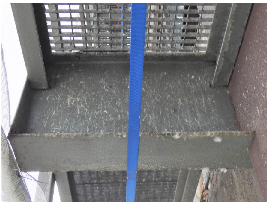
Fot. 124, 125 Kondygnacja 6 (Poziom +25.20) Elewacja Wschodnia – wspornik w osiach 14/F (widok z dołu) Pozostałości po drabinie ewakuacyjnej. Brak widocznych uszkodzeń wspornika.
