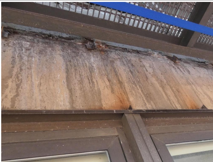
Fot. 92 Kondygnacja 6 (Poziom +25.20) Elewacja Zachodnia – belka w osiach 10/F-G. Brak widocznych uszkodzeń belki w przęśle.
