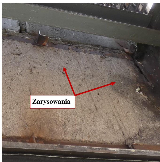
Fot. 97 Kondygnacja 6 (Poziom +25.20) Elewacja Zachodnia – belka w osiach 10/E-F. Zarysowanie belki na wysokości miejsca oparcia. Spękania i zarysowania powierzchni zaprawy.
