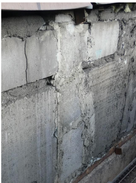
Fot. 10 Widok zamkniętego pionu instalacyjnego
