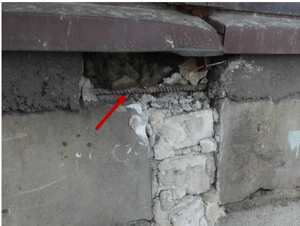
Fot. 6 Widok zbrojenia podlewki zwieńczającej ścianę.
