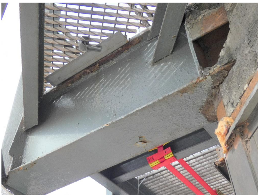
Fot. 157, 158 Kondygnacja 6 (Poziom +25.20) Elewacja Zachodnia– wspornik w osiach 10/E. Brak widocznych uszkodzeń wspornika.
