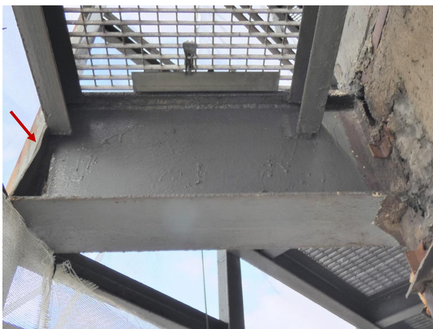
Fot. 145, 146 Kondygnacja 6 (Poziom +25.20) Elewacja Zachodnia– wspornik w osiach 10/I. Mechaniczne uszkodzenie żeberka usztywniającego.
