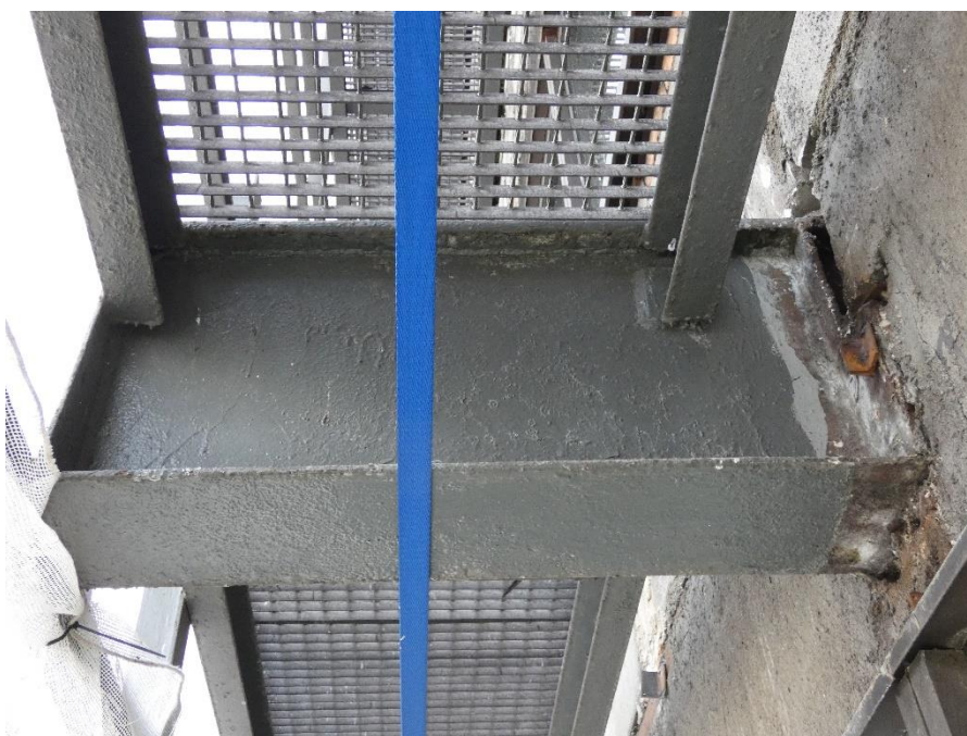
Fot. 140, 141 Kondygnacja 6 (Poziom +25.20) Elewacja Północna – wspornik w osiach 11/I (widok z dołu) Brak widocznych uszkodzeń wspornika.
