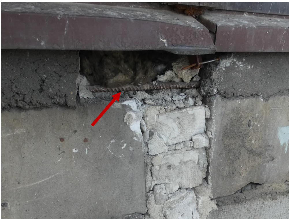
Fot. 6 Widok zbrojenia podlewki zwieńczającej ścianę.
