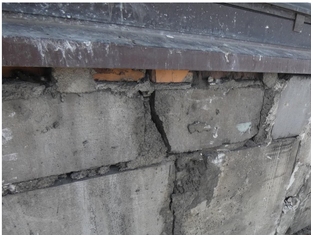
Fot. 7 Widok zwieńczenia ściany ceramicznymi elementami murowymi.
