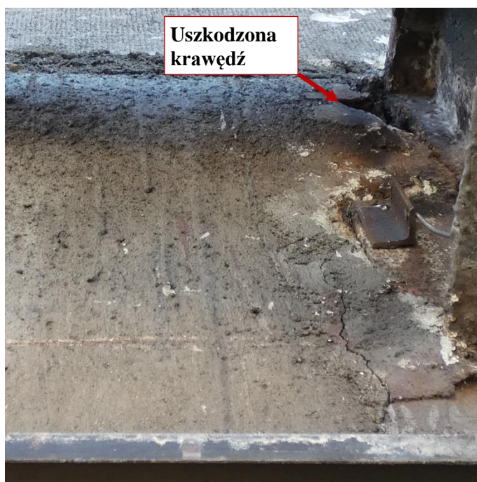
Fot. 71 Kondygnacja 6 (Poziom +25.20) Elewacja Północna – belka w osiach 13-14/I. Uszkodzona krawędź elementu. Spękania i zarysowania powierzchni zaprawy.
