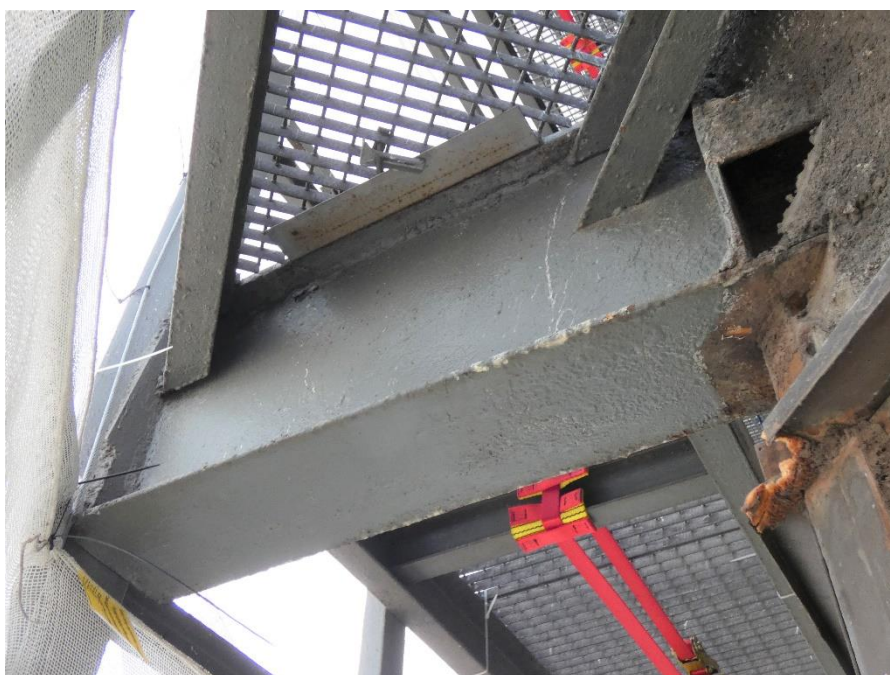
Fot. 131, 132 Kondygnacja 6 (Poziom +25.20) Elewacja Wschodnia – wspornik w osiach 14/I. Brak widocznych uszkodzeń wspornika.
