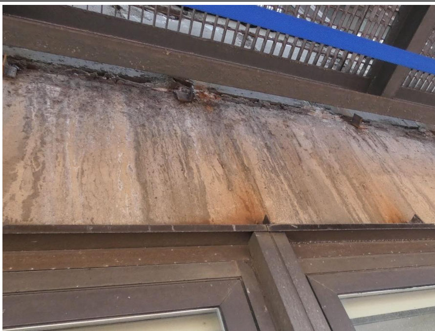
Fot. 92 Kondygnacja 6 (Poziom +25.20) Elewacja Zachodnia – belka w osiach 10/F-G. Brak widocznych uszkodzeń belki w przęśle.
