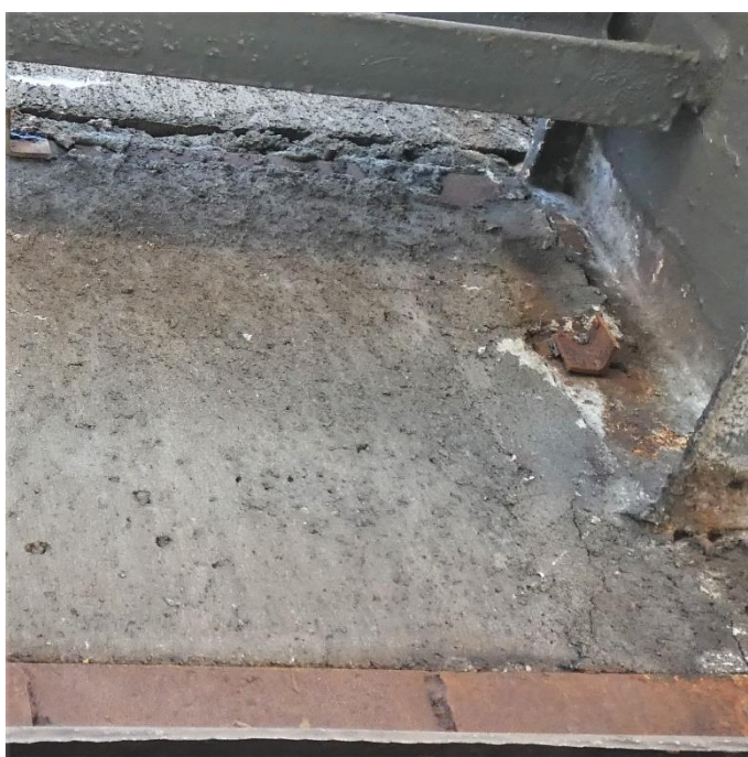
Fot. 81 Kondygnacja 6 (Poziom +25.20) Elewacja Północna – belka w osiach 10-11/I. Przestrzeń między elementami wypełniona zaprawą. Brak widocznych uszkodzeń belki przy podporze. Zarysowania powierzchni zaprawy.
