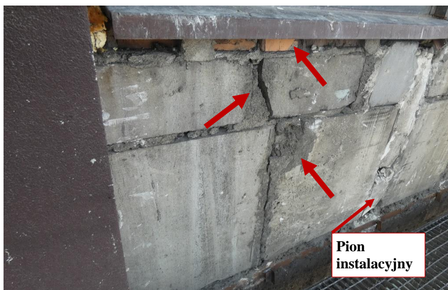
Fot. 14 Kondygnacja 6 (Poziom +25.20) Elewacja Wschodnia – widok ściany murowanej w osiach 14/H-I. Zbyt duże wymiary spoin. Ściana z uszkodzonych elementów murowych o zróżnicowanych kształtach (24x60, 60x60 cm). Zwieńczenie ściany uszkodzonymi ceramicznymi elementami murowymi gr. 6,5 cm. Wypełnienie ubytków między elementami i uszkodzonych miejsc zaprawą i gruzem. Zamknięcie pionu instalacyjnego zaprawą i gruzem.
