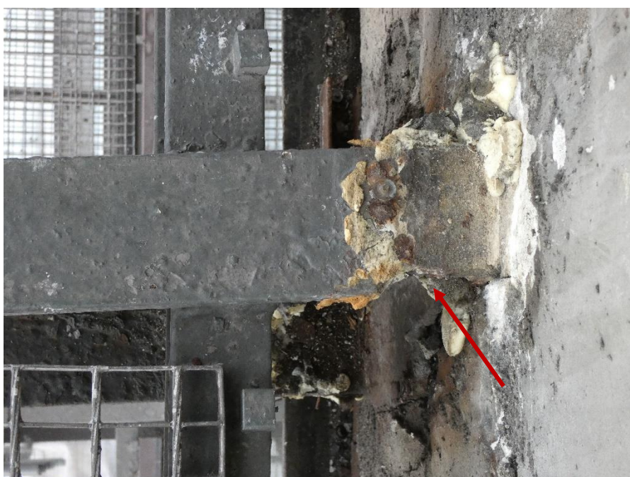
Fot. 155, 156 Kondygnacja 6 (Poziom +25.20) Elewacja Zachodnia– wspornik w osiach 10/F (widok z góry) Przemieszczenie wspornika w kierunku osi E. Uszkodzenie pasa górnego, szerokość pasa przy murze 8,5 cm.
