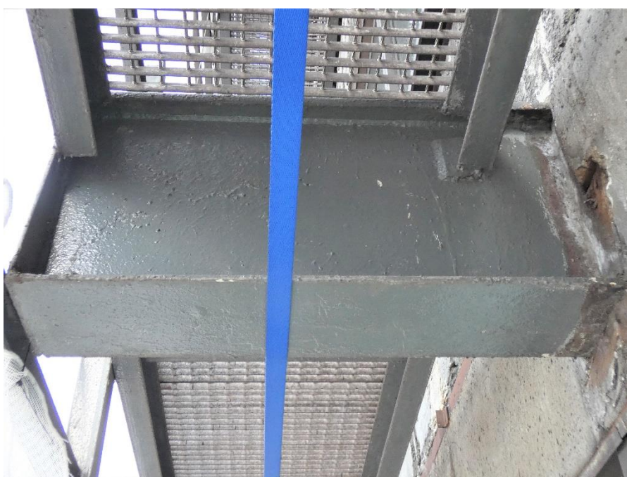
Fot. 147, 148 Kondygnacja 6 (Poziom +25.20) Elewacja Zachodnia– wspornik w osiach 10/H (widok z góry) Mechaniczne uszkodzenie żeberka usztywniającego.
