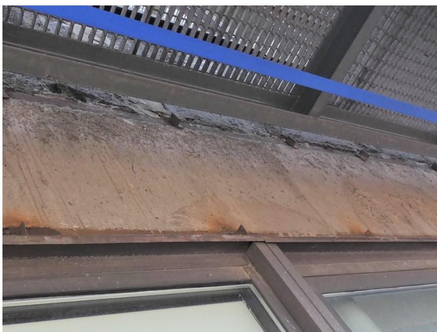
Fot. 88 Kondygnacja 6 (Poziom +25.20) Elewacja Zachodnia – belka w osiach 10/G-H. Brak widocznych uszkodzeń belki w przęśle.
