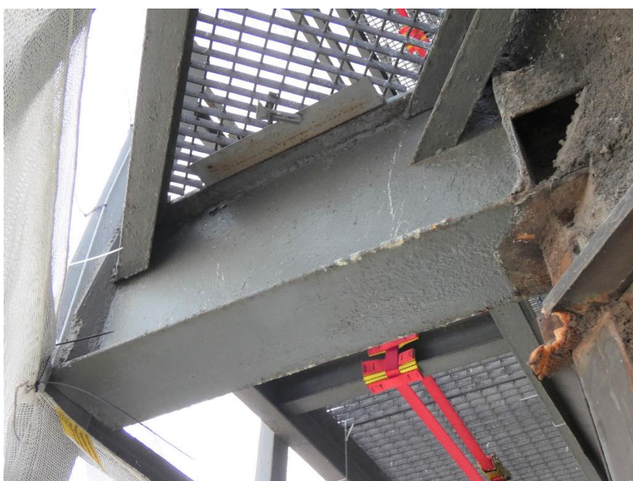
Fot. 131, 132 Kondygnacja 6 (Poziom +25.20) Elewacja Wschodnia – wspornik w osiach 14/I. Brak widocznych uszkodzeń wspornika.
