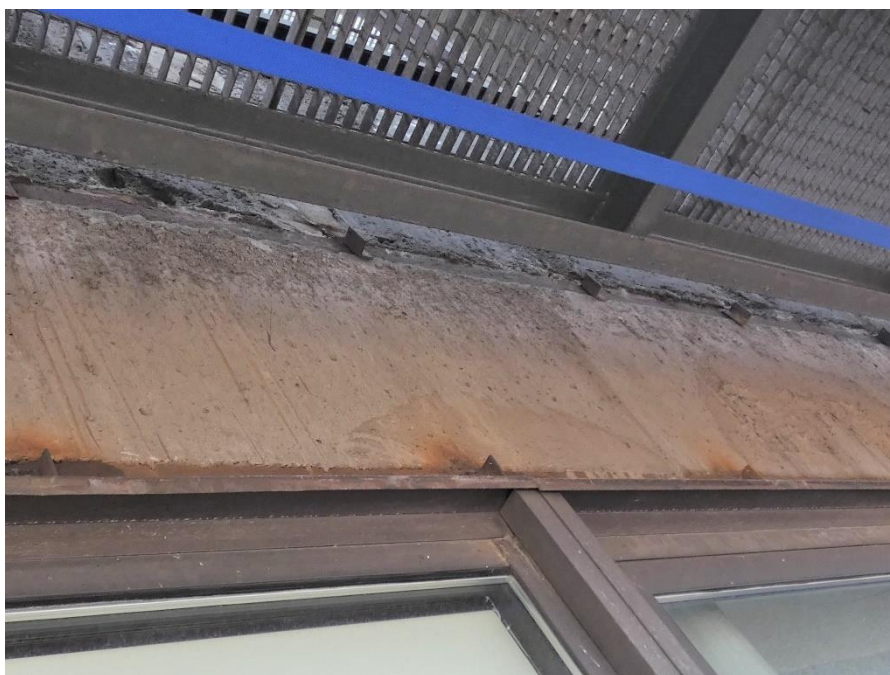
Fot. 88 Kondygnacja 6 (Poziom +25.20) Elewacja Zachodnia – belka w osiach 10/G-H. Brak widocznych uszkodzeń belki w przęśle.
