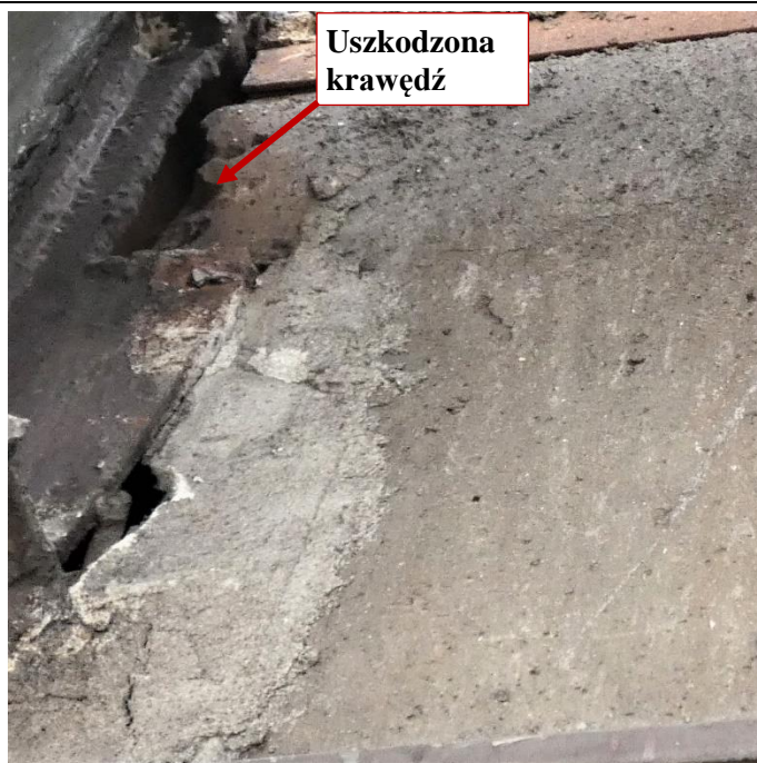
Fot. 63 Kondygnacja 11 (Poziom +41.70) Elewacja Wschodnia – belka w osiach 14/H-I. Uszkodzona krawędź elementu, brak widocznego zbrojenia. Zalegający gruz w przestrzeni między elementami. Spękania i zarysowania powierzchni zaprawy
