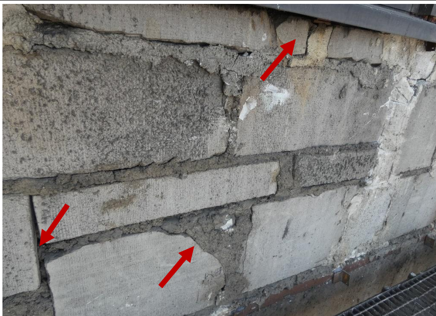
Fot. 27 Kondygnacja 11 (Poziom +41.70) Elewacja Północna – widok ściany murowanej w osiach 12-13/I. Zbyt duże wymiary spoin. Ubytki spoin pionowych. Niewłaściwe przewiązanie elementów. Wykonanie ściany z uszkodzonych elementów murowanych o zróżnicowanych kształtach. Wypełnienie ubytków między elementami i uszkodzonych miejsc zaprawą i gruzem. Zwieńczenie ściany elementami murowymi i gruzem.
