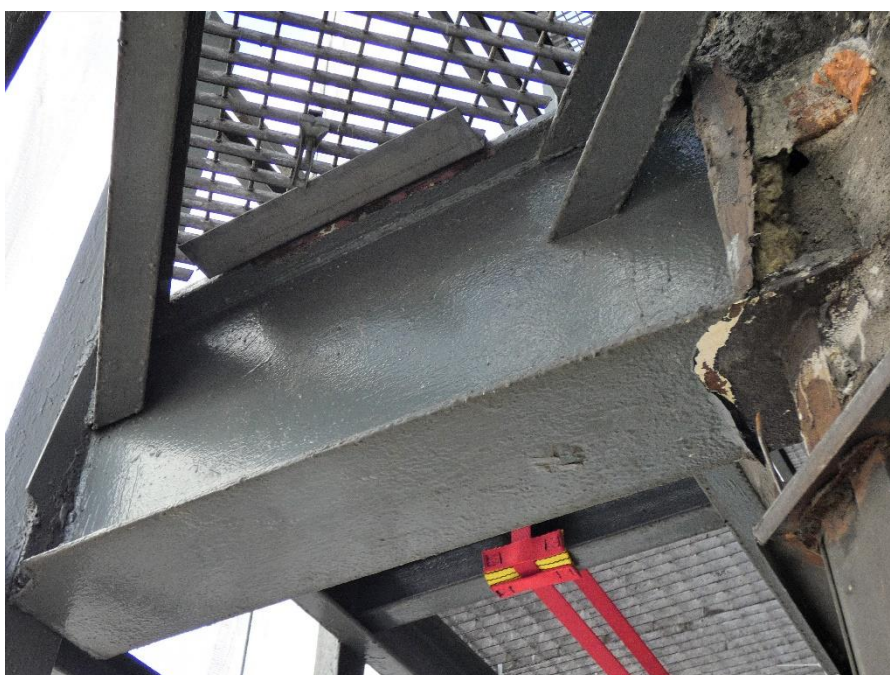
Fot. 138, 139 Kondygnacja 11 (Poziom +41.70) Elewacja Północna – wspornik w osiach 10/I. Brak widocznych uszkodzeń wspornika.
