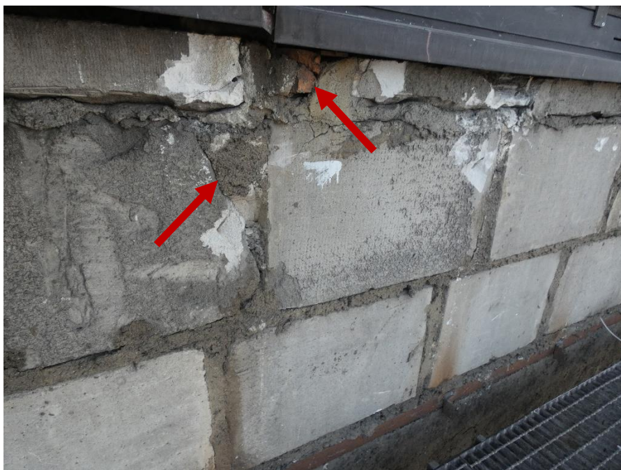
Fot. 34 Kondygnacja 11 (Poziom +41.70) Elewacja Północna – widok ściany murowanej w osiach 10-11/I. Zbyt duże wymiary spoin. Wykonanie ściany z uszkodzonych elementów murowych. Wypełnienie ubytków między elementami i uszkodzonych miejsc zaprawą. Zwieńczenie ściany elementami murowymi i gruzem.
