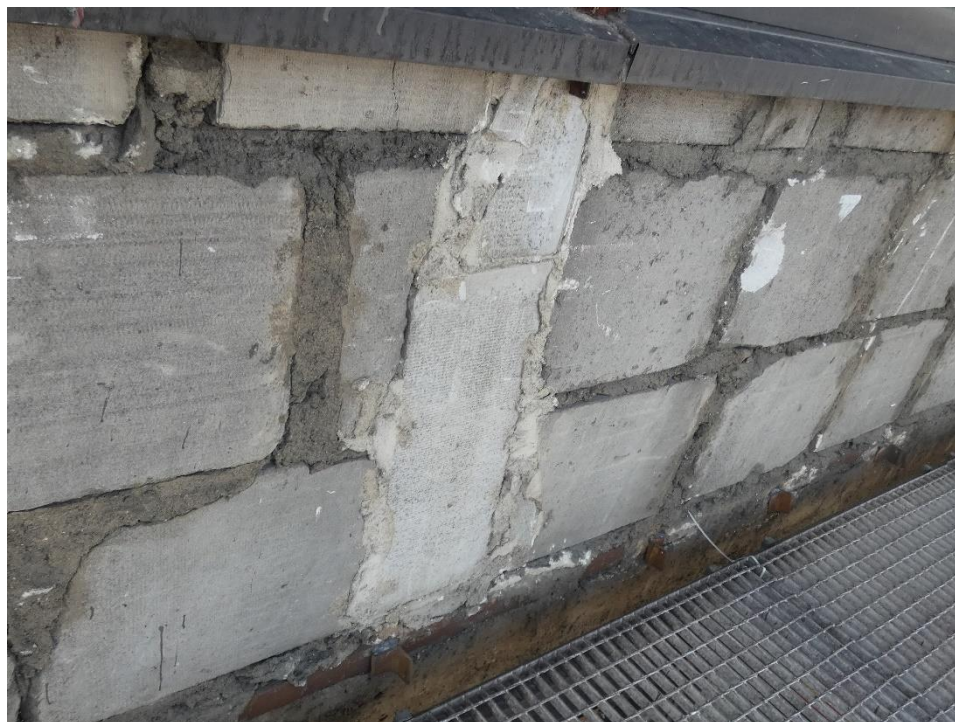
Fot. 9 Przykład zamknięcia pionu instalacyjnego.
