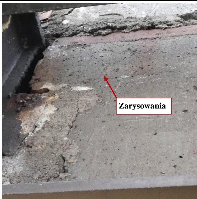
Fot. 67 Kondygnacja 11 (Poziom +41.70) Elewacja Północna – belka w osiach 13-14/I. Zarysowania belki na wysokości miejsca oparcia. Zarysowania powierzchni zaprawy.
