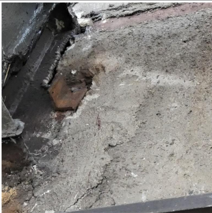
Fot. 78 Kondygnacja 11 (Poziom +41.70) Elewacja Północna – belka w osiach 10-11/I. Brak widocznych uszkodzeń belki przy podporze. Zarysowania powierzchni zaprawy
