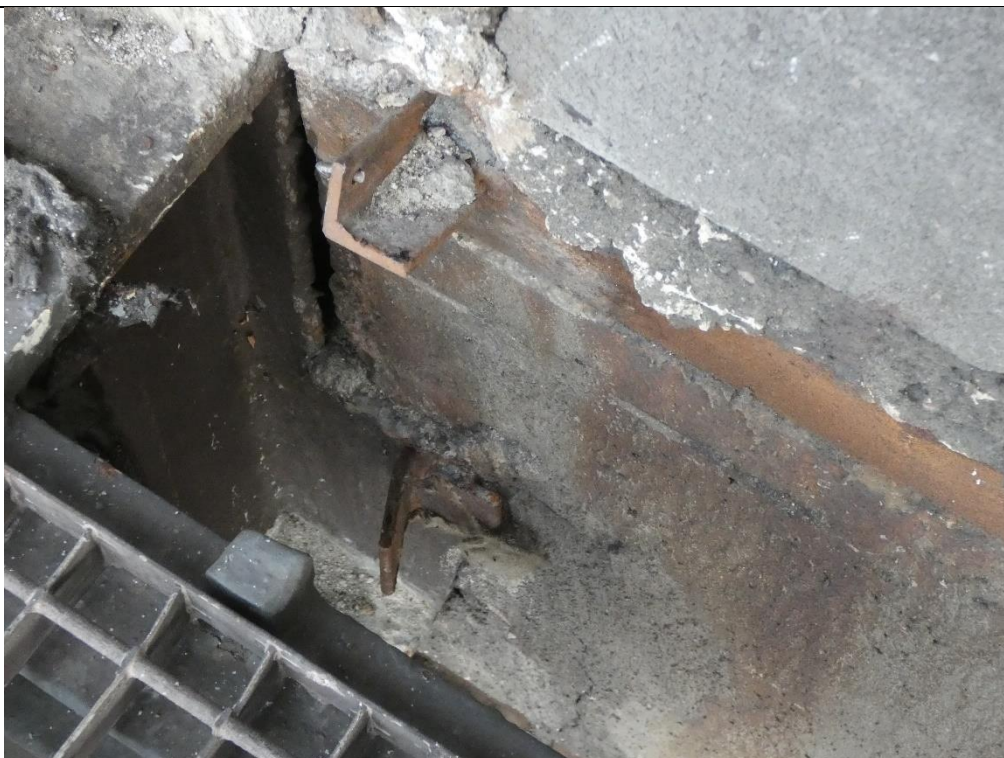
Fot. 113 Wspornik stalowy w miejscu oparcia belek żelbetowych (widok z góry)
