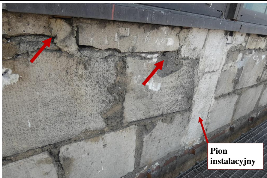
Fot. 29 Kondygnacja 11 (Poziom +41.70) Elewacja Północna – widok ściany murowanej w osiach 11-12/I. Zbyt duże wymiary spoin. Wykonanie ściany z uszkodzonych elementów murowych 36x60 cm. Wypełnienie ubytków między elementami i uszkodzonych miejsc zaprawą. Zwieńczenie ściany uszkodzonymi elementami murowymi. Zamknięcie pionu instalacyjnego.
