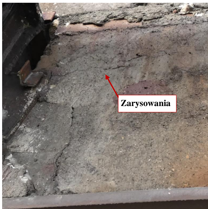
Fot. 59 Kondygnacja 11 (Poziom +41.70) Elewacja Wschodnia – belka w osiach 14/E-F. Zarysowania belki na wysokości miejsca oparcia. Zarysowania powierzchni zaprawy.
