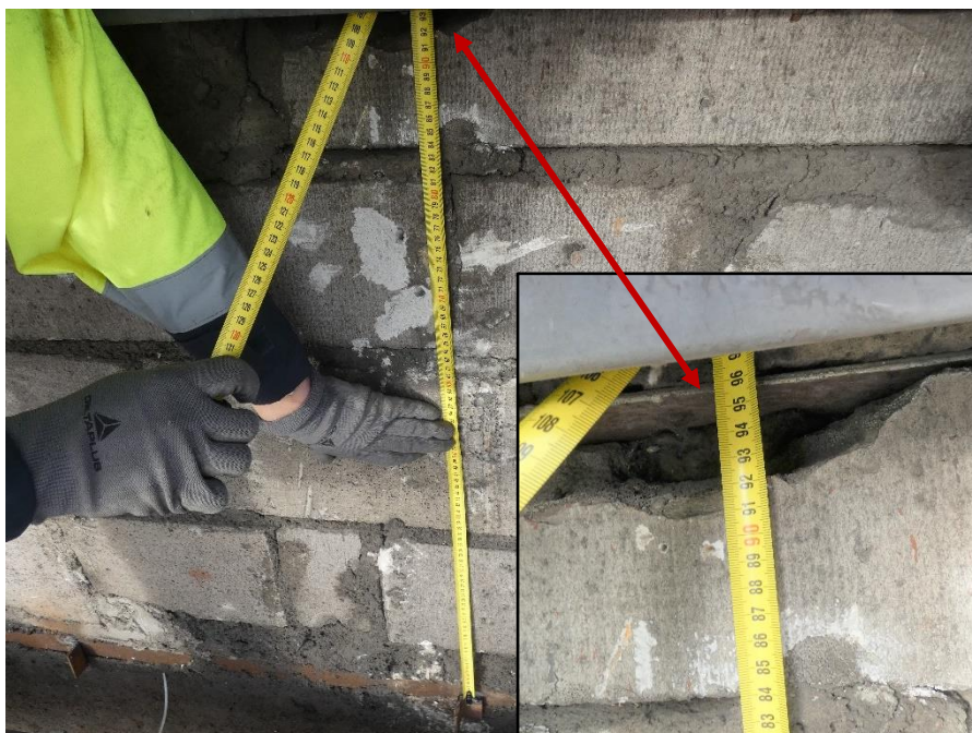
Fot. 18 Kondygnacja 11 (Poziom +41.70) Elewacja Wschodnia – widok ściany murowanej w osiach 14/H-I. Wysokość ściany murowanej ~96 cm. Grubość podlewki między belką żelbetową a ścianą ~11 cm. Element murowy bezpośrednio pod profilem stalowym (brak podlewki).
