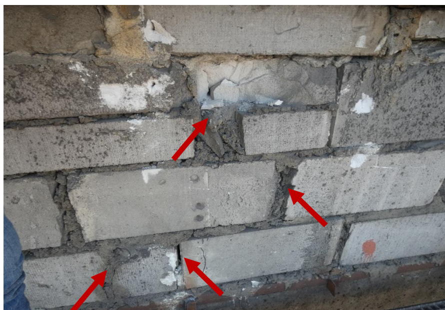
Fot. 26 Kondygnacja 11 (Poziom +41.70) Elewacja Północna – widok ściany murowanej w osiach 12-13/I.
