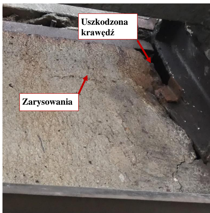
Fot. 97 Kondygnacja 11 (Poziom +41.70) Elewacja Zachodnia – belka w osiach 10/E-F. Uszkodzona krawędź elementu, brak widocznego zbrojenia. Zarysowania belki na wysokości miejsca oparcia. Zarysowania powierzchni zaprawy.
