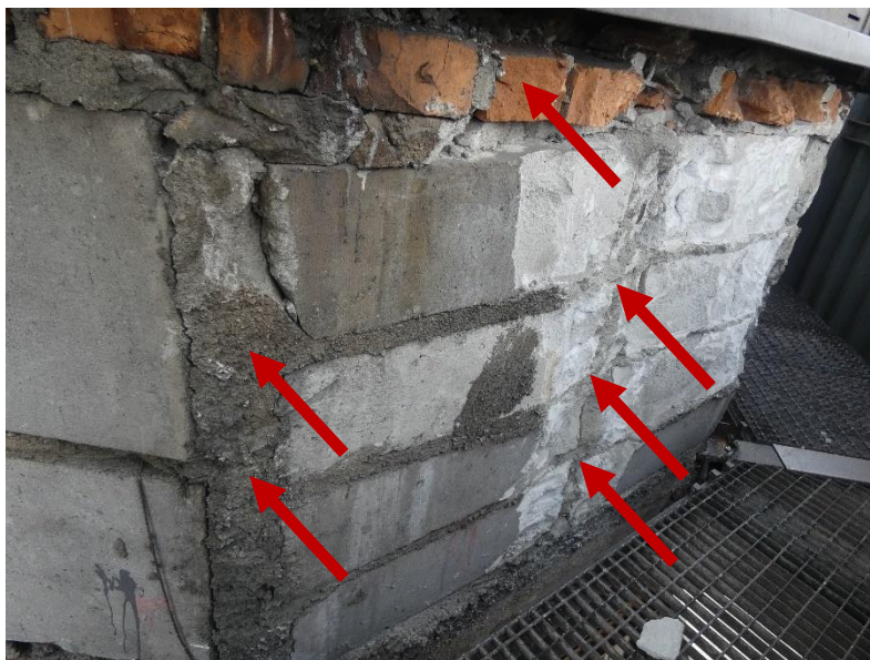
Fot. 36 Kondygnacja 11 (Poziom +41.70) Elewacja Północna – widok ściany murowanej w osiach 10/I. Zbyt duże wymiary spoin. Niewłaściwe przewiązanie elementów. Wykonanie ściany z uszkodzonych elementów murowych 18x60 cm. Wypełnienie ubytków między elementami i uszkodzonych miejsc zaprawą. Zwieńczenie ściany uszkodzonymi ceramicznymi elementami murowymi i gruzem.
