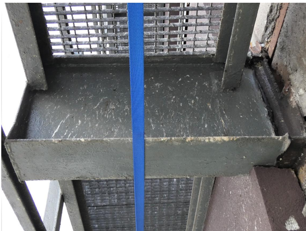
Fot. 115 Wspornik stalowy (widok z boku)
