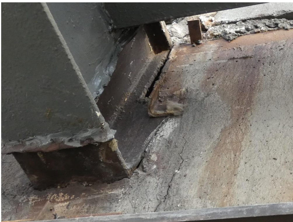
Fot. 114 Wspornik stalowy w miejscu oparcia belek żelbetowych (widok z dołu)
