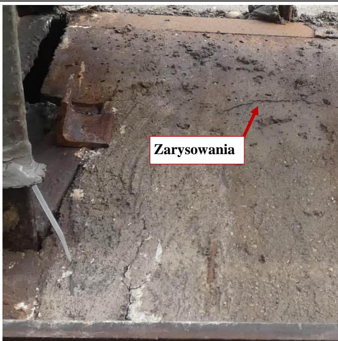
Fot. 106 Kondygnacja 11 (Poziom +41.70) Elewacja Południowa – belka w osiach 12-13/E. Zarysowania belki na wysokości miejsca oparcia. Zarysowania powierzchni zaprawy.
