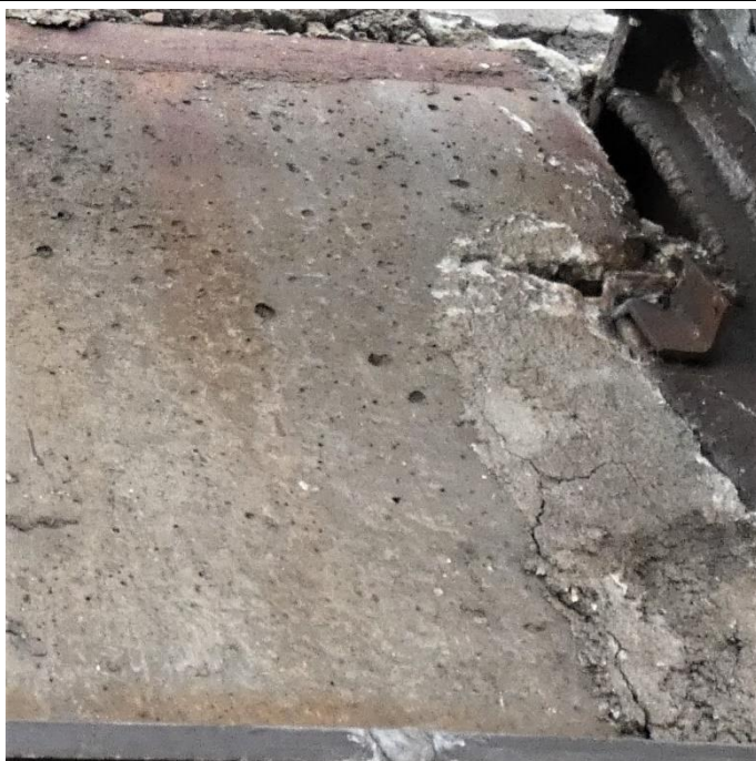
Fot. 73 Kondygnacja 11 (Poziom +41.70) Elewacja Północna – belka w osiach 12-13/I. Brak widocznych uszkodzeń belki przy podporze. Spękania i zarysowania powierzchni zaprawy.
