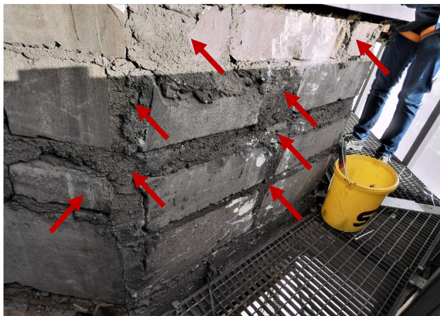
Fot. 58 Kondygnacja 11 (Poziom +41.70) Elewacja Południowa – widok ściany murowanej w osiach 14/E. Zbyt duże wymiary spoin. Niewłaściwe przewiązanie elementów. Wykonanie ściany z uszkodzonych elementów murowych 24x60 cm. Wypełnienie ubytków między elementami zaprawą i gruzem. Zwieńczenie ściany uszkodzonymi elementami murowymi i gruzem.
