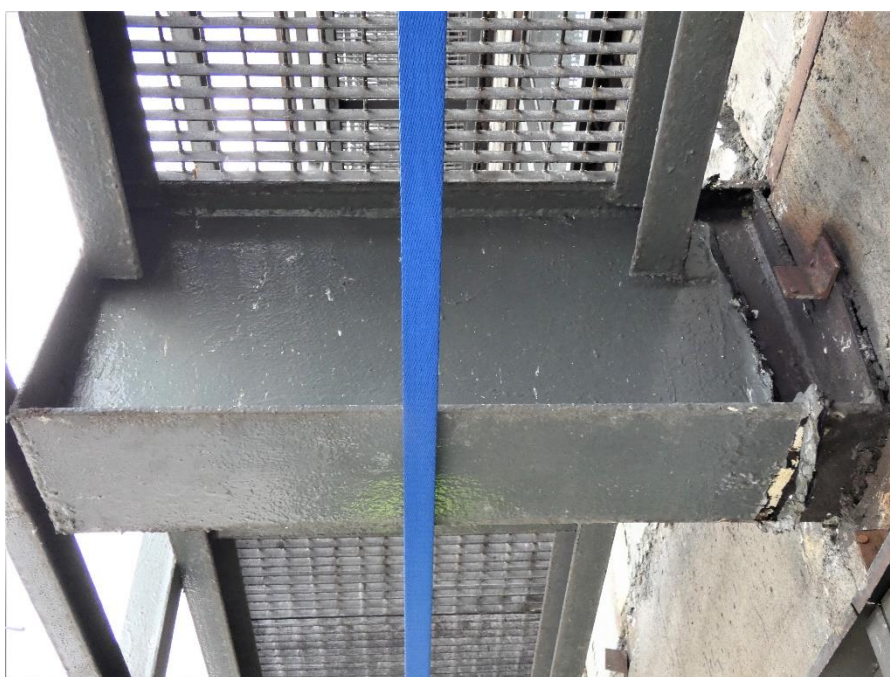
Fot. 145, 146 Kondygnacja 11 (Poziom +41.70) Elewacja Zachodnia– wspornik w osiach 10/G (widok z dołu) Brak widocznych uszkodzeń wspornika.
