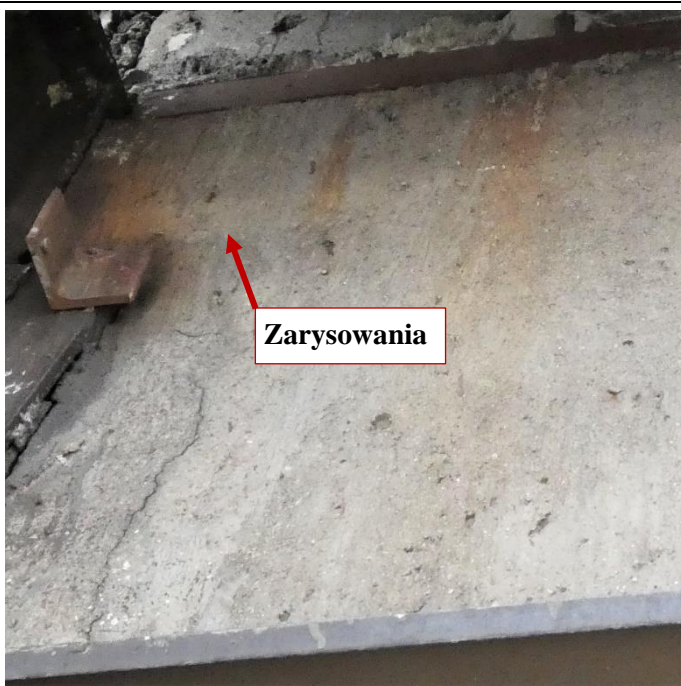
Fot. 91 Kondygnacja 11 (Poziom +41.70) Elewacja Zachodnia – belka w osiach 10/F-G. Zarysowania belki na wysokości miejsca oparcia. Zarysowania powierzchni zaprawy
