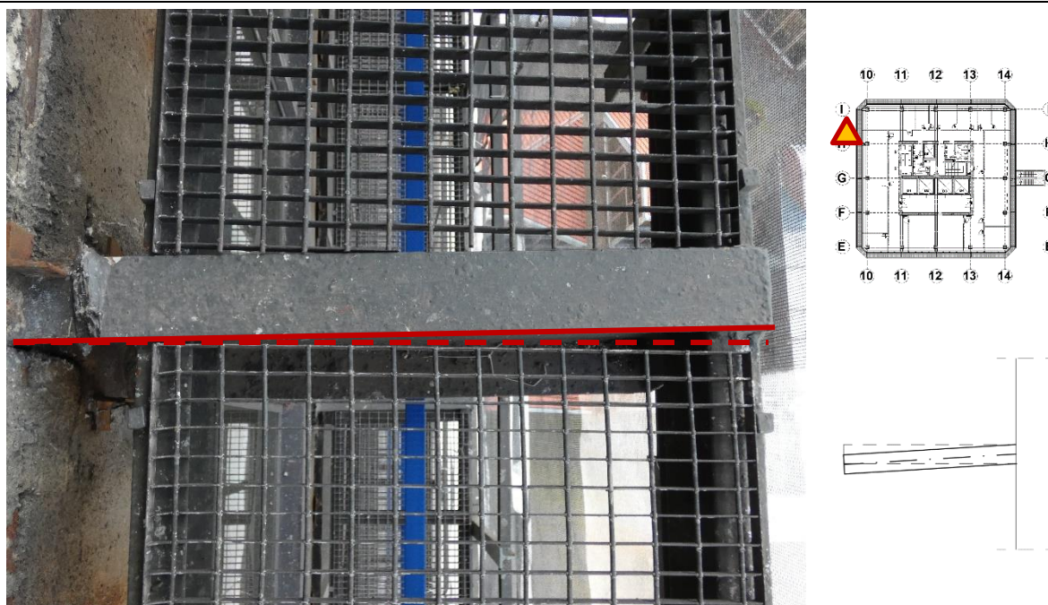
Fot. 144 Kondygnacja 11 (Poziom +41.70) Elewacja Zachodnia – wspornik w osiach 10/H (widok z góry) Przemieszczenia wspornika w kierunku osi G. Brak widocznych uszkodzeń wspornika.
