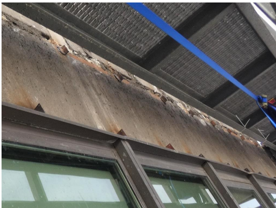
Fot. 64 Kondygnacja 11 (Poziom +41.70) Elewacja Wschodnia – belka w osiach 14/H-I. Brak widocznych uszkodzeń belki w przęśle.
