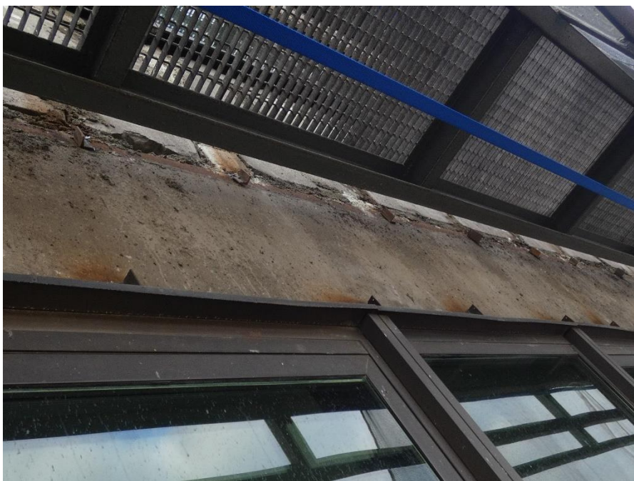
Fot. 72 Kondygnacja 11 (Poziom +41.70) Elewacja Północna – belka w osiach 12-13/I. Brak widocznych uszkodzeń belki w przęśle.
