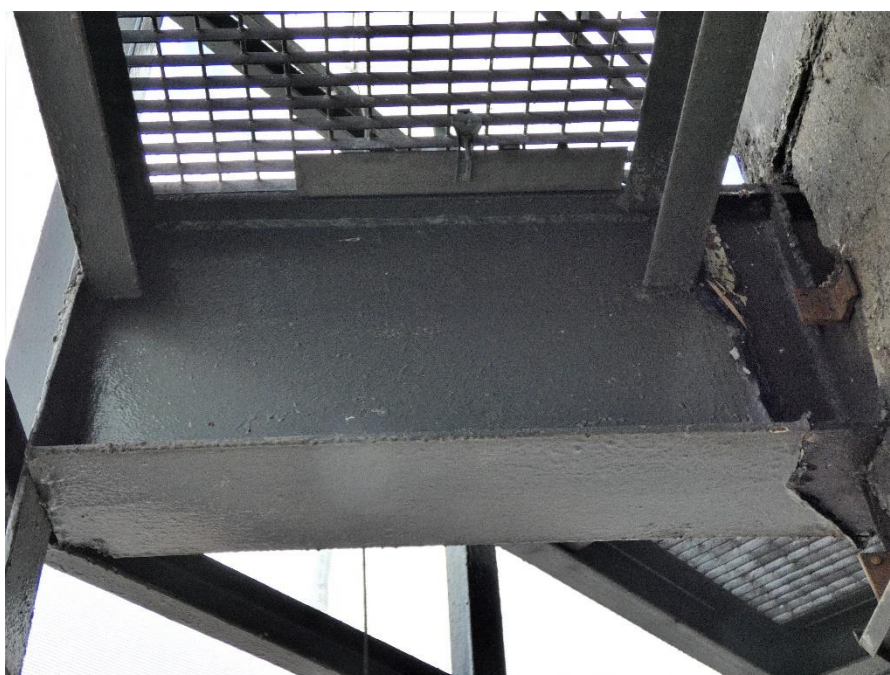
Fot. 140, 141 Kondygnacja 11 (Poziom +41.70) Elewacja Zachodnia– wspornik w osiach 10/I. Brak widocznych uszkodzeń wspornika.
