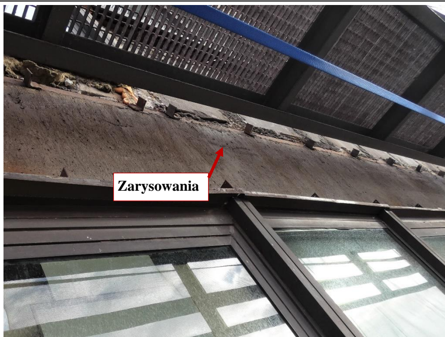
Fot. 104 Kondygnacja 11 (Poziom +41.70) Elewacja Południowa – belka w osiach 11-12/E. Zarysowania belki w przęśle na wysokości miejsca oparcia
