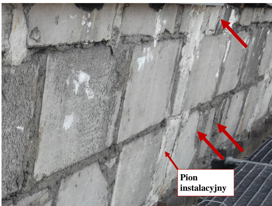
Fot. 32 Kondygnacja 11 (Poziom +41.70) Elewacja Północna – widok ściany murowanej w osiach 11-12/I. Zbyt duże wymiary spoin. Wykonanie ściany z uszkodzonych elementów murowych. Wypełnienie ubytków między elementami i uszkodzonych miejsc zaprawą i gruzem. Zwieńczenie ściany uszkodzonymi elementami murowymi. Zamknięcie pionu instalacyjnego.
