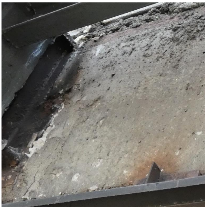
Fot. 71 Kondygnacja 11 (Poziom +41.70) Elewacja Północna – belka w osiach 12-13/I. Brak widocznych uszkodzeń belki przy podporze. Spękania i zarysowania powierzchni zaprawy
