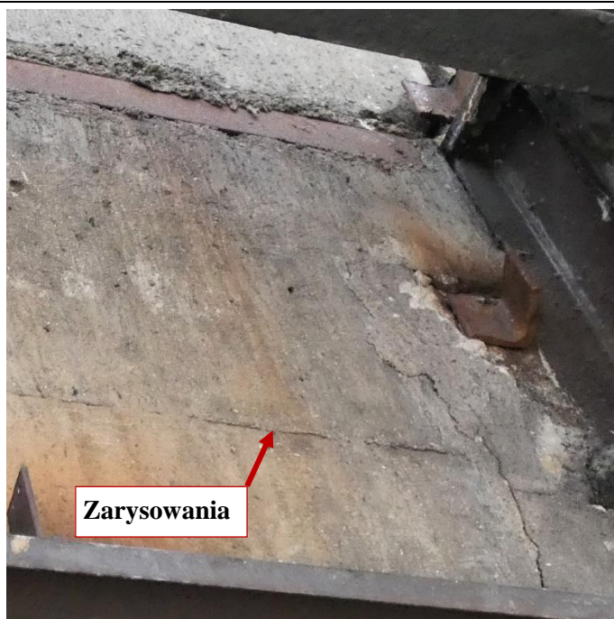
Fot. 93 Kondygnacja 11 (Poziom +41.70) Elewacja Zachodnia – belka w osiach 10/F-G. Zarysowania belki przy podporze. Zarysowania powierzchni zaprawy
