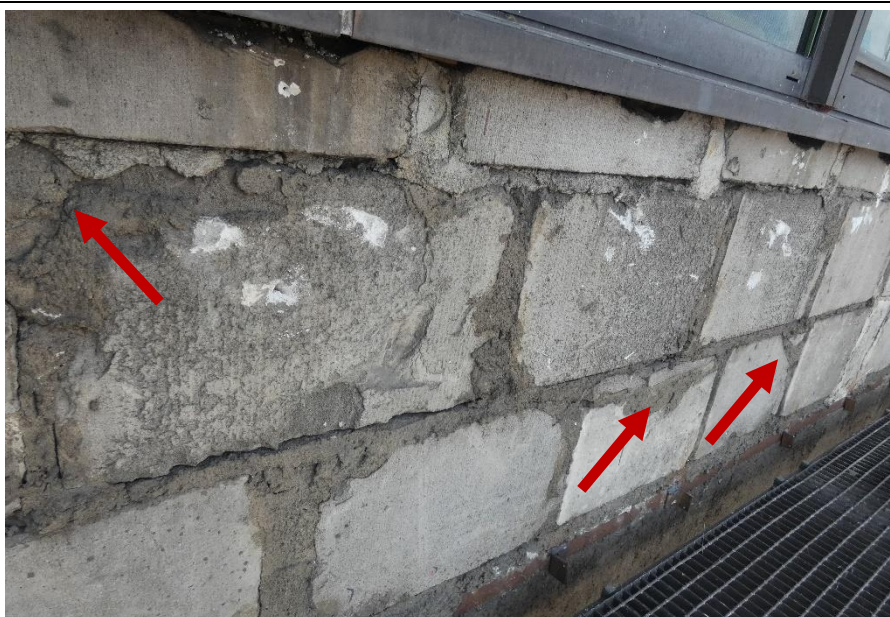
Fot. 31 Kondygnacja 11 (Poziom +41.70) Elewacja Północna – widok ściany murowanej w osiach 11-12/I. Zbyt duże wymiary spoin. Wykonanie ściany z uszkodzonych elementów murowych. Wypełnienie ubytków między elementami i uszkodzonych miejsc zaprawą i gruzem. Zwieńczenie ściany uszkodzonymi elementami murowymi.
