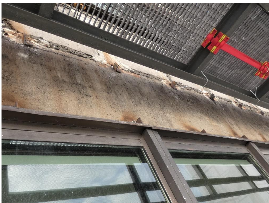
Fot. 60 Kondygnacja 11 (Poziom +41.70) Elewacja Wschodnia – belka w osiach 14/E-F. Brak widocznych uszkodzeń w przęśle belki
