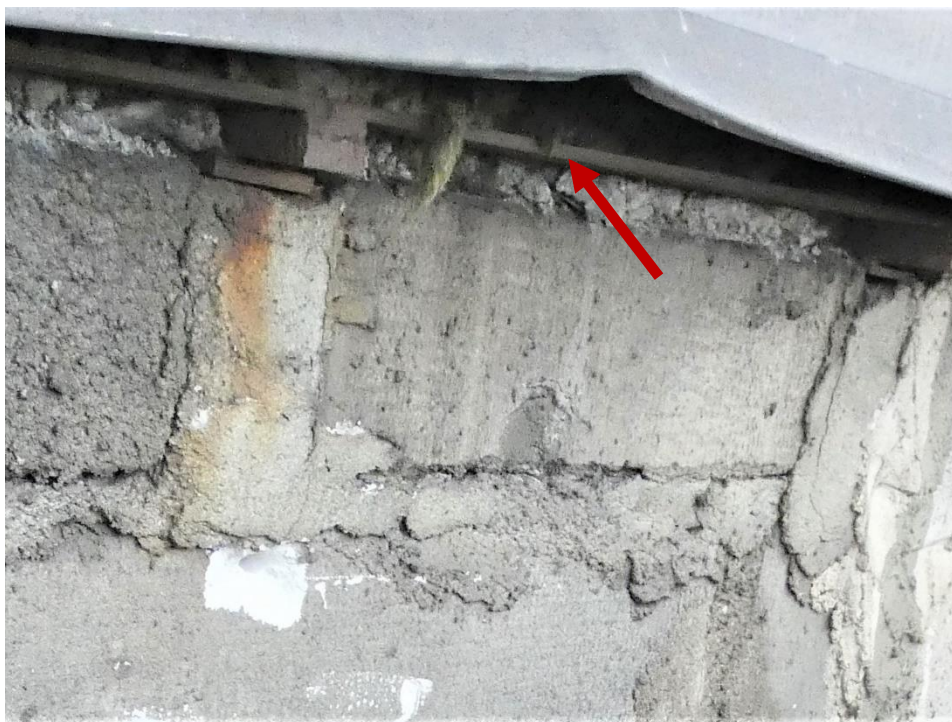
Fot. 6 Widok zwieńczenia ściany elementami murowanymi z betonu komórkowego pod profilem stalowym
