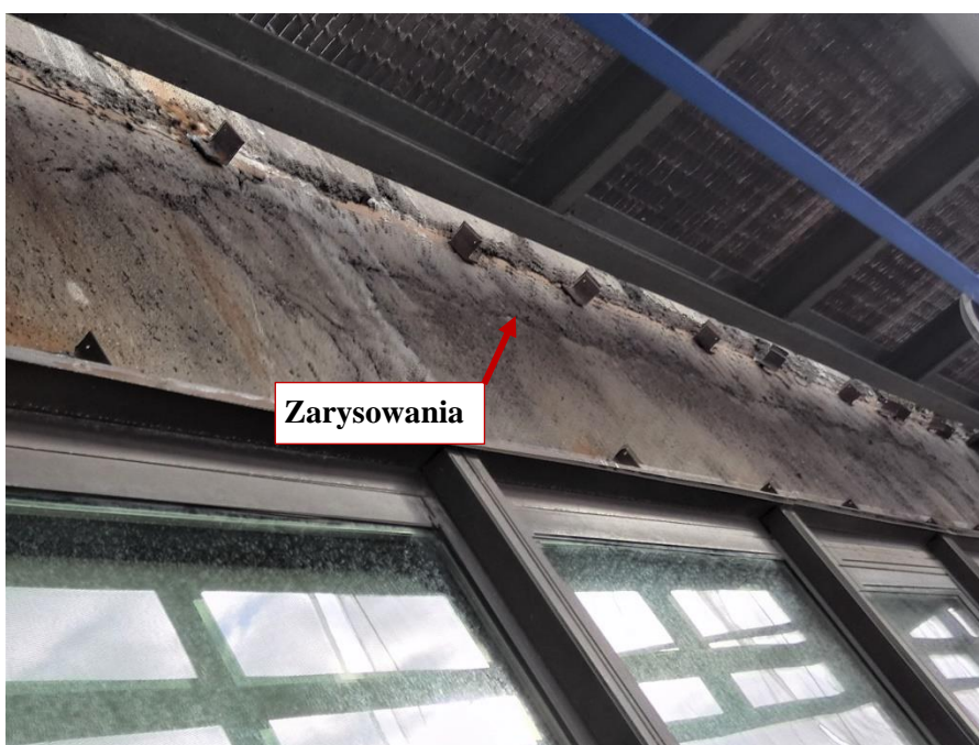
Fot. 107 Kondygnacja 11 (Poziom +41.70) Elewacja Południowa – belka w osiach 12-13/E. Zarysowania belki w przęśle na wysokości miejsca oparcia
