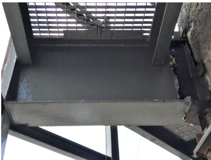
Fot. 152, 153 Kondygnacja 11 (Poziom +41.70) Elewacja Południowa– wspornik w osiach 10/E. Brak widocznych uszkodzeń wspornika.
