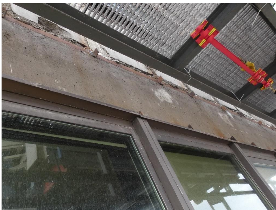
Fot. 68 Kondygnacja 11 (Poziom +41.70) Elewacja Północna – belka w osiach 13-14/I. Brak widocznych uszkodzeń belki w przęśle.
