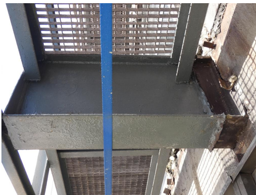
Fot. 160, 161 Kondygnacja 11 (Poziom +41.70) Elewacja Południowa– wspornik w osiach 13/E (widok z dołu) Brak widocznych uszkodzeń wspornika.
