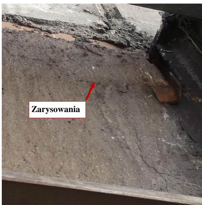
Fot. 105 Kondygnacja 11 (Poziom +41.70) Elewacja Południowa – belka w osiach 11-12/E. Zarysowania belki na wysokości miejsca oparcia. Zarysowania powierzchni zaprawy
