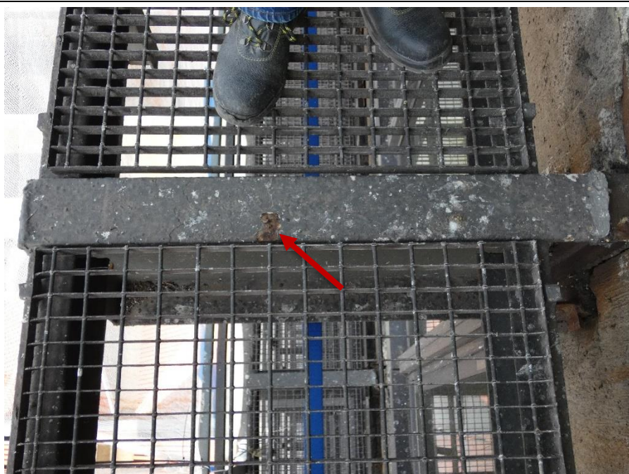
Fot. 147 Kondygnacja 11 (Poziom +41.70) Elewacja Zachodnia– wspornik w osiach 10/G (widok z góry) Ślady korozji pasa górnego. Brak widocznych uszkodzeń wspornika.
