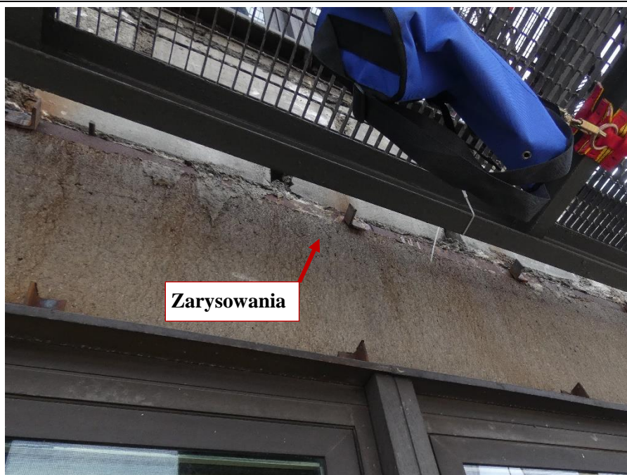
Fot. 96 Kondygnacja 11 (Poziom +41.70) Elewacja Zachodnia – belka w osiach 10/E-F. Zarysowania belki w przęśle na wysokości miejsca oparcia.
