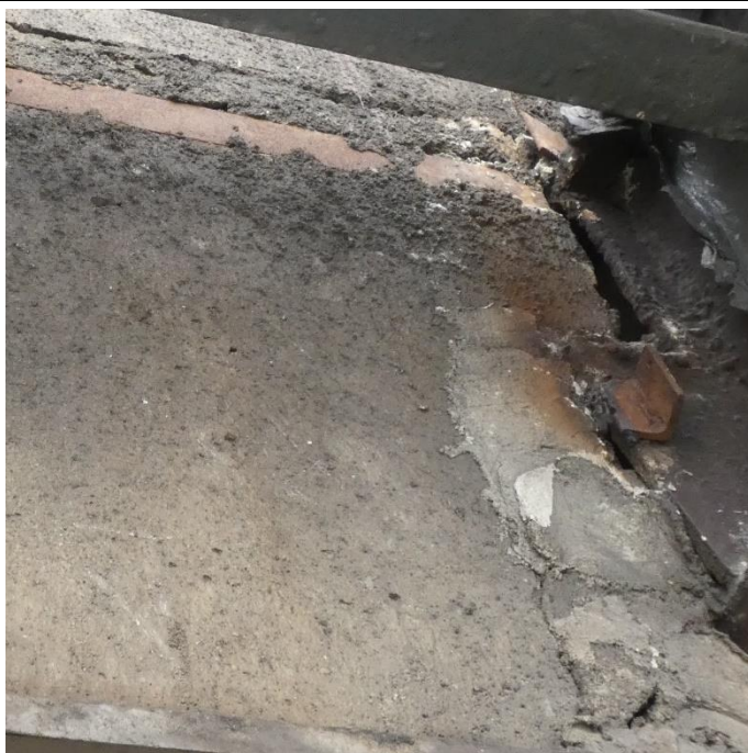
Fot. 65 Kondygnacja 11 (Poziom +41.70) Elewacja Wschodnia – belka w osiach 14/H-I. Brak widocznych uszkodzeń belki przy podporze. Spękania i zarysowania powierzchni zaprawy
