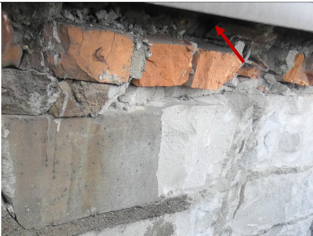
Fot. 7 Widok zwieńczenia ściany ceramicznymi elementami murowymi pod profilem stalowym
