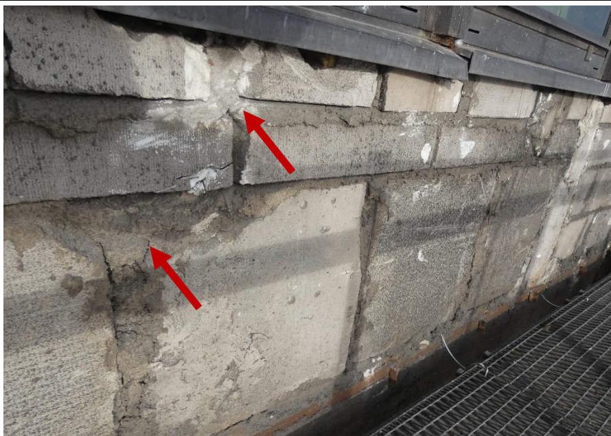
Fot. 17 Kondygnacja 11 (Poziom +41.70) Elewacja Wschodnia – widok ściany murowanej w osiach 14/H-I. Zbyt duże wymiary spoin. Niewłaściwe przewiązanie elementów. Ściana z uszkodzonymi elementami murowymi o zróżnicowanych kształtach. Wypełnienie ubytków między elementami i uszkodzonych miejsc zaprawą. Zwieńczenie ściany uszkodzonymi elementami murowymi.
