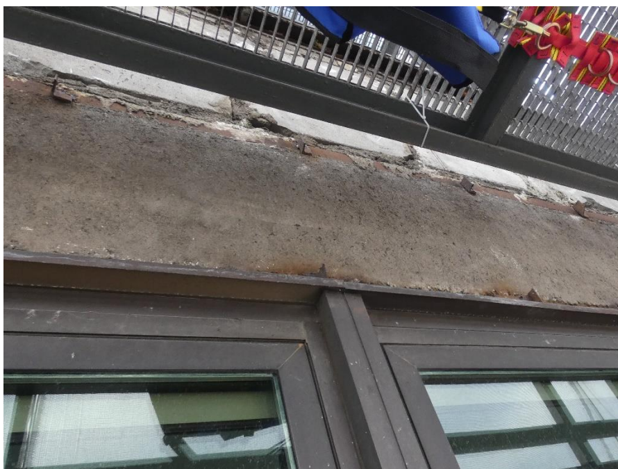
Fot. 79 Kondygnacja 11 (Poziom +41.70) Elewacja Północna – belka w osiach 10-11/I. Brak widocznych uszkodzeń belki w przęśle
