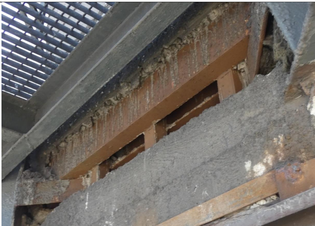
Fot. 165 Konstrukcja naroża nad kondygnacją 7
