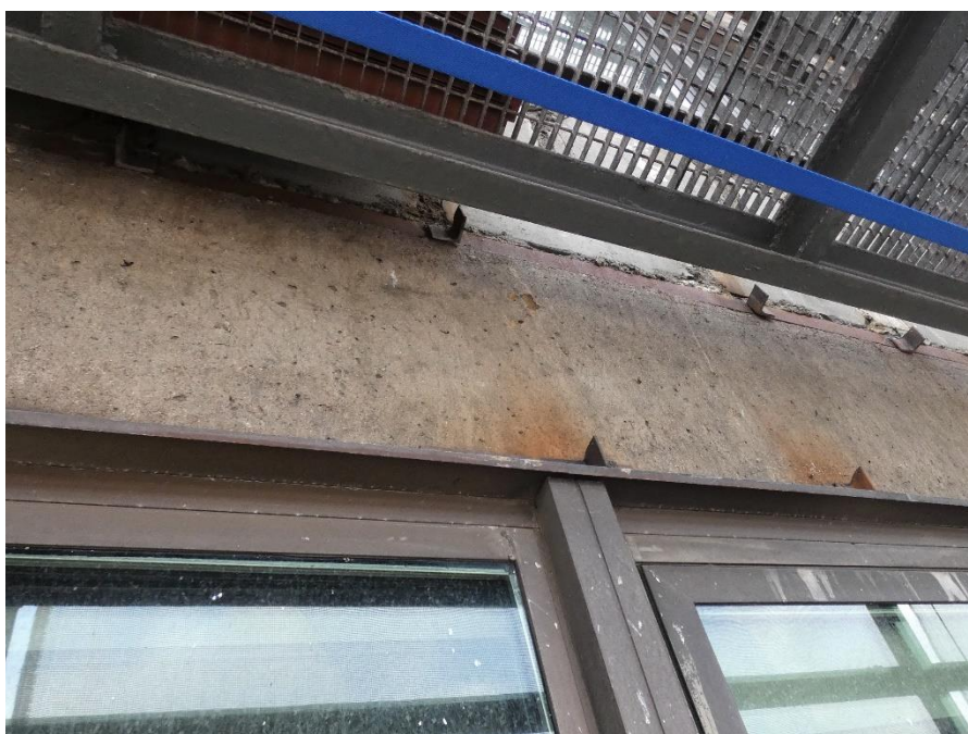
Fot. 92 Kondygnacja 11 (Poziom +41.70) Elewacja Zachodnia – belka w osiach 10/F-G. Brak widocznych uszkodzeń belki w przęśle.
