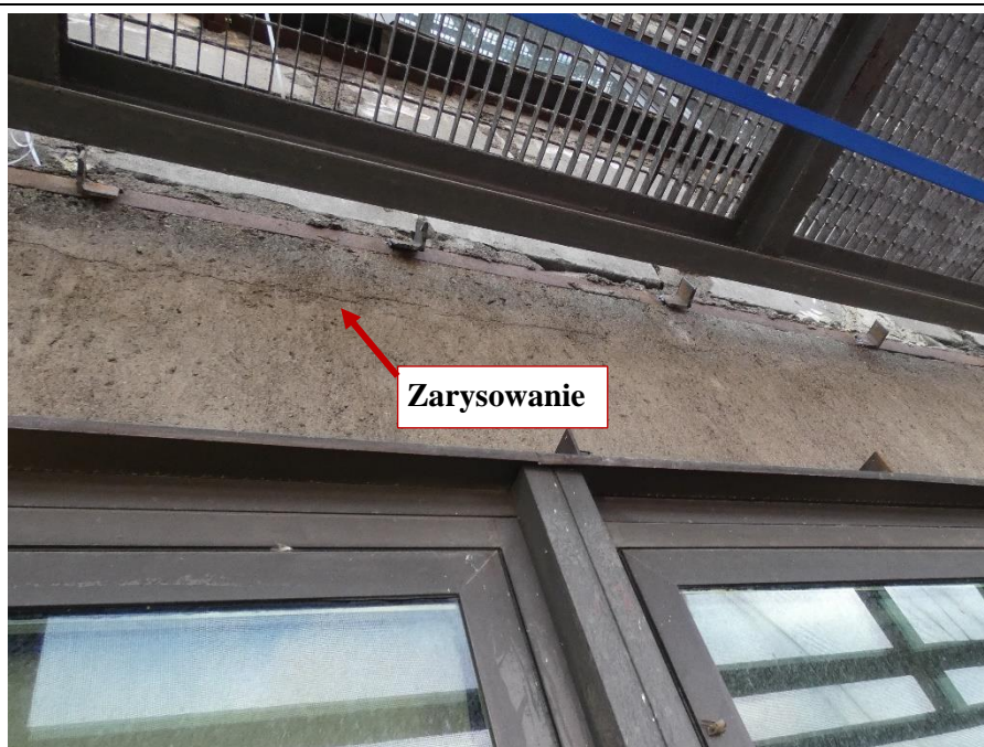
Fot. 85 Kondygnacja 11 (Poziom +41.70) Elewacja Zachodnia – belka w osiach 10/H-I. Zarysowania belki w przęśle na wysokości miejsca oparcia.
