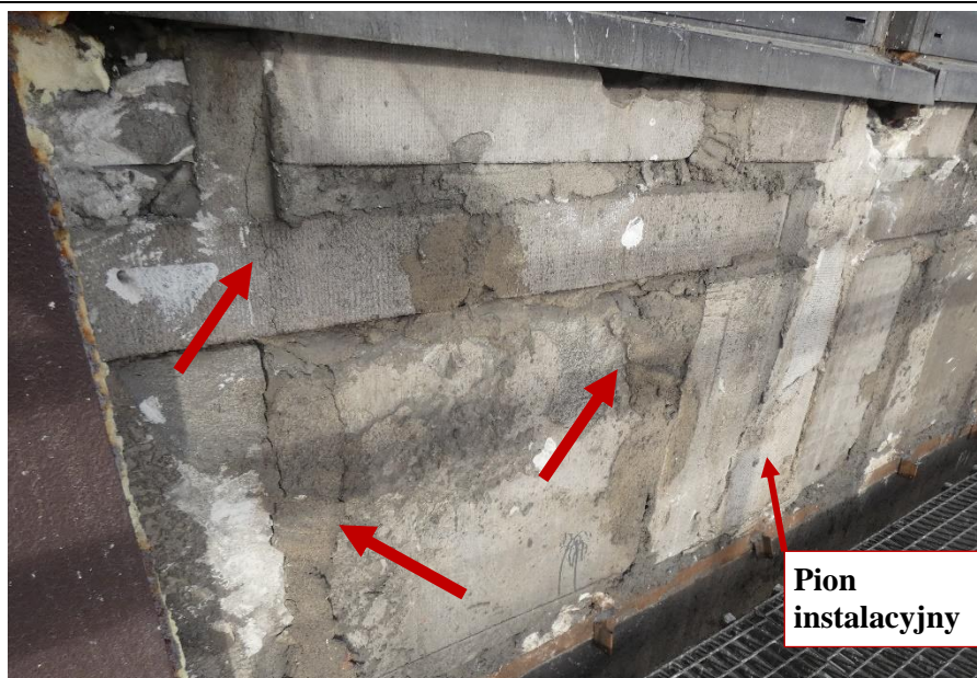
Fot. 15 Kondygnacja 11 (Poziom +41.70) Elewacja Wschodnia – widok ściany murowanej w osiach 14/H-I. Zbyt duże wymiary spoin. Zarysowania elementów murowych. Ściana z uszkodzonymi elementami murowymi o zróżnicowanych kształtach (12x60, 60x60 cm). Wypełnienie ubytków między elementami i uszkodzonych miejsc zaprawą. Zwieńczenie ściany elementami murowymi 12x60 cm. Zamknięcie pionu instalacyjnego
