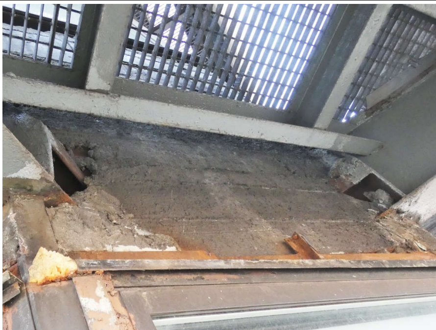
Fot. 90 Nad kondygnacją 5 (Poziom +21.90) Elewacja Północna – belka w osiach 10/I. Brak możliwości pomiaru głębokości oparcia i określenia zastosowanych rozwiązań konstrukcyjnych. Brak widocznych uszkodzeń.
