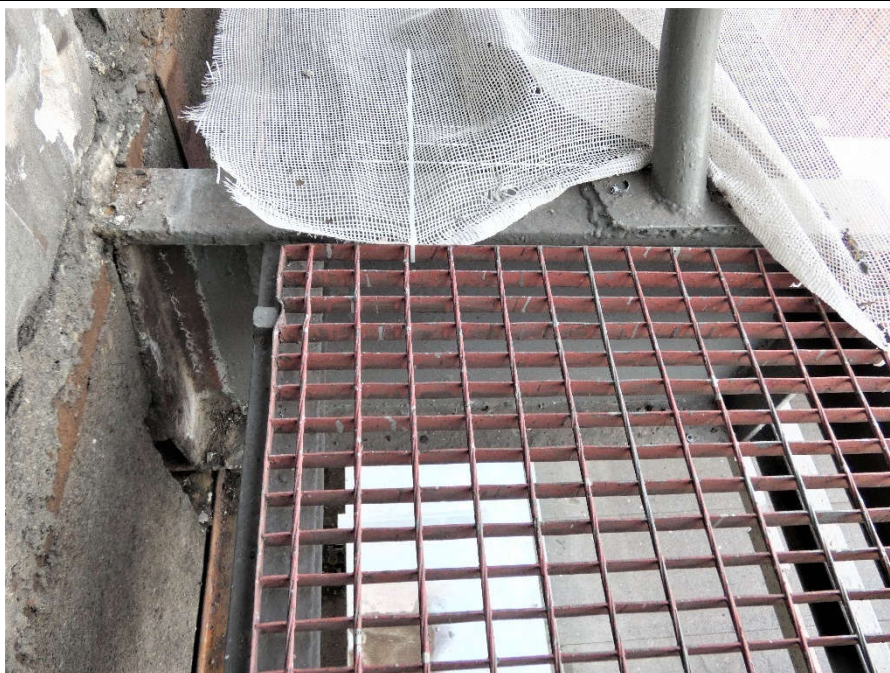
Fot. 225 Pod kondygnacją 5 (Poziom +21.90) Elewacja Zachodnia– wspornik w osiach 10/F. Przemieszczenie wspornika w kierunku osi E. Brak widocznych uszkodzeń wspornika.
