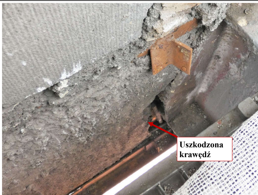
Fot. 150 Pod kondygnacją 5 (Poziom +21.90) Elewacja Południowa – belka w osiach 10-11/E.
