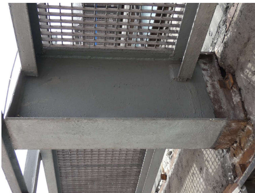
Fot. 201, 202 Nad kondygnacją 5 (Poziom +21.90) Elewacja Południowa– wspornik w osiach 12/E. Brak widocznych uszkodzeń wspornika.
