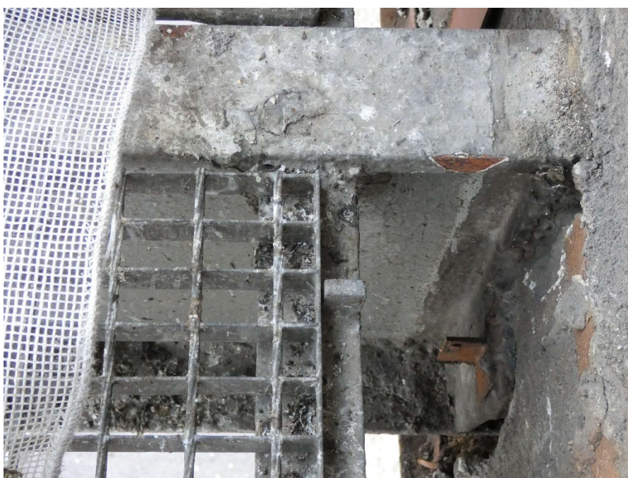
Fot. 208, 209 Pod kondygnacją 5 (Poziom +21.90) Elewacja Wschodnia – wspornik w osiach 14/F Brak widocznych uszkodzeń wspornika.
