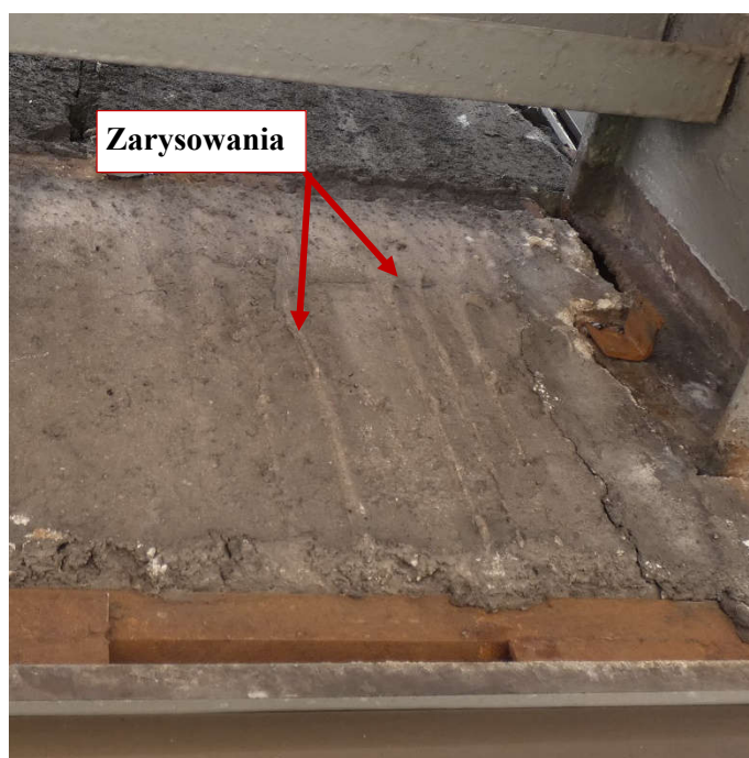
Fot. 124 Nad kondygnacją 5 (Poziom +21.90) Elewacja Południowa – belka w osiach 13-14/E. Zarysowania poziome i pionowe belki przy podporze. Zarysowania powierzchni zaprawy.
