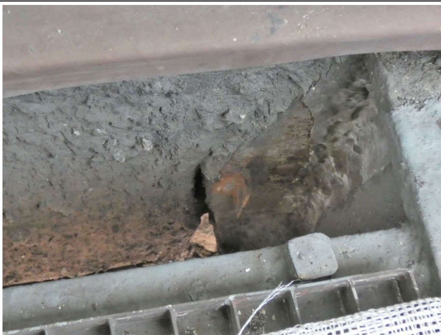
Fot. 154 Pod kondygnacją 5 (Poziom +21.90) Elewacja Południowa – belka w osiach 12-13/E. Brak widocznych uszkodzeń belki przy podporze. Przerzeń między elementami wypełniona zaprawą.
