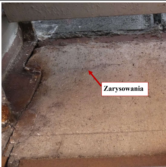
Fot. 100 Nad kondygnacją 5 (Poziom +21.90) Elewacja Zachodnia – belka w osiach 10/F-G. Zarysowania belki na wysokości miejsca oparcia. Spękania i zarysowania powierzchni zaprawy.
