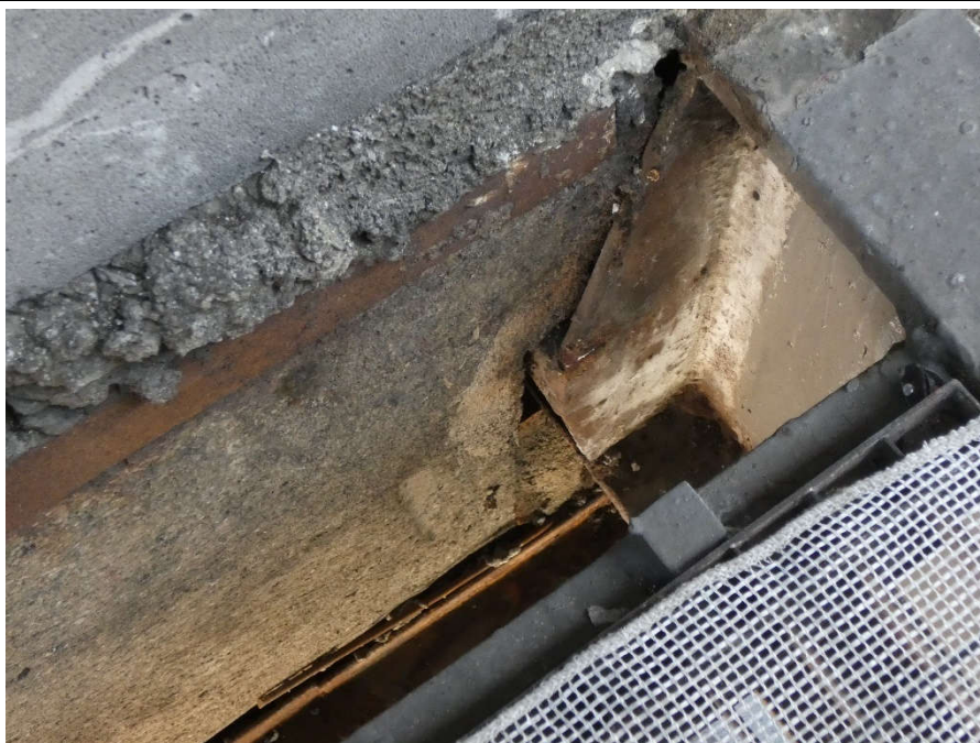
Fot. 142 Pod kondygnacją 5 (Poziom +21.90) Elewacja Zachodnia – belka w osiach 10/H-I. Brak widocznych uszkodzeń belki przy podporze.
