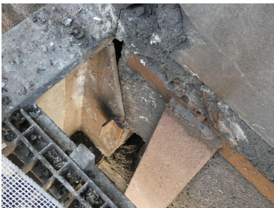
Fot. 131 Pod kondygnacją 5 (Poziom +21.90) Elewacja Wschodnia – belka w osiach 14/H-I. Brak widocznych uszkodzeń belki przy podporze. Przestrzeń między elementami częściowo wypełniona zaprawą.
