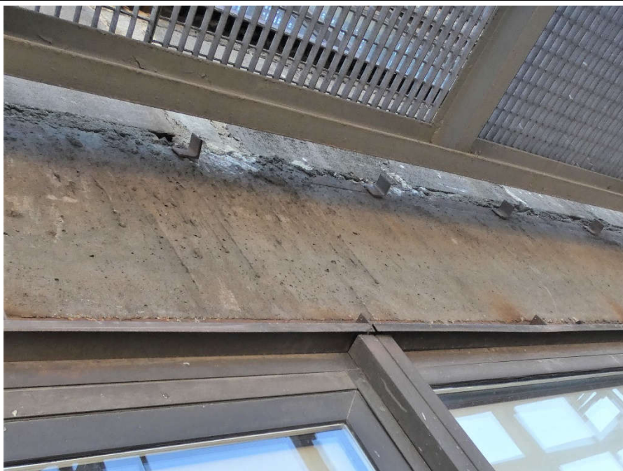
Fot. 75 Nad kondygnacją 5 (Poziom +21.90) Elewacja Północna – belka w osiach 13-14/I.
