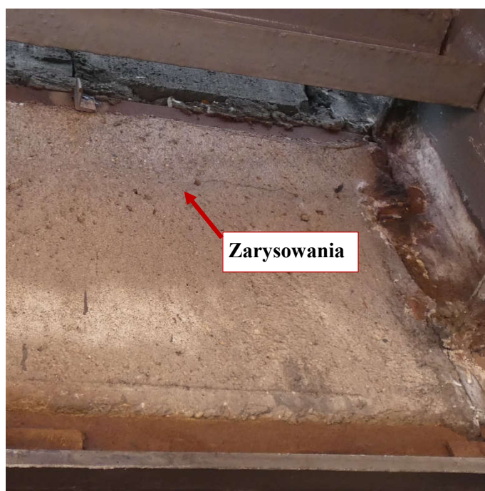
Fot. 99 Nad kondygnacją 5 (Poziom +21.90) Elewacja Zachodnia – belka w osiach 10/G-H. Zarysowania belki na wysokości miejsca oparcia. Spękania i zarysowania powierzchni zaprawy
