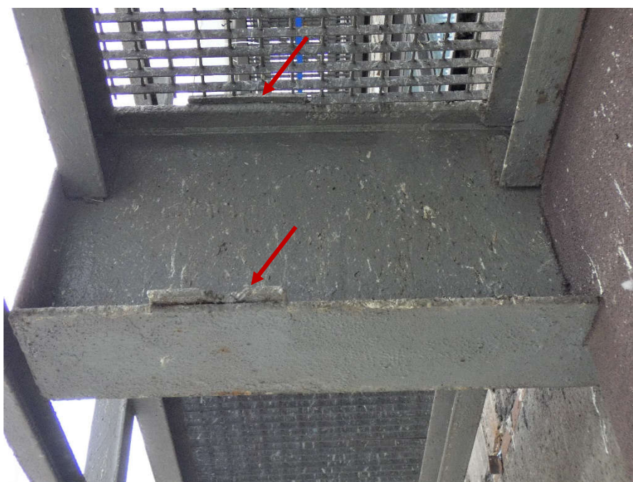
Fot. 166, 167 Nad kondygnacją 5 (Poziom +21.90) Elewacja Wschodnia – wspornik w osiach 14/F Pozostałości po drabinie ewakuacyjnej. Brak widocznych uszkodzeń wspornika.
