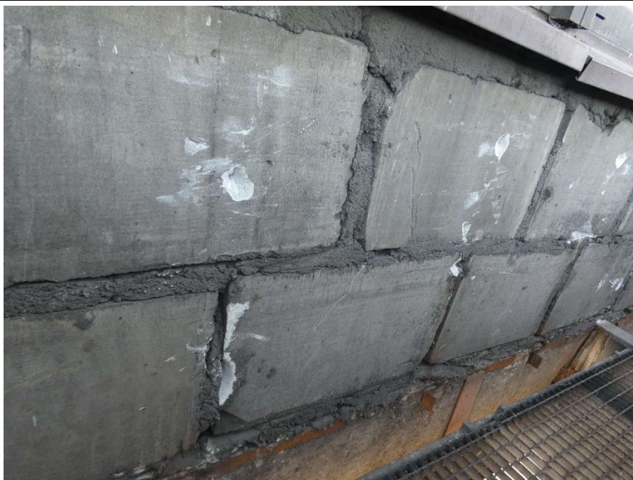
Fot. 30 Kondygnacja 5 (Poziom +21.90) Elewacja Północna – widok ściany murowanej w osiach 12-13/I. Zbyt duże wymiary spoin. Ściana z elementów murowanych 36x60 cm. Wypełnienie ubytków między elementami zaprawą. Zwieńczenie ściany podlewką.
