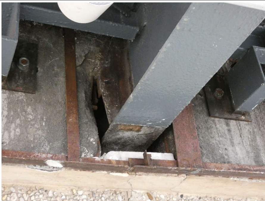
Fot. 210 Pod kondygnacją 5 (Poziom +21.90) Elewacja Wschodnia – wspornik w osi 14/G (widok od dołu) Brak widocznych uszkodzeń wspornika.
