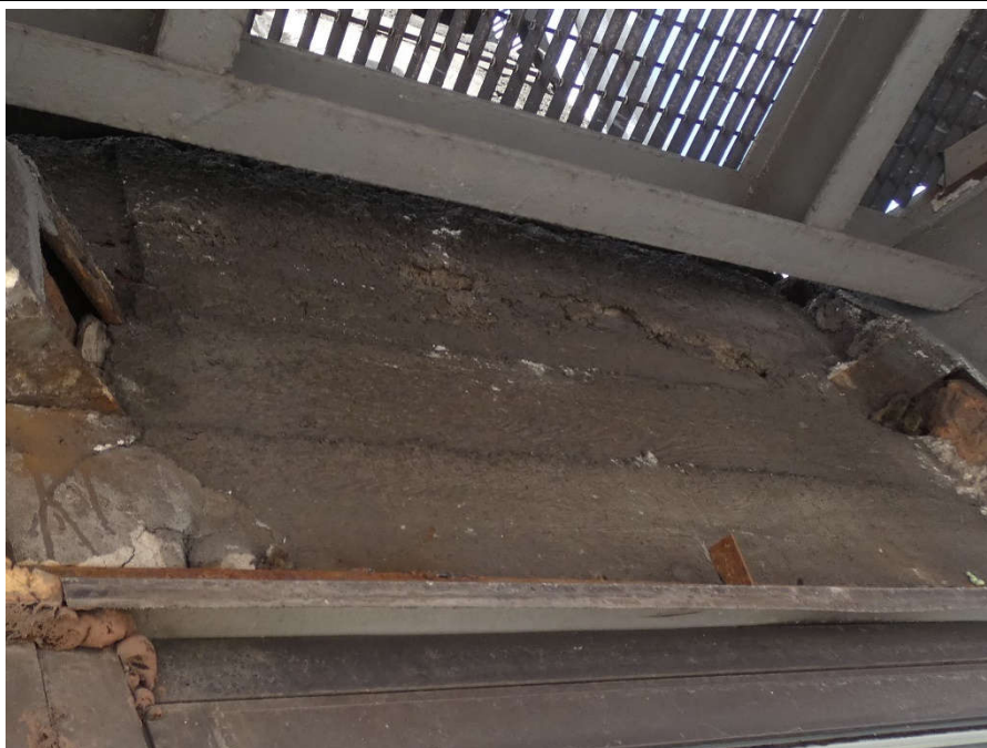
Fot. 125 Nad kondygnacją 5 (Poziom +21.90) Elewacja Południowa – belka w osiach 14/E. Brak możliwości pomiaru głębokości oparcia i określenia zastosowanych rozwiązań konstrukcyjnych. Brak widocznych uszkodzeń.
