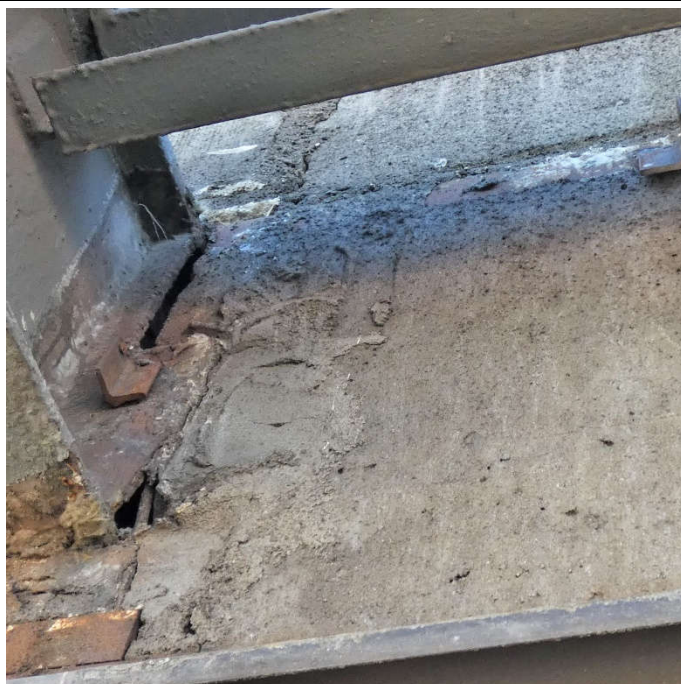
Fot. 77 Nad kondygnacją 5 (Poziom +21.90) Elewacja Północna – belka w osiach 12-13/I. Spękania i zarysowania powierzchni zaprawy. Brak widocznych uszkodzeń belki przy podporze.
