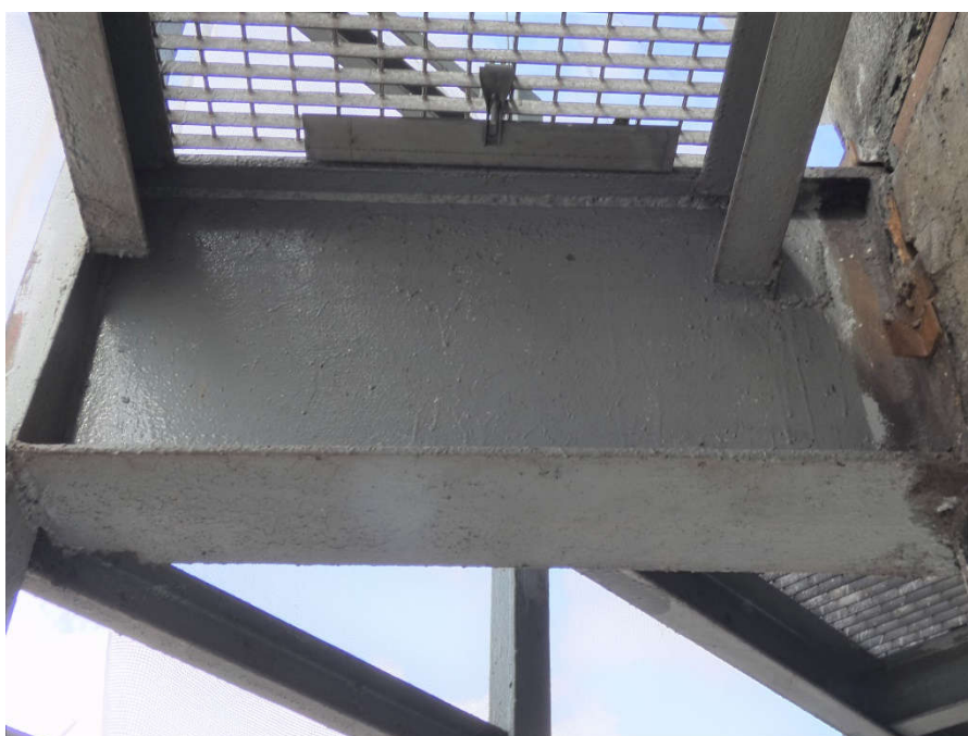
Fot. 186, 187 Nad kondygnacją 5 (Poziom +21.90) Elewacja Zachodnia – wspornik w osiach 10/I. Brak widocznych uszkodzeń wspornika.
