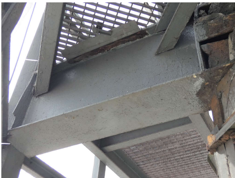
Fot. 205, 206 Nad kondygnacją 5 (Poziom +21.90) Elewacja Południowa– wspornik w osiach 14/E. Brak widocznych uszkodzeń wspornika.
