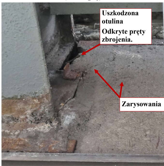
Fot. 110, 111 Nad kondygnacją 5 (Poziom +21.90) Elewacja Południowa – belka w osiach 11-12/E. Uszkodzona otulina. Odkryte pręty zbrojeniowe. Zarysowanie belki nad podporą oraz na wysokości miejsca oparcia. Zarysowania powierzchni zaprawy.
