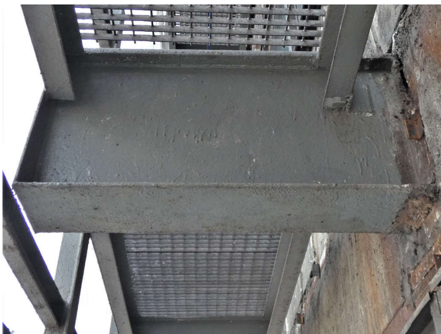
Fot. 181, 182 Nad kondygnacją 5 (Poziom +21.90) Elewacja Północna – wspornik w osiach I/I/I Brak widocznych uszkodzeń wspornika.
