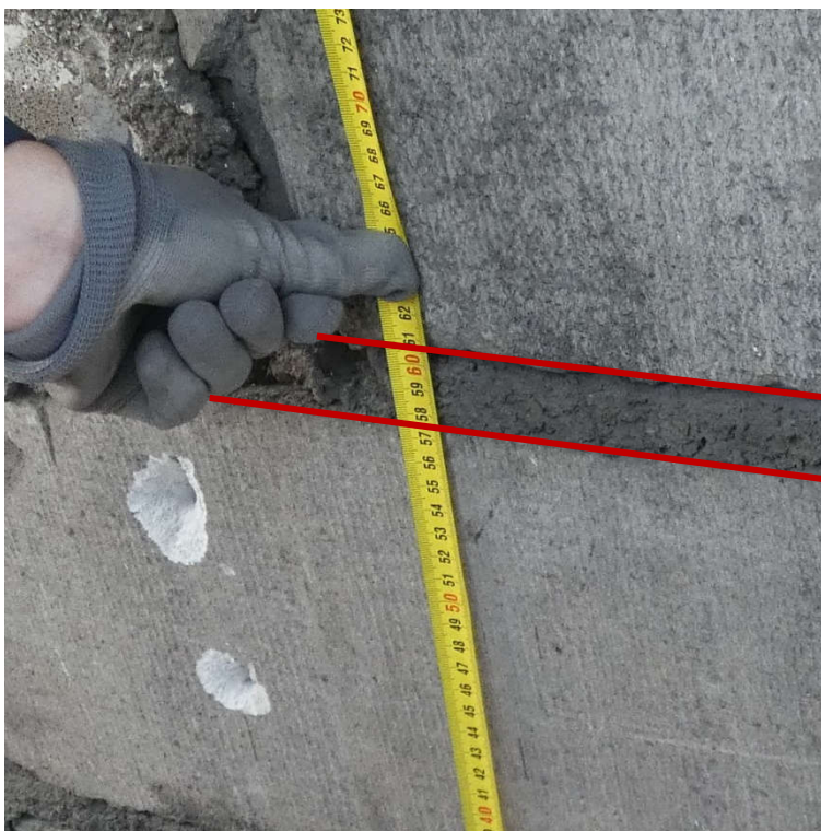
Fot. 1 Przykładowa spoina pozioma – grubość 3 cm
