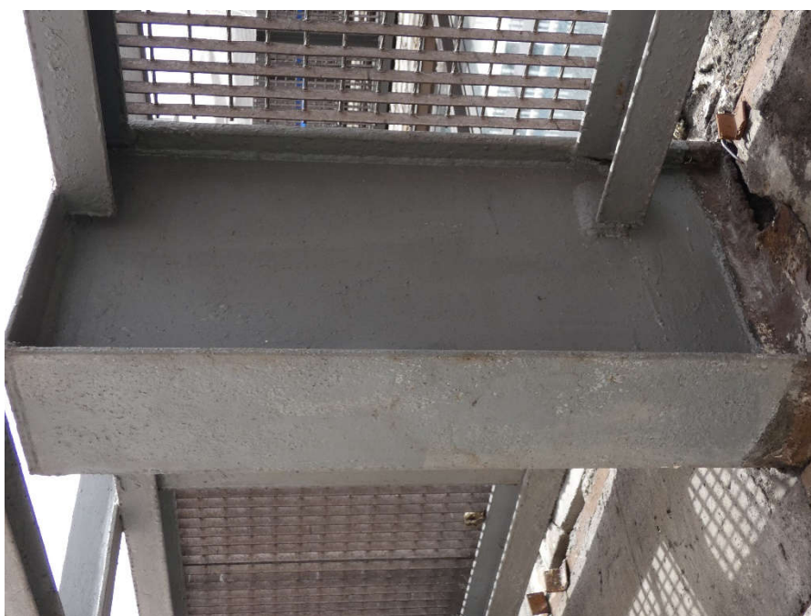
Fot. 203, 204 Nad kondygnacją 5 (Poziom +21.90) Elewacja Południowa– wspornik w osiach 13/E. Brak widocznych uszkodzeń wspornika.
