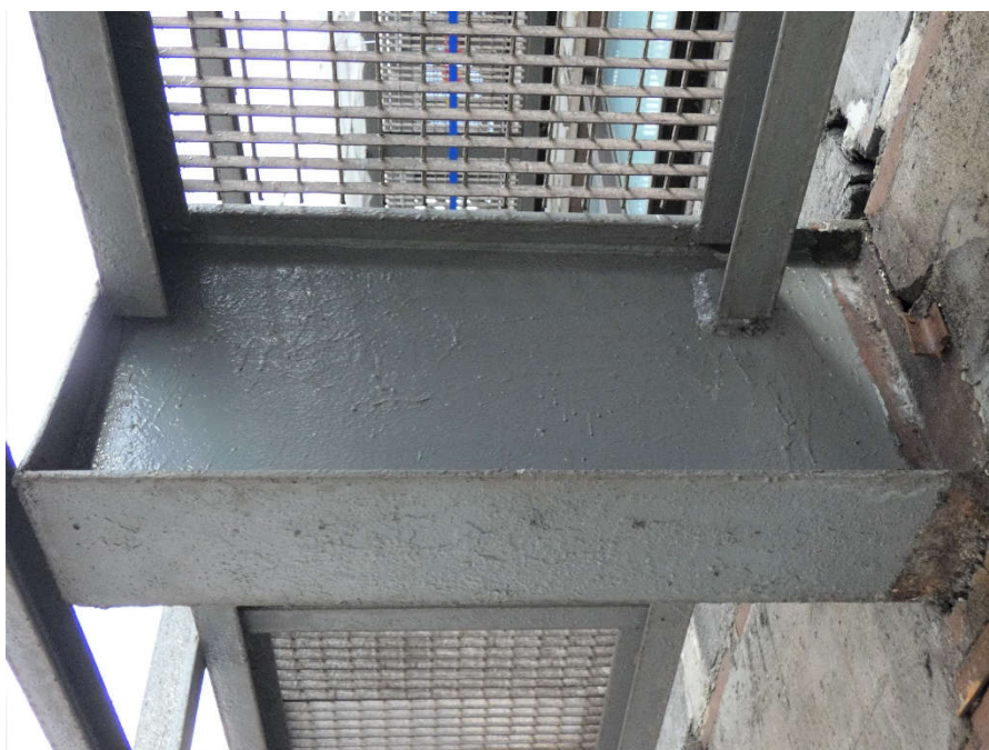
Fot. 188, 189 Nad kondygnacją 5 (Poziom +21.90) Elewacja Zachodnia – wspornik w osiach 10/H Brak widocznych uszkodzeń wspornika.
