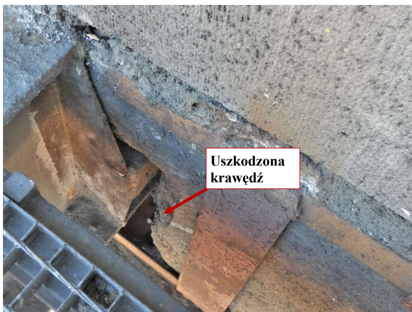
Fot. 135 Pod kondygnacją 5 (Poziom +21.90) Elewacja Północna – belka w osiach 12-13/I. Uszkodzona krawędź elementu.
