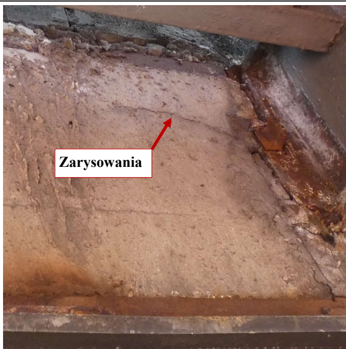
Fot. 102 Nad kondygnacją 5 (Poziom +21.90) Elewacja Zachodnia – belka w osiach 10/F-G. Zarysowania belki na wysokości miejsca oparcia. Spękania i zarysowania powierzchni zaprawy.
