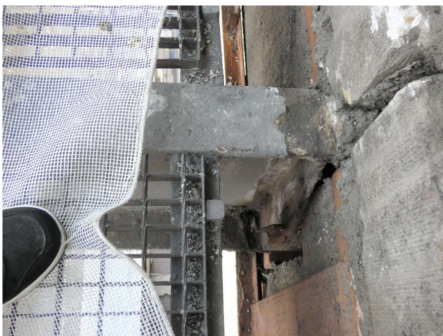
Fot. 218, 219 Pod kondygnacją 5 (Poziom +21.90) Elewacja Północna – wspornik w osiach 11/I. Przemieszczenia wspornika w kierunku osi 12. Brak widocznych uszkodzeń wspornika.
