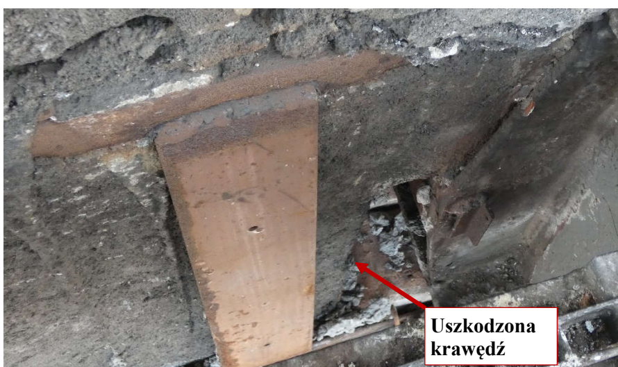
Fot. 127 Pod kondygnacją 5 (Poziom +21.90) Elewacja Wschodnia – belka w osiach 14/E-F. Uszkodzona krawędź elementu. Przestrzeń między elementami wypełniona gruzem
