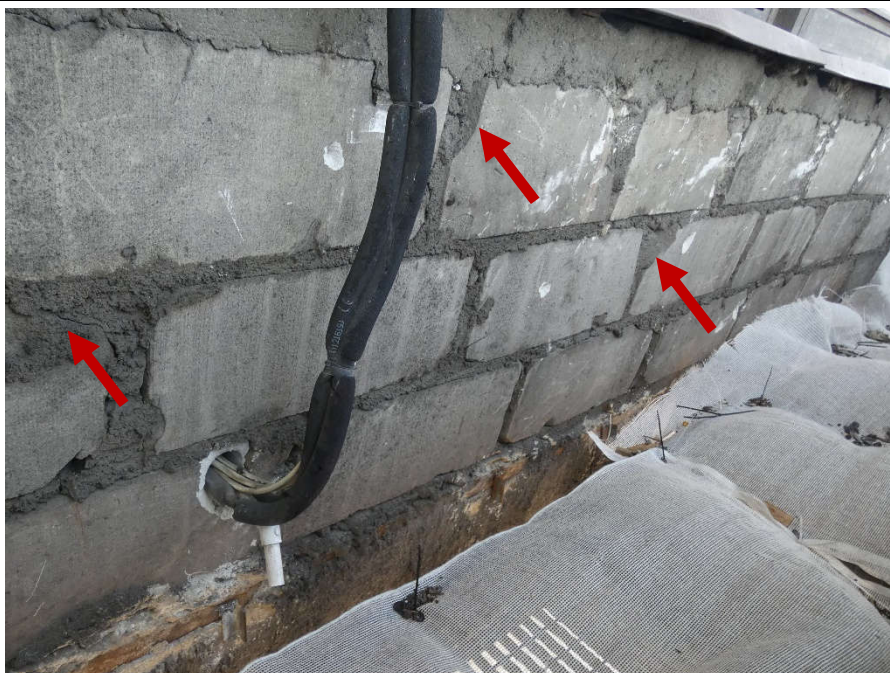
Fot. 24 Kondygnacja 5 (Poziom +21.90) Elewacja Wschodnia – widok ściany murowanej w osiach 14/H-I. Zbyt duże wymiary spoin. Ściana z uszkodzonych elementów murowych. Wypełnienie ubytków między elementami i uszkodzonych miejsc zaprawą. Zwieńczenie ściany podlewką.
