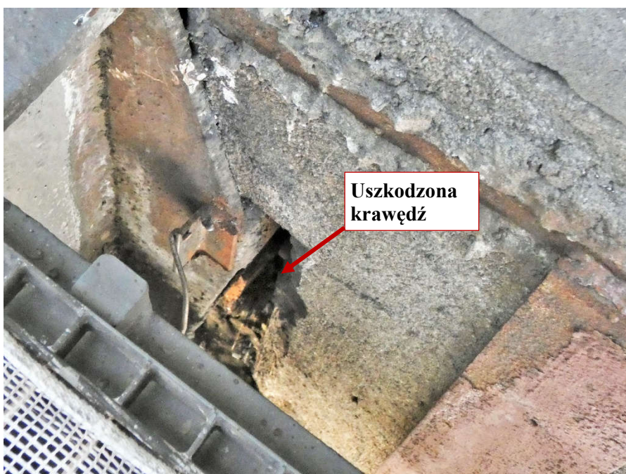
Fot. 143 Pod kondygnacją 5 (Poziom +21.90) Elewacja Zachodnia – belka w osiach 10/G-H. Uszkodzona krawędź elementu. Zalegający gruz w przestrzeni między elementami.
