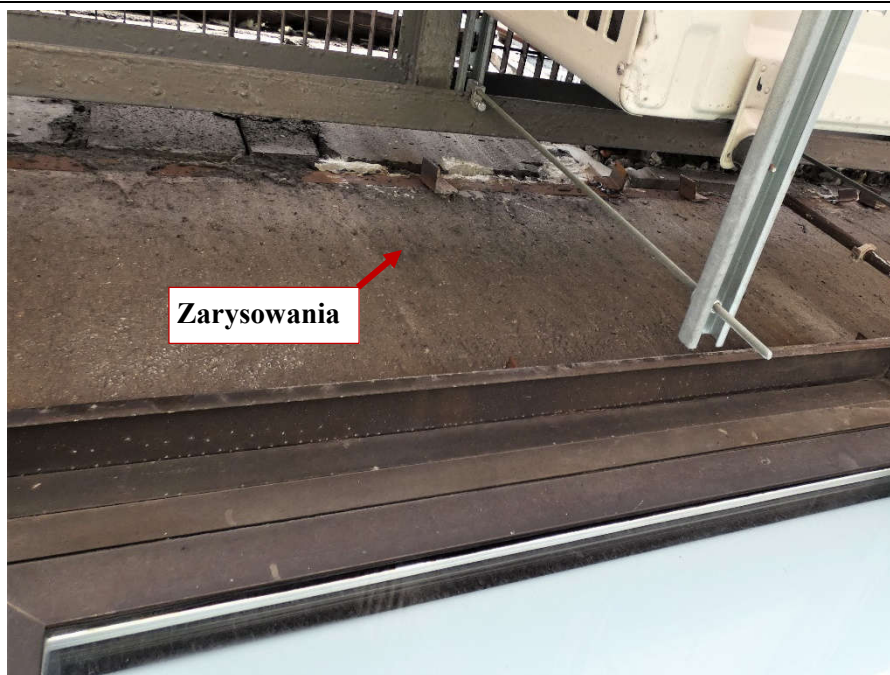
Fot. 118 Nad kondygnacją 5 (Poziom +21.90) Elewacja Południowa – belka w osiach 12-13/E. Zarysowanie belki w przęśle na wysokości miejsca oparcia.
