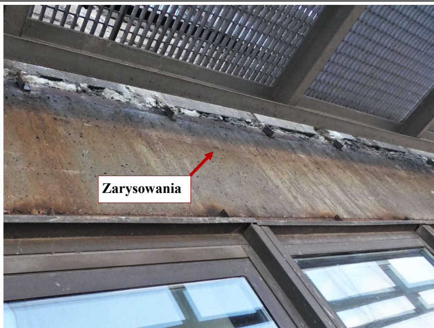
Fot. 87 Nad kondygnacją 5 (Poziom +21.90) Elewacja Północna – belka w osiach 10-11/I. Zarysowania belki w prześle na wysokości miejsca oparcia.
