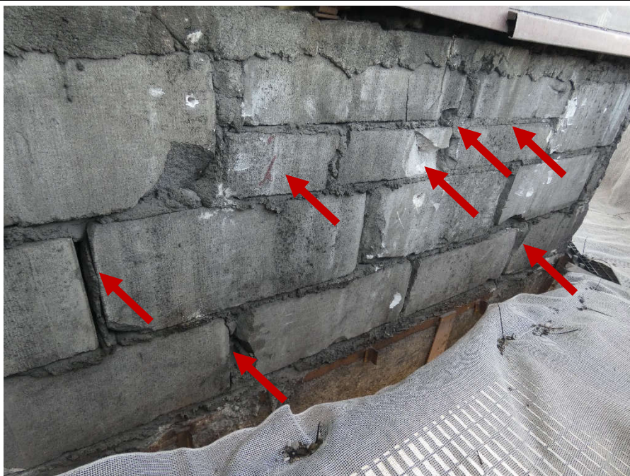
Fot. 36 Kondygnacja 5 (Poziom +21.90) Elewacja Północna – widok ściany murowanej w osiach 10-11/I.
