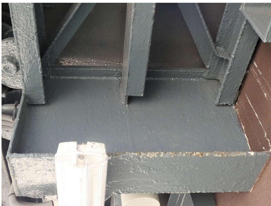
Fot. 169, 170 Nad kondygnacją 5 (Poziom +21.90) Elewacja Wschodnia – wspornik w osiach 14/G. Brak widocznych uszkodzeń wspornika.
