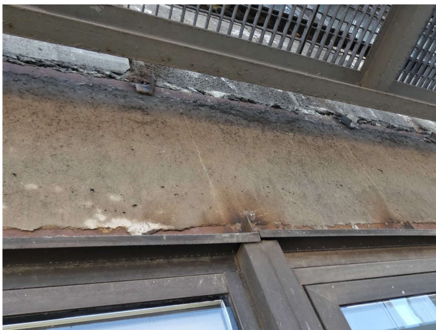
Fot. 78 Nad kondygnacją 5 (Poziom +21.90) Elewacja Północna – belka w osiach 12-13/I. Brak widocznych uszkodzeń belki w przęśle.
