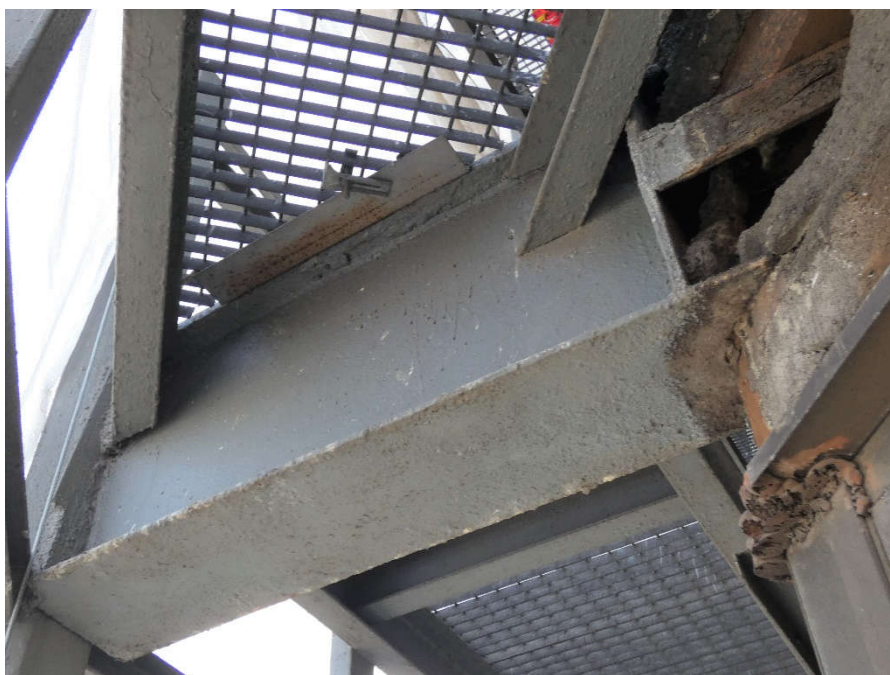
Fot. 173, 174 Nad kondygnacją 5 (Poziom +21.90) Elewacja Wschodnia – wspornik w osiach 14/I. Brak widocznych uszkodzeń wspornika.
