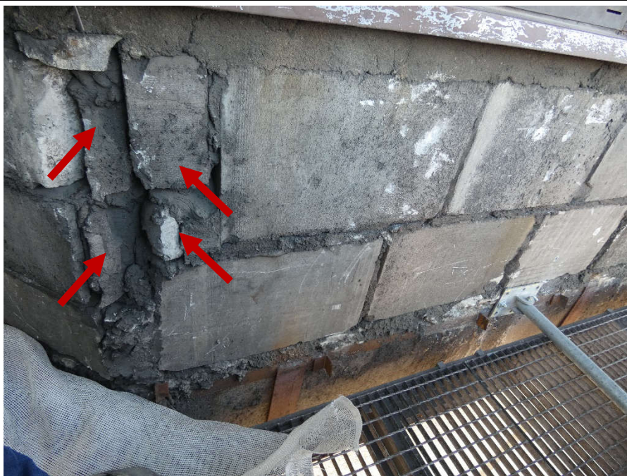
Fot. 26 Kondygnacja 5 (Poziom +21.90) Elewacja Północna – widok ściany murowanej w osiach 13-14/I. Zbyt duże wymiary spoin. Niewłaściwe przewiązanie elementów w narożu. Ściana z elementów murowanych 36x60 cm. Wypełnienie ubytków między elementami zaprawą i gruzem. Zwieńczenie ściany podlewką.
