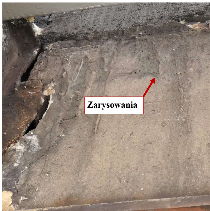
Fot. 107 Nad kondygnacją 5 (Poziom +21.90) Elewacja Południowa – belka w osiach 10-11/E. Zarysowanie belki na wysokości miejsca oparcia. Spękania i zarysowania powierzchni zaprawy.
