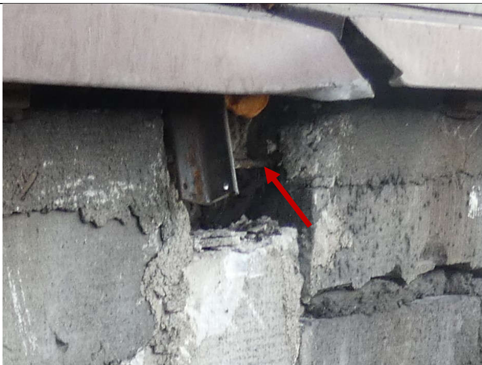
Fot. 9 Widok zbrojenia podlewki zwieńczającej ścianę.
