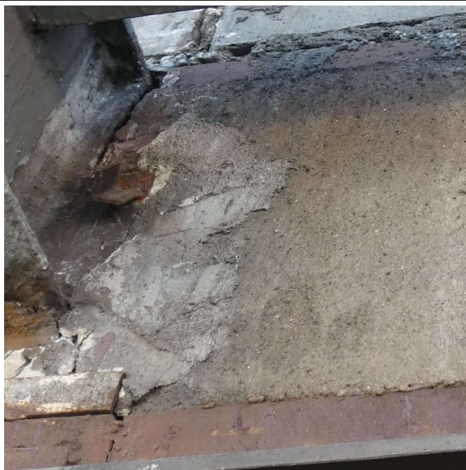
Fot. 81 Nad kondygnacją 5 (Poziom +21.90) Elewacja Północna – belka w osiach 11-12/I. Spękania i zarysowania powierzchni zaprawy. Brak widocznych uszkodzeń belki przy podporze.
