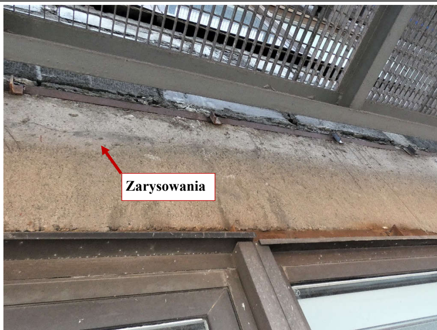
Fot. 93 Nad kondygnacją 5 (Poziom +21.90) Elewacja Zachodnia – belka w osiach 10/H-I. Zarysowanie belki w przęśle na wysokości miejsca oparcia.
