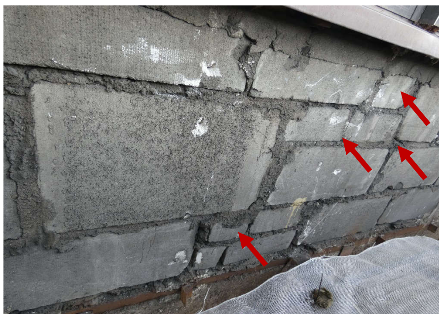
Fot. 43 Kondygnacja 5 (Poziom +21.90) Elewacja Zachodnia – widok ściany murowanej w osiach 10/F-G. Zbyt duże wymiary spoin. Niewłaściwe przewiązanie elementów. Ściana z uszkodzonymi elementami murowymi o zróżnicowanych kształtach. Wypełnienie ubytków między elementami i uszkodzonych miejsc zaprawą i gruzem. Zwieńczenie ściany podlewką.
