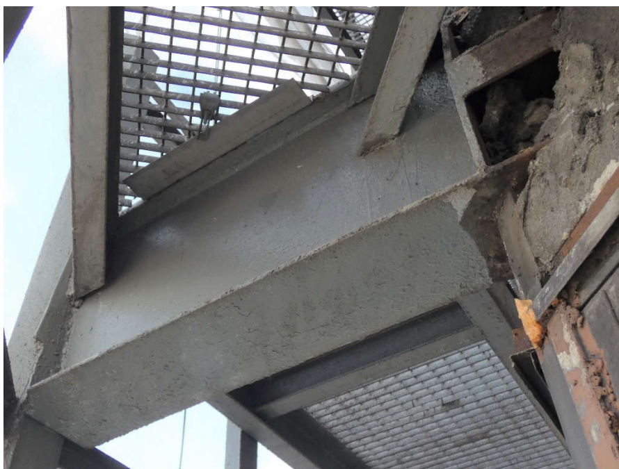
Fot. 184, 185 Nad kondygnacją 5 (Poziom +21.90) Elewacja Północna – wspornik w osiach 10/I. Brak widocznych uszkodzeń wspornika.
