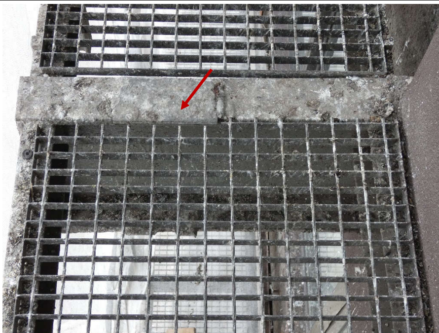
Fot. 168 Nad kondygnacją 5 (Poziom +21.90) Elewacja Wschodnia – wspornik w osiach 14/F (widok z góry) Pozostałości po drabinie ewakuacyjnej. Brak widocznych uszkodzeń wspornika.
