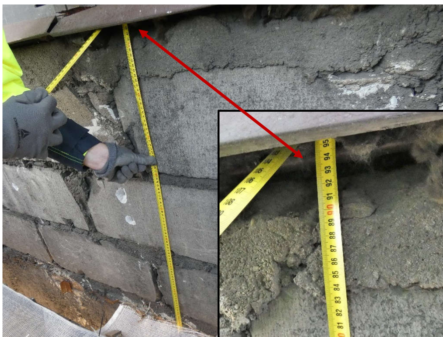
Fot. 23 Kondygnacja 5 (Poziom +21.90) Elewacja Wschodnia – widok ściany murowanej w osiach 14/H-I. Wysokość ściany murowanej ~94 cm. Grubość podlewki między belką żelbetową a ścianą ~9 cm. Grubość podlewki między ścianą a profilem okiennym ~10 cm
