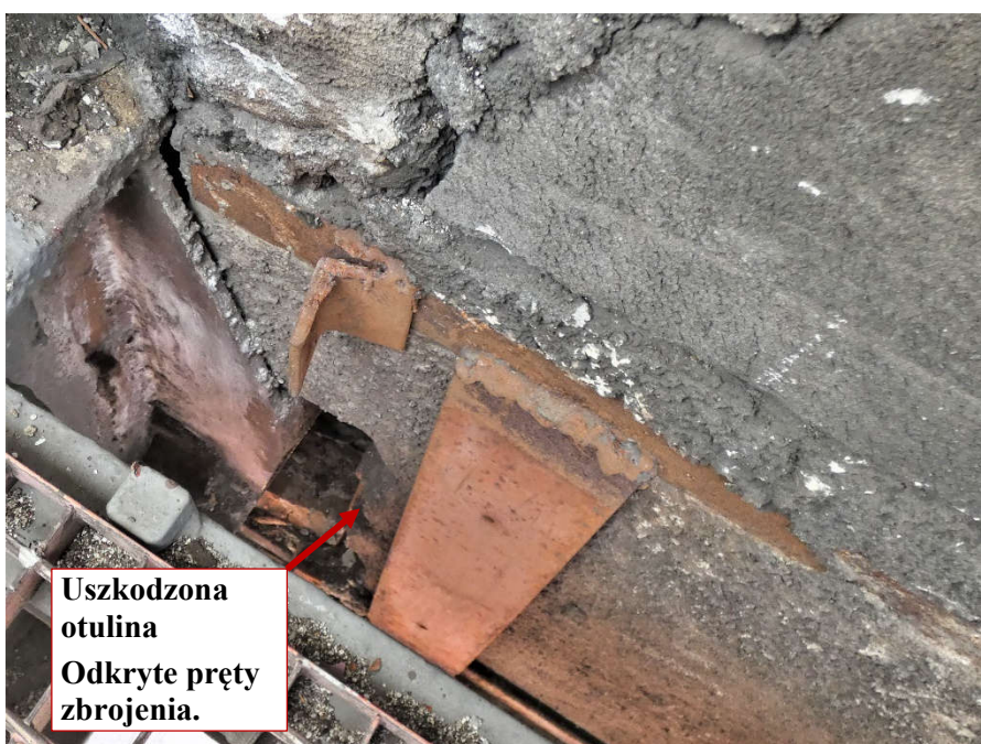
Fot. 155 Pod kondygnacją 5 (Poziom +21.90) Elewacja Południowa – belka w osiach 13-14/E. Uszkodzona otulina. Odkryte pręty zbrojenia. Przerzeń między elementami wypełniona gruzem.
