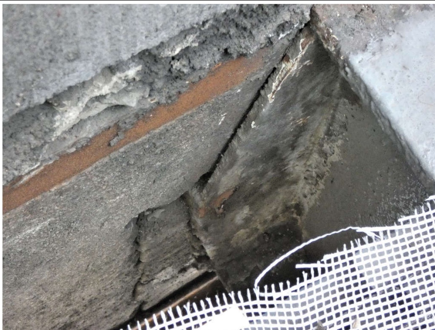
Fot. 156 Pod kondygnacją 5 (Poziom +21.90) Elewacja Południowa – belka w osiach 13-14/E. Brak widocznych uszkodzeń belki przy podporze. Przestrzeń między elementami wypełniona zaprawą.
