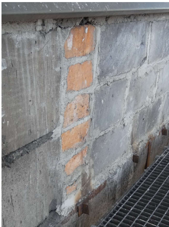
Fot. 12 Widok zamknięcia pionu instalacyjnego elementami ceramicznymi
