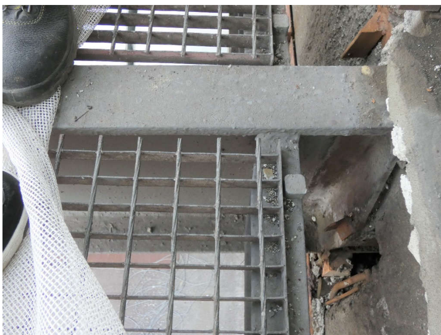
Fot. 227, 228 Pod kondygnacją 5 (Poziom +21.90) Elewacja Południowa– wspornik w osiach 11/E. Brak widocznych uszkodzeń wspornika.
