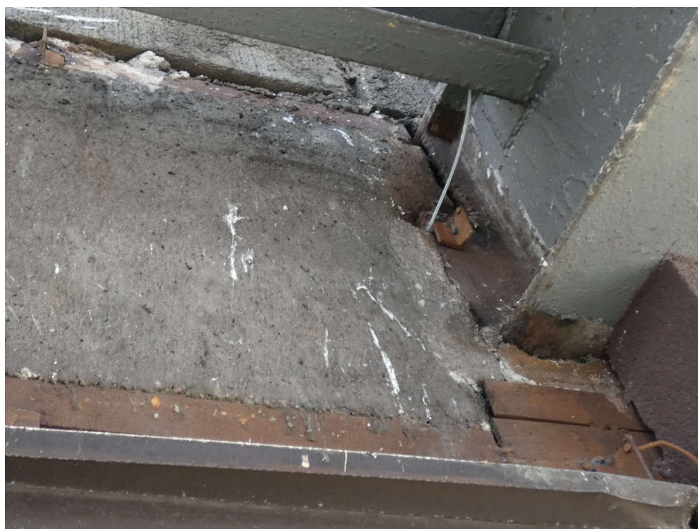
Fot. 158 Wspornik stalowy w miejscu oparcia belek żelbetowych nad kondygnacją 5 (widok z dołu)
