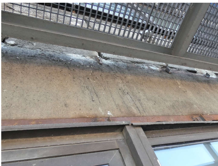
Fot. 82 Nad kondygnacją 5 (Poziom +21.90) Elewacja Północna – belka w osiach 11-12/I. Brak widocznych uszkodzeń belki w przęśle
