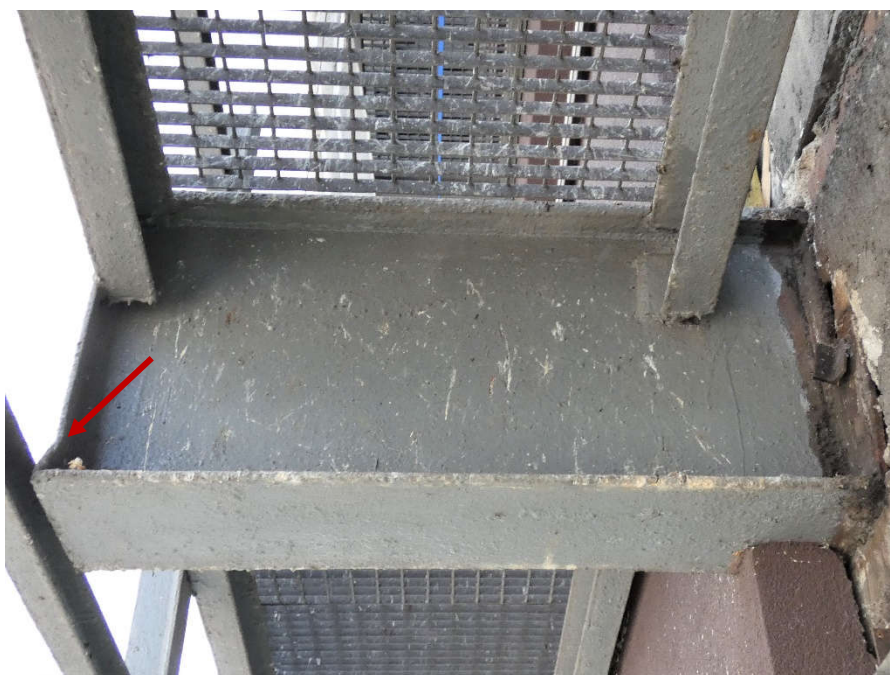
Fot. 171, 172 Nad kondygnacją 5 (Poziom +21.90) Elewacja Wschodnia – wspornik w osiach 14/H. Mechaniczne uszkodzenie żeberka usztywniającego.
