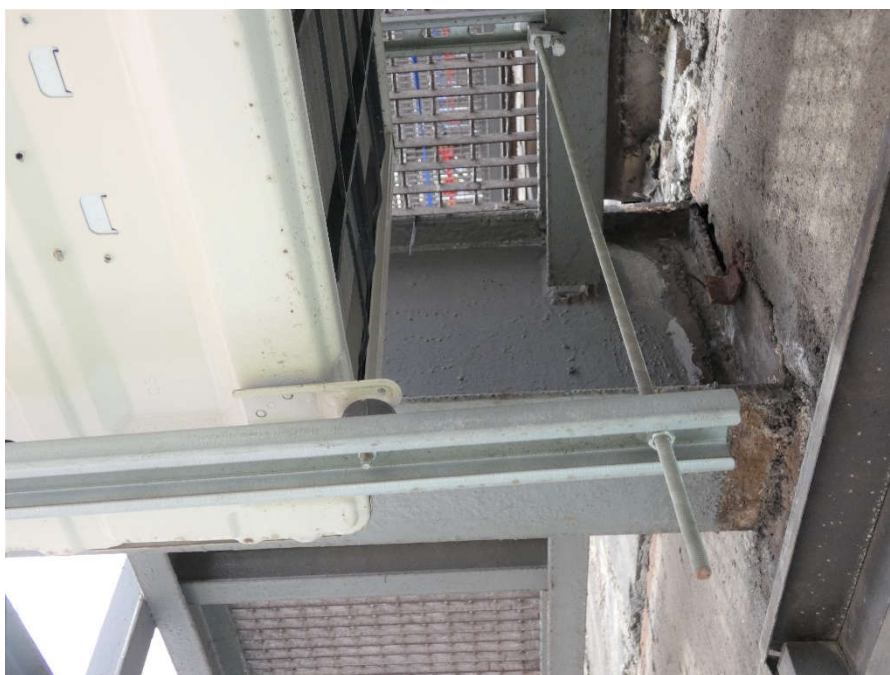
Fot. 199, 200 Nad kondygnacją 5 (Poziom +21.90) Elewacja Południowa– wspornik w osiach 11/E. Brak widocznych uszkodzeń wspornika.
