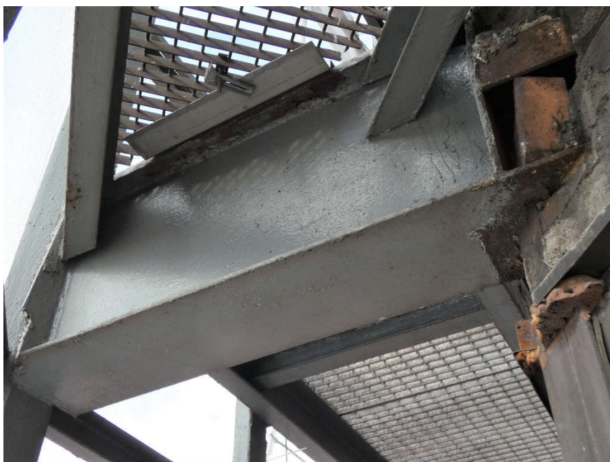
Fot. 195, 196 Nad kondygnacją 5 (Poziom +21.90) Elewacja Zachodnia– wspornik w osiach 10/E. Mechaniczne uszkodzenie żeberka usztywniającego.
