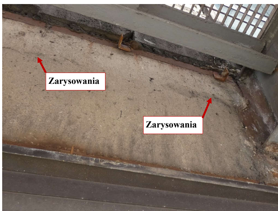
Fot. 109 Nad kondygnacją 5 (Poziom +21.90) Elewacja Południowa – belka w osiach 10-11/E. Zarysowania belki na wysokości miejsca oparcia. Zarysowania powierzchni zaprawy.
