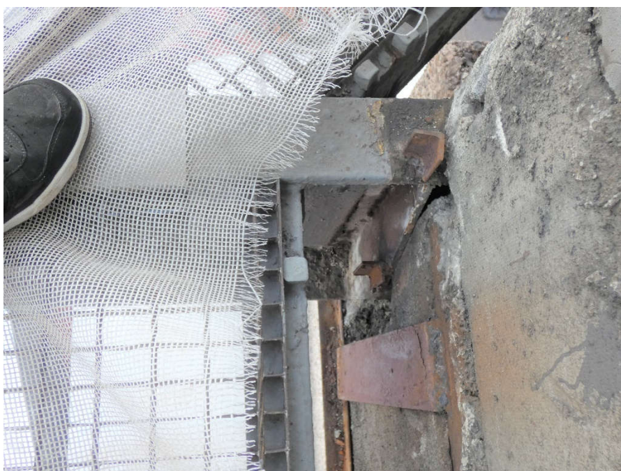
Fot. 226 Pod kondygnacją 5 (Poziom +21.90) Elewacja Południowa– wspornik w osiach 10/E. Brak widocznych uszkodzeń wspornika.
