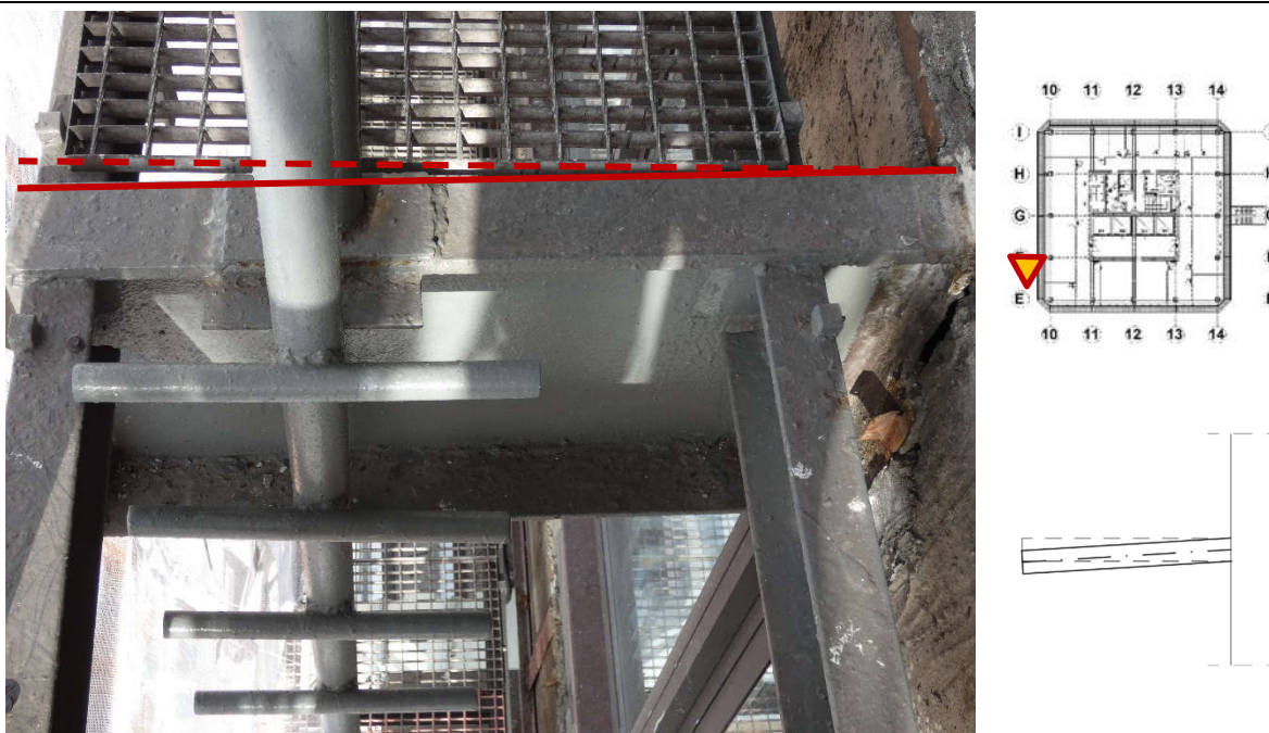
Fot. 194 Nad kondygnacją 5 (Poziom +21.90) Elewacja Zachodnia– wspornik w osiach 10/F (widok z góry) Przemieszczenia wspornika w kierunku osi E. Brak widocznych uszkodzeń wspornika.
