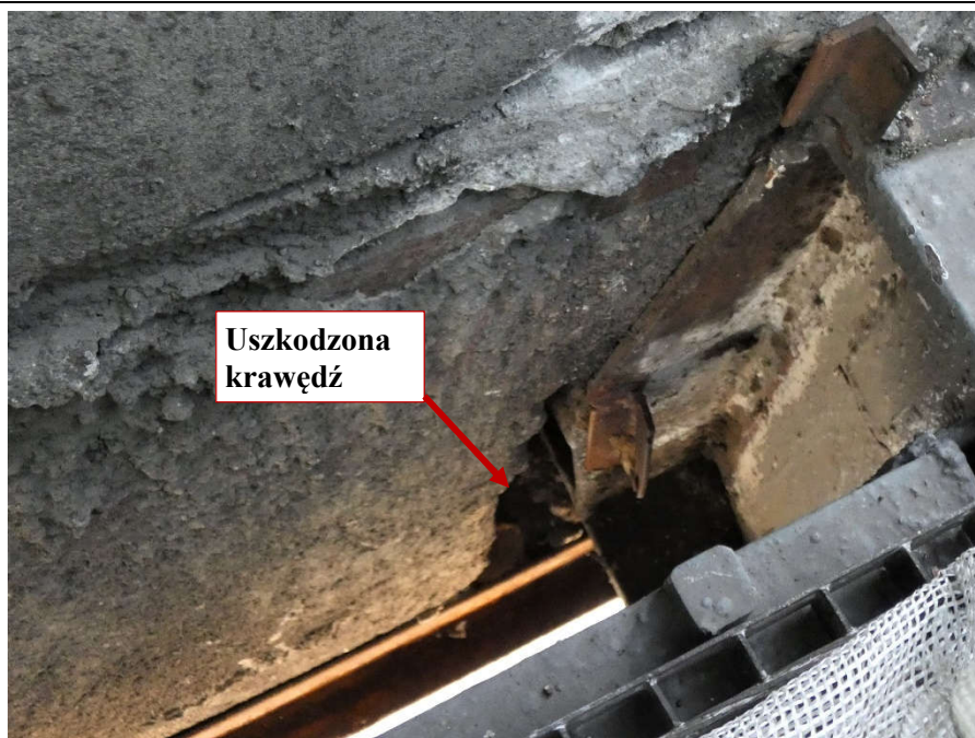
Fot. 140 Pod kondygnacją 5 (Poziom +21.90) Elewacja Północna – belka w osiach 10-11/I. Uszkodzona krawędź elementu.
