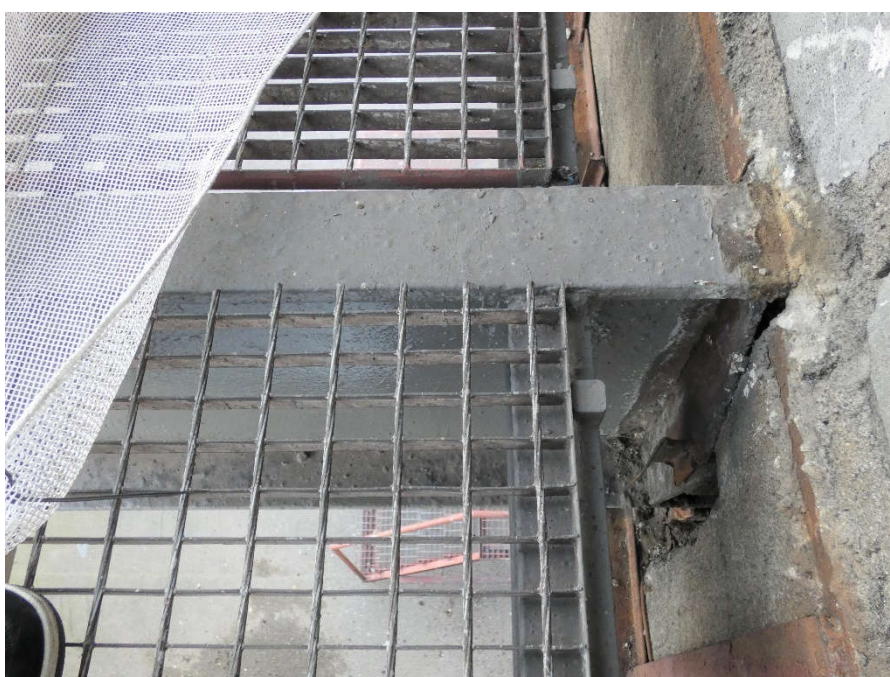
Fot. 221, 222 Pod kondygnacją 5 (Poziom +21.90) Elewacja Zachodnia – wspornik w osiach 10/H Brak widocznych uszkodzeń wspornika.
