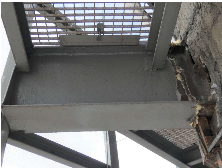
Fot. 197, 198 Nad kondygnacją 5 (Poziom +21.90) Elewacja Południowa– wspornik w osiach 10/E. Brak widocznych uszkodzeń wspornika.
