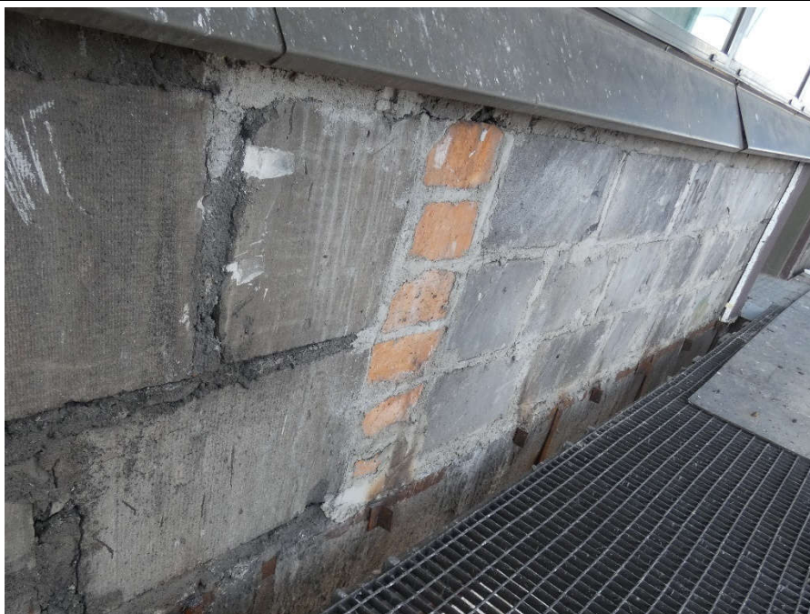
Fot. 18 Kondygnacja 5 (Poziom +21.90) Elewacja Wschodnia – widok ściany murowanej w osiach 14/F-G. Zbyt duże wymiary spoin. Ściana z elementów 24x60 cm. Zwieńczenie ściany podlewką. Zamknięcie pionu instalacyjnego elementami ceramicznymi.
