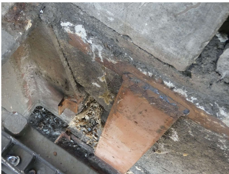
Fot. 126 Pod kondygnacją 5 (Poziom +21.90) Elewacja Wschodnia – belka w osiach 14/E-F. Brak widocznych uszkodzeń belki przy podporze. Przestrzeń między elementami wypełniona odpadami.
