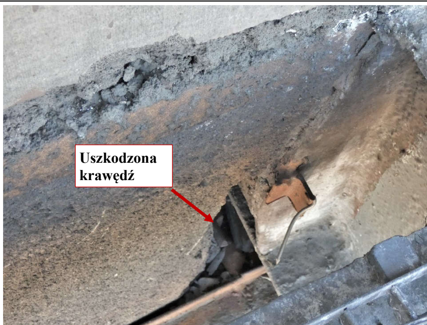
Fot. 134 Pod kondygnacją 5 (Poziom +21.90) Elewacja Północna – belka w osiach 13-14/I. Uszkodzona krawędź elementu. Zalegający gruz w przestrzeni między elementami
