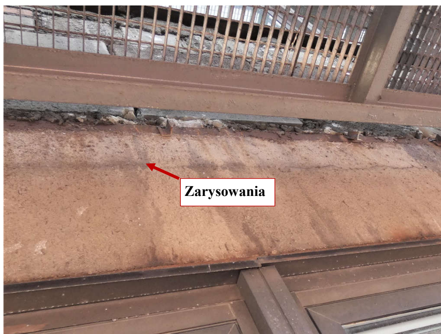
Fot. 101 Nad kondygnacją 5 (Poziom +21.90) Elewacja Zachodnia – belka w osiach 10/F-G. Zarysowanie belki w przęśle na wysokości miejsca oparcia.
