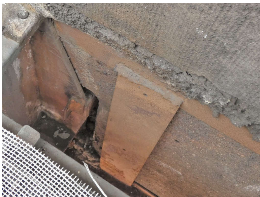
Fot. 153 Pod kondygnacją 5 (Poziom +21.90) Elewacja Południowa – belka w osiach 12-13/E. Brak widocznych uszkodzeń belki przy podporze. Zalegający gruz w przestrzeni między elementami.
