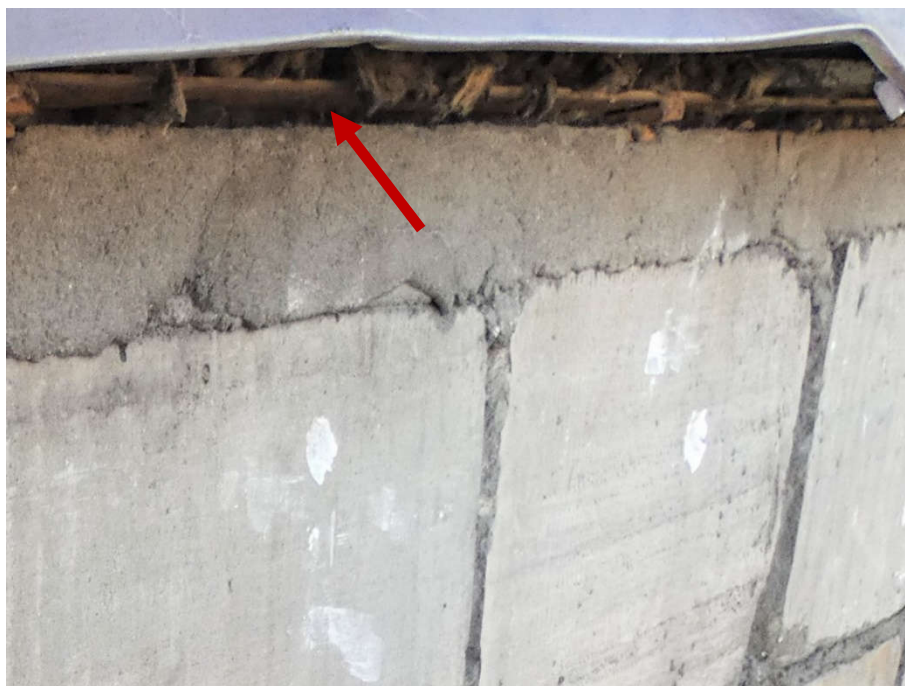
Fot. 8 Widok zwieńczenia ściany podlewką wyrównującą pod profilem stalowym
