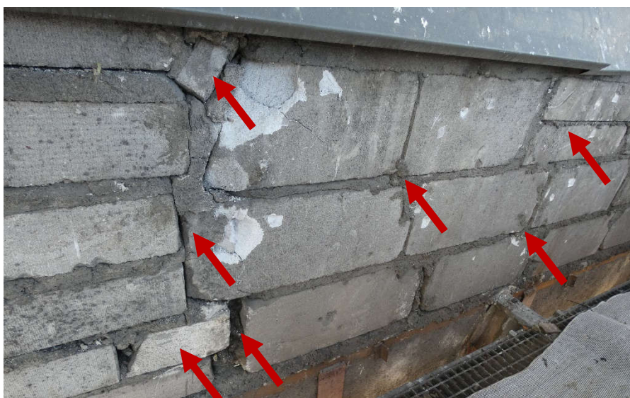
Fot. 21 Kondygnacja 5 (Poziom +21.90) Elewacja Wschodnia – widok ściany murowanej w osiach 14/G-H. Zbyt duże wymiary spoin. Ubytki spoin pionowych. Niewłaściwe przewiązanie elementów. Ściana z uszkodzonych elementów murowych o zróżnicowanych kształtach (12x60, 24x60 cm). Wypełnienie ubytków między elementami i uszkodzonych miejsc zaprawą i gruzem. Zwieńczenie ściany podlewką i elementami murowymi.
