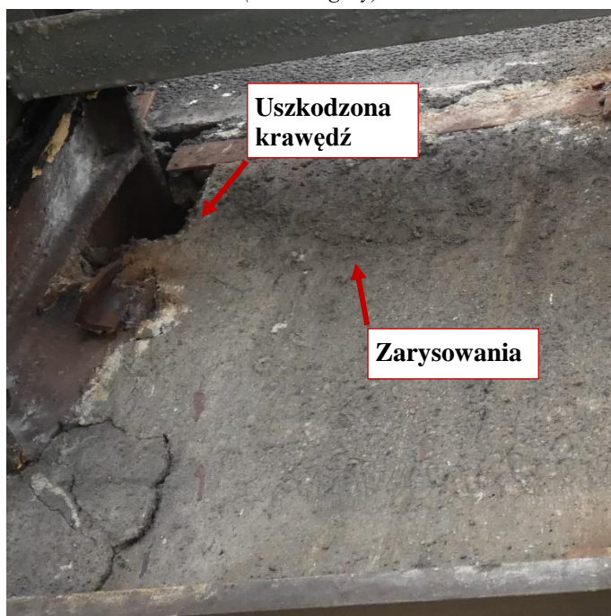
Fot. 66, 67 Kondygnacja 10 (Poziom +38.40) Elewacja Wschodnia – belka w osiach 14/E-F. Uszkodzona krawędź elementu. Zalegający gruz w przestrzeni między elementami. Zarysowanie belki na wysokości miejsca oparcia. Spękania i zarysowania powierzchni zaprawy.
