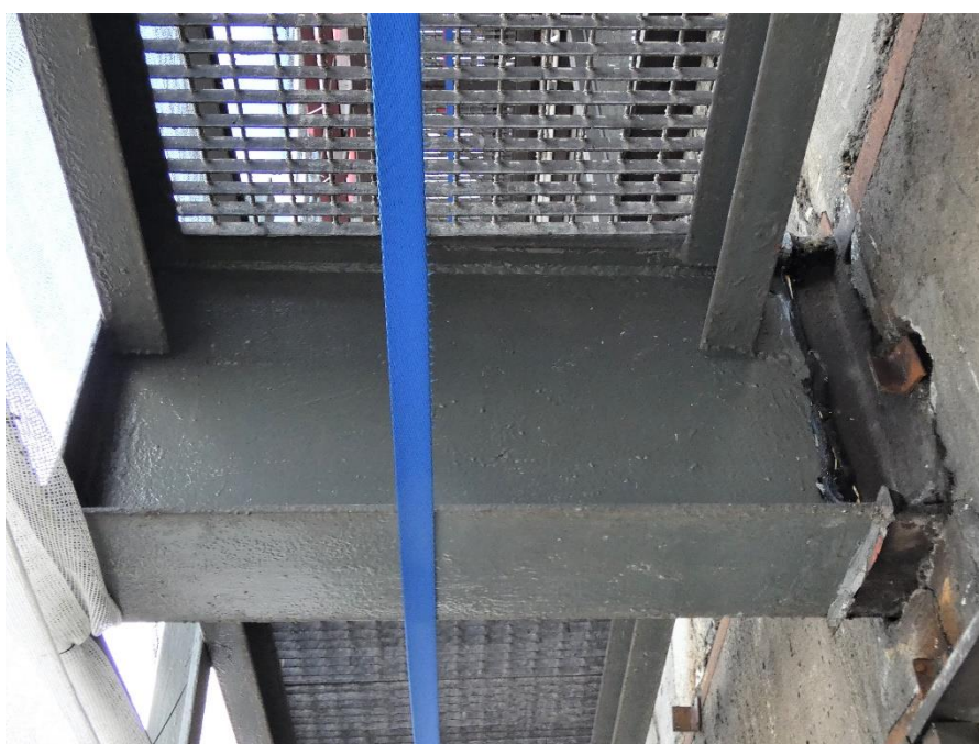
Fot. 150, 151 Kondygnacja 10 (Poziom +38.40) Elewacja Zachodnia– wspornik w osiach 10/H (widok z dołu) Brak widocznych uszkodzeń wspornika.
