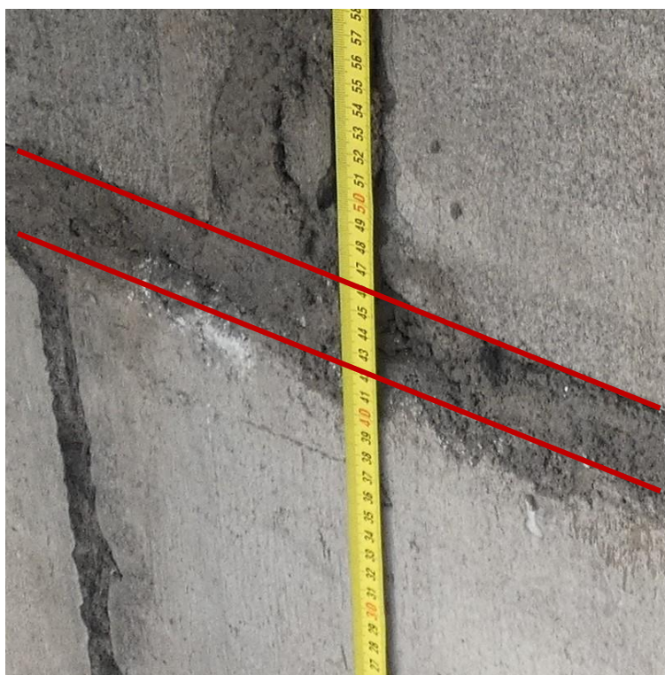
Fot. 1 Przykładowa spoina pozioma – grubość 4 cm
