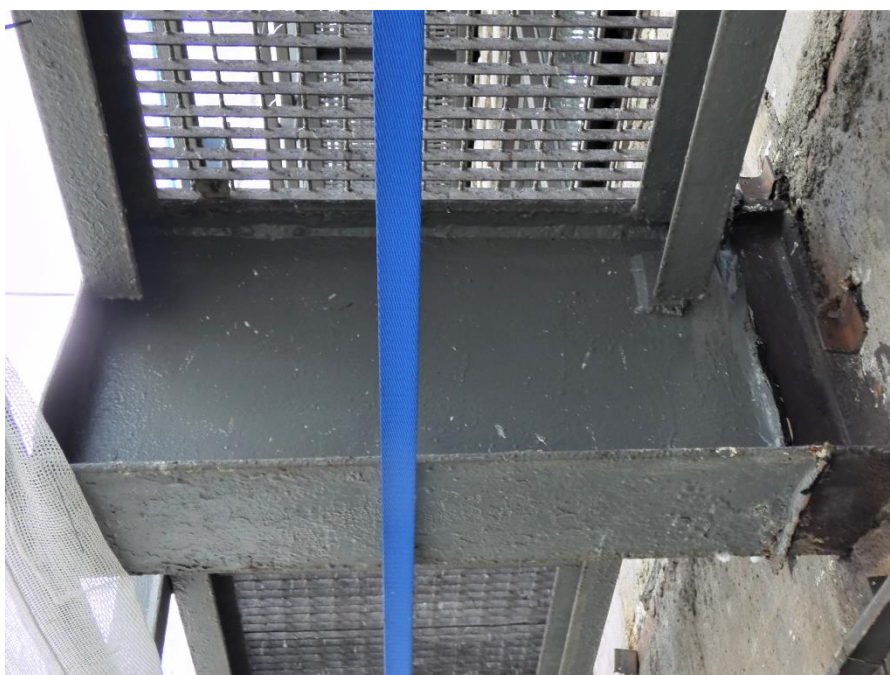
Fot. 142, 143 Kondygnacja 10 (Poziom +38.40) Elewacja Północna – wspornik w osiach 12/I. Brak widocznych uszkodzeń wspornika.
