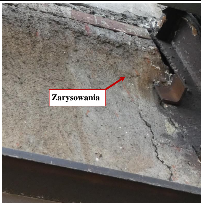
Fot. 76 Kondygnacja 10 (Poziom +38.40) Elewacja Północna – belka w osiach 13-14/I. Zarysowania belki na wysokości miejsca oparcia. Spękania i zarysowania powierzchni zaprawy.
