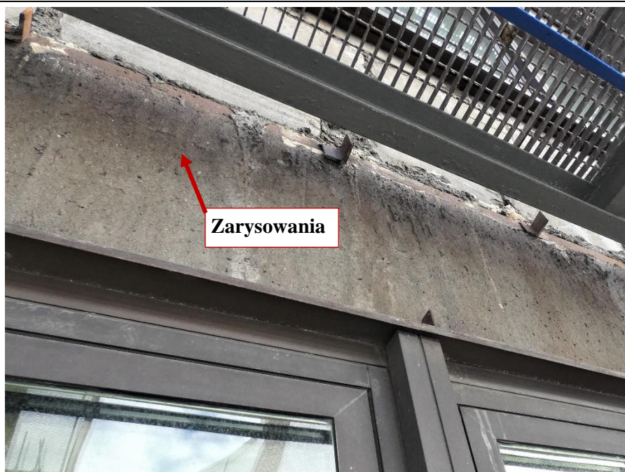
Fot. 111 Kondygnacja 10 (Poziom +38.40) Elewacja Południowa – belka w osiach 11-12/E. Zarysowanie belki w przęśle na wysokości miejsca oparcia.
