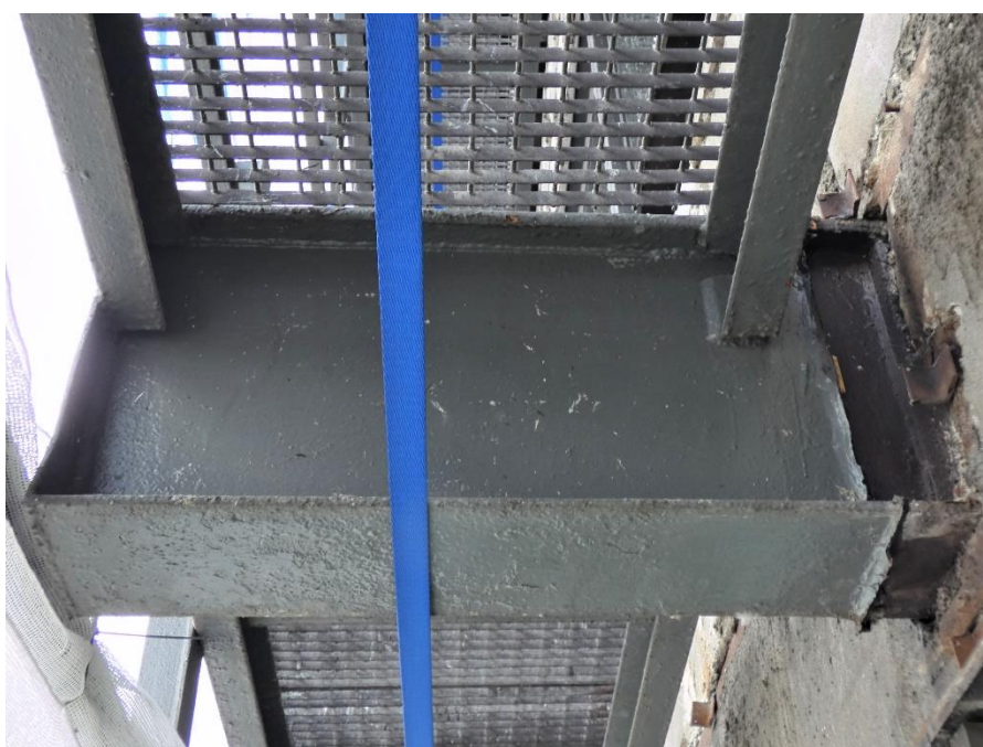
Fot. 144, 145 Kondygnacja 10 (Poziom +38.40) Elewacja Północna – wspornik w osiach 11/I. Przemieszczenia wspornika w kierunku osi 10. Brak widocznych uszkodzeń wspornika.
