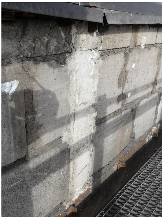
Fot. 11 Przykład zamknięcia pionu instalacyjnego.
