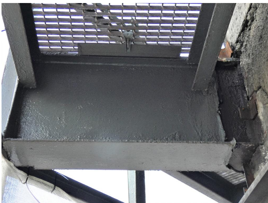
Fot. 161, 162 Kondygnacja 10 (Poziom +38.40) Elewacja Południowa– wspornik w osiach 10/E. Brak widocznych uszkodzeń wspornika.
