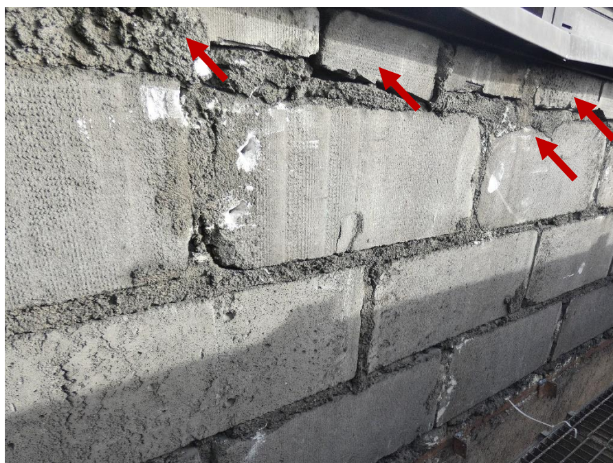
Fot. 63 Kondygnacja 10 (Poziom +38.40) Elewacja Południowa – widok ściany murowanej w osiach 13-14/E.
