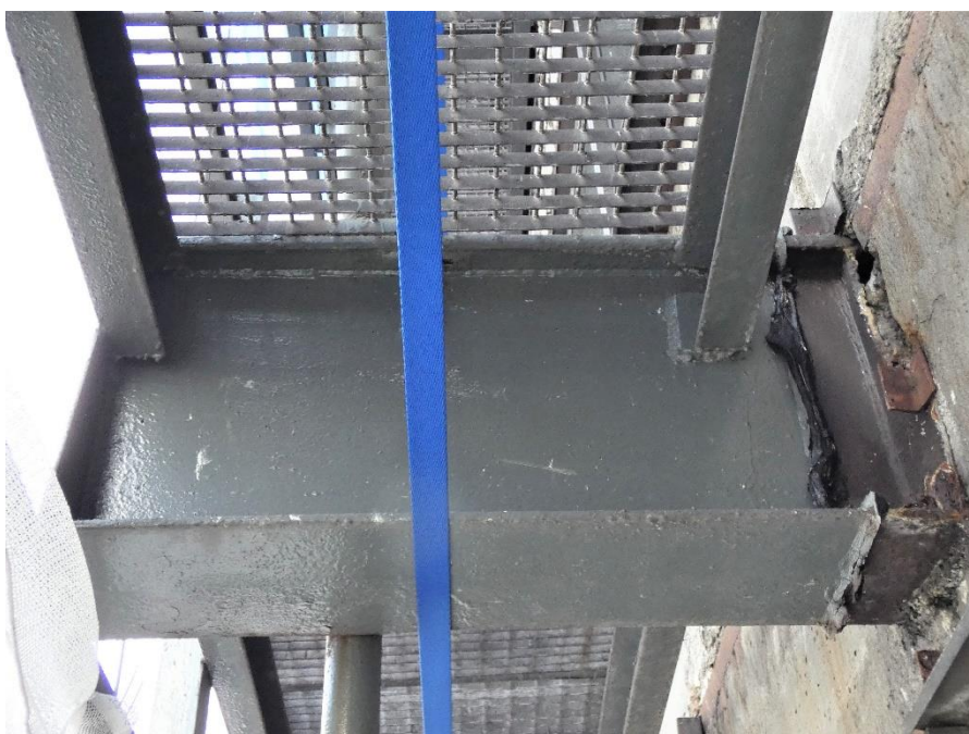
Fot. 156, 157 Kondygnacja 10 (Poziom +38.40) Elewacja Zachodnia– wspornik w osiach 10/F (widok z dołu) Brak widocznych uszkodzeń wspornika.
