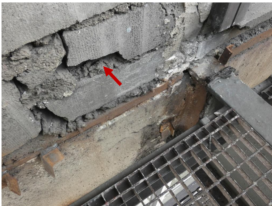
Fot. 55 Kondygnacja 10 (Poziom +38.40) Elewacja Południowa – widok ściany murowanej w osiach 10-11/E. Wypełnienie ubytków między elementami zaprawą i gruzem
