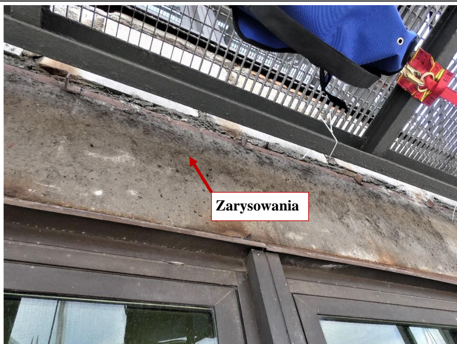
Fot. 86 Kondygnacja 10 (Poziom +38.40) Elewacja Północna – belka w osiach 10-11/I.
