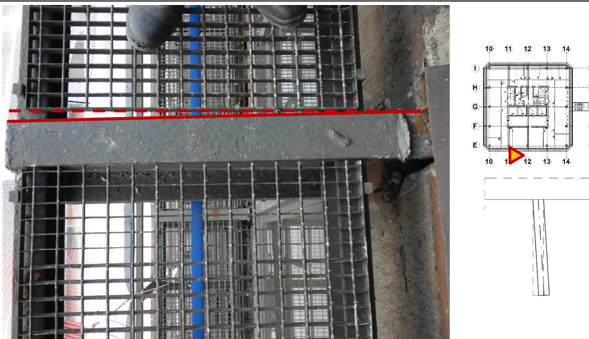
Fot. 165 Kondygnacja 10 (Poziom +38.40) Elewacja Południowa– wspornik w osiach 11/E (widok z góry) Przemieszczenia wspornika w kierunku osi 12. Brak widocznych uszkodzeń wspornika.
