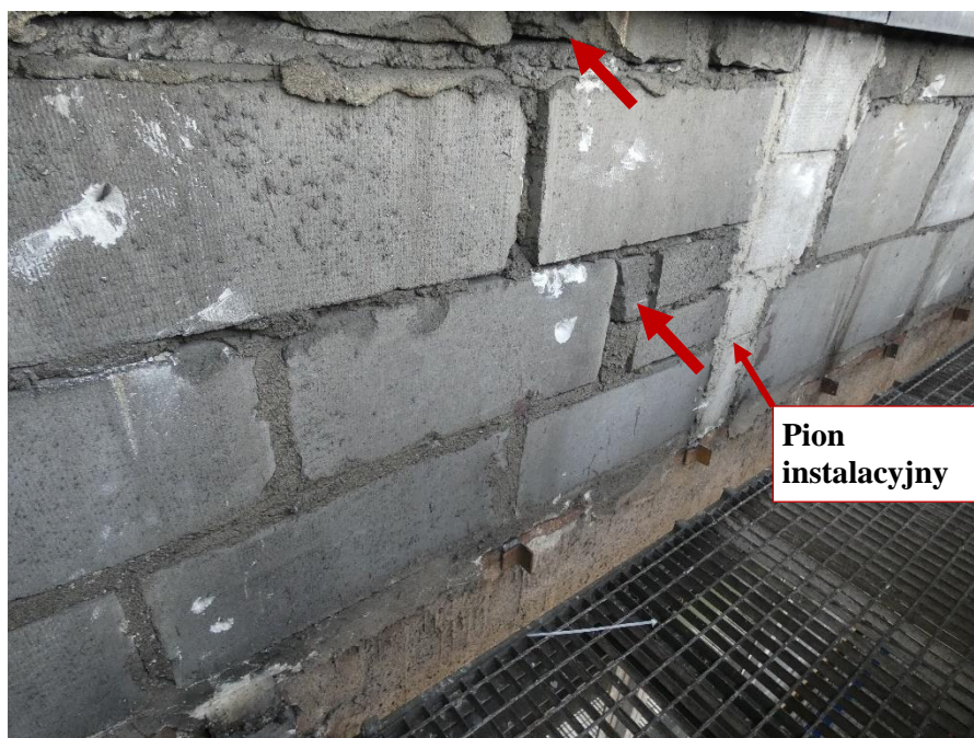
Fot. 43 Kondygnacja 10 (Poziom +38.40) Elewacja Zachodnia – widok ściany murowanej w osiach 10/F-G.
