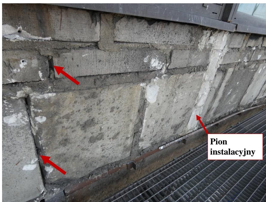
Fot. 29 Kondygnacja 10 (Poziom +38.40) Elewacja Północna – widok ściany murowanej w osiach 11-12/I.
