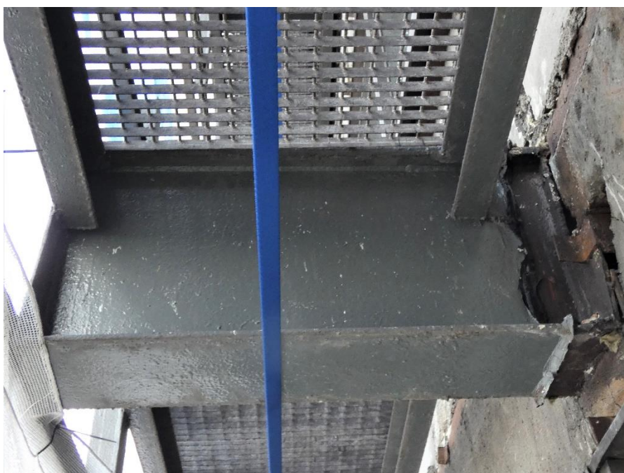
Fot. 153, 154 Kondygnacja 10 (Poziom +38.40) Elewacja Zachodnia – wspornik w osiach 10/G (widok z dołu) Brak widocznych uszkodzeń wspornika.
