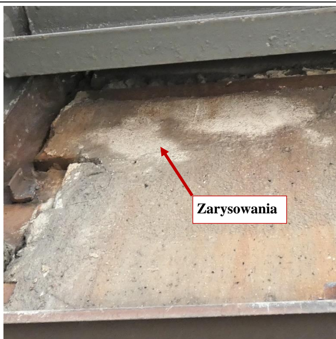
Fot. 113 Kondygnacja 10 (Poziom +38.40) Elewacja Południowa – belka w osiach 12-13/E. Zarysowanie belki na wysokości miejsca oparcia. Spękania i zarysowania powierzchni zaprawy
