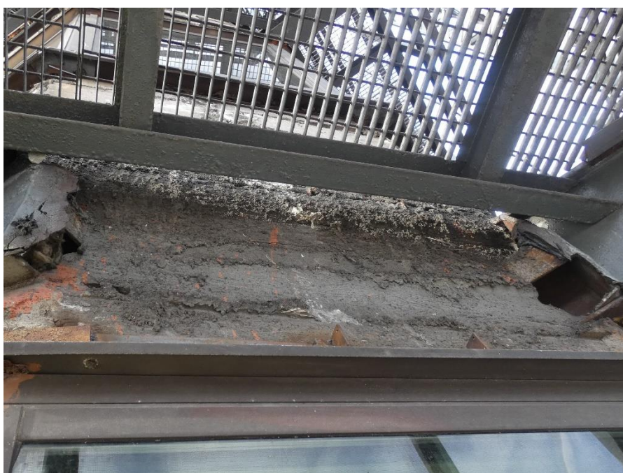
Fot. 73 Kondygnacja 10 (Poziom +38.40) Elewacja Wschodnia – belka w osiach 14/I. Brak możliwości pomiaru głębokości oparcia i określenia zastosowanych rozwiązań konstrukcyjnych. Brak widocznych uszkodzeń.
