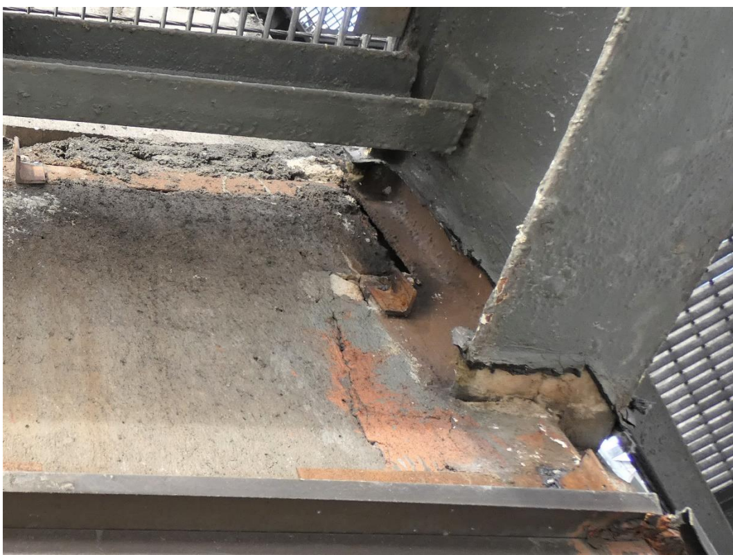
Fot. 124 Wspornik stalowy w miejscu oparcia belek żelbetowych (widok z dołu)
