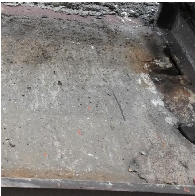
Fot. 84 Kondygnacja 10 (Poziom +38.40) Elewacja Północna – belka w osiach 11-12/I. Spękania i zarysowania powierzchni zaprawy. Brak widocznych uszkodzeń belki przy podporze.
