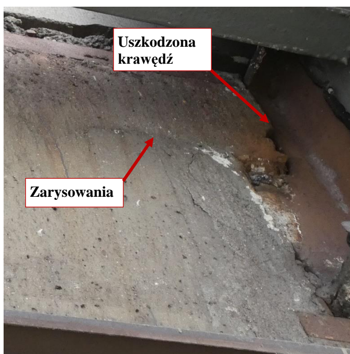
Fot. 112 Kondygnacja 10 (Poziom +38.40) Elewacja Południowa – belka w osiach 11-12/E. Uszkodzona krawędź elementu. Zarysowanie belki na wysokości miejsca oparcia. Zarysowania powierzchni zaprawy.
