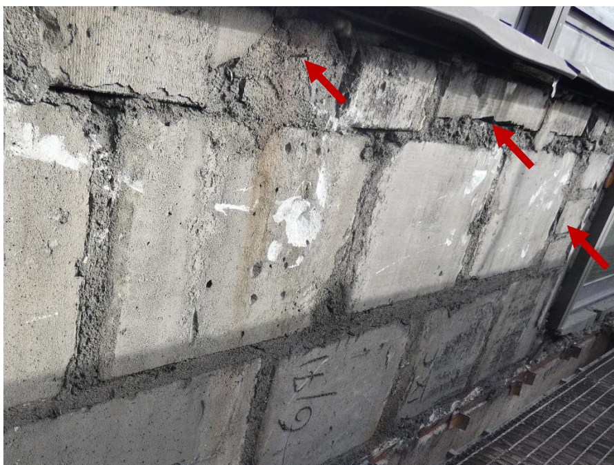
Fot. 61 Kondygnacja 10 (Poziom +38.40) Elewacja Południowa – widok ściany murowanej w osiach 12-13/E.
