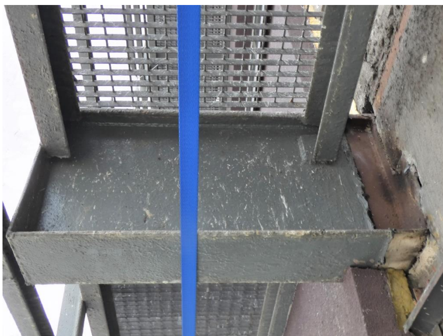
Fot. 133, 134 Kondygnacja 10 (Poziom +38.40) Elewacja Wschodnia – wspornik w osiach 14/H (widok z dołu) Brak widocznych uszkodzeń wspornika.
