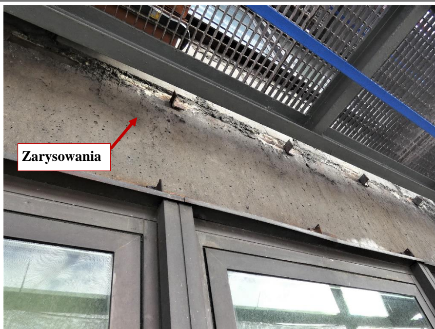
Fot. 107 Kondygnacja 10 (Poziom +38.40) Elewacja Południowa – belka w osiach 10-11/E. Zarysowanie belki w przęśle na wysokości miejsca oparcia.
