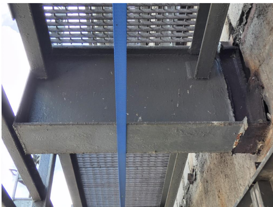
Fot. 140, 141 Kondygnacja 10 (Poziom +38.40) Elewacja Północna – wspornik w osiach 13/I. Brak widocznych uszkodzeń wspornika.
