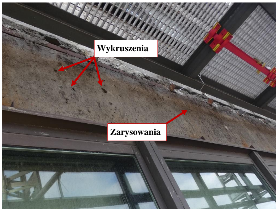
Fot. 75 Kondygnacja 10 (Poziom +38.40) Elewacja Północna – belka w osiach 13-14/I. Wykruszenia otuliny. Zarysowania belki w przęśle na wysokości miejsca oparcia.
