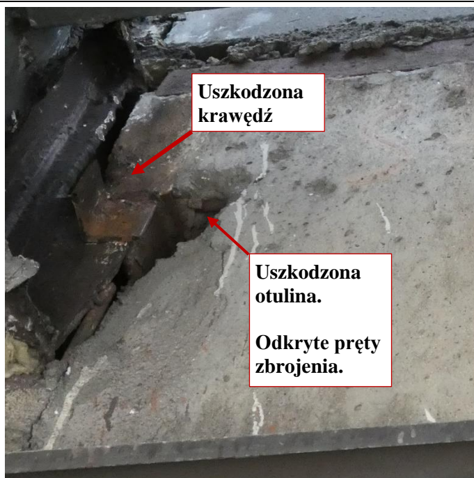
Fot. 98 Kondygnacja 10 (Poziom +38.40) Elewacja Zachodnia – belka w osiach 10/F-G. Uszkodzona otulina i krawędź elementu. Odkryte pręty zbrojeniowe. Uszkodzenia zaprawy między elementami.
