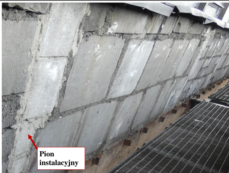
Fot. 44 Kondygnacja 10 (Poziom +38.40) Elewacja Zachodnia – widok ściany murowanej w osiach 10/F-G. Zbyt duże wymiary spoin. Wykonanie ściany z elementów murowych 36x60 cm. Wypełnienie ubytków między elementami zaprawą. Zwieńczenie ściany elementami murowymi 12x60 cm. Zamknięcie pionu instalacyjnego.
