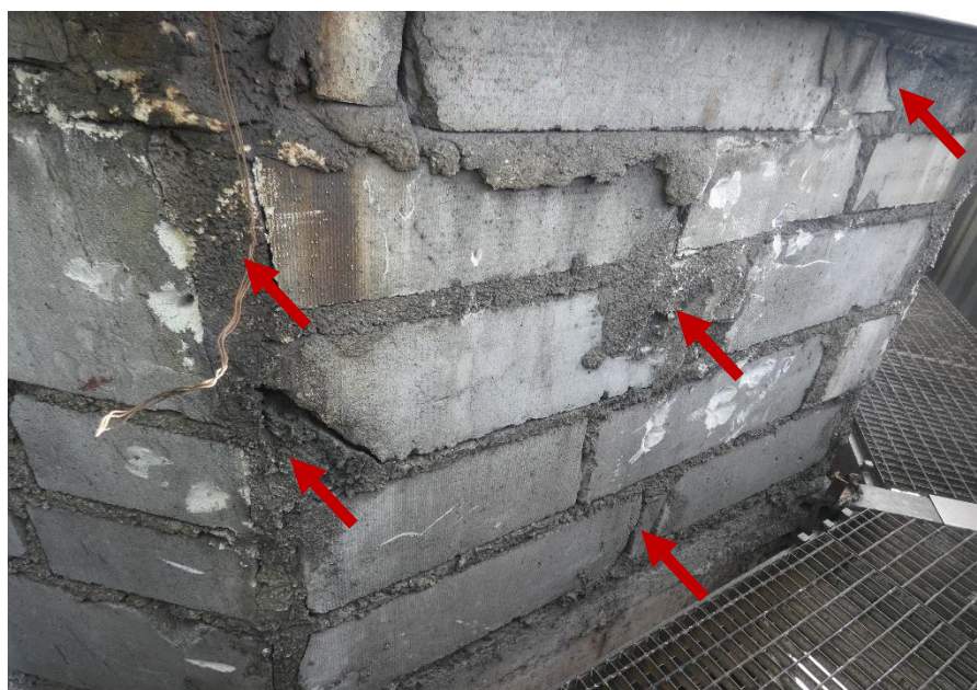
Fot. 49 Kondygnacja 10 (Poziom +38.40) Elewacja Zachodnia – widok ściany murowanej w osiach 10/E.
