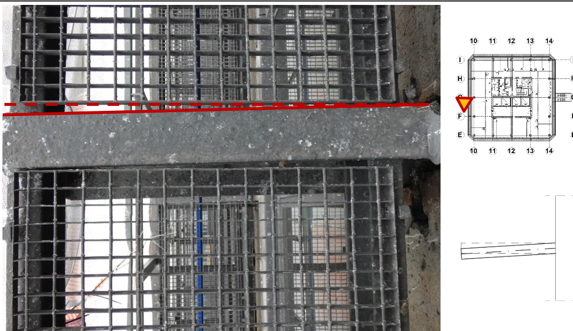
Fot. 155 Kondygnacja 10 (Poziom +38.40) Elewacja Zachodnia– wspornik w osiach 10/G (widok z góry) Przemieszczenia wspornika w kierunku osi F. Brak widocznych uszkodzeń wspornika.
