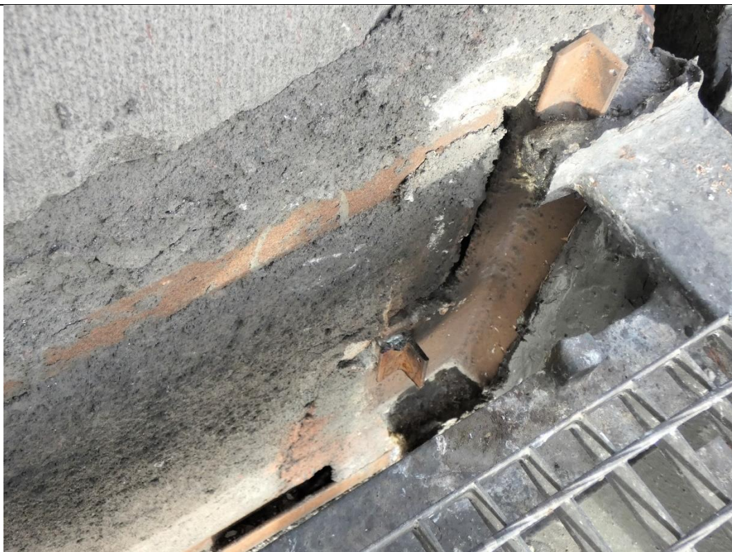
Fot. 123 Wspornik stalowy w miejscu oparcia belek żelbetowych (widok z góry)
