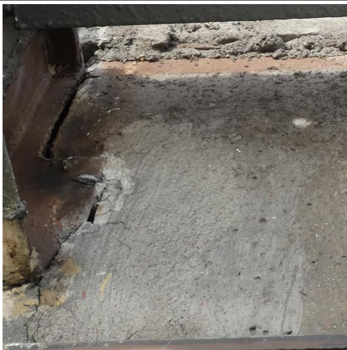
Fot. 70 Kondygnacja 10 (Poziom +38.40) Elewacja Wschodnia – belka w osiach 14/H-I. Spękania i zarysowania powierzchni zaprawy. Brak widocznych uszkodzeń belki przy podporze.
