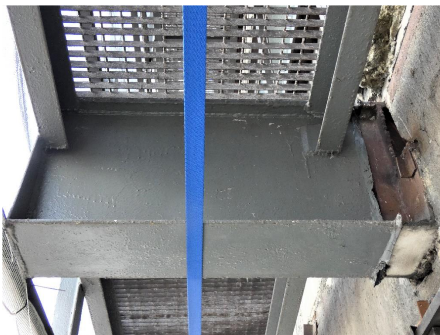
Fot. 163, 164 Kondygnacja 10 (Poziom +38.40) Elewacja Południowa– wspornik w osiach 11/E (widok z dołu) Brak widocznych uszkodzeń wspornika.
