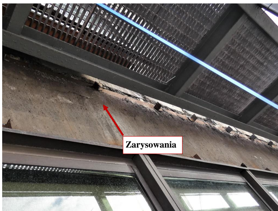
Fot. 114 Kondygnacja 10 (Poziom +38.40) Elewacja Południowa – belka w osiach 12-13/E. Zarysowanie belki w przęśle na wysokości miejsca oparcia.
