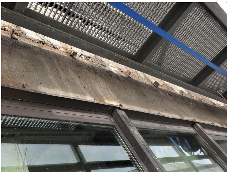
Fot. 71 Kondygnacja 10 (Poziom +38.40) Elewacja Wschodnia – belka w osiach 14/H-I. Brak widocznych uszkodzeń belki w przęśle.
