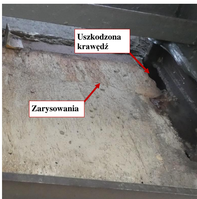
Fot. 104 Kondygnacja 10 (Poziom +38.40) Elewacja Zachodnia – belka w osiach 10/E-F. Uszkodzona krawędź elementu. Zalegający gruz w przestrzeni między elementami. Zarysowanie belki na wysokości miejsca oparcia. Zarysowania powierzchni zaprawy.
