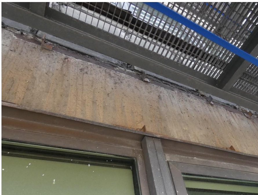
Fot. 99 Kondygnacja 10 (Poziom +38.40) Elewacja Zachodnia – belka w osiach 10/F-G. Brak widocznych uszkodzeń belki w przęśle.
