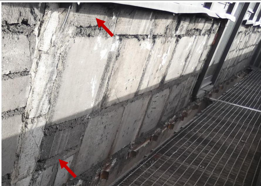
Fot. 60 Kondygnacja 10 (Poziom +38.40) Elewacja Południowa – widok ściany murowanej w osiach 12-13/E.
