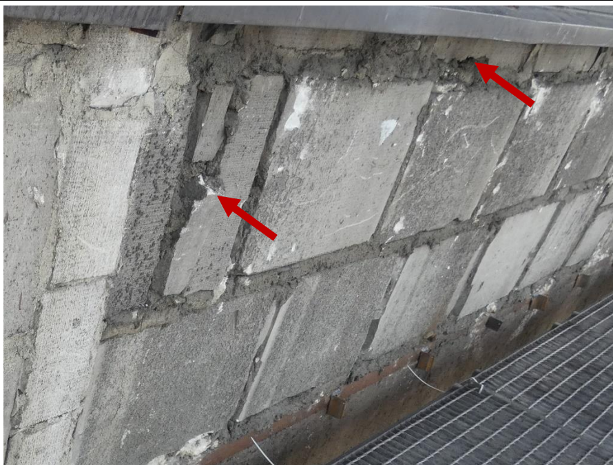
Fot. 22 Kondygnacja 10 (Poziom +38.40) Elewacja Północna – widok ściany murowanej w osiach 13-14/I. Zbyt duże wymiary spoin. Zwieńczenie ściany uszkodzonymi elementami murowymi. Wypełnienie ubytków między elementami zaprawą i gruzem.
