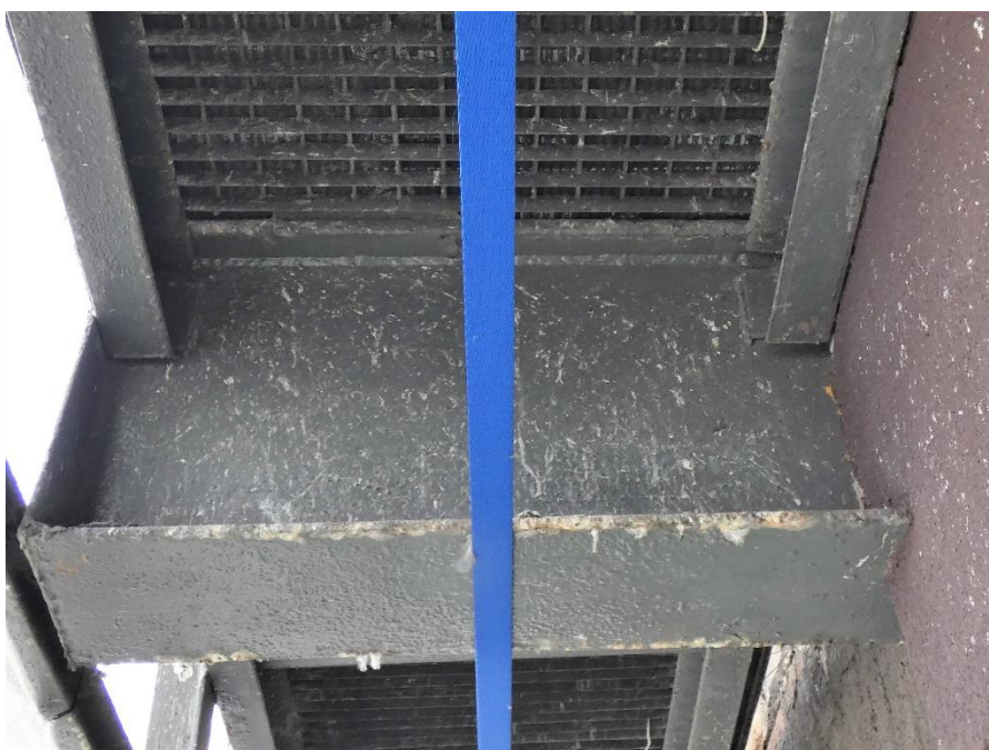
Fot. 129, 130 Kondygnacja 10 (Poziom +38.40) Elewacja Wschodnia – wspornik w osiach 14/F Pozostałości po usuniętej drabinie ewakuacyjnej. Brak widocznych uszkodzeń wspornika.
