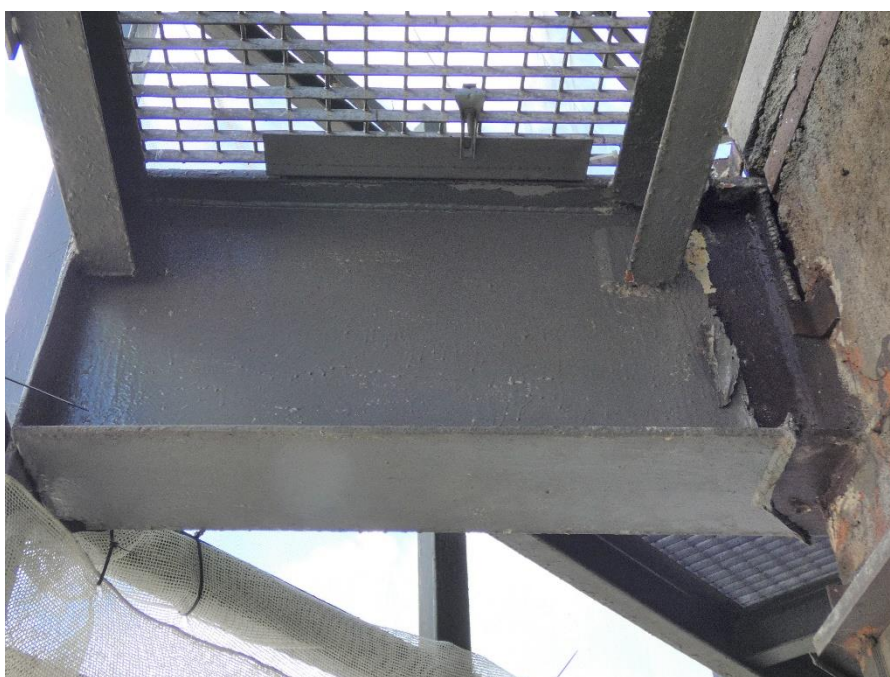
Fot. 138, 139 Kondygnacja 10 (Poziom +38.40) Elewacja Północna – wspornik w osiach 14/I. Brak widocznych uszkodzeń wspornika.
