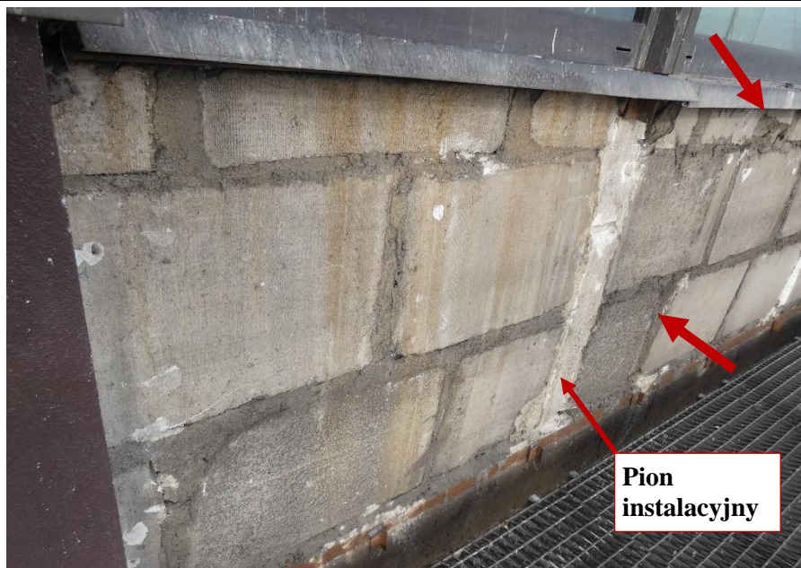
Fot. 16 Kondygnacja 10 (Poziom +38.40) Elewacja Wschodnia – widok ściany murowanej w osiach 14/H-I.
