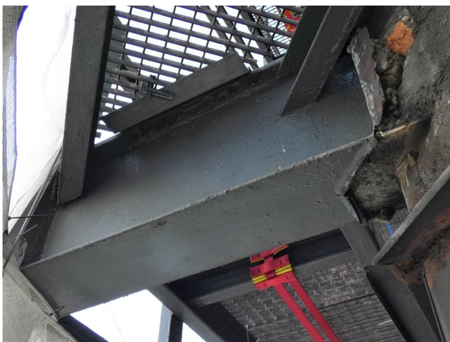
Fot. 170, 171 Kondygnacja 10 (Poziom +38.40) Elewacja Południowa– wspornik w osiach 14/E. Brak widocznych uszkodzeń wspornika.
