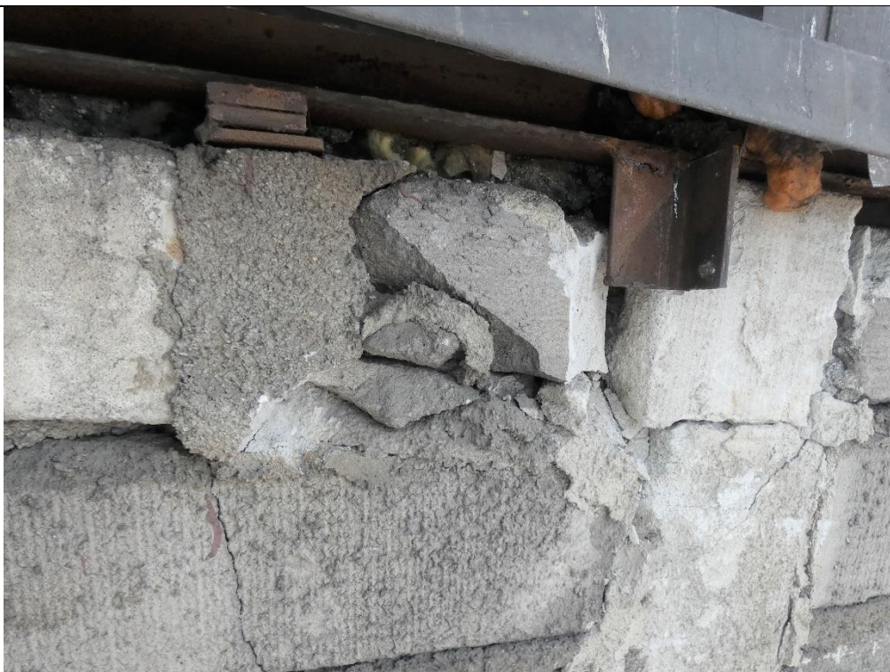
Fot. 8 Przykład wypełnienia gruzem przestrzeni między elementami zwieńczenia ściany.
