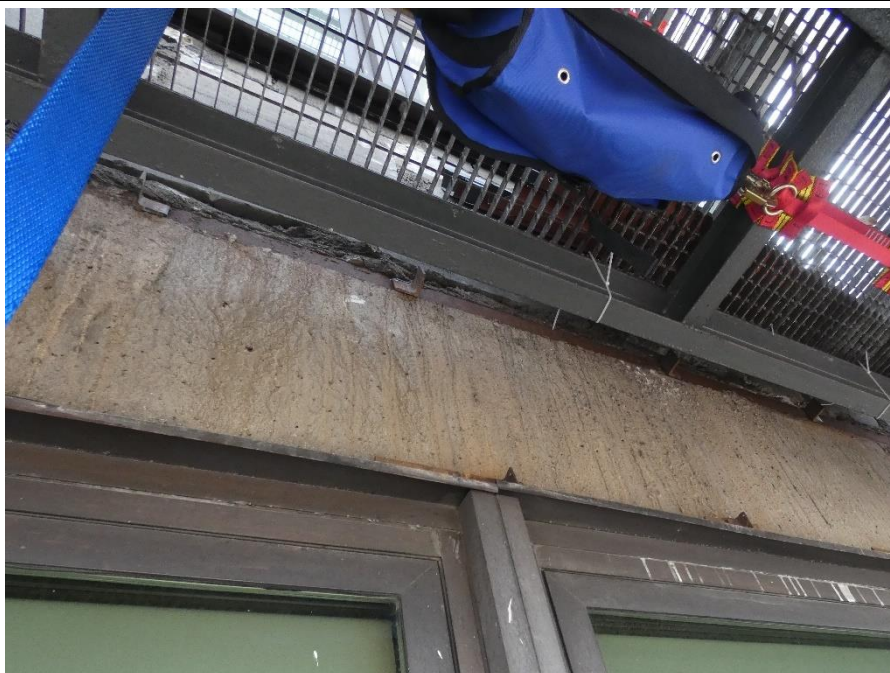
Fot. 103 Kondygnacja 10 (Poziom +38.40) Elewacja Zachodnia – belka w osiach 10/E-F. Brak widocznych uszkodzeń belki w przęśle
