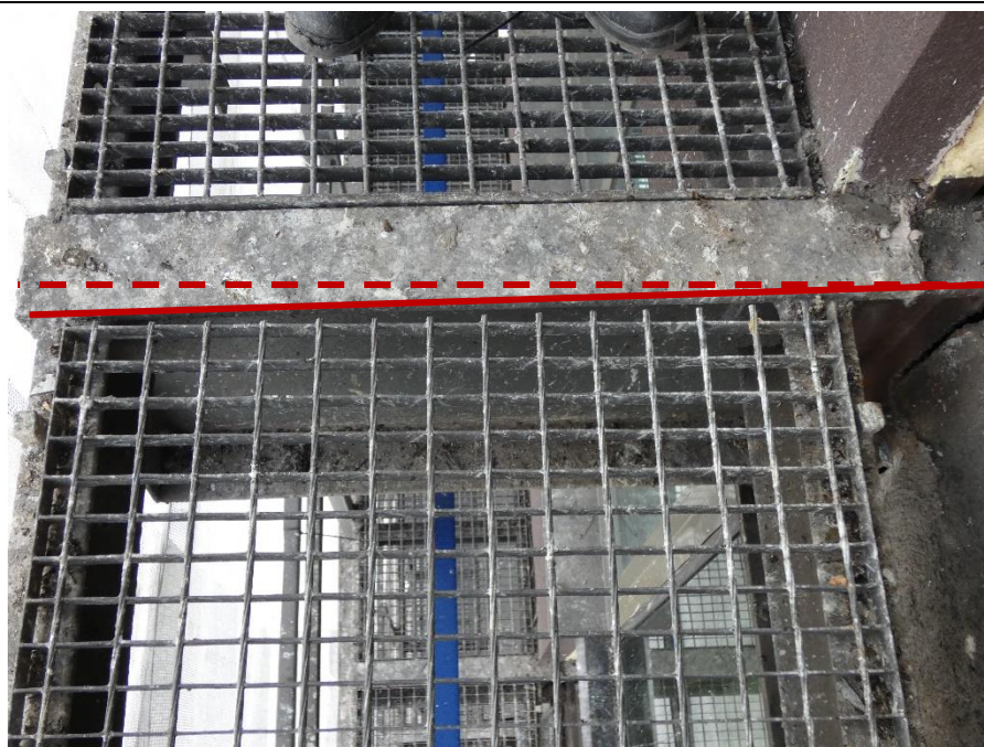
Fot. 135 Kondygnacja 10 (Poziom +38.40) Elewacja Wschodnia – wspornik w osiach 14/H (widok z góry) Przemieszczenia wspornika w kierunku osi I. Brak widocznych uszkodzeń wspornika.
