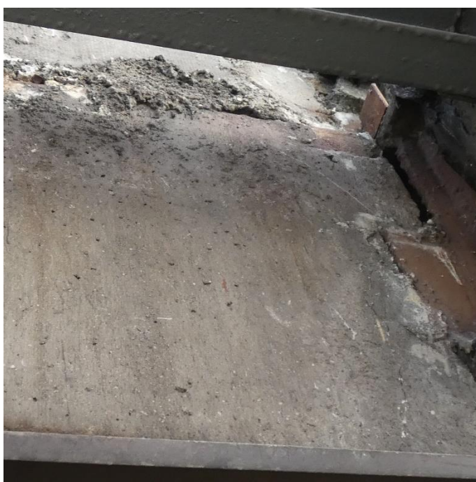
Fot. 108 Kondygnacja 10 (Poziom +38.40) Elewacja Południowa – belka w osiach 10-11/E. Zarysowania powierzchni zaprawy. Brak widocznych uszkodzeń belki przy podporze.
