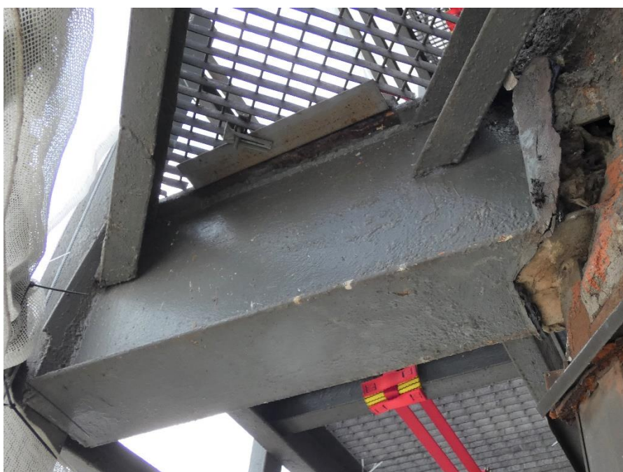
Fot. 136, 137 Kondygnacja 10 (Poziom +38.40) Elewacja Wschodnia – wspornik w osiach 14/I. Brak widocznych uszkodzeń wspornika.
