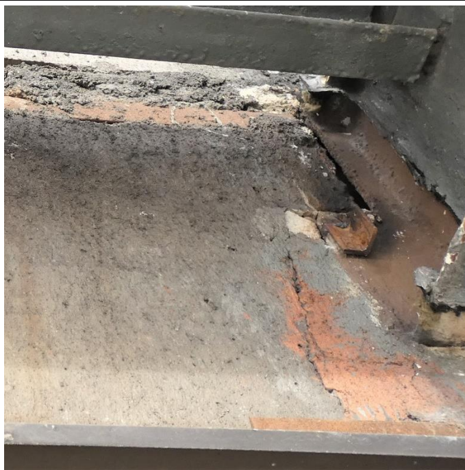
Fot. 72 Kondygnacja 10 (Poziom +38.40) Elewacja Wschodnia – belka w osiach 14/H-I. Spękania i zarysowania powierzchni zaprawy. Brak widocznych uszkodzeń belki przy podporze.
