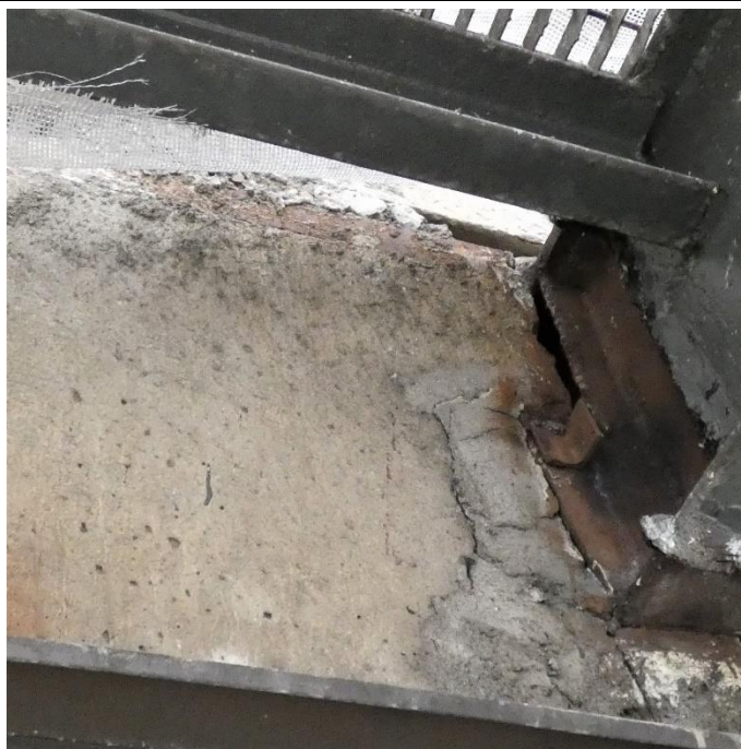
Fot. 85 Kondygnacja 14 (Poziom +51.60) Elewacja Zachodnia – belka w osiach 10/G-H. Zarysowania powierzchni zaprawy. Brak widocznych uszkodzeń belki przy podporze.
