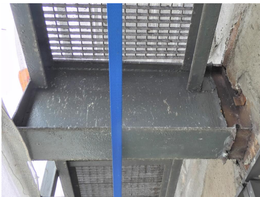
Fot. 137, 138 Kondygnacja 14 (Poziom +51.60) Elewacja Zachodnia– wspornik w osiach 10/G. Brak widocznych uszkodzeń wspornika.
