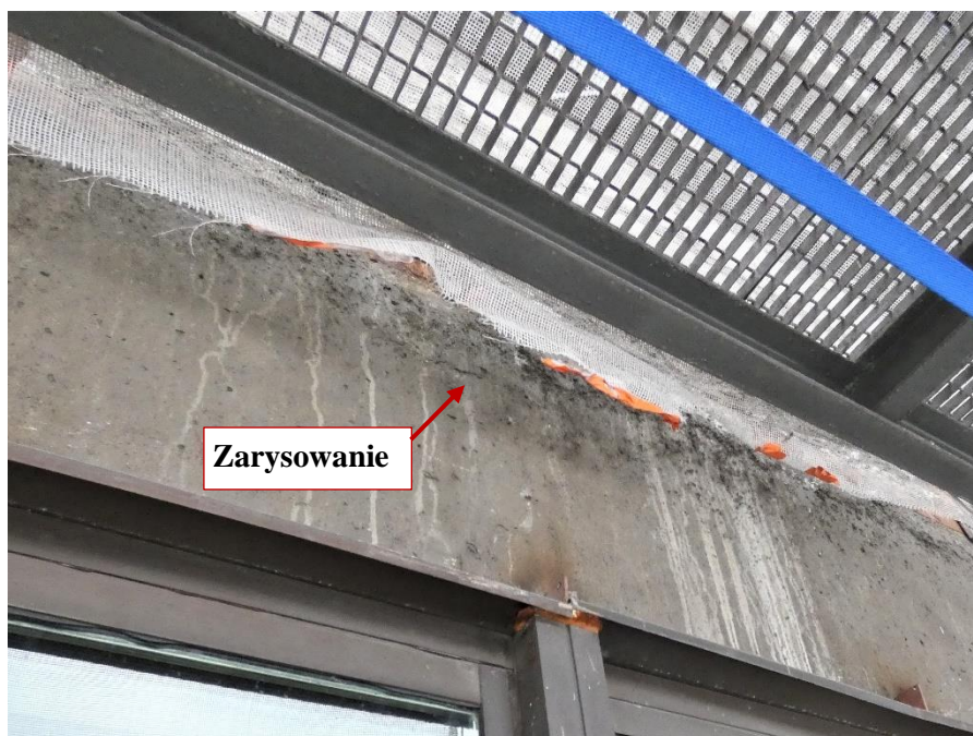
Fot. 74 Kondygnacja 14 (Poziom +51.60) Elewacja Północna – belka w osiach 11-12/I. Zarysowanie belki w przęśle na wysokości miejsca oparcia.
