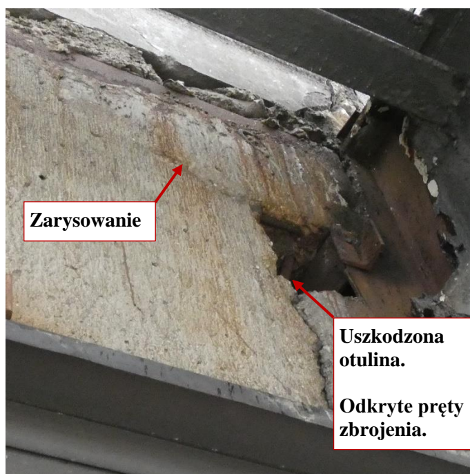
Fot. 92 Kondygnacja 14 (Poziom +51.60) Elewacja Zachodnia – belka w osiach 10/E-F.
