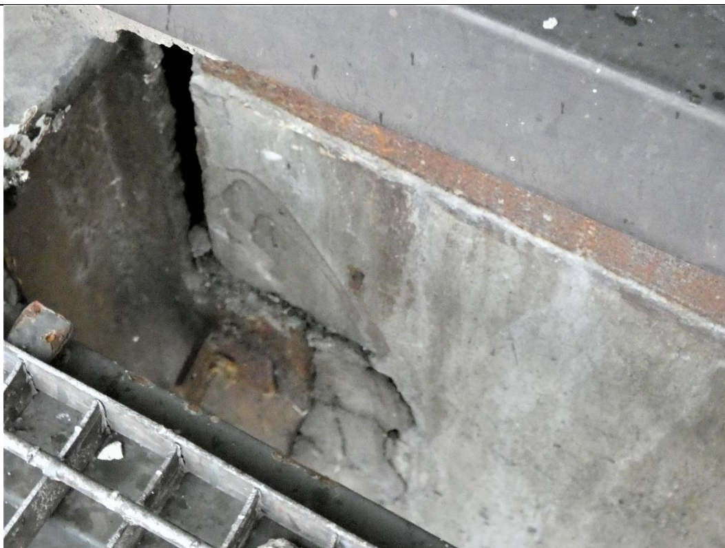
Fot. 108 Wspornik stalowy w miejscu oparcia belek żelbetowych (widok z góry)
