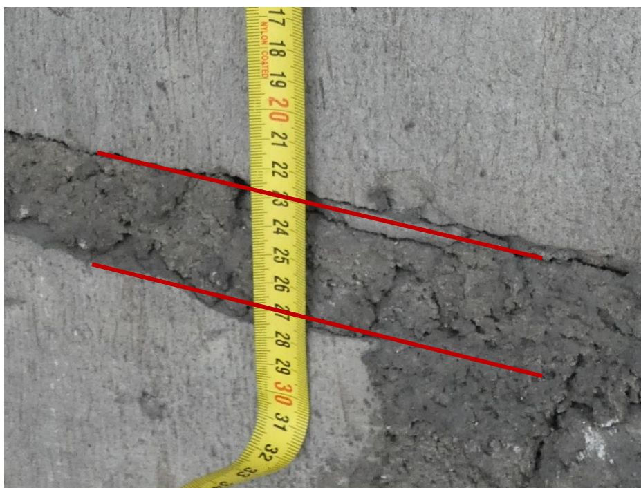
Fot. 1 Przykładowa spoina pozioma – grubość 4 cm
