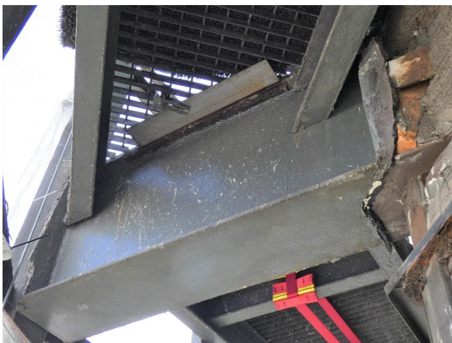
Fot. 121, 122 Kondygnacja 14 (Poziom +51.60) Elewacja Wschodnia – wspornik w osiach 14/I. Brak widocznych uszkodzeń wspornika.
