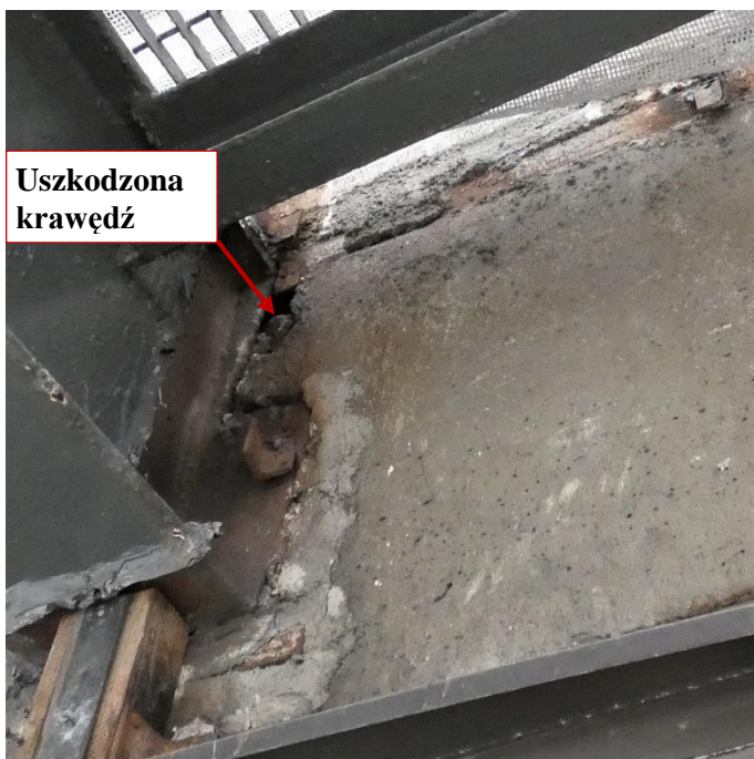
Fot. 76 Kondygnacja 14 (Poziom +51.60) Elewacja Północna – belka w osiach 10-11/I. Uszkodzona krawędź elementu, brak widocznego zbrojenia. Zalegający gruz w przestrzeni między elementami. Zarysowania powierzchni zaprawy.
