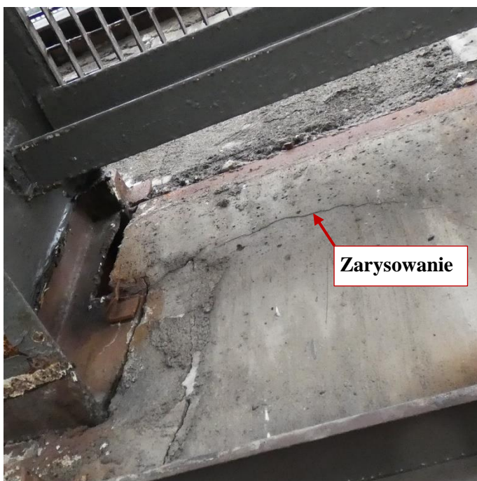
Fot. 101 Kondygnacja 14 (Poziom +51.60) Elewacja Południowa – belka w osiach 12-13/E.
