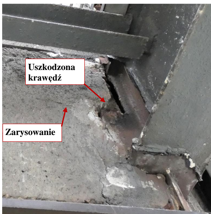
Fot. 63 Kondygnacja 14 (Poziom +51.60) Elewacja Wschodnia – belka w osiach 14/H-I.
