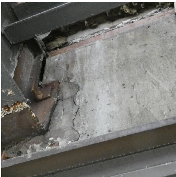
Fot. 98 Kondygnacja 14 (Poziom +51.60) Elewacja Południowa – belka w osiach 11-12/E. Spękania i zarysowania powierzchni zaprawy. Brak widocznych uszkodzeń belki przy podporze.
