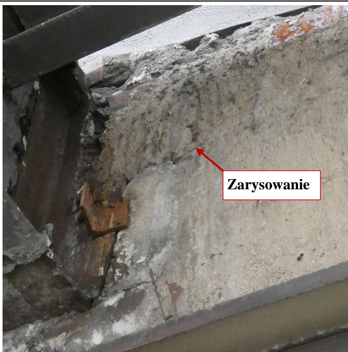
Fot. 83 Kondygnacja 14 (Poziom +51.60) Elewacja Zachodnia – belka w osiach 10/G-H. Zarysowanie belki na wysokości miejsca oparcia. Zarysowania powierzchni zaprawy.
