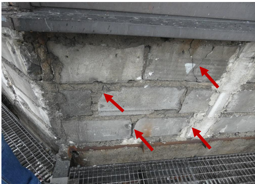
Fot. 32 Kondygnacja 14 (Poziom +51.60) Elewacja Zachodnia – widok ściany murowanej w osiach 10/H-I. Zbyt duże wymiary spoin. Ubytki spoin pionowych. Ściana z elementów betonowych 24x60 cm. Spękania i zarysowania elementów murowych. Wykonanie ściany z uszkodzonych elementów murowych. Wypełnienie ubytków między elementami zaprawą i gruzem.
