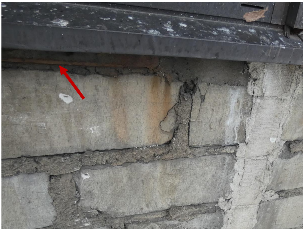
Fot. 8 Przykład zbrojenia podlewki zwieńczenia ściany pod profilem stalowym
