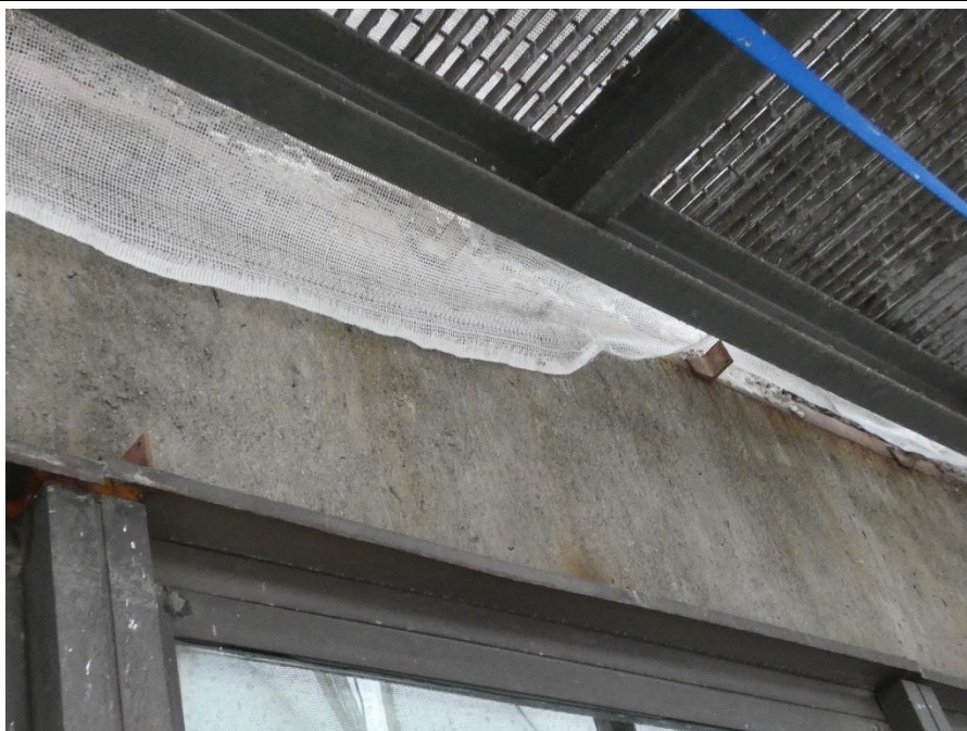
Fot. 81 Kondygnacja 14 (Poziom +51.60) Elewacja Zachodnia – belka w osiach 10/H-I. Brak widocznych uszkodzeń belki w przęśle
