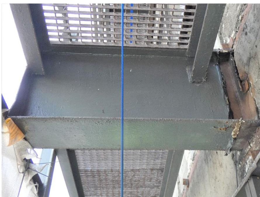
Fot. 147, 148 Kondygnacja 14 (Poziom +51.60) Elewacja Południowa– wspornik w osiach 12/E. Brak widocznych uszkodzeń wspornika.
