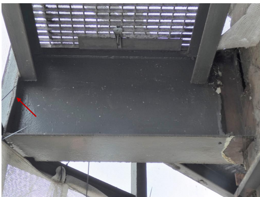
Fot. 133, 134 Kondygnacja 14 (Poziom +51.60) Elewacja Zachodnia– wspornik w osiach 10/I. Mechaniczne uszkodzenie żeberka usztywniającego.
