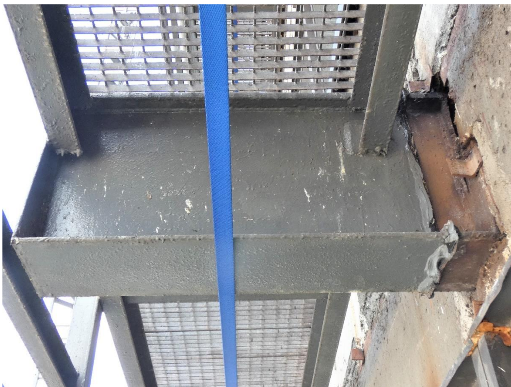
Fot. 110 Wspornik stalowy (widok z boku)
