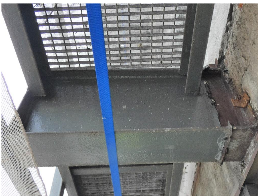
Fot. 135, 136 Kondygnacja 14 (Poziom +51.60) Elewacja Zachodnia– wspornik w osiach 10/H (widok z dołu) Przemieszczenie wspornika w kierunku osi G. Brak widocznych uszkodzeń wspornika.
