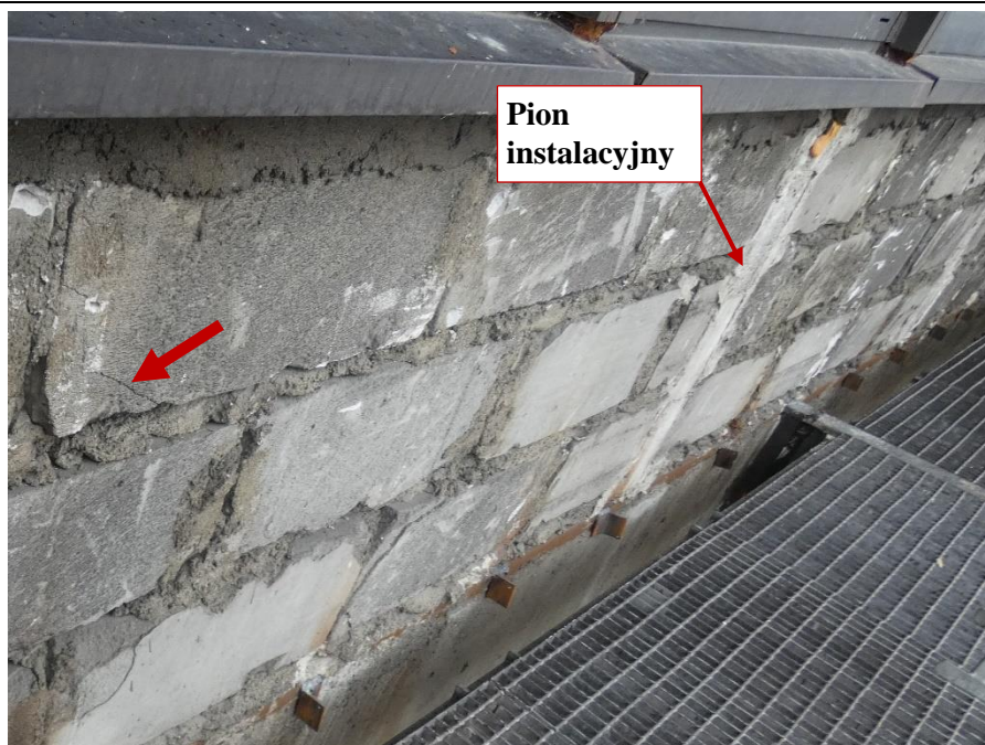
Fot. 21 Kondygnacja 14 (Poziom +51.60) Elewacja Północna – widok ściany murowanej w osiach 13-14/I. Zbyt duże wymiary spoin. Zarysowania elementów murowych. Zamknięcie pionu instalacyjnego.
