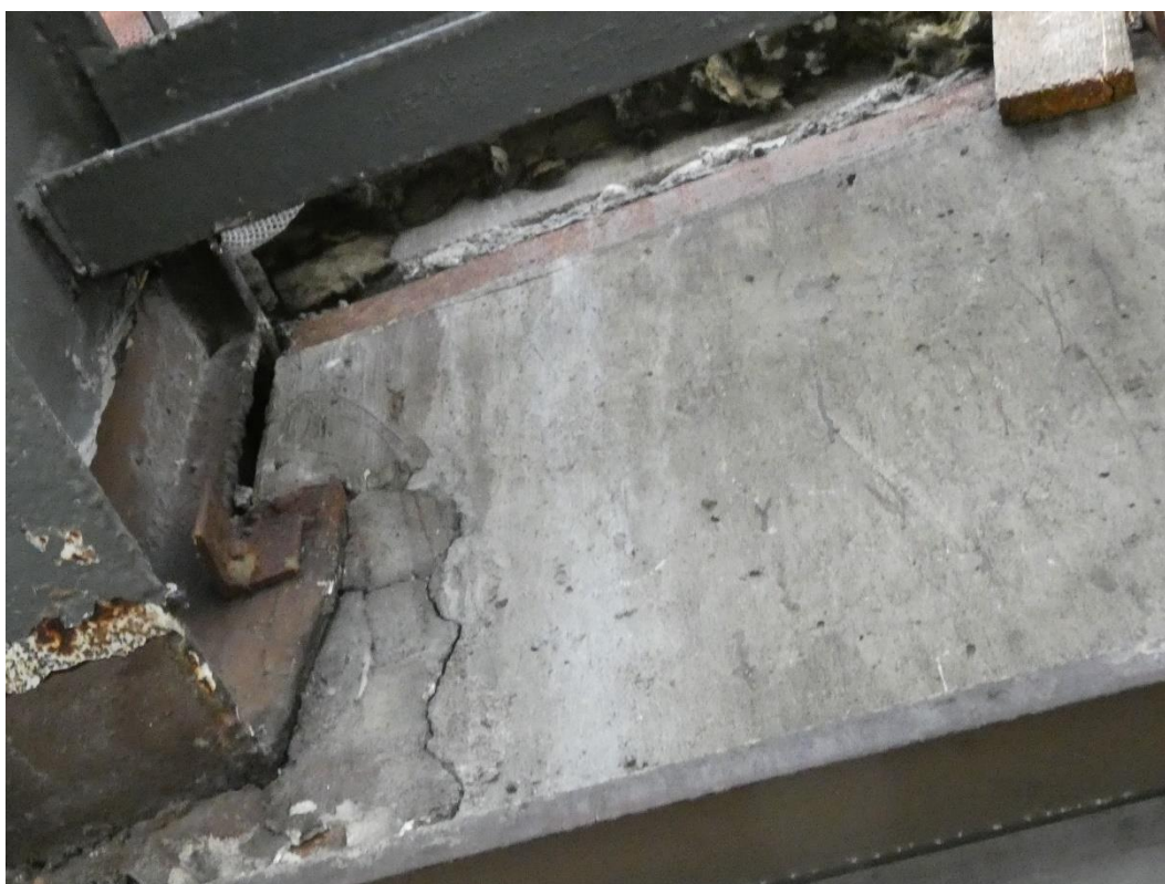
Fot. 109 Wspornik stalowy w miejscu oparcia belek żelbetowych (widok z dołu)
