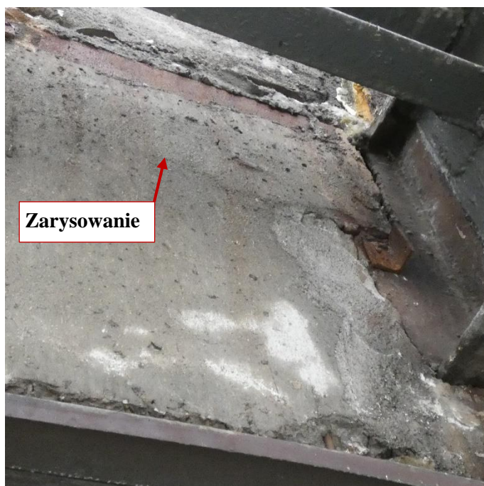
Fot. 60 Kondygnacja 14 (Poziom +51.60) Elewacja Wschodnia – belka w osiach 14/E-F. Zarysowanie belki na wysokości miejsca oparcia. Zarysowania powierzchni zaprawy.
