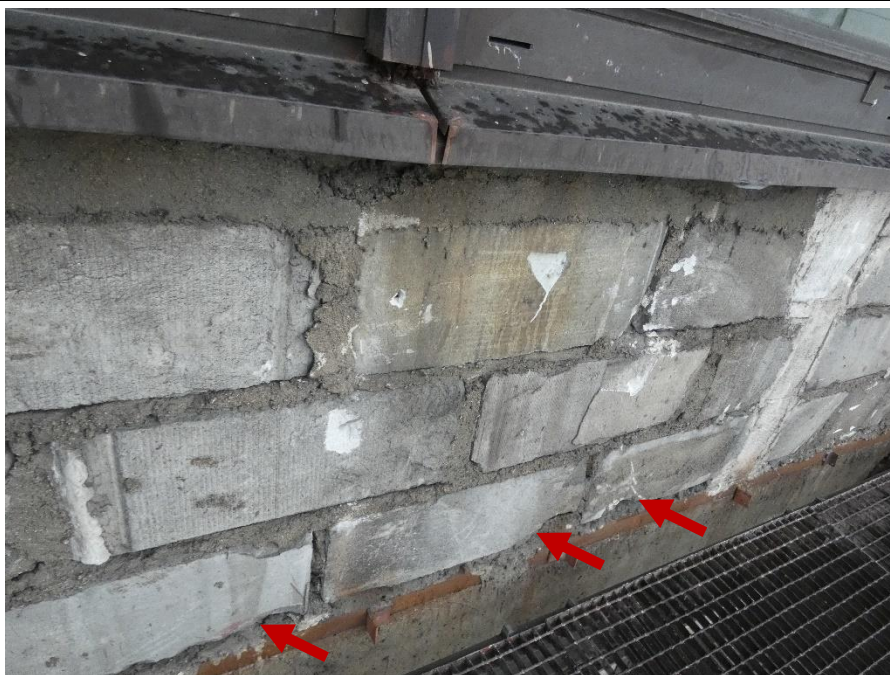
Fot. 49 Kondygnacja 14 (Poziom +51.60) Elewacja Południowa – widok ściany murowanej w osiach 11-12/E. Zbyt duże wymiary spoin. Wykonanie ściany z uszkodzonych elementów murowych. Wypełnienie ubytków między elementami i uszkodzonych miejsc zaprawą.
