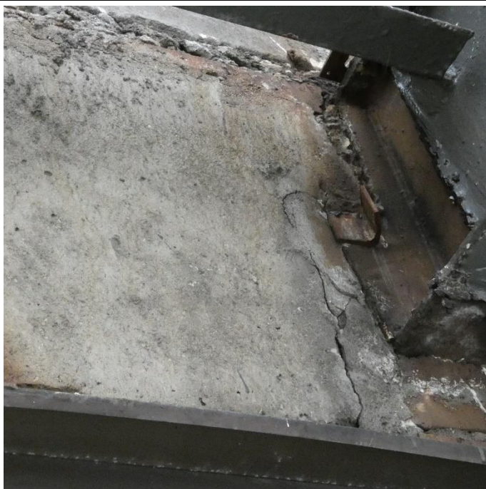
Fot. 89 Kondygnacja 14 (Poziom +51.60) Elewacja Zachodnia – belka w osiach 10/F-G. Spękania i zarysowania powierzchni zaprawy. Brak widocznych uszkodzeń belki przy podporze.
