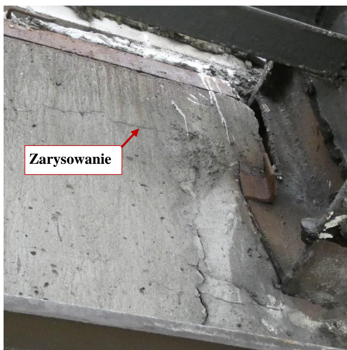
Fot. 103 Kondygnacja 14 (Poziom +51.60) Elewacja Południowa – belka w osiach 12-13/E. Zarysowanie belki na wysokości miejsca oparcia. Zarysowania powierzchni zaprawy.
