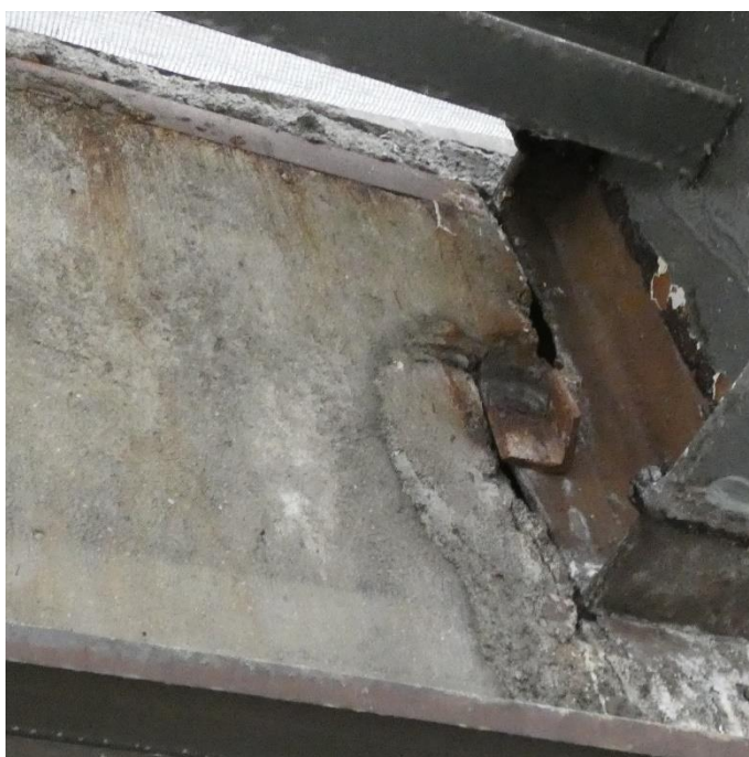
Fot. 82 Kondygnacja 14 (Poziom +51.60) Elewacja Zachodnia – belka w osiach 10/H-I. Zarysowania powierzchni zaprawy. Brak widocznych uszkodzeń belki przy podporze.
