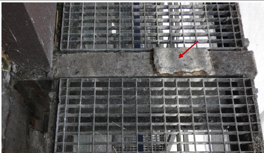
Fot. 116 Kondygnacja 14 (Poziom +51.60) Elewacja Wschodnia – wspornik w osiach 14/F (widok z góry) Pozostałości po usuniętej drabinie ewakuacyjnej.
