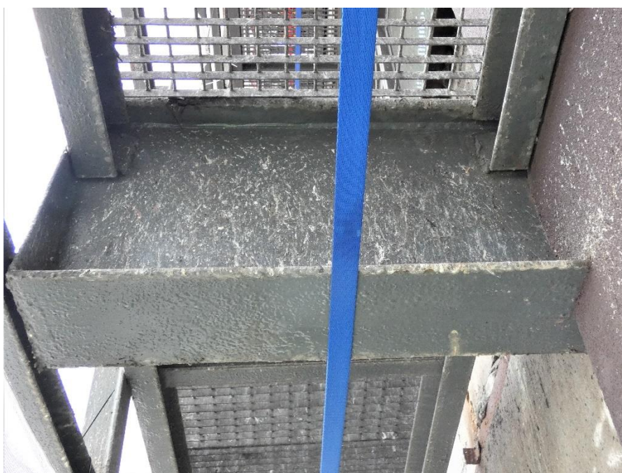
Fot. 114, 115 Kondygnacja 14 (Poziom +51.60) Elewacja Wschodnia – wspornik w osiach 14/F (widok z dołu) Brak widocznych uszkodzeń wspornika.
