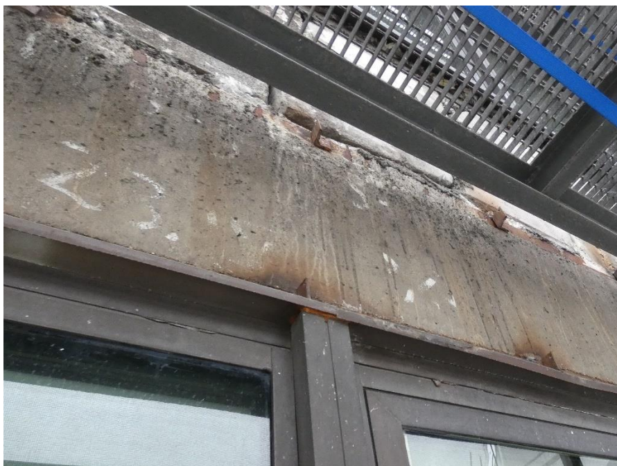
Fot. 59 Kondygnacja 14 (Poziom +51.60) Elewacja Wschodnia – belka w osiach 14/E-F.
