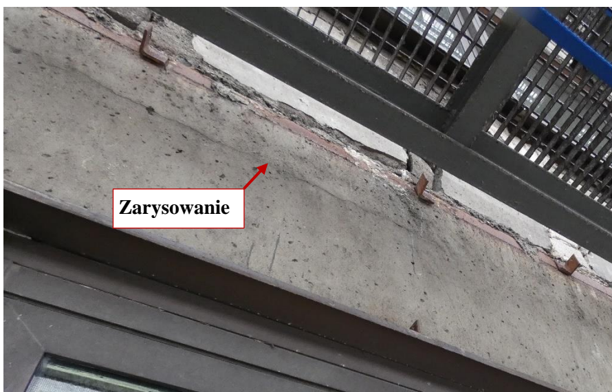
Fot. 99 Kondygnacja 14 (Poziom +51.60) Elewacja Południowa – belka w osiach 11-12/E. Zarysowanie belki w przęśle na wysokości miejsca oparcia.
