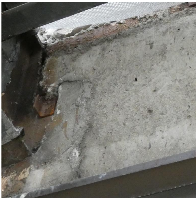
Fot. 86 Kondygnacja 14 (Poziom +51.60) Elewacja Zachodnia – belka w osiach 10/F-G. Zarysowania i spękania powierzchni zaprawy. Brak widocznych uszkodzeń belki przy podporze.
