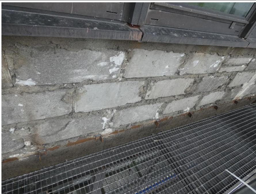
Fot. 23 Kondygnacja 14 (Poziom +51.60) Elewacja Północna – widok ściany murowanej w osiach 12-13/I. Zbyt duże wymiary spoin.
