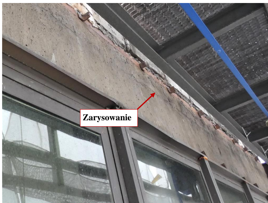
Fot. 105 Kondygnacja 14 (Poziom +51.60) Elewacja Południowa – belka w osiach 13-14/E.
