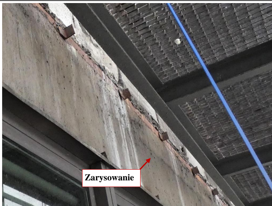
Fot. 102 Kondygnacja 14 (Poziom +51.60) Elewacja Południowa – belka w osiach 12-13/E. Zarysowanie belki w przęśle na wysokości miejsca oparcia.
