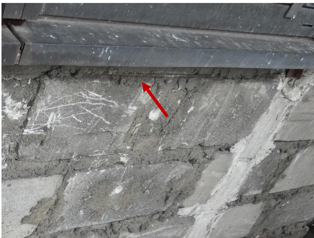
Fot. 9 Przykład zbrojenia podlewki zwieńczenia ściany pod profilem stalowym
