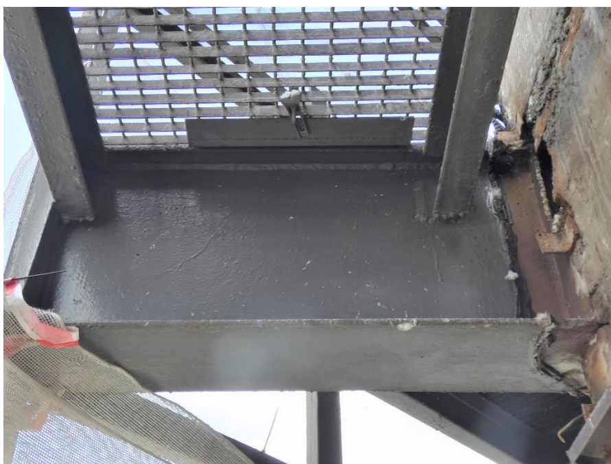
Fot. 123, 124 Kondygnacja 14 (Poziom +51.60) Elewacja Północna – wspornik w osiach 14/I. Brak widocznych uszkodzeń wspornika.
