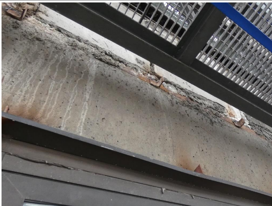
Fot. 67 Kondygnacja 14 (Poziom +51.60) Elewacja Północna – belka w osiach 13-14/I. Brak widocznych uszkodzeń w przęśle belki
