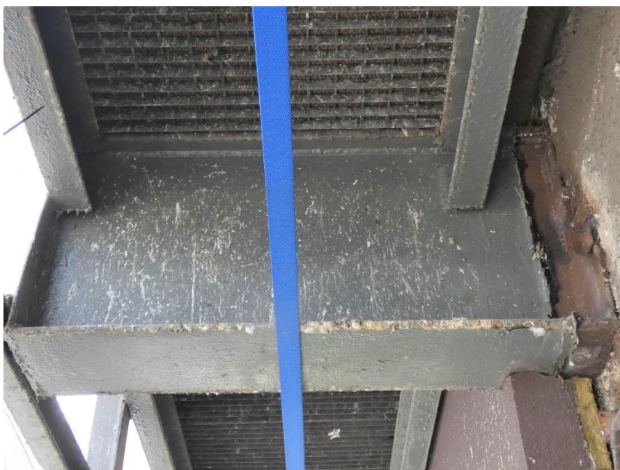
Fot. 119, 120 Kondygnacja 14 (Poziom +51.60) Elewacja Wschodnia – wspornik w osiach 14/H. Brak widocznych uszkodzeń wspornika.
