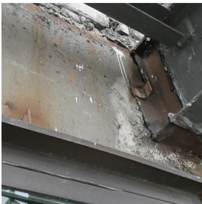
Fot. 68 Kondygnacja 14 (Poziom +51.60) Elewacja Północna – belka w osiach 13-14/I. Zarysowania powierzchni zaprawy. Brak widocznych uszkodzeń belki przy podporze.
