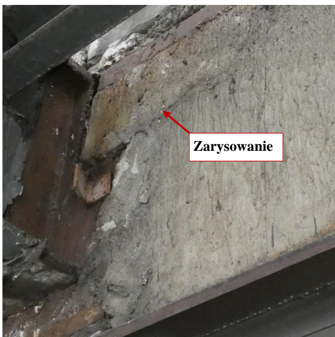
Fot. 90 Kondygnacja 14 (Poziom +51.60) Elewacja Zachodnia – belka w osiach 10/E-F. Zarysowanie belki na wysokości miejsca oparcia. Zarysowania powierzchni zaprawy.
