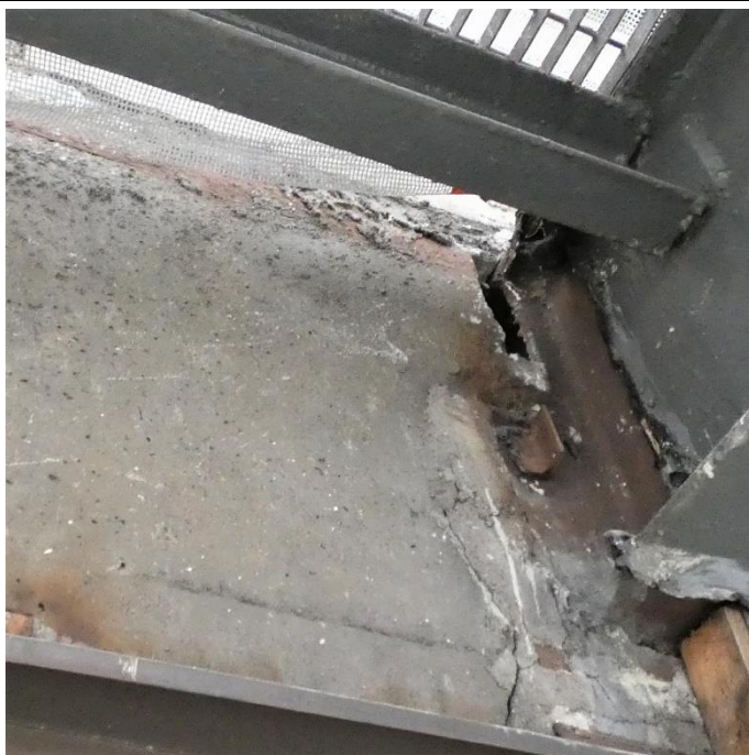
Fot. 75 Kondygnacja 14 (Poziom +51.60) Elewacja Północna – belka w osiach 11-12/I. Zarysowania powierzchni zaprawy. Zalegający gruz w przestrzeni między elementami. Brak widocznych uszkodzeń belki przy podporze.
