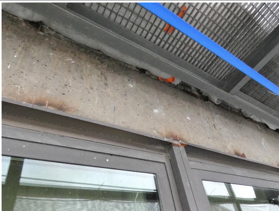
Fot. 71 Kondygnacja 14 (Poziom +51.60) Elewacja Północna – belka w osiach 12-13/I. Brak widocznych uszkodzeń belki w przeszle.
