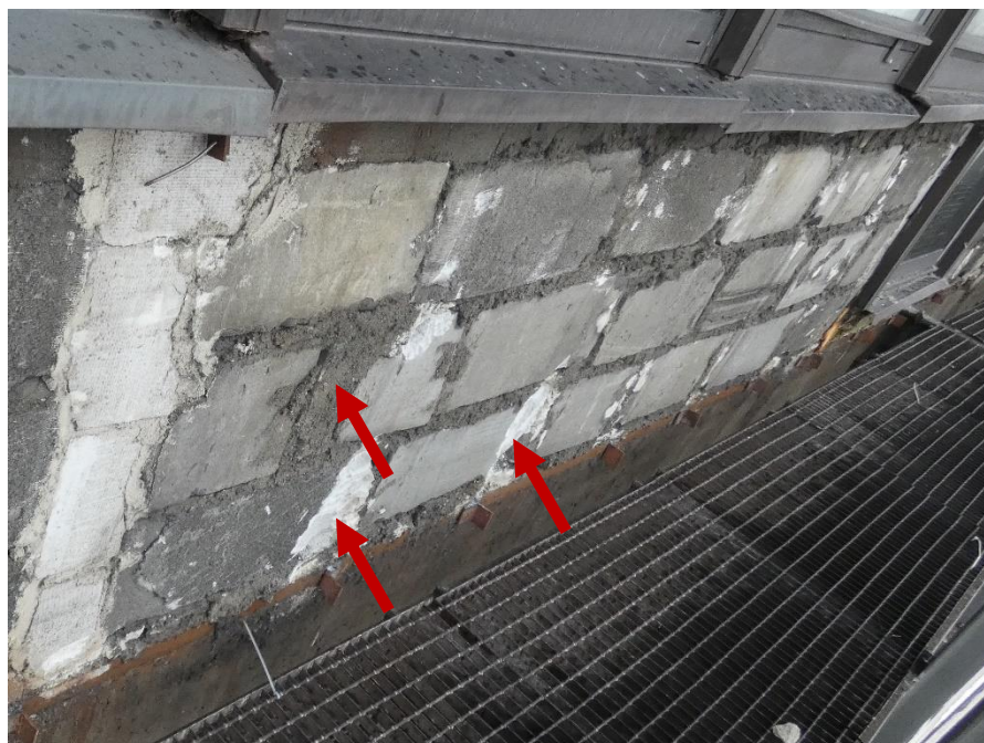
Fot. 52 Kondygnacja 14 (Poziom +51.60) Elewacja Południowa – widok ściany murowanej w osiach 12-13/E. Zbyt duże wymiary spoin. Wykonanie ściany z uszkodzonych elementów murowych. Wypełnienie ubytków między elementami i uszkodzonych miejsc zaprawą i gruzem.
