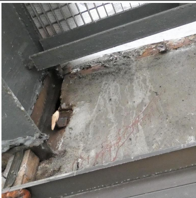
Fot. 73 Kondygnacja 14 (Poziom +51.60) Elewacja Północna – belka w osiach 11-12/I. Zarysowania i spękania powierzchni zaprawy. Brak widocznych uszkodzeń belki przy podporze.
