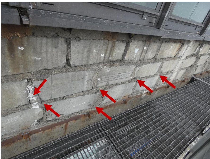
Fot. 37 Kondygnacja 14 (Poziom +51.60) Elewacja Zachodnia – widok ściany murowanej w osiach 10/G-H. Zbyt duże wymiary spoin. Niewłaściwe przewiązanie elementów. Wykonanie ściany z uszkodzonych elementów murowych. Wypełnienie ubytków między elementami i uszkodzonych miejsc zaprawą i gruzem.
