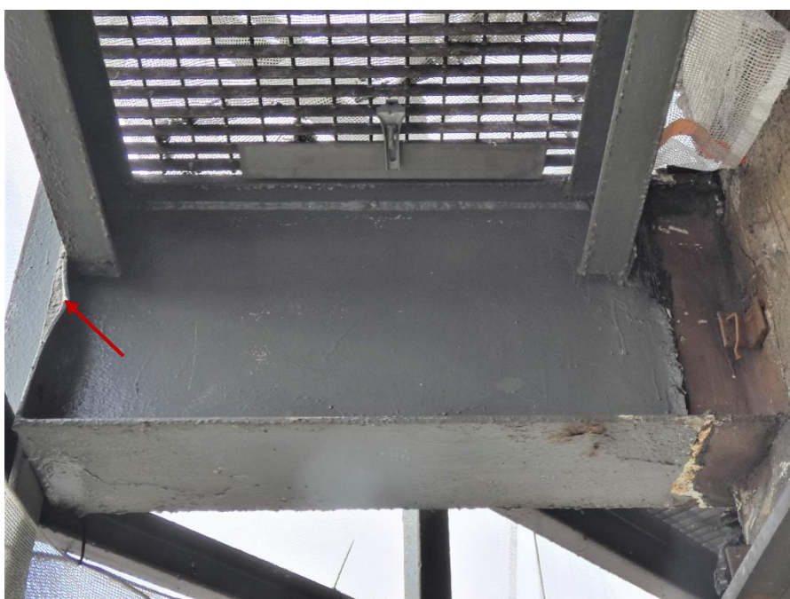
Fot. 143, 144 Kondygnacja 14 (Poziom +51.60) Elewacja Południowa– wspornik w osiach 10/E. Mechaniczne uszkodzenie żeberka usztywniającego.
