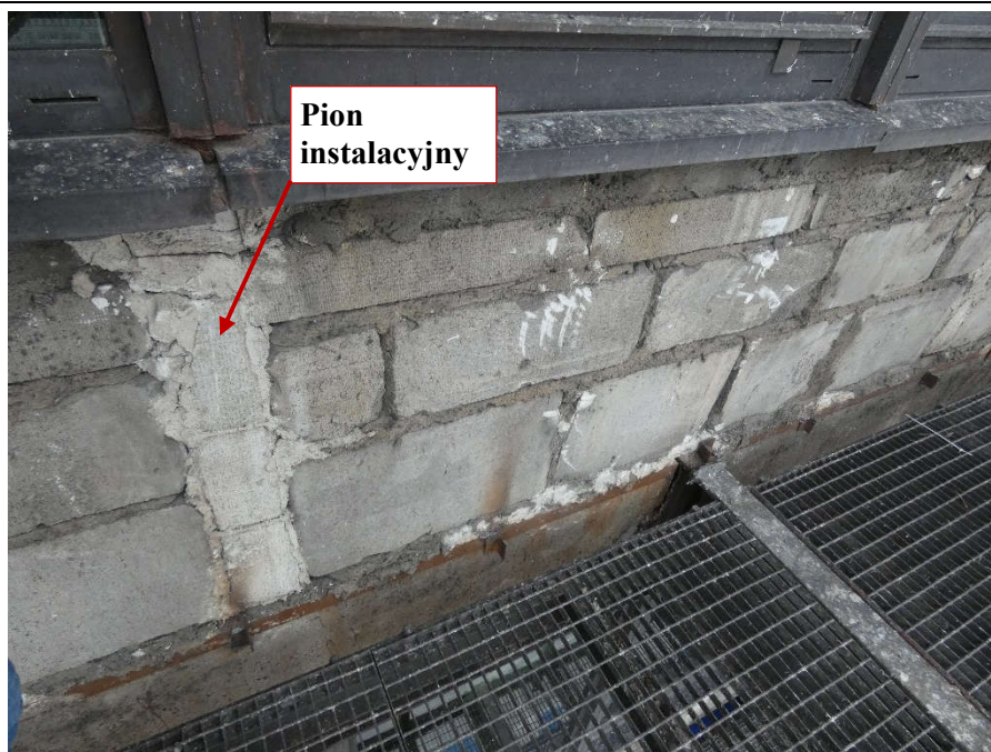
Fot. 29 Kondygnacja 13 (Poziom +48.30) Elewacja Północna – widok ściany murowanej w osiach 12-13/I. Zbyt duże wymiary spoin. Wykonanie ściany z uszkodzonych elementów murowych o zróżnicowanych kształtach. Zwieńczenie ściany podlewką. Zamknięcie pionu instalacyjnego.
