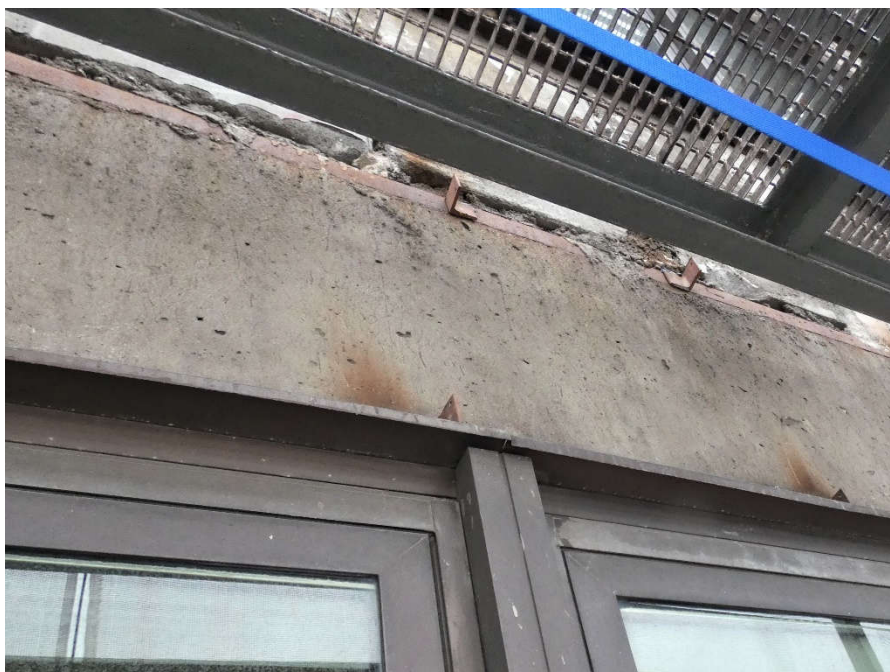
Fot. 102 Kondygnacja 13 (Poziom +48.30) Elewacja Południowa – belka w osiach 11-12/E. Brak widocznych uszkodzeń belki w przęśle
