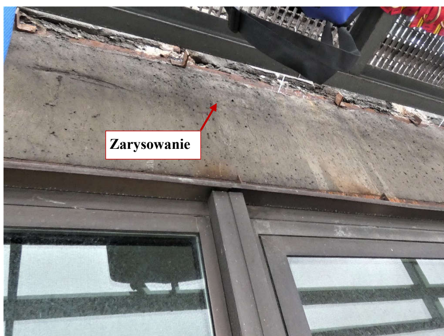
Fot. 108 Kondygnacja 13 (Poziom +48.30) Elewacja Południowa – belka w osiach 13-14/E. Zarysowanie belki w przęśle na wysokości miejsca oparcia.
