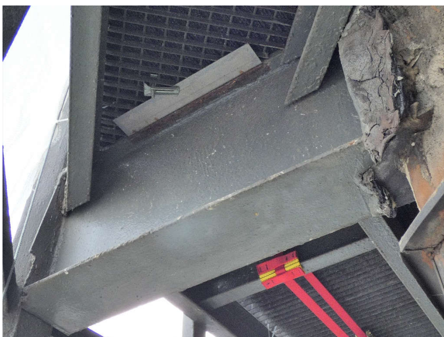
Fot. 125, 126 Kondygnacja 13 (Poziom +48.30) Elewacja Wschodnia – wspornik w osiach 14/I. Brak widocznych uszkodzeń wspornika.
