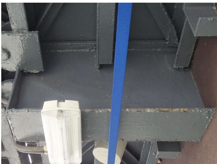
Fot. 121, 122 Kondygnacja 13 (Poziom +48.30) Elewacja Wschodnia – wspornik w osiach 14/G. Brak widocznych uszkodzeń wspornika.
