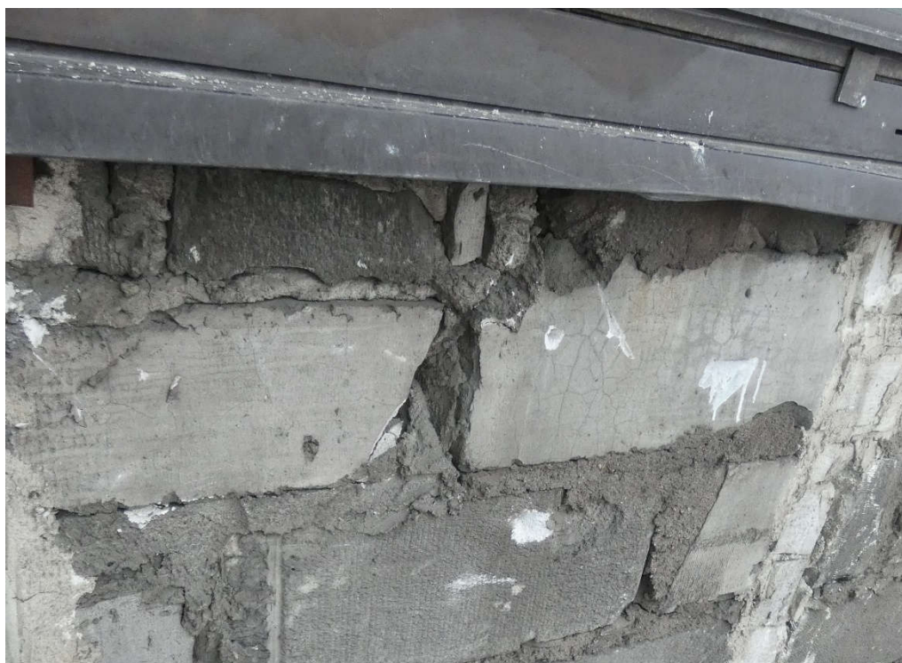
Fot. 10 Przykład zwieńczenia ściany podlewką i gruzem.
