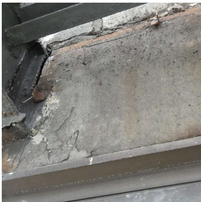
Fot. 62 Kondygnacja 13 (Poziom +48.30) Elewacja Wschodnia – belka w osiach 14/E-F. Spękania i zarysowania powierzchni zaprawy. Brak widocznych uszkodzeń belki przy podporze.
