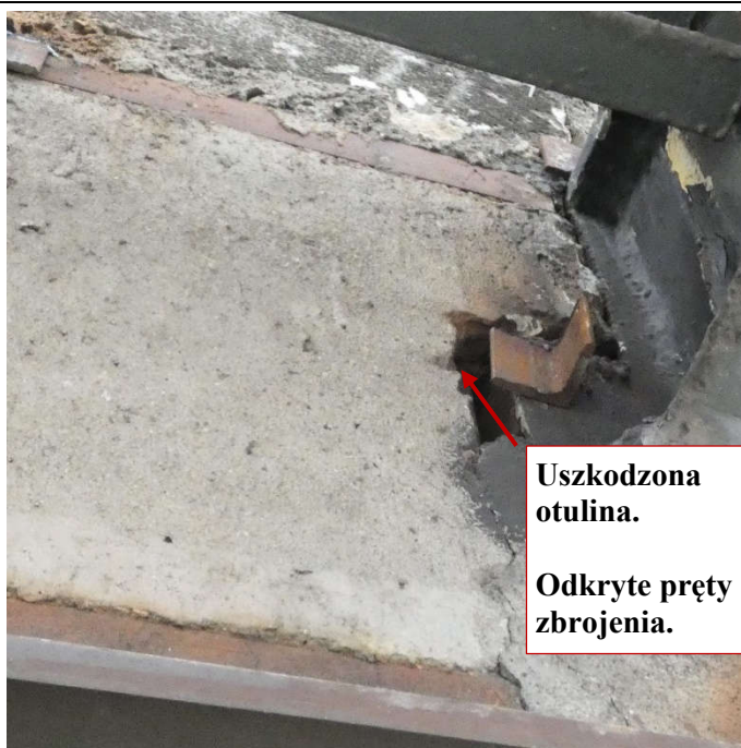
Fot. 80 Kondygnacja 13 (Poziom +48.30) Elewacja Północna – belka w osiach 10-11/I. Uszkodzona otulina. Odkryte pręty zbrojeniowe. Spękania i zarysowania powierzchni zaprawy.
