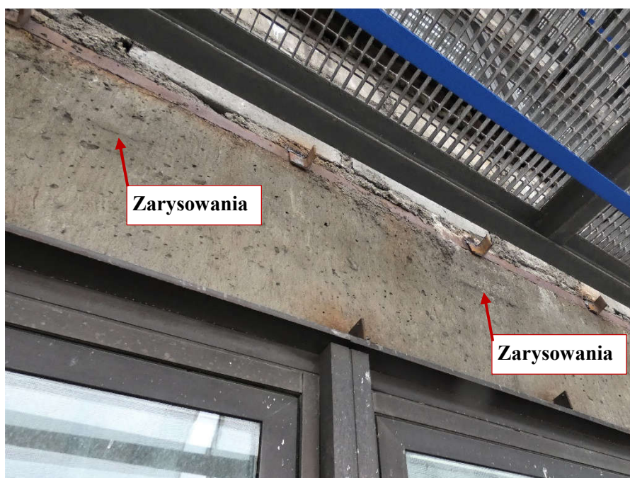
Fot. 87 Kondygnacja 13 (Poziom +48.30) Elewacja Zachodnia – belka w osiach 10/G-H. Zarysowanie belki w przęśle na wysokości miejsca oparcia.
