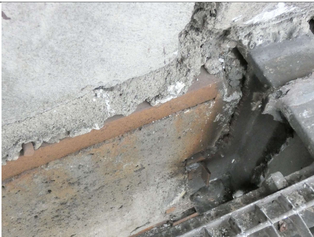
Fot. 111 Wspornik stalowy w miejscu oparcia belek żelbetowych (widok z góry)
