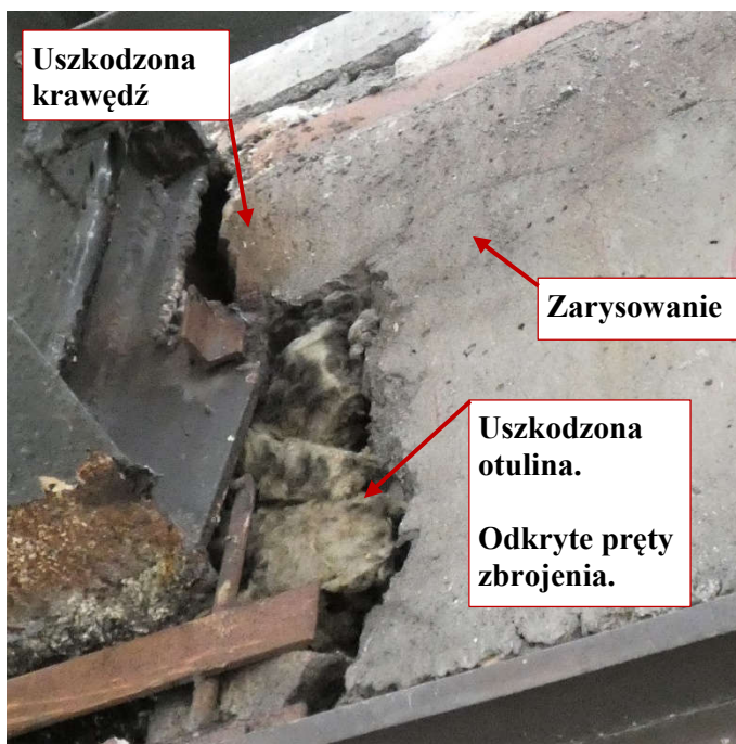
Fot. 104 Kondygnacja 13 (Poziom +48.30) Elewacja Południowa – belka w osiach 12-13/E.
