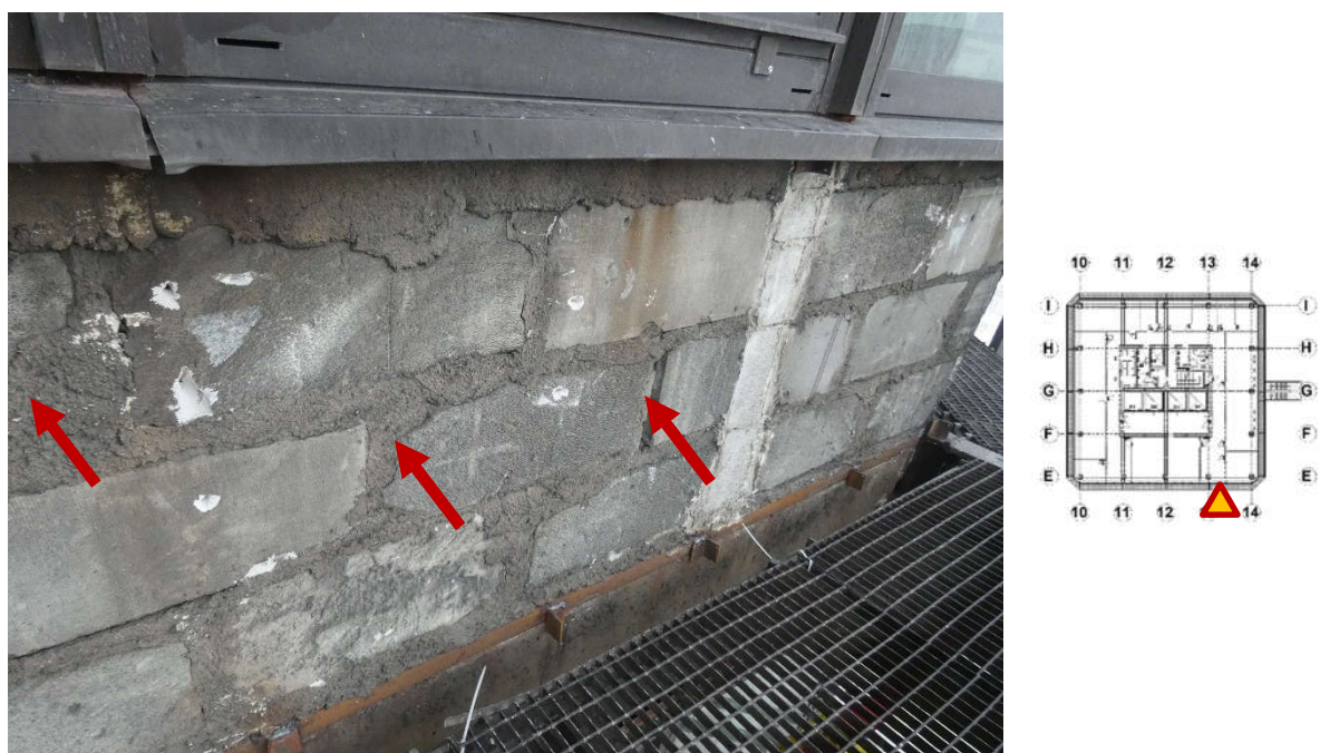
Fot. 60 Kondygnacja 13 (Poziom +48.30) Elewacja Południowa – widok ściany murowanej w osiach 13-14/E.
