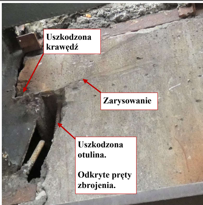
Fot. 101 Kondygnacja 13 (Poziom +48.30) Elewacja Południowa – belka w osiach 11-12/E. Uszkodzona otulina. Odkryte pręty zbrojeniowe. Zarysowanie belki na wysokości miejsca oparcia. Znaczne uszkodzenia i ubytki podlewki wspornika stalowego.
