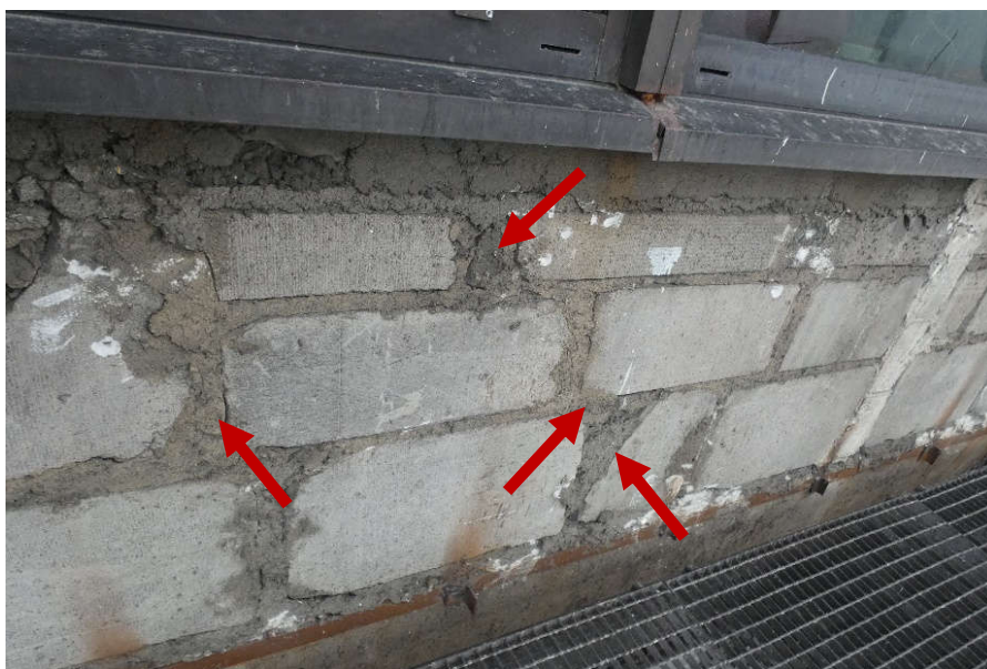
Fot. 28 Kondygnacja 13 (Poziom +48.30) Elewacja Północna – widok ściany murowanej w osiach 12-13/I. Zbyt duże wymiary spoin. Niewłaściwe przewiązanie elementów. Wykonanie ściany z uszkodzonych elementów murowych o zróżnicowanych kształtach (12x60, 24x60, 36x60 cm). Zwieńczenie ściany podlewką. Wypełnienie ubytków między elementami zaprawą.
