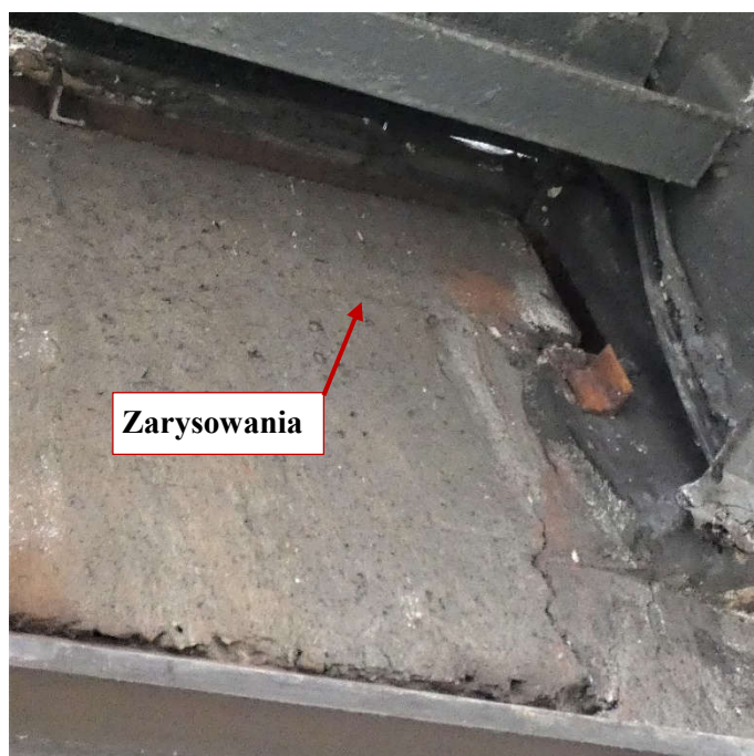
Fot. 67 Kondygnacja 13 (Poziom +48.30) Elewacja Wschodnia – belka w osiach 14/H-I. Zarysowanie belki na wysokości miejsca oparcia. Spękania i zarysowania powierzchni zaprawy.
