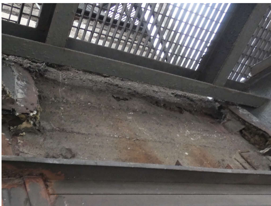
Fot. 110 Kondygnacja 13 (Poziom +48.30) Elewacja Południowa – belka w osiach 14/E. Brak możliwości pomiaru głębokości oparcia i określenia zastosowanych rozwiązań konstrukcyjnych. Brak widocznych uszkodzeń.
