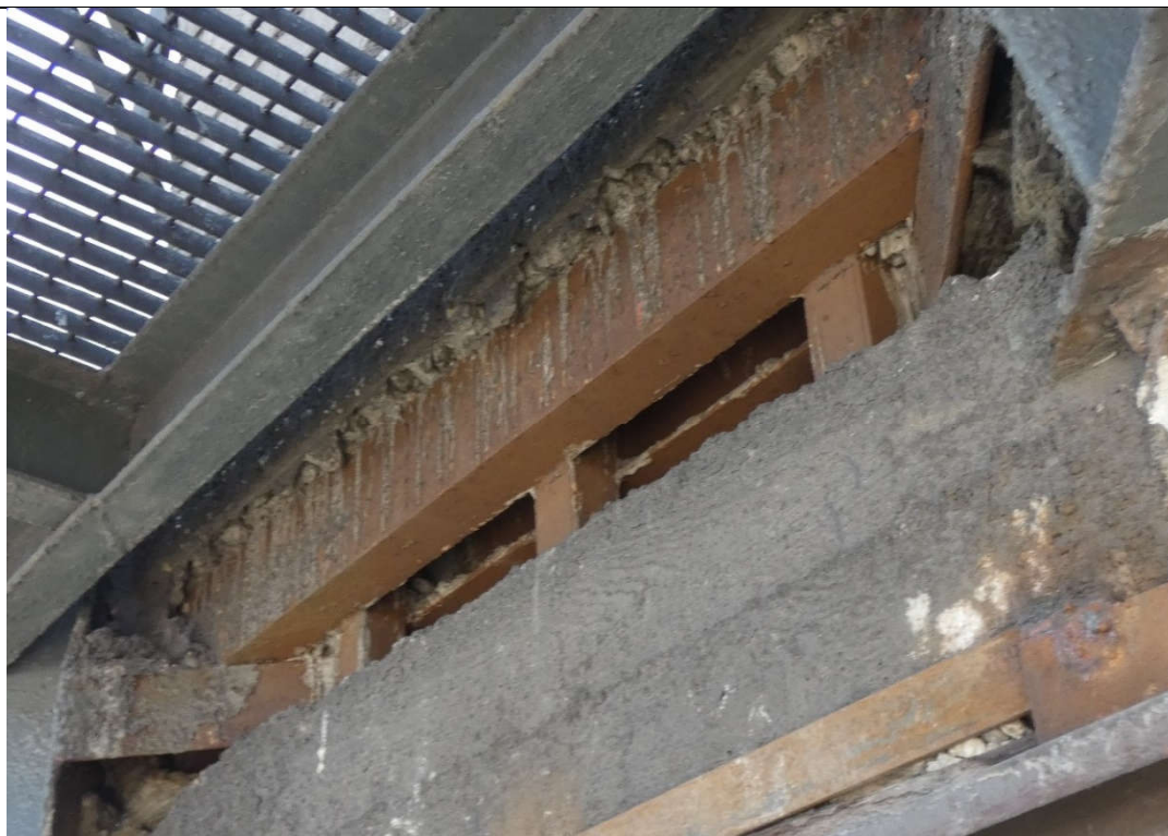
Fot. 158 Konstrukcja naroża nad kondygnacją 7
