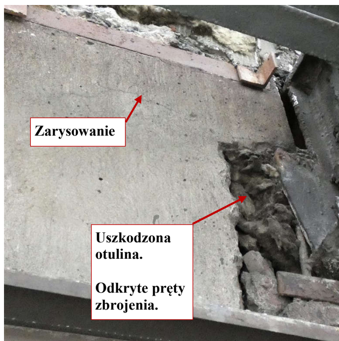
Fot. 106 Kondygnacja 13 (Poziom +48.30) Elewacja Południowa – belka w osiach 12-13/E. Uszkodzona otulina. Odkryte pręty zbrojeniowe. Zarysowanie belki na wysokości miejsca oparcia. Znaczne uszkodzenia i ubytki podlewki wspornika stalowego. Przestrzeń między elementami wypełniona odpadami wełny mineralnej i gruzem
