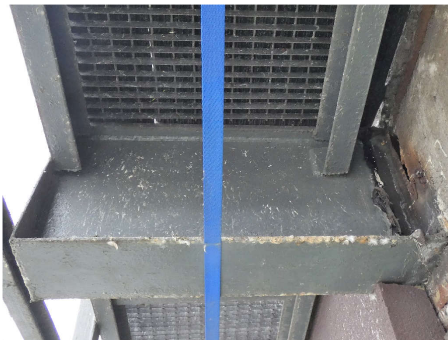
Fot. 123, 124 Kondygnacja 13 (Poziom +48.30) Elewacja Wschodnia – wspornik w osiach 14/H. Brak widocznych uszkodzeń wspornika.
