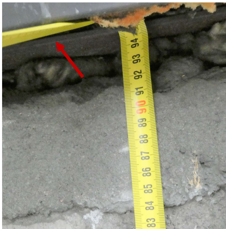
Fot. 8 Widok zwieńczenia ściany z elementów z betonu komórkowego z podlewką wyrównującą gr. 8 cm pod profilem stalowym
