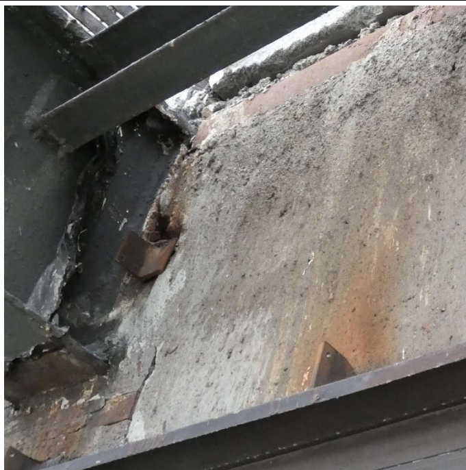
Fot. 72 Kondygnacja 13 (Poziom +48.30) Elewacja Północna – belka w osiach 12-13/I. Spękania i zarysowania powierzchni zaprawy. Brak widocznych uszkodzeń belki przy podporze.
