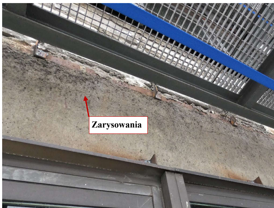
Fot. 73 Kondygnacja 13 (Poziom +48.30) Elewacja Północna – belka w osiach 12-13/I. Zarysowanie belki w przęśle na wysokości miejsca oparcia.
