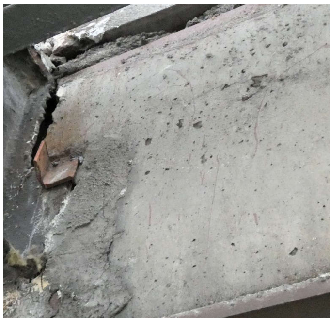
Fot. 107 Kondygnacja 13 (Poziom +48.30) Elewacja Południowa – belka w osiach 13-14/E. Spękania i zarysowania powierzchni zaprawy. Brak widocznych uszkodzeń belki przy podporze.
