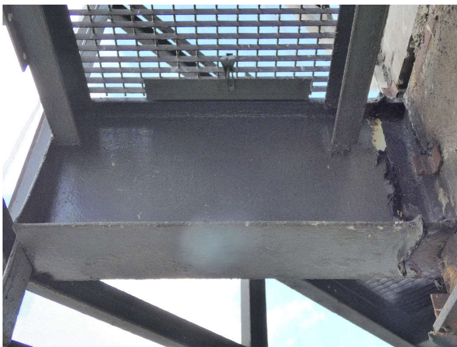
Fot. 127, 128 Kondygnacja 13 (Poziom +48.30) Elewacja Północna – wspornik w osiach 14/I. Brak widocznych uszkodzeń wspornika.
