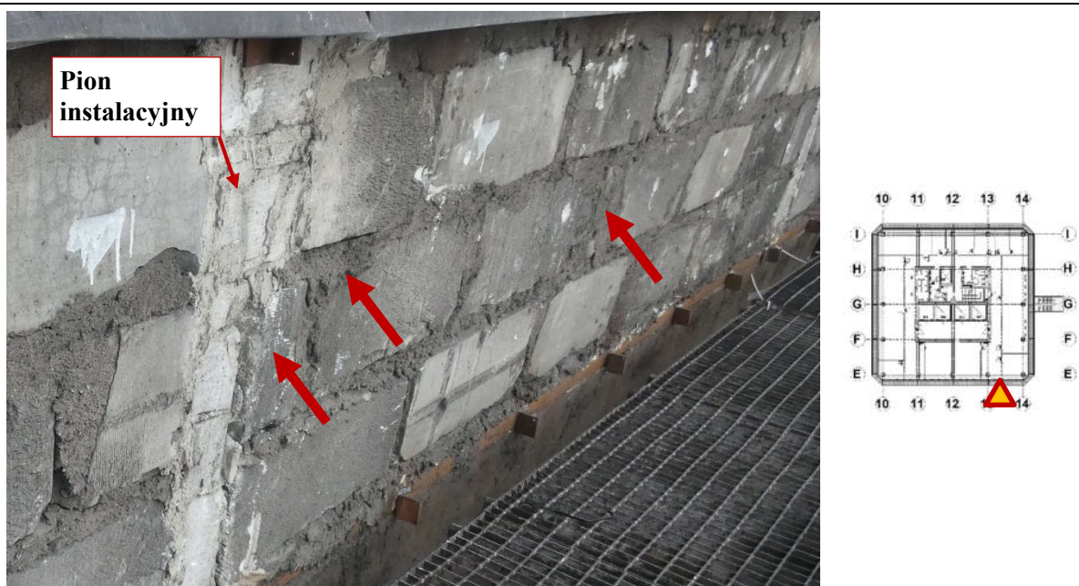
Fot. 59 Kondygnacja 13 (Poziom +48.30) Elewacja Południowa – widok ściany murowanej w osiach 13-14/E.
