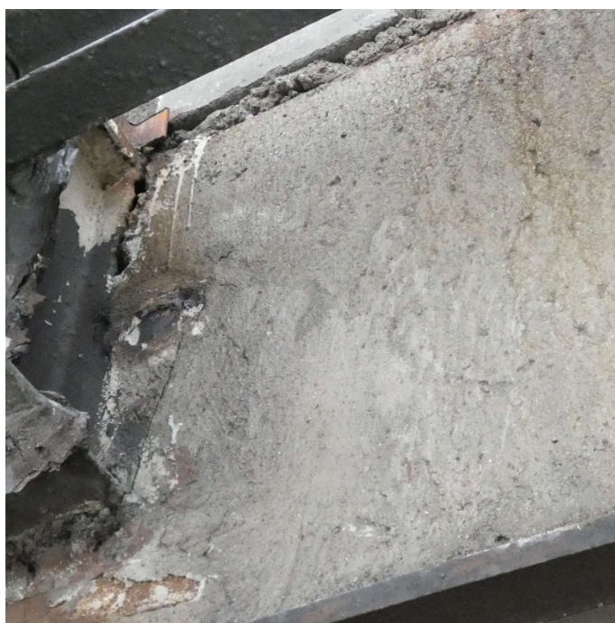
Fot. 93 Kondygnacja 13 (Poziom +48.30) Elewacja Zachodnia – belka w osiach 10/E-F. Brak widocznych uszkodzeń belki przy podporze.
