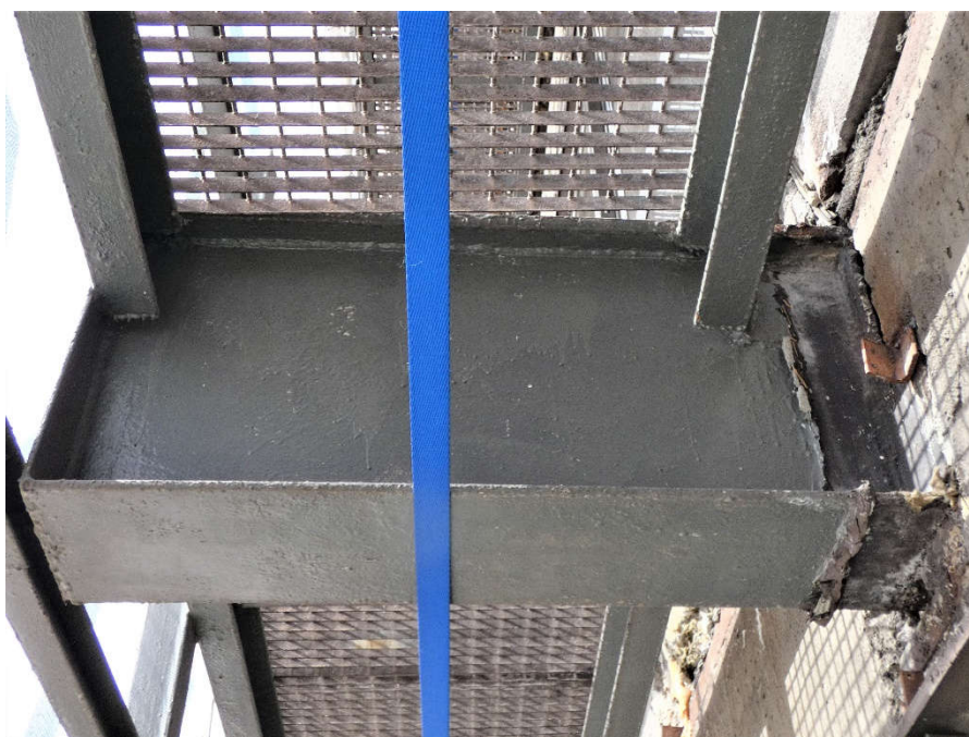
Fot. 153, 154 Kondygnacja 13 (Poziom +48.30) Elewacja Południowa– wspornik w osiach 13/E. Brak widocznych uszkodzeń wspornika.
