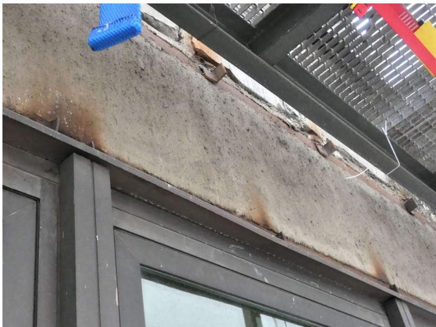
Fot. 79 Kondygnacja 13 (Poziom +48.30) Elewacja Północna – belka w osiach 10-11/I. Brak widocznych uszkodzeń belki w przęśle
