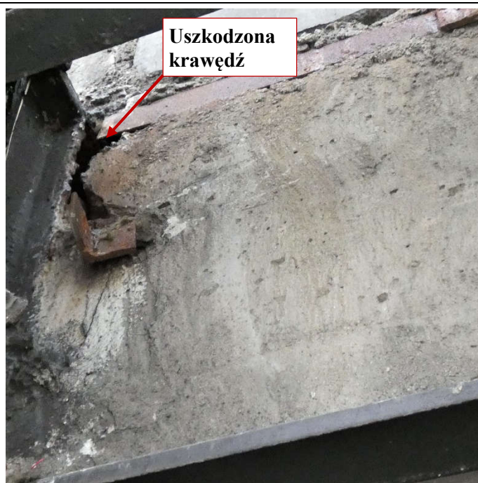
Fot. 86 Kondygnacja 13 (Poziom +48.30) Elewacja Zachodnia – belka w osiach 10/G-H. Uszkodzona krawędź elementu, brak widocznego zbrojenia. Spękania i zarysowania powierzchni zaprawy.
