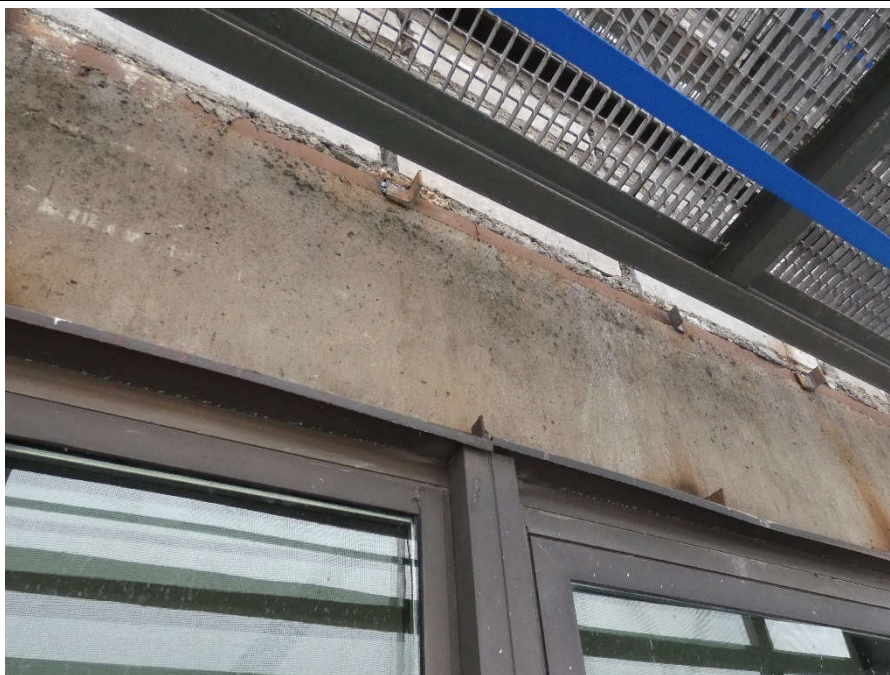
Fot. 76 Kondygnacja 13 (Poziom +48.30) Elewacja Północna – belka w osiach 11-12/I. Brak widocznych uszkodzeń belki w przęśle
