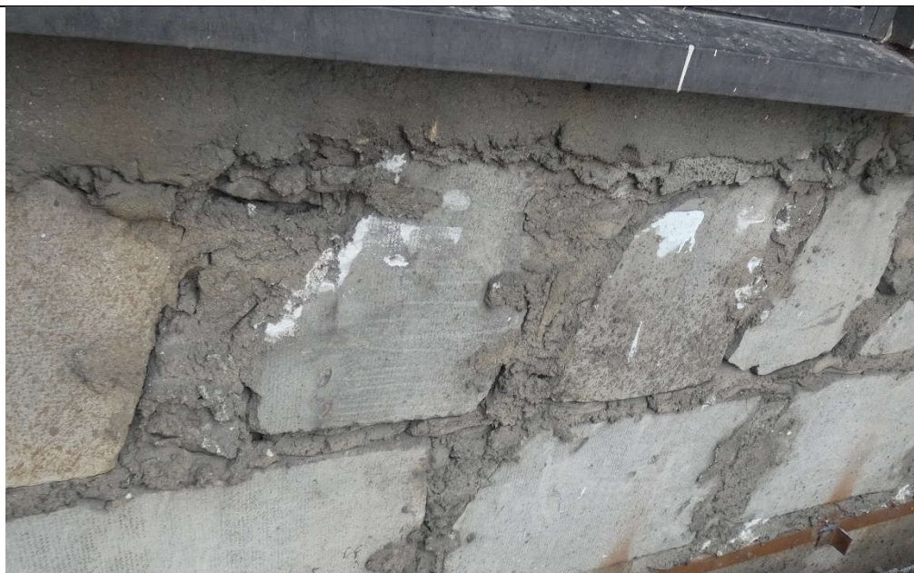
Fot. 11 Przykład zwieńczenia ściany podlewką.
