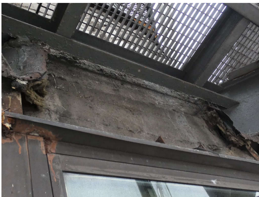
Fot. 81 Kondygnacja 13 (Poziom +48.30) Elewacja Północna – belka w osiach 10/I. Brak możliwości pomiaru głębokości oparcia i określenia zastosowanych rozwiązań konstrukcyjnych. Brak widocznych uszkodzeń.
