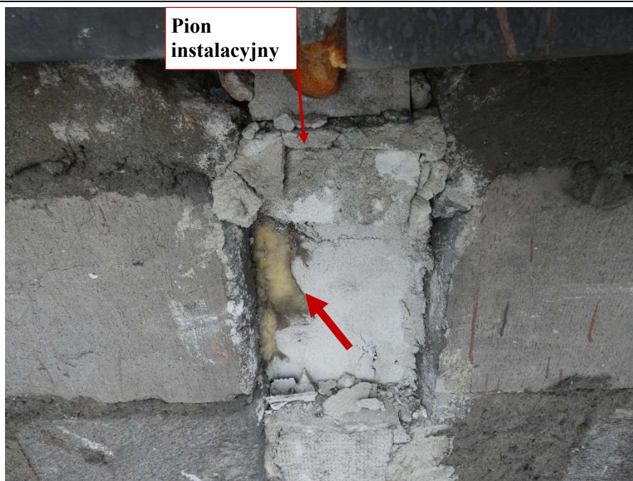
Fot. 21 Kondygnacja 13 (Poziom +48.30) Elewacja Wschodnia – widok ściany murowanej w osiach 14/H-I. Częściowe zamknięcie pionu instalacyjnego. Izolacja termiczna przykryta zaprawą.
