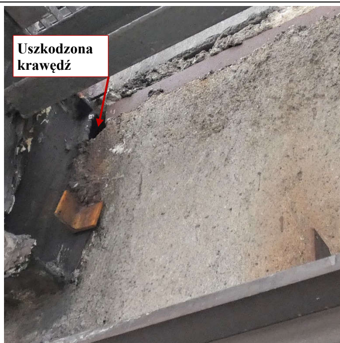
Fot. 82 Kondygnacja 13 (Poziom +48.30) Elewacja Zachodnia – belka w osiach 10/H-I. Drobne uszkodzenia krawędzi elementu. Zalegający gruz w przestrzeni między elementami. Zarysowania powierzchni zaprawy. Brak znaczących uszkodzeń belki przy podporze.
