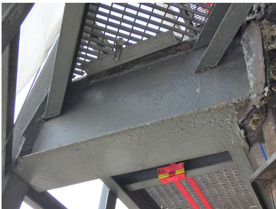
Fot. 156, 157 Kondygnacja 13 (Poziom +48.30) Elewacja Południowa– wspornik w osiach 14/E. Brak widocznych uszkodzeń wspornika.
