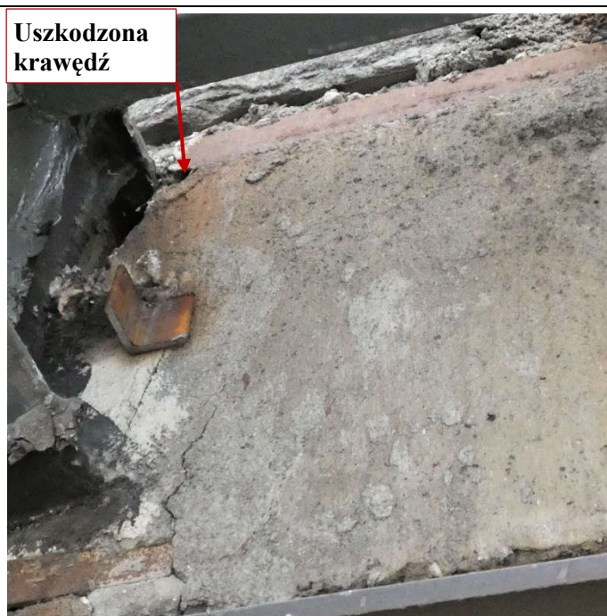
Fot. 78 Kondygnacja 13 (Poziom +48.30) Elewacja Północna – belka w osiach 10-11/I. Uszkodzona krawędź elementu, brak widocznego zbrojenia. Zalegający gruz w przestrzeni między elementami. Zarzysowania powierzchni zaprawy.
