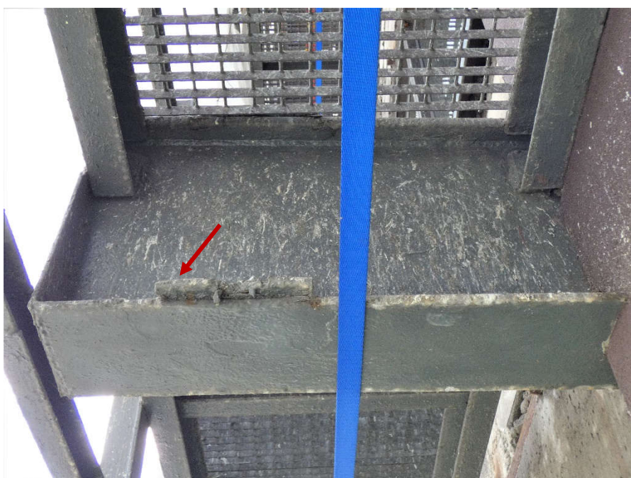
Fot. 118, 119 Kondygnacja 13 (Poziom +48.30) Elewacja Wschodnia – wspornik w osiach 14/F (widok z dołu) Pozostałości po usuniętej drabinie ewakuacyjnej. Brak widocznych uszkodzeń wspornika.
