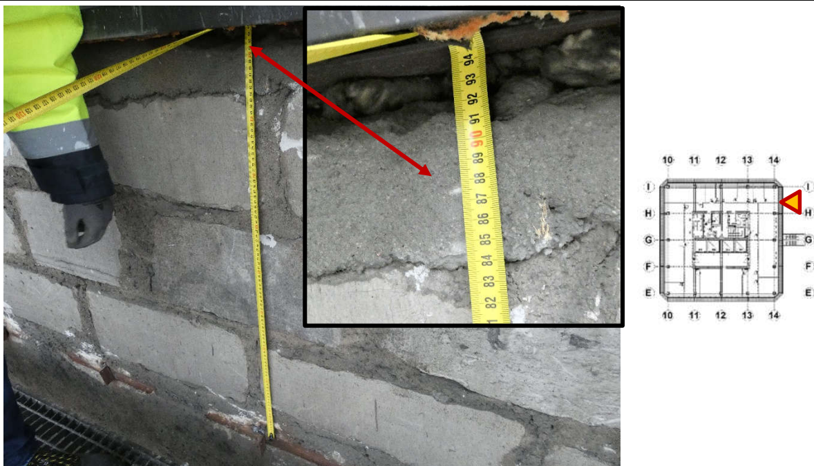
Fot. 19 Kondygnacja 13 (Poziom +48.30) Elewacja Północna – widok ściany murowanej w osiach 14/H-I. Wysokość ściany murowanej ~94 cm. Grubość podlewki między belką żelbetową a ścianą ~7 cm. Grubość podlewki między ścianą a profilem okiennym ~8 cm
