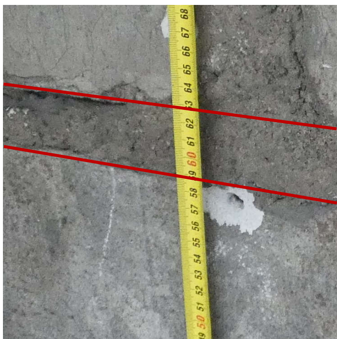
Fot. 1 Przykładowa spoina pozioma – grubość 4 cm
