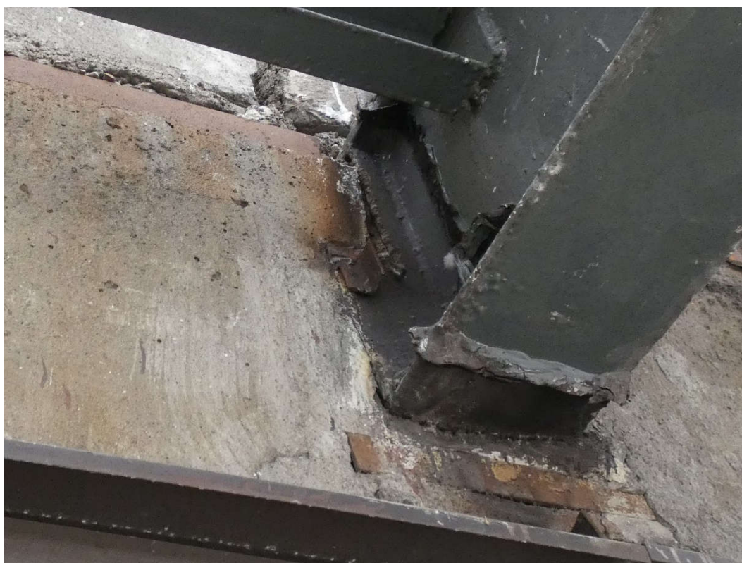
Fot. 112 Wspornik stalowy w miejscu oparcia belek żelbetowych (widok z dołu)
