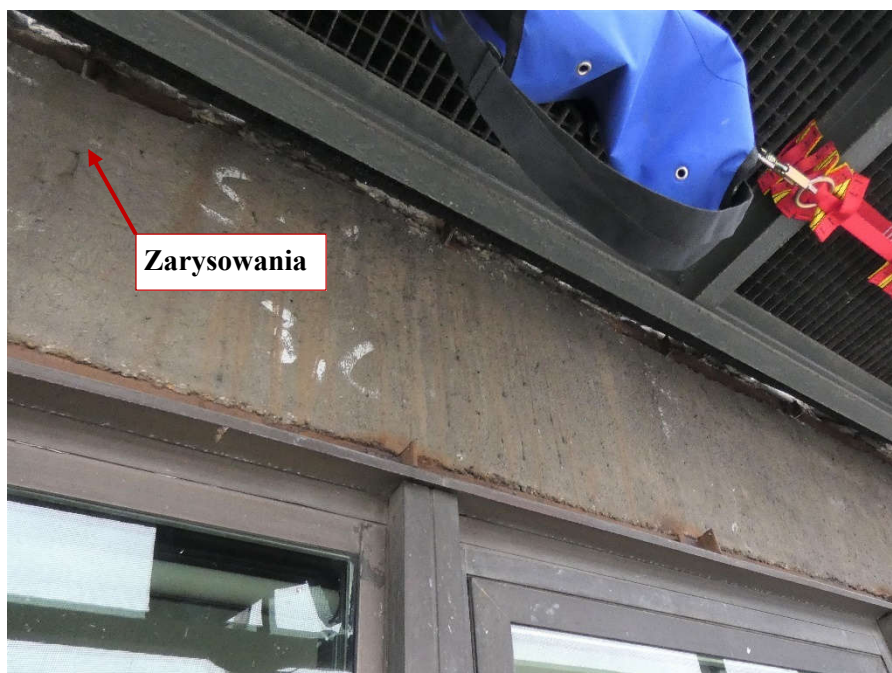
Fot. 66 Kondygnacja 13 (Poziom +48.30) Elewacja Wschodnia – belka w osiach 14/H-I. Zarysowanie belki w przęśle na wysokości miejsca oparcia.
