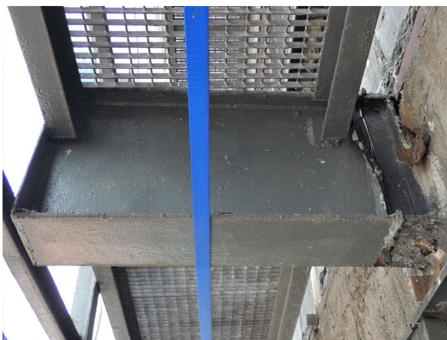
Fot. 138, 139 Kondygnacja 13 (Poziom +48.30) Elewacja Zachodnia– wspornik w osiach 10/H Przemieszczenie wspornika w kierunku osi G. Brak widocznych uszkodzeń wspornika.
