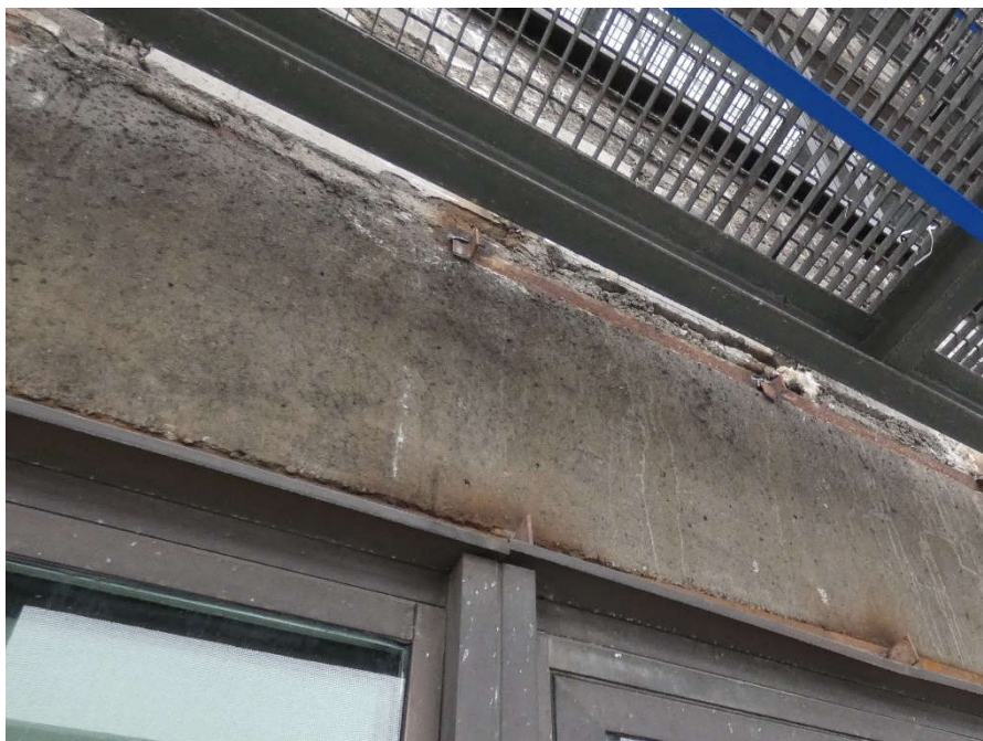
Fot. 63 Kondygnacja 13 (Poziom +48.30) Elewacja Wschodnia – belka w osiach 14/E-F. Brak widocznych uszkodzeń w przęśle belki
