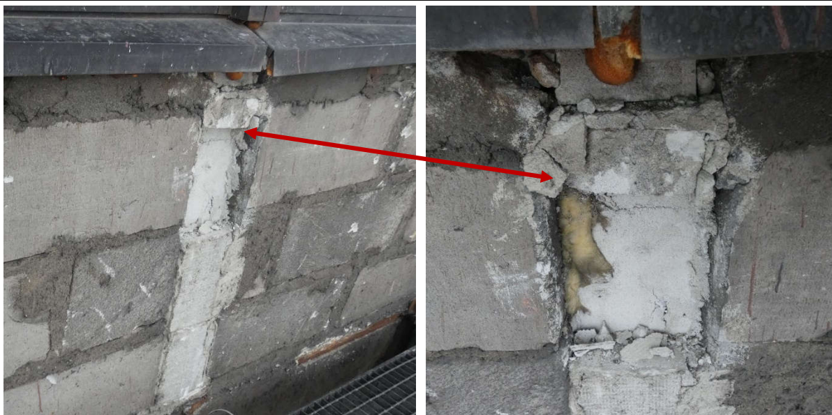
Fot. 12, 13 Widok pionu instalacyjnego częściowo zamkniętego elementami murowymi i zaprawą
