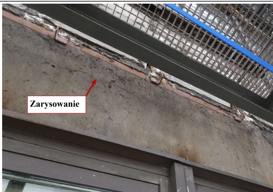
Fot. 105 Kondygnacja 13 (Poziom +48.30) Elewacja Południowa – belka w osiach 12-13/E. Zarysowanie belki w przęśle na wysokości miejsca oparcia.
