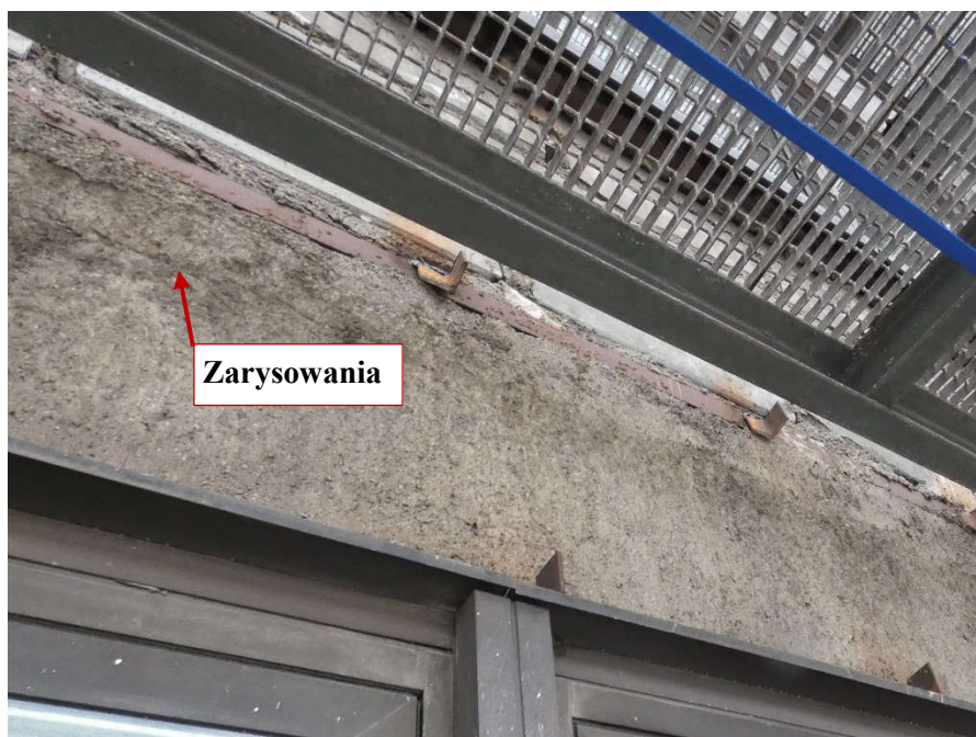
Fot. 83 Kondygnacja 13 (Poziom +48.30) Elewacja Zachodnia – belka w osiach 10/H-I. Zarysowanie belki w prześle na wysokości miejsca oparcia.
