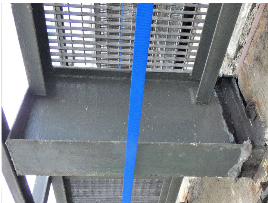
Fot. 131, 132 Kondygnacja 13 (Poziom +48.30) Elewacja Północna – wspornik w osiach 12/I. Brak widocznych uszkodzeń wspornika.
