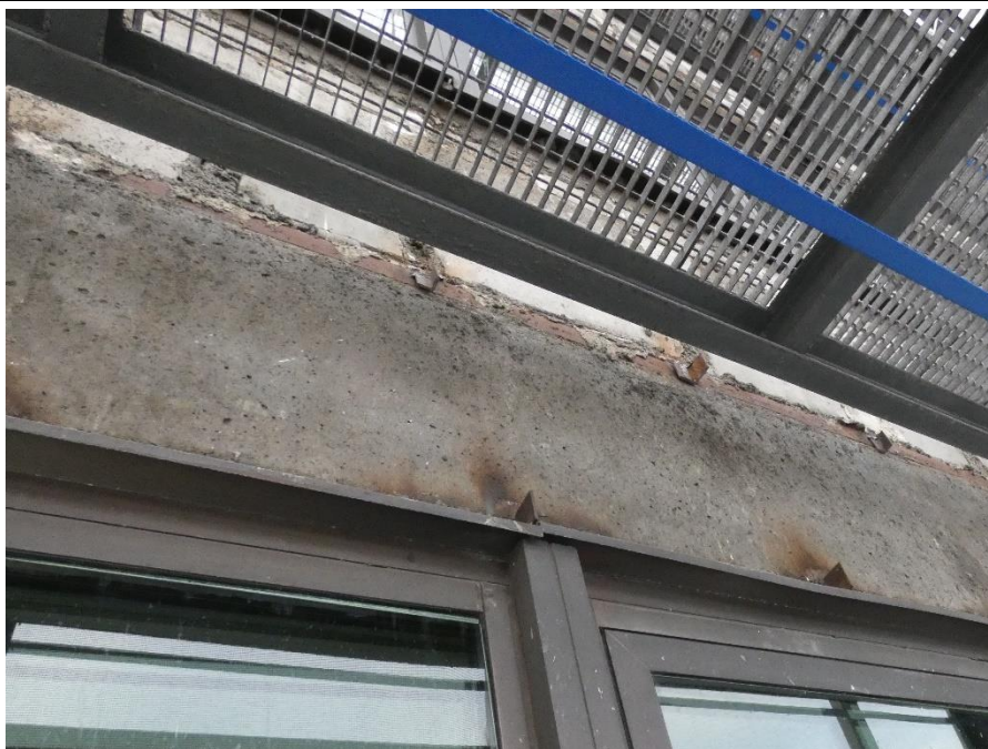
Fot. 67 Kondygnacja 12 (Poziom +45.00) Elewacja Północna – belka w osiach 11-12/I. Brak widocznych uszkodzeń belki w przęśle
