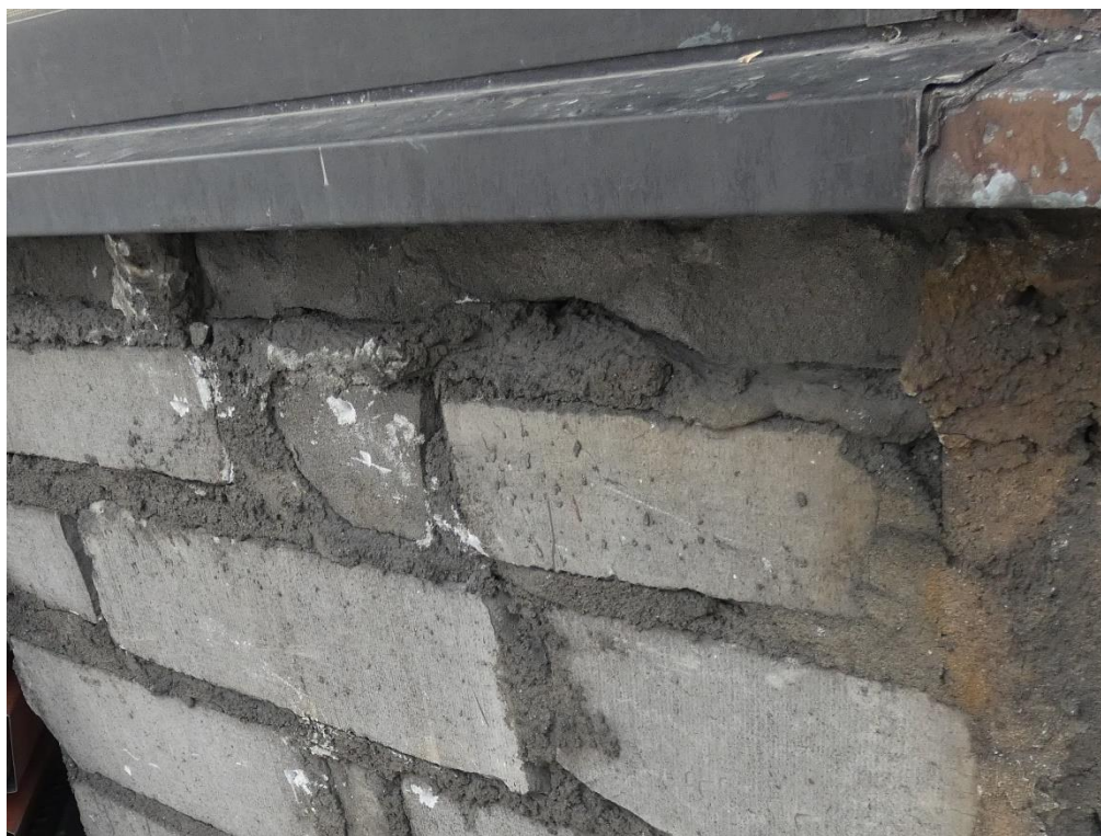
Fot. 7 Widok zwieńczenia ściany podlewką gr. 16 cm.
