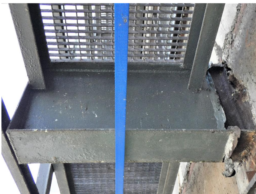
Fot. 125, 126 Kondygnacja 12 (Poziom +45.00) Elewacja Północna – wspornik w osiach 12/I. Brak widocznych uszkodzeń wspornika.
