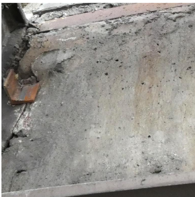
Fot. 99 Kondygnacja 12 (Poziom +45.00) Elewacja Południowa – belka w osiach 13-14/E. Brak widocznych uszkodzeń belki przy podporze.
