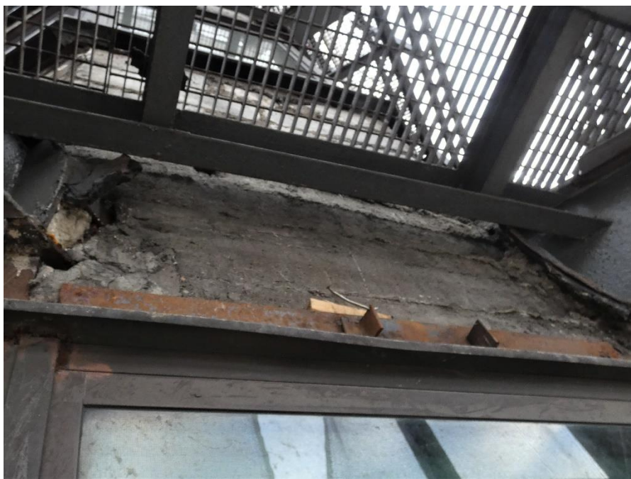
Fot. 89 Kondygnacja 12 (Poziom +45.00) Elewacja Zachodnia – belka w osiach 10/E. Brak możliwości pomiaru głębokości oparcia i określenia zastosowanych rozwiązań konstrukcyjnych. Brak widocznych uszkodzeń.
