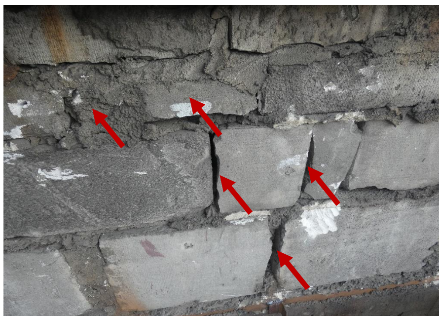
Fot. 46 Kondygnacja 12 (Poziom +45.00) Elewacja Południowa – widok ściany murowanej w osiach 13-14/E.
