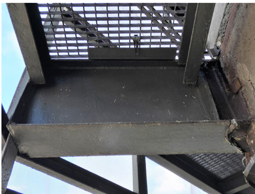
Fot. 121, 122 Kondygnacja 12 (Poziom +45.00) Elewacja Północna – wspornik w osiach 14/I. Brak widocznych uszkodzeń wspornika.
