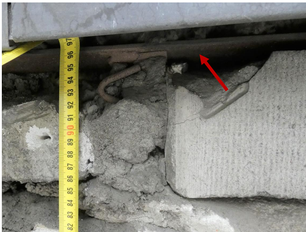
Fot. 5 Widok zwieńczenia ściany elementami murowanymi z betonu komórkowego pod profilem stalowym
