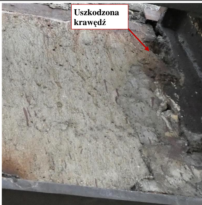
Fot. 88 Kondygnacja 12 (Poziom +45.00) Elewacja Zachodnia – belka w osiach 10/E-F. Uszkodzona krawędź elementu, brak widocznego zbrojenia. Spękania i zarysowania powierzchni zaprawy.
