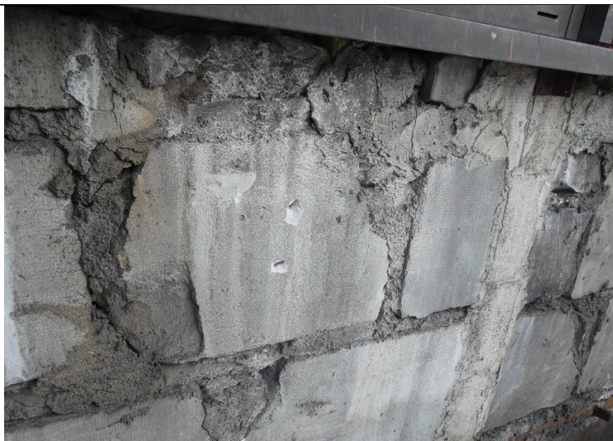
Fot. 8 Przykład zwieńczenia ściany podlewką i gruzem.
