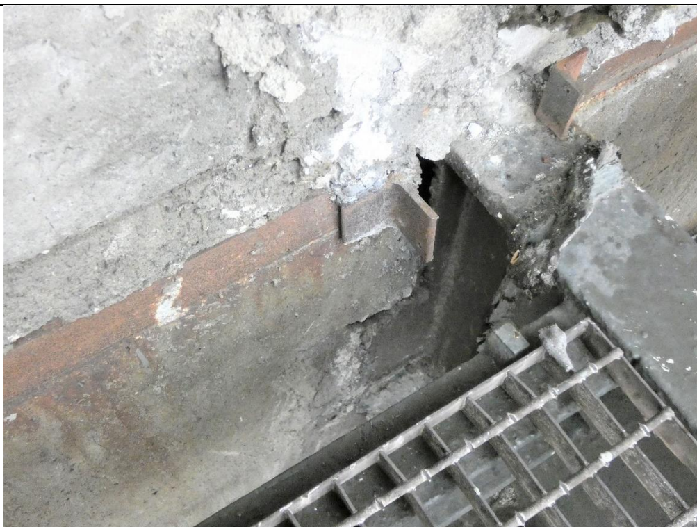
Fot. 104 Wspornik stalowy w miejscu oparcia belek żelbetowych (widok z góry)
