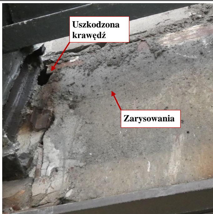
Fot. 53 Kondygnacja 12 (Poziom +45.00) Elewacja Wschodnia – belka w osiach 14/H-I.
