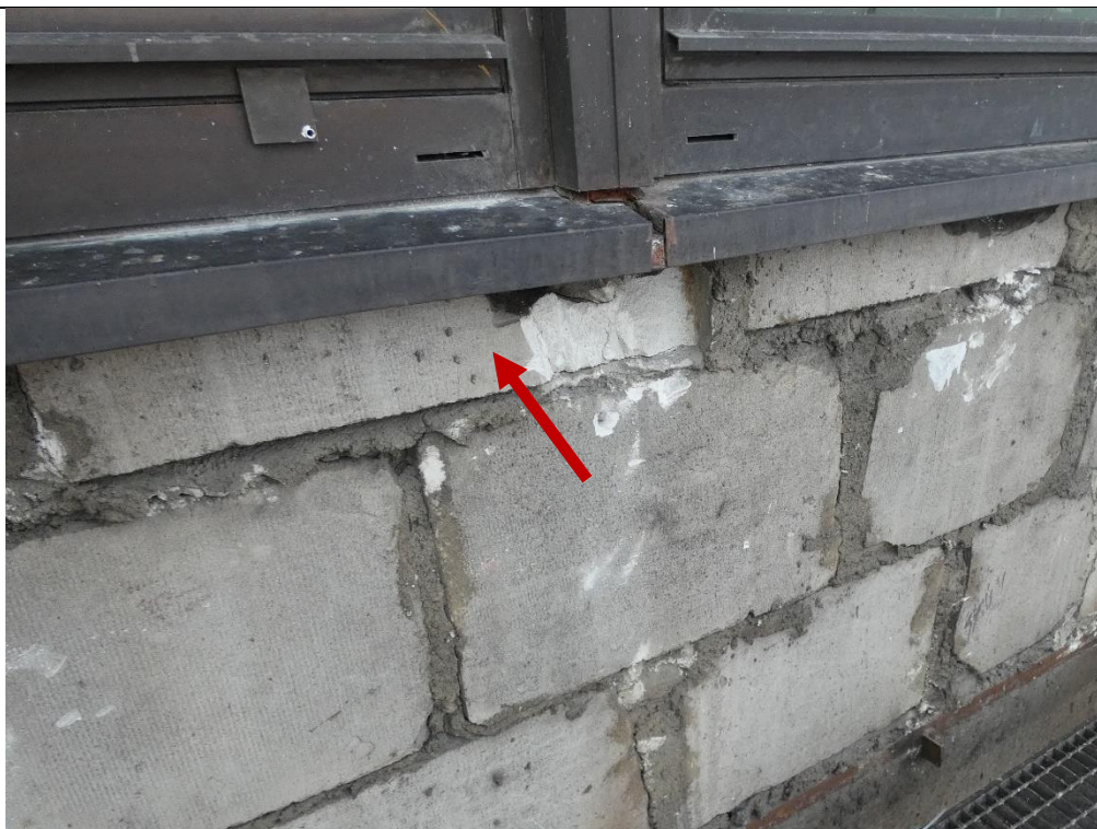
Fot. 6 Widok zwieńczenia ściany z elementów z betonu komórkowego bez podlewki pod profilem stalowym.
