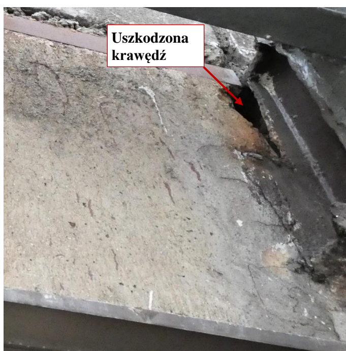
Fot. 85 Kondygnacja 12 (Poziom +45.00) Elewacja Zachodnia – belka w osiach 10/F-G. Uszkodzona krawędź elementu, brak widocznego zbrojenia. Zarysowania powierzchni zaprawy
