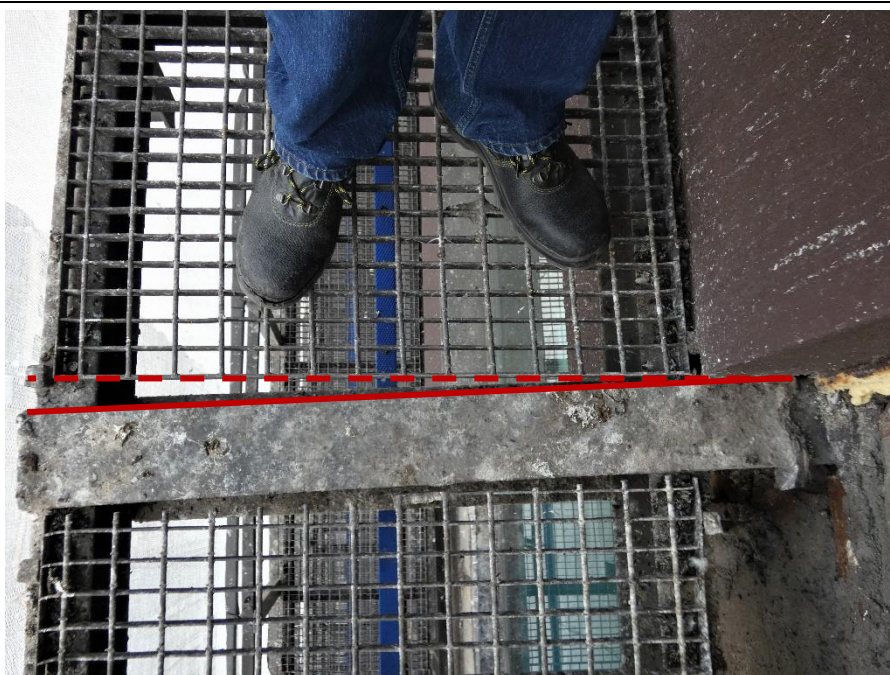
Fot. 118 Kondygnacja 12 (Poziom +45.00) Elewacja Wschodnia – wspornik w osiach 14/H. Przemieszczenie wspornika w kierunku osi I. Brak widocznych uszkodzeń wspornika.
