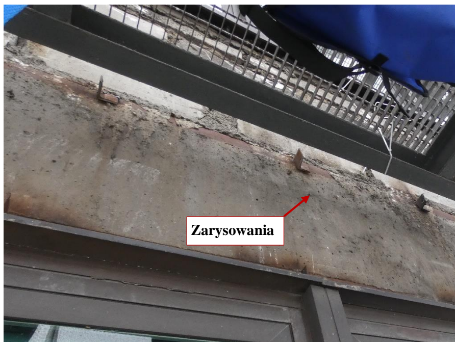
Fot. 70 Kondygnacja 12 (Poziom +45.00) Elewacja Północna – belka w osiach 10-11/I. Zarysowania belki w przęśle na wysokości miejsca oparcia.
