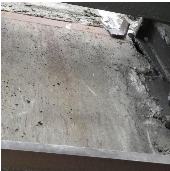
Fot. 93 Kondygnacja 12 (Poziom +45.00) Elewacja Południowa – belka w osiach 10-11/E. Spękania i zarysowania powierzchni zaprawy. Brak widocznych uszkodzeń belki przy podporze.
