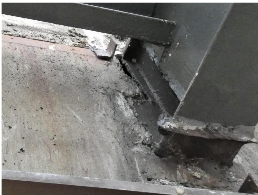
Fot. 105 Wspornik stalowy w miejscu oparcia belek żelbetowych (widok z dołu)
