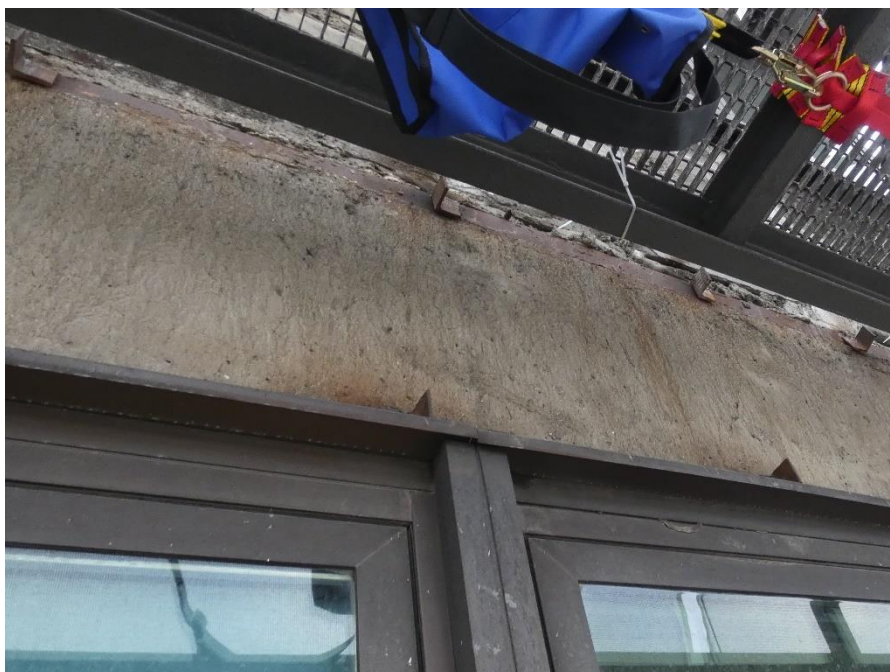
Fot. 87 Kondygnacja 12 (Poziom +45.00) Elewacja Zachodnia – belka w osiach 10/E-F. Brak widocznych uszkodzeń belki w przęśle
