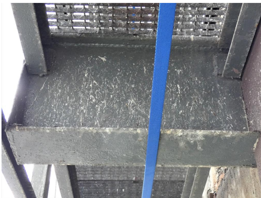
Fot. 111, 112 Kondygnacja 12 (Poziom +45.00) Elewacja Wschodnia – wspornik w osiach 14/F (widok z dołu) Pozostałości po usuniętej drabinie ewakuacyjnej. Brak widocznych uszkodzeń wspornika.
