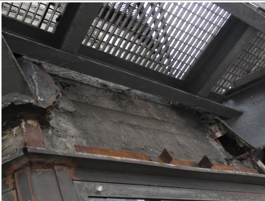
Fot. 73 Kondygnacja 12 (Poziom +45.00) Elewacja Północna – belka w osiach 10/I.
