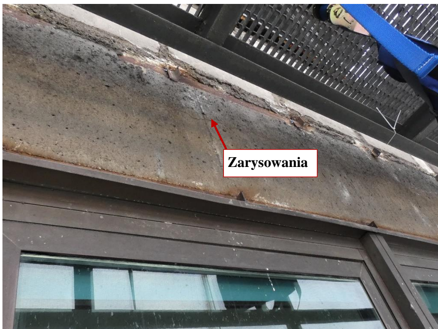
Fot. 54 Kondygnacja 12 (Poziom +45.00) Elewacja Wschodnia – belka w osiach 14/H-I.
