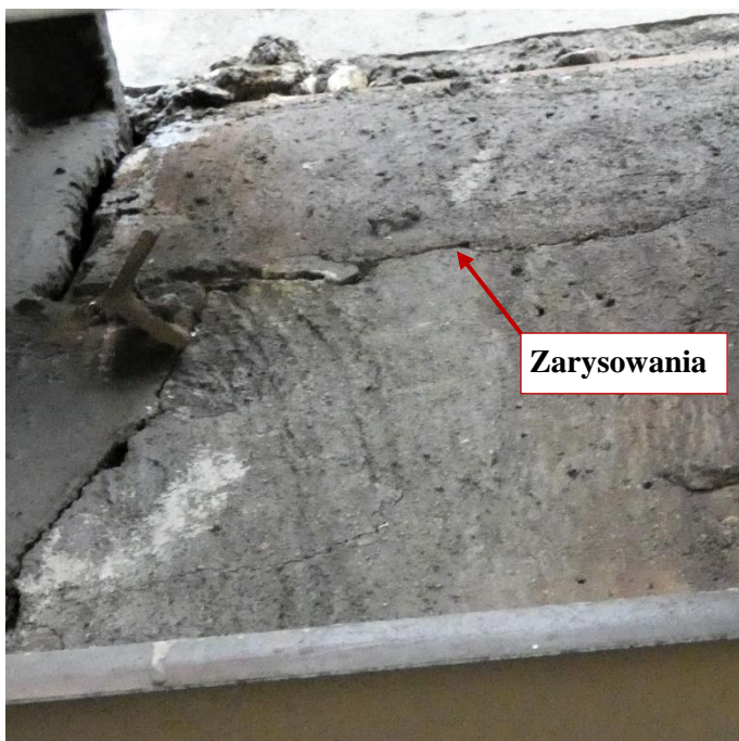
Fot. 97 Kondygnacja 12 (Poziom +45.00) Elewacja Południowa – belka w osiach 12-13/E. Zarysowania belki na wysokości miejsca oparcia. Spękania i zarysowania powierzchni zaprawy.
