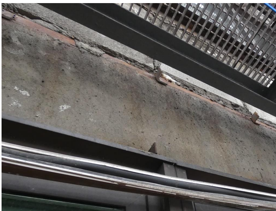
Fot. 95 Kondygnacja 12 (Poziom +45.00) Elewacja Południowa – belka w osiach 11-12/E. Brak widocznych uszkodzeń belki w przęśle
