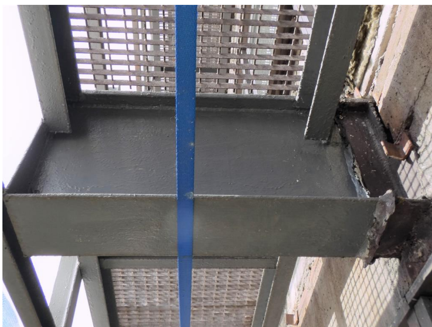
Fot. 142, 143 Kondygnacja 12 (Poziom +45.00) Elewacja Południowa– wspornik w osiach 11/E. Brak widocznych uszkodzeń wspornika.
