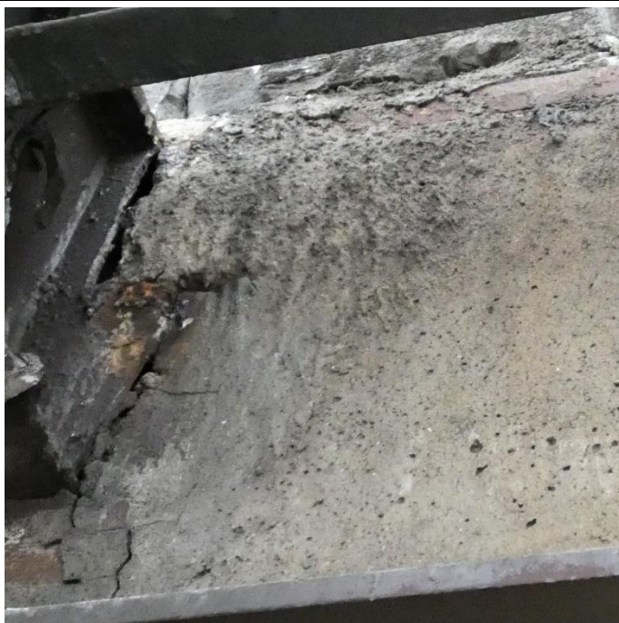
Fot. 78 Kondygnacja 12 (Poziom +45.00) Elewacja Zachodnia – belka w osiach 10/G-H. Spękania i zarysowania powierzchni zaprawy. Brak widocznych uszkodzeń belki przy podporze.
