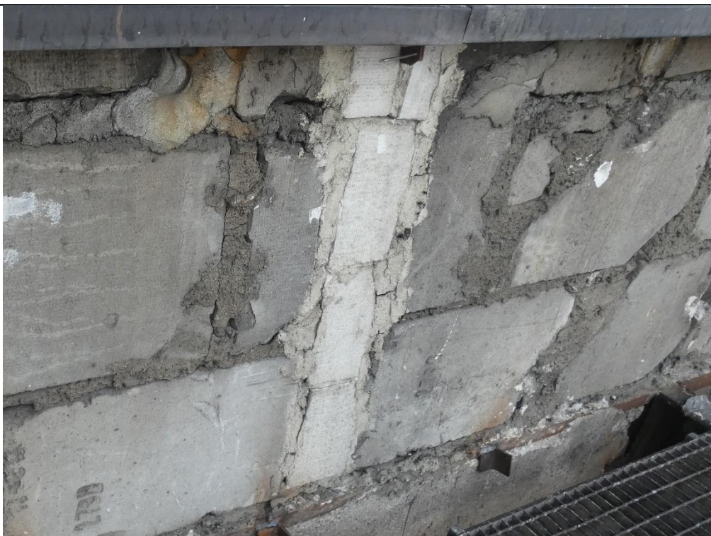
Fot. 9 Przykład zamknięcia pionu instalacyjnego.
