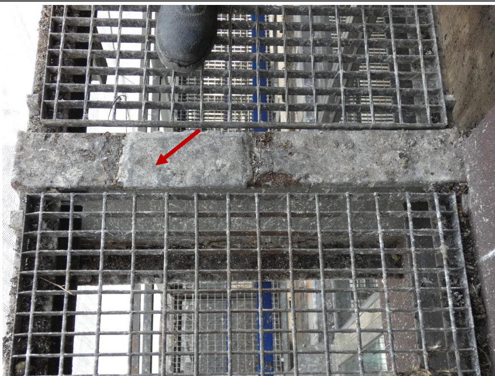
Fot. 113 Kondygnacja 12 (Poziom +45.00) Elewacja Wschodnia – wspornik w osiach 14/F (widok z góry) Pozostałości po usuniętej drabinie ewakuacyjnej. Brak widocznych uszkodzeń wspornika.
