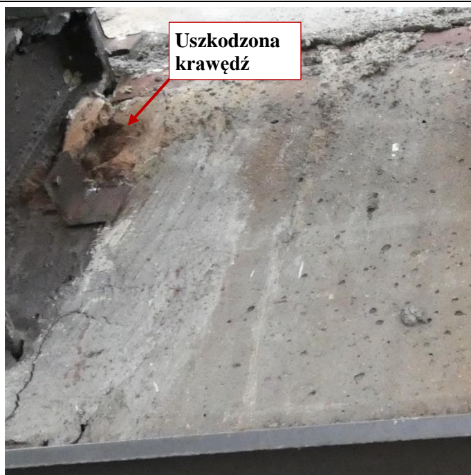
Fot. 69 Kondygnacja 12 (Poziom +45.00) Elewacja Północna – belka w osiach 10-11/I. Uszkodzona krawędź elementu, brak widocznego zbrojenia. Zalegający gruz w przestrzeni między elementami. Zarysowania powierzchni zaprawy.
