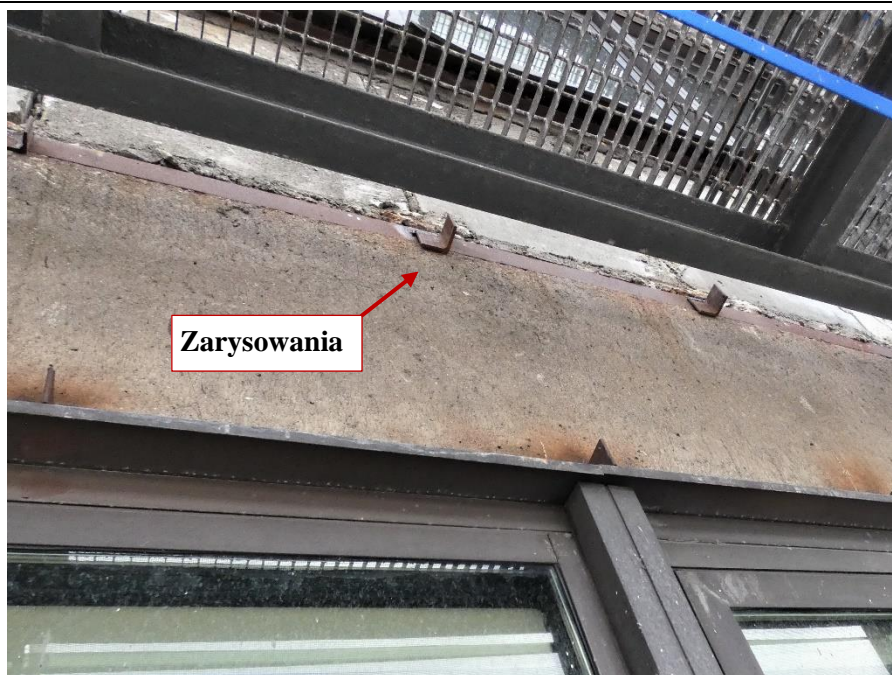
Fot. 84 Kondygnacja 12 (Poziom +45.00) Elewacja Zachodnia – belka w osiach 10/F-G. Zarysowania belki w przęśle na wysokości miejsca oparcia.
