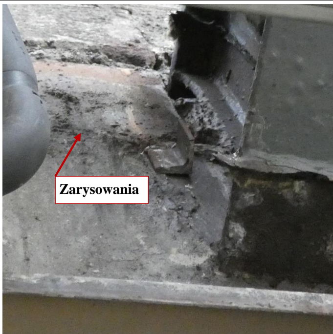
Fot. 96 Kondygnacja 12 (Poziom +45.00) Elewacja Południowa – belka w osiach 11-12/E. Wypełnienie przestrzeni między elementami zaprawą. Zarysowania belki na wysokości miejsca oparcia. Spękania i zarysowania powierzchni zaprawy.
