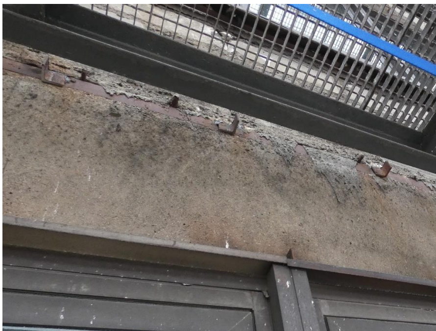
Fot. 79 Kondygnacja 12 (Poziom +45.00) Elewacja Zachodnia – belka w osiach 10/G-H. Brak widocznych uszkodzeń belki w przęśle.
