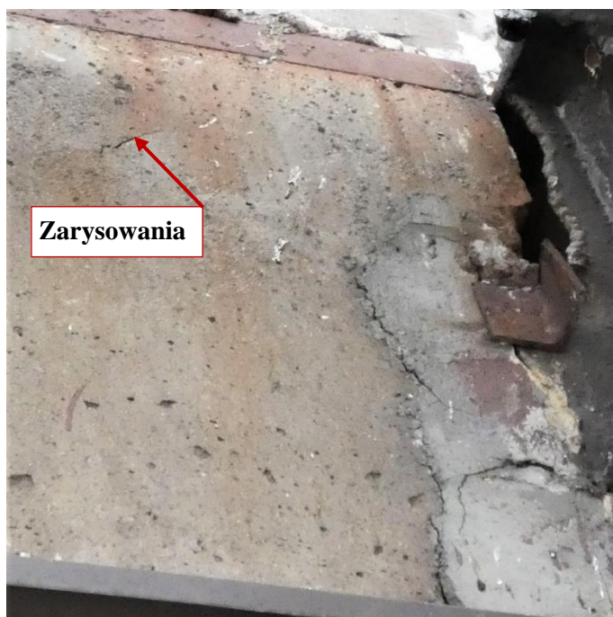
Fot. 64 Kondygnacja 12 (Poziom +45.00) Elewacja Północna – belka w osiach 12-13/I. Zarysowania belki na wysokości miejsca oparcia. Spękania i zarysowania powierzchni zaprawy.
