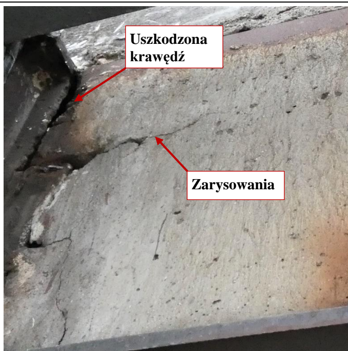
Fot. 86 Kondygnacja 12 (Poziom +45.00) Elewacja Zachodnia – belka w osiach 10/E-F. Uszkodzona krawędź elementu, brak widocznego zbrojenia. Zarysowania belki na wysokości miejsca oparcia. Zarysowania powierzchni zaprawy
