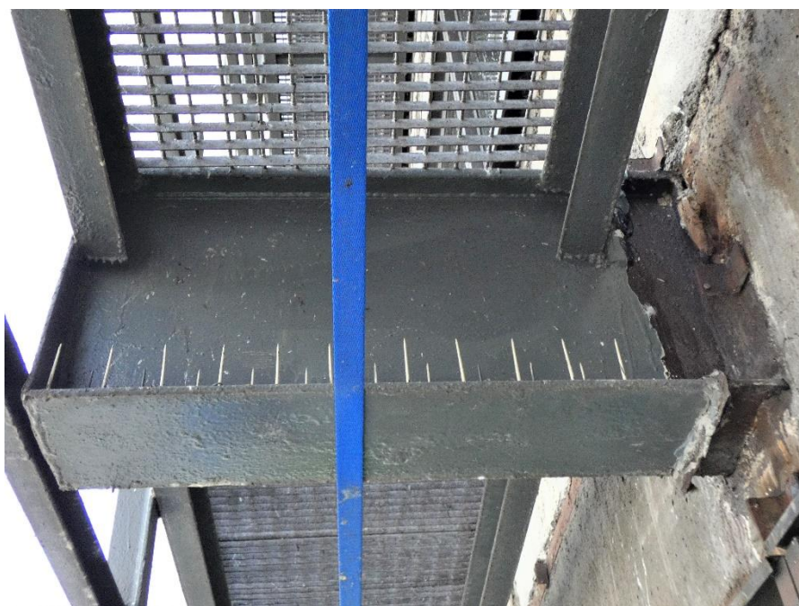
Fot. 127, 128 Kondygnacja 12 (Poziom +45.00) Elewacja Północna – wspornik w osiach 11/I. Przemieszczenie wspornika w kierunku osi 10. Brak widocznych uszkodzeń wspornika.
