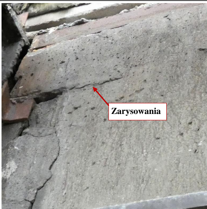
Fot. 94 Kondygnacja 12 (Poziom +45.00) Elewacja Południowa – belka w osiach 11-12/E. Zarysowania belki na wysokości miejsca oparcia. Spękania i zarysowania powierzchni zaprawy.
