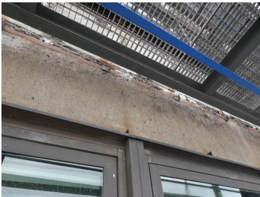
Fot. 63 Kondygnacja 12 (Poziom +45.00) Elewacja Północna – belka w osiach 12-13/I. Brak widocznych uszkodzeń belki w przęśle.
