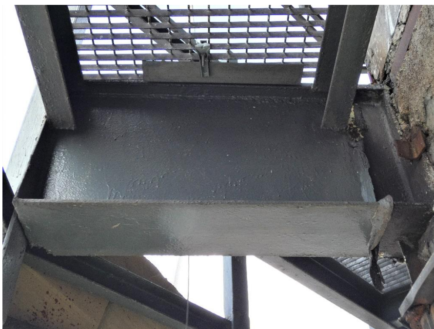
Fot. 131, 132 Kondygnacja 12 (Poziom +45.00) Elewacja Zachodnia– wspornik w osiach 10/I. Brak widocznych uszkodzeń wspornika.
