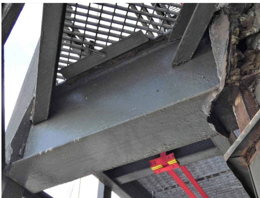
Fot. 129, 130 Kondygnacja 12 (Poziom +45.00) Elewacja Północna – wspornik w osiach 10/I. Brak widocznych uszkodzeń wspornika.
