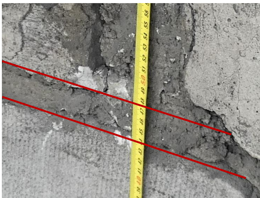
Fot. 1 Przykładowa spoina pozioma – grubość 3,5 cm
