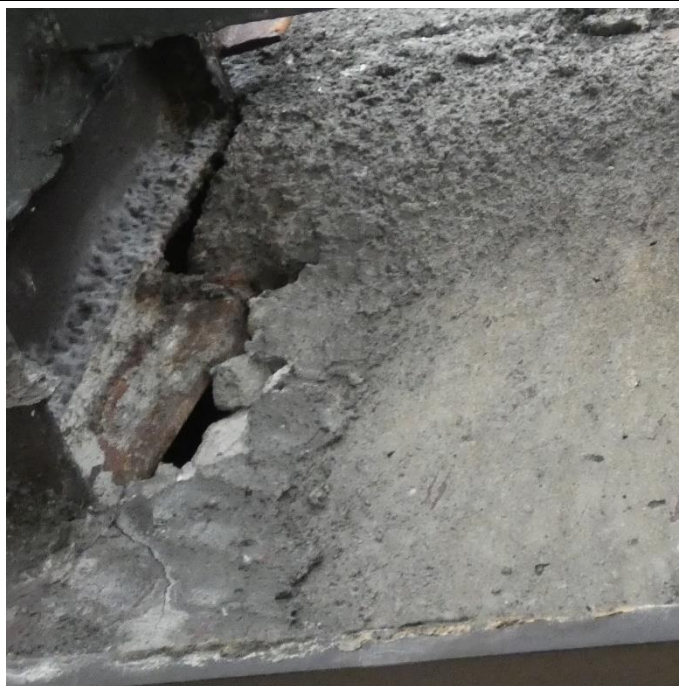
Fot. 90 Kondygnacja 12 (Poziom +45.00) Elewacja Południowa – belka w osiach 10-11/E. Spękania i zarysowania powierzchni zaprawy. Brak widocznych uszkodzeń belki przy podporze.
