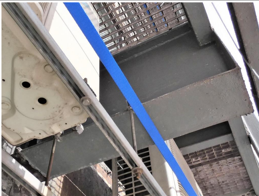
Fot. 144 Kondygnacja 12 (Poziom +45.00) Elewacja Południowa– wspornik w osiach 12/E. Brak widocznych uszkodzeń wspornika.
