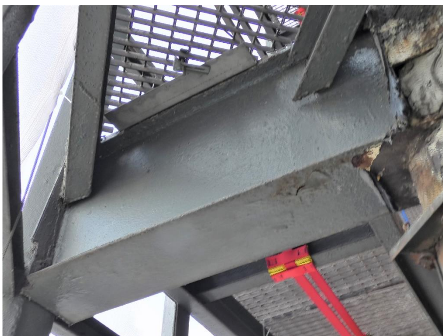
Fot. 147, 148 Kondygnacja 12 (Poziom +45.00) Elewacja Południowa– wspornik w osiach 14/E. Brak widocznych uszkodzeń wspornika.
