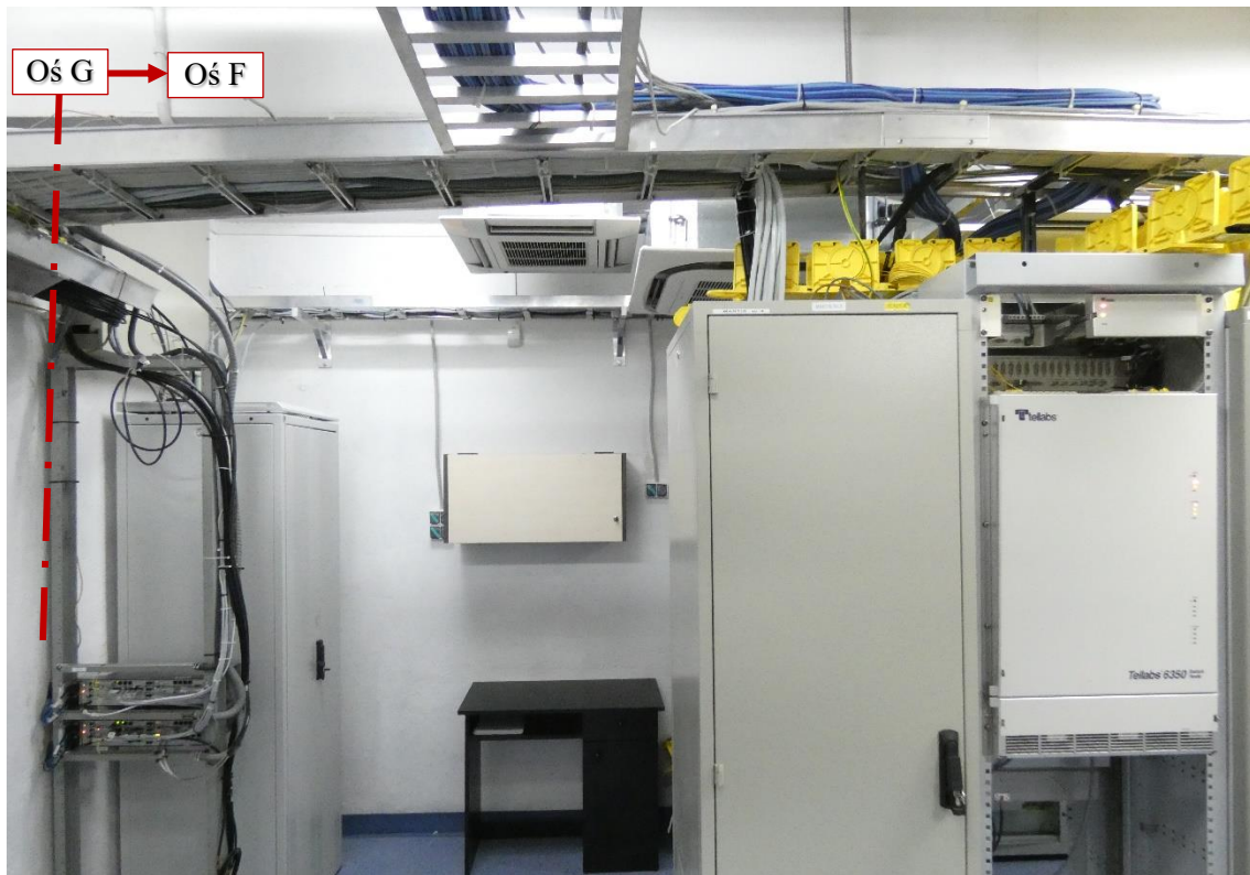
Fot. 52 Piętro 19 (Poziom +68.10) Elewacja Wschodnia – widok ściany w osiach 14 / F-G – wewnątrz
