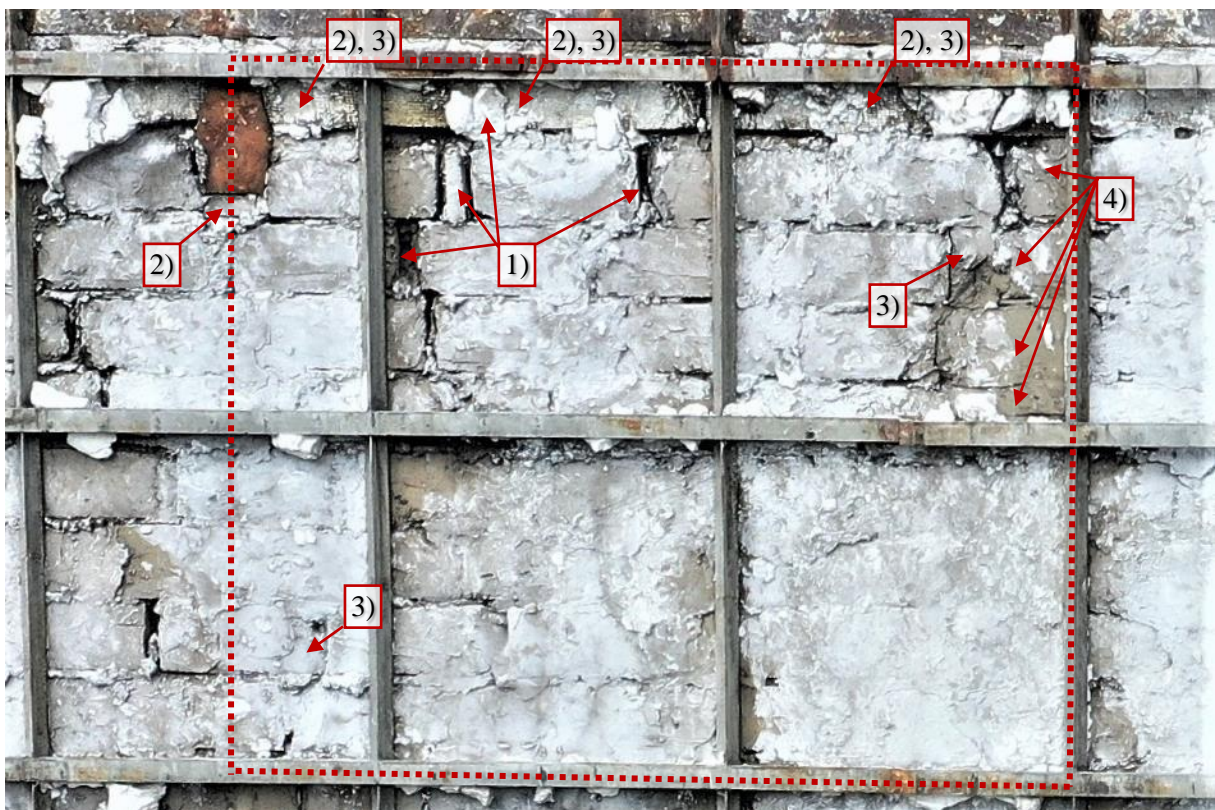
Fot. 196 Piętro 20 (Poziom +71.40) Elewacja Południowa – widok ściany w osiach 11-12 / E – Część 4/4
