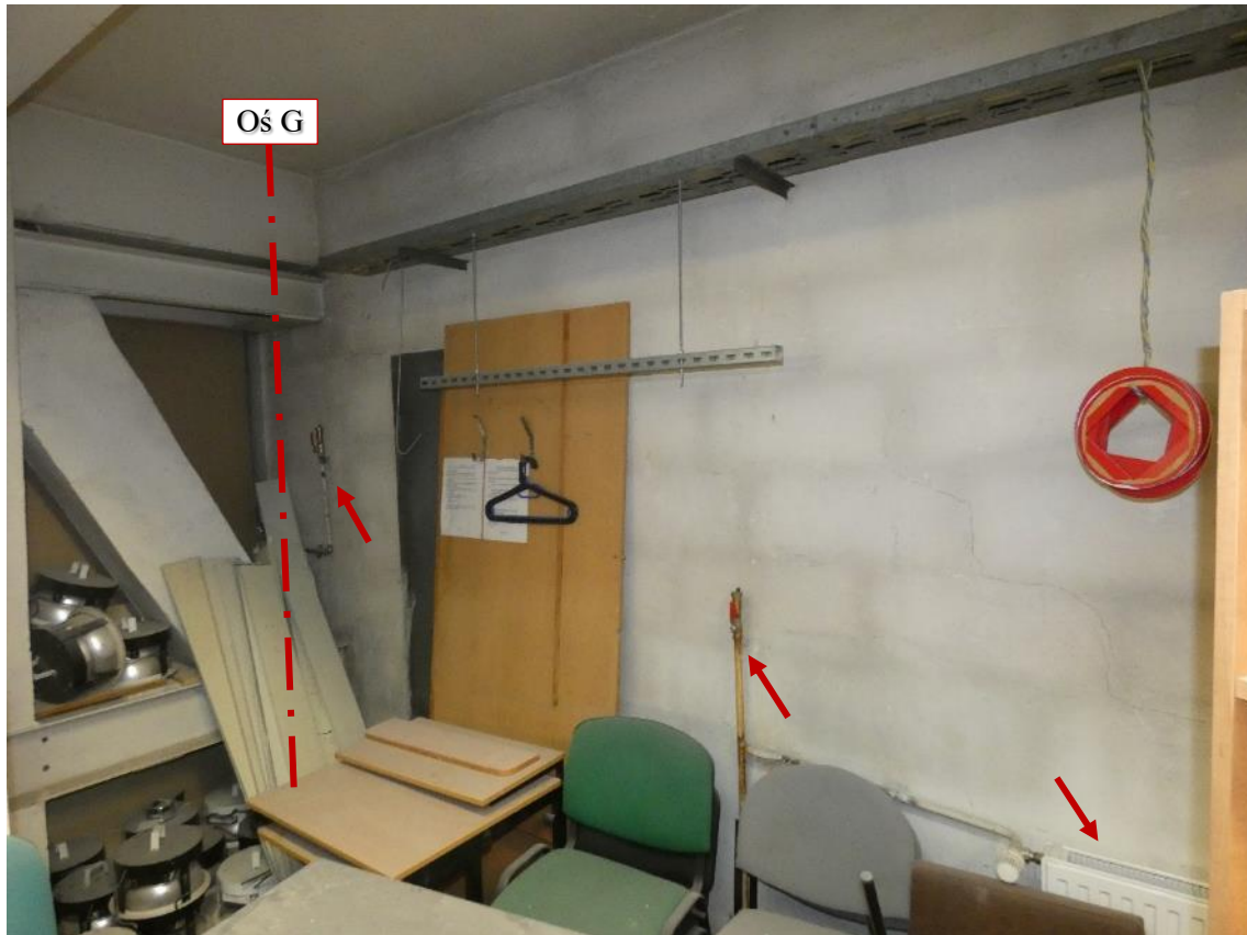
Fot. 103 Piętro 19 (Poziom +68.10) Elewacja Zachodnia – widok ściany w osiach 10 / G-H – wewnątrz
