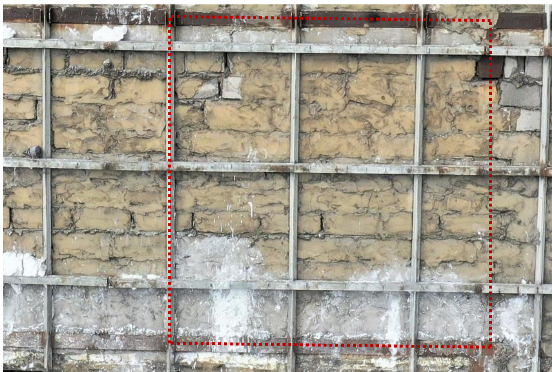
Fot. 82 Piętro 19 (Poziom +68.10) Elewacja Południowa– widok ściany w osiach 11-12 / E Część 1/2
