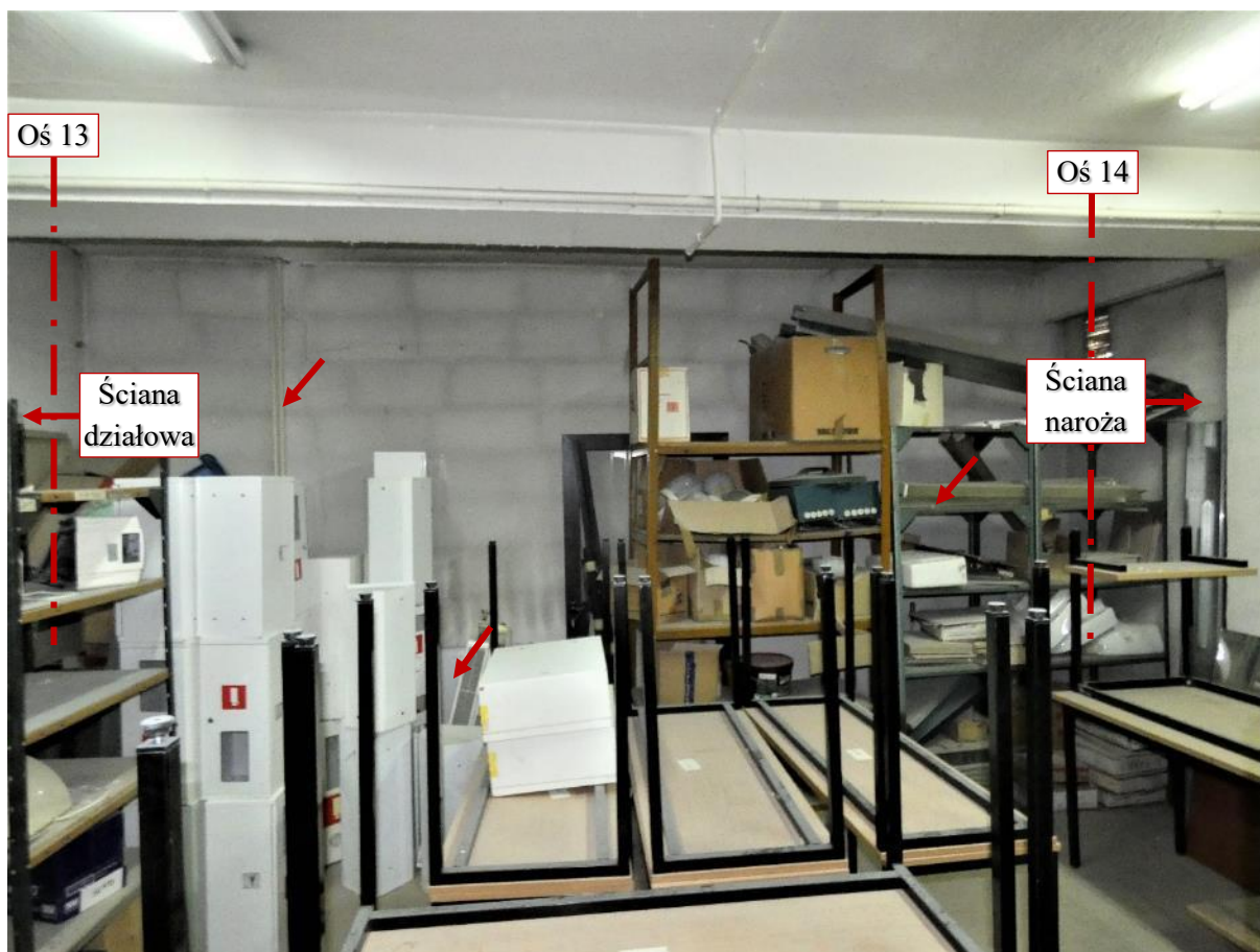
Fot. 35 Piętro 19 (Poziom +68.10) Elewacja Północna – widok ściany w osiach 13-14 / I – wewnątrz
