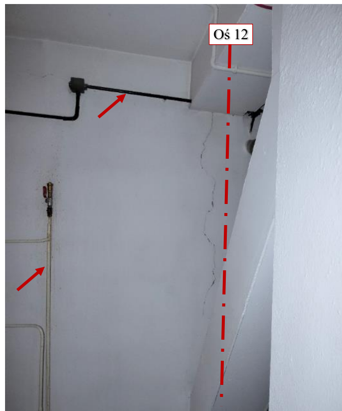
Fot. 73 Piętro 19 (Poziom +68.10) Elewacja Południowa – widok ściany w osiach 12-13 / E – wewnątrz
