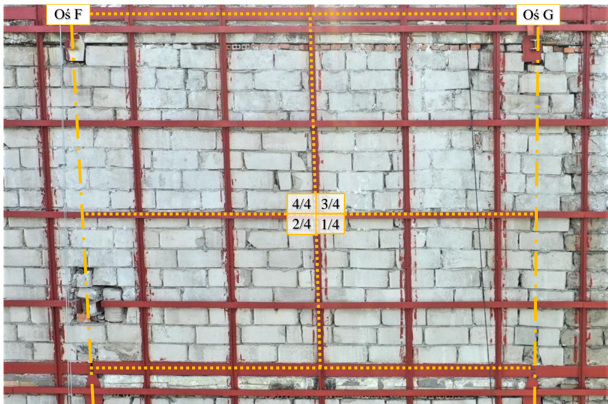
Fot. 155 Piętro 20 (Poziom +71.40) Elewacja Wschodnia – widok ściany w osi 14 / F-G – zewnątrz
