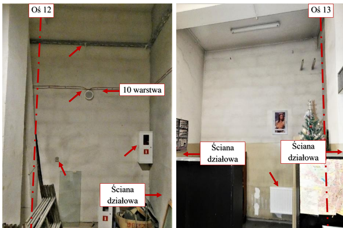
Fot. 131 Piętro 20 (Poziom +71.40) Elewacja Północna – widok ściany w osiach 12-13 / I – wewnątrz
