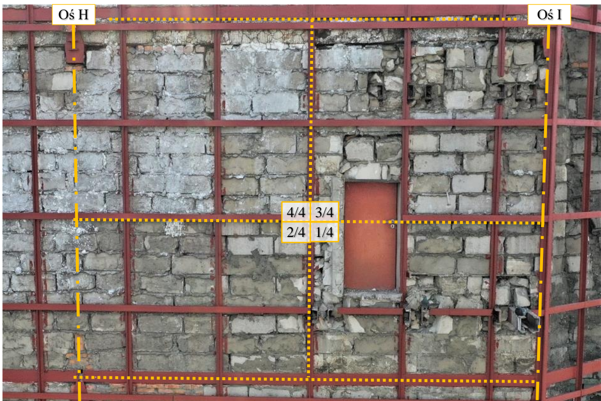
Fot. 142 Piętro 20 (Poziom +71.40) Elewacja Wschodnia – widok ściany w osi 14 / H-I – zewnątrz
