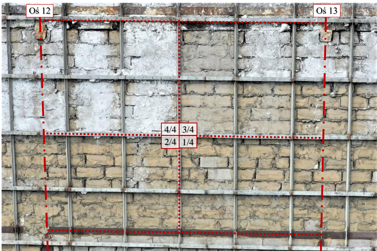
Fot. 179 Piętro 20 (Poziom +71.40) Elewacja Południowa – widok ściany w osiach 12-13 / E – zewnątrz
