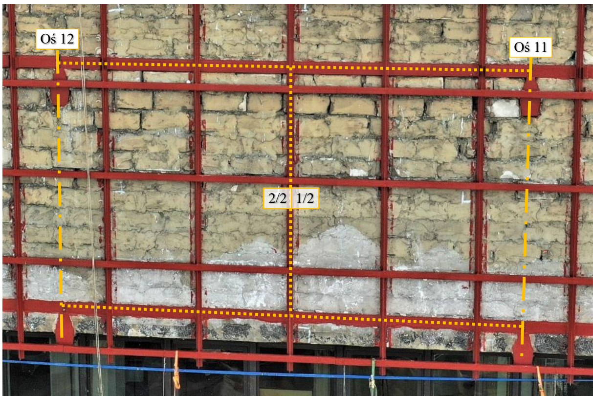
Fot. 24 Piętro 19 (Poziom +68.10) Elewacja Północna – widok ściany w osiach 11-12 / I – zewnątrz
