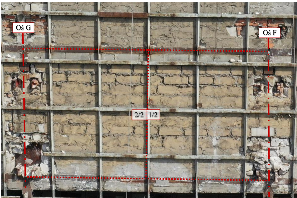
Fot. 98 Piętro 19 (Poziom +68.10) Elewacja Zachodnia – widok ściany w osiach 10 / F-G – zewnątrz
