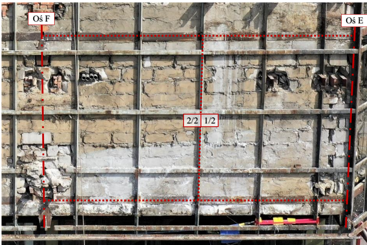
Fot. 92 Piętro 19 (Poziom +68.10) Elewacja Zachodnia – widok ściany w osiach 10 / E-F – zewnątrz
