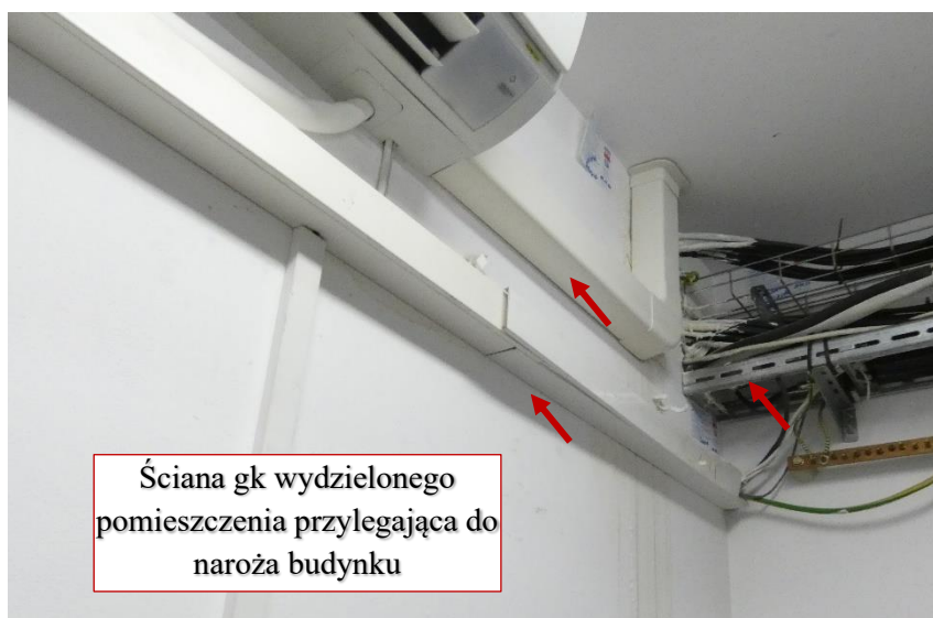
Fot. 169 Piętro 20 (Poziom +71.40) Elewacja Południowa – widok z wnętrza wydzielonego pomieszczenia.
