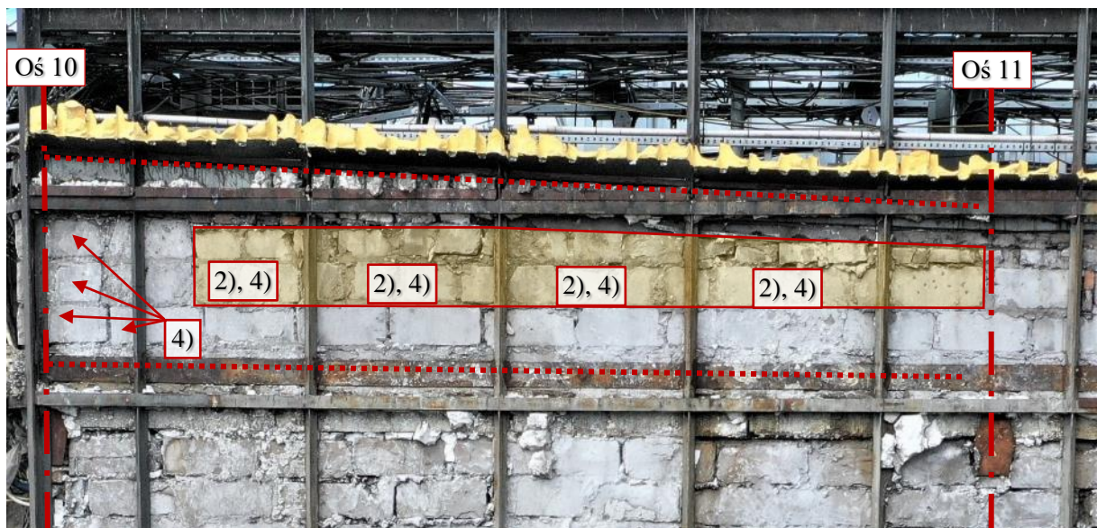
Fot. 254 Ściana nad 20 pięciem (Poziom +76.00) Elewacja Południowa – widok ściany w osiach 10-11 / E
