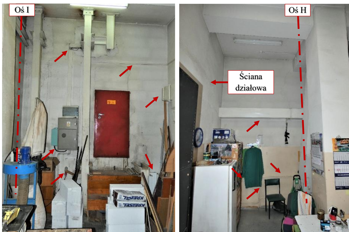
Fot. 143 Piętro 20 (Poziom +71.40) Elewacja Wschodnia – widok ściany w osi 14 / H-I – wewnątrz
