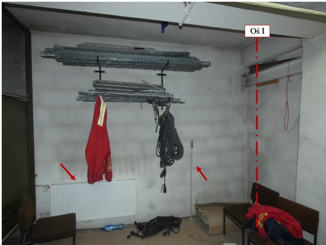
Fot. 110 Piętro 19 (Poziom +68.10) Elewacja Zachodnia – widok ściany w osiach 10 / H-I – wewnątrz
