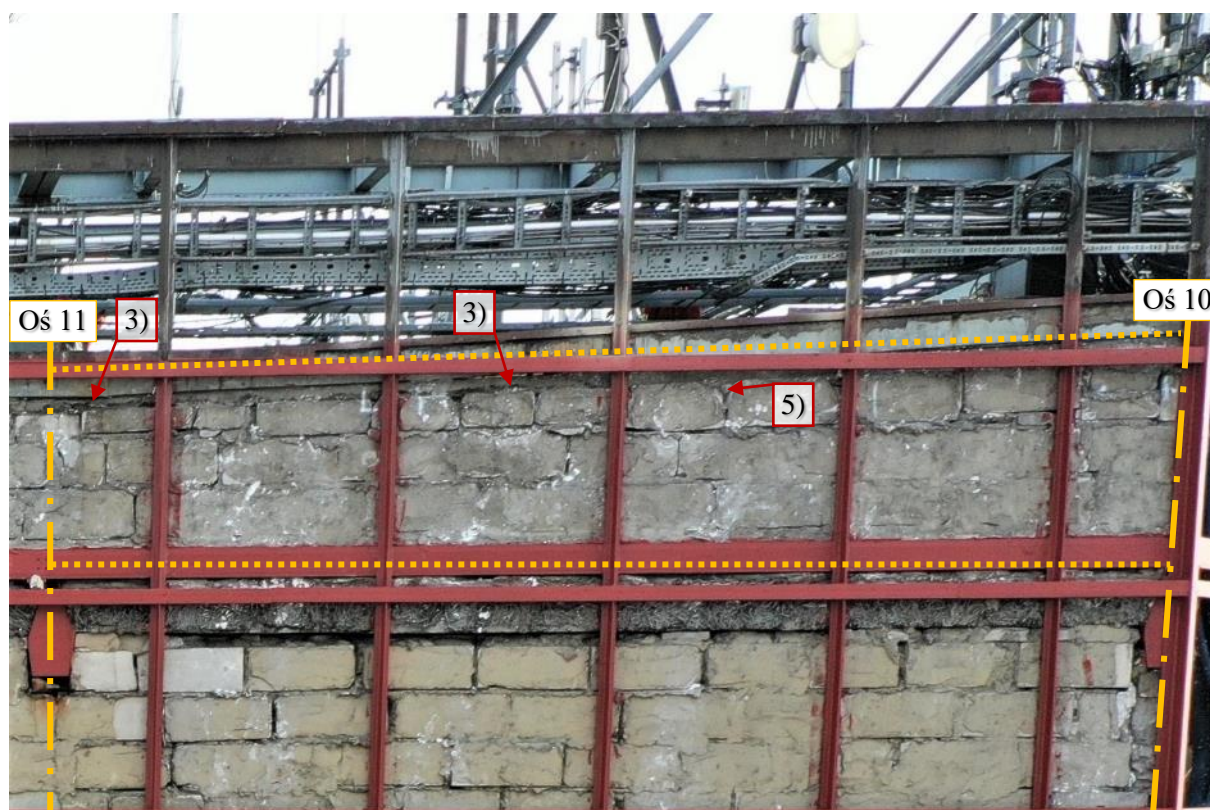
Fot. 241 Ściana nad 20 piętrzem (Poziom +76.00) Elewacja Północna – widok ściany w osiach 10-11 / I
