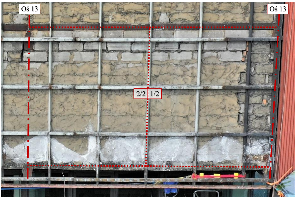
Fot. 65 Piętro 19 (Poziom +68.10) Elewacja Południowa – widok ściany w osiach 13-14 / E – zewnątrz
