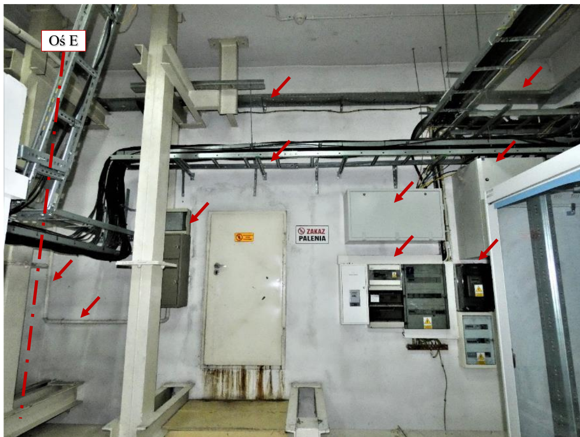
Fot. 211 Piętro 20 (Poziom +71.40) Elewacja Zachodnia – widok ściany w osi 10 / E-F – wewnątrz
