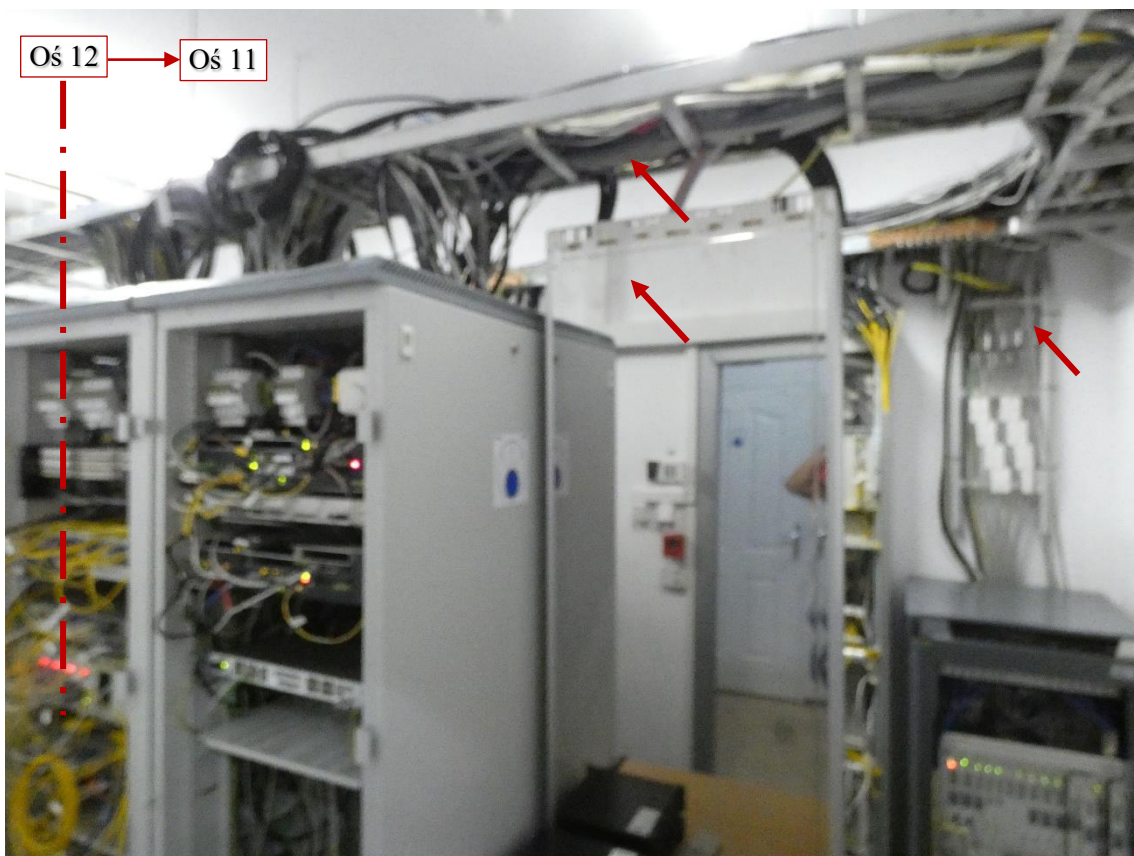
Fot. 188 Piętro 20 (Poziom +71.40) Elewacja Południowa – widok ściany w osiach 11-12 / E – wewnątrz
