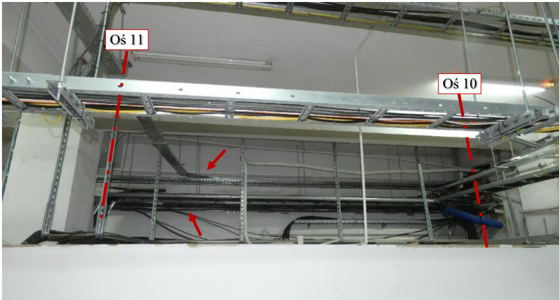
Fot. 198 Piętro 20 (Poziom +71.40) Elewacja Południowa – widok ściany w osiach 10-11 / E – wewnątrz
