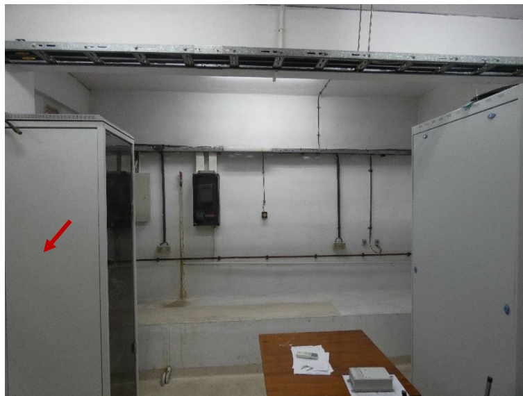
Fot. 64 Piętro 19 (Poziom +68.10) Elewacja Południowa – widok naroża ściany w osi 14 / E – wewnątrz
