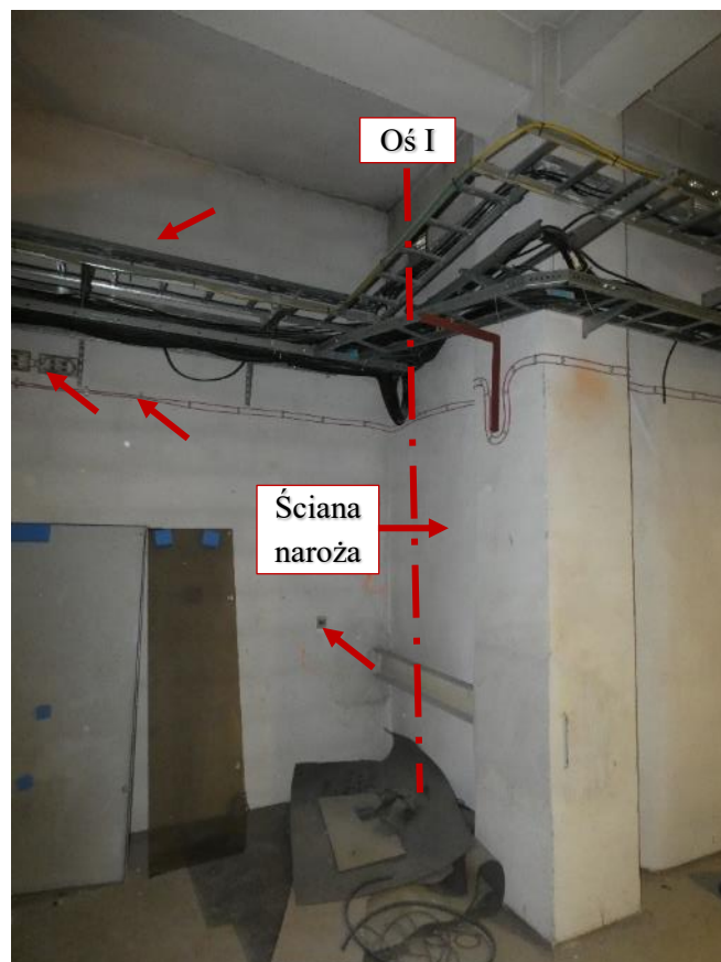
Fot. 234 Piętro 20 (Poziom +71.40) Elewacja Zachodnia – widok ściany w osi 10 / H-I – wewnątrz
