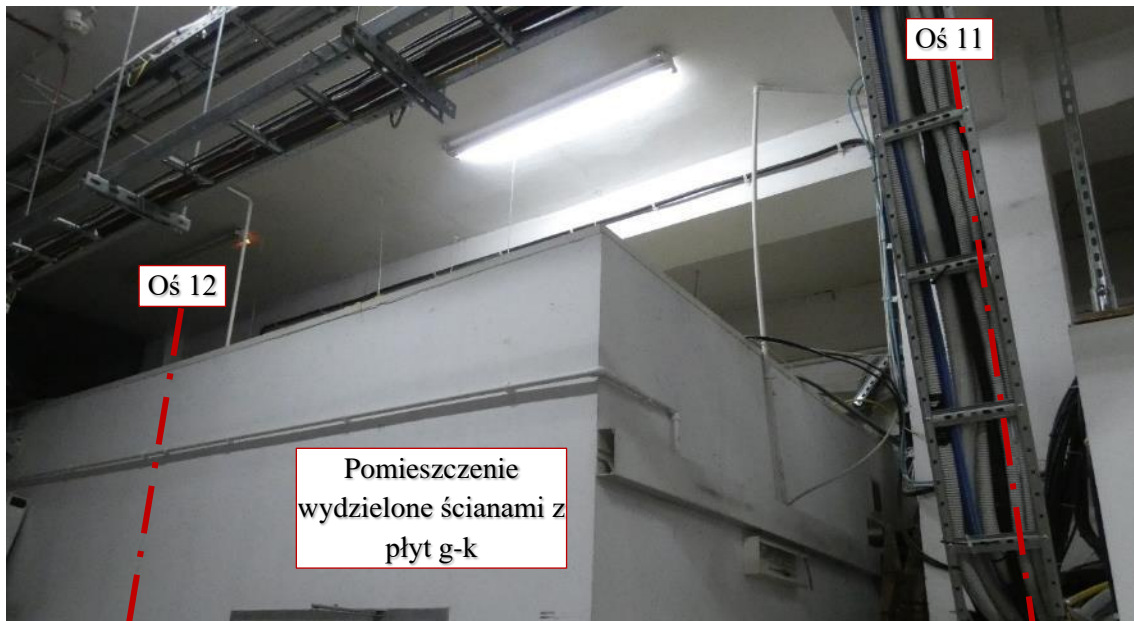
Fot. 187 Piętro 20 (Poziom +71.40) Elewacja Południowa – widok ściany w osiach 11-12 / E – wewnątrz
