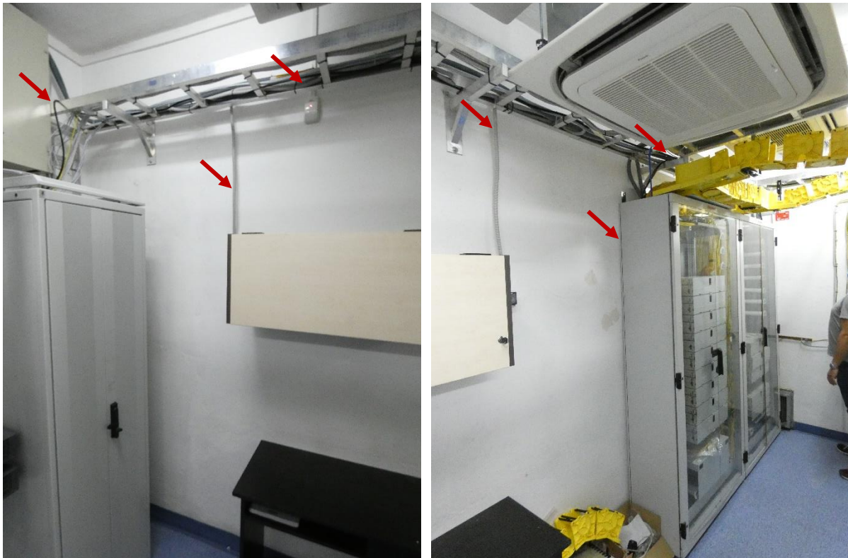
Fot. 53 Piętro 19 (Poziom +68.10) Elewacja Wschodnia – widok ściany w osiach 14 / F-G – wewnątrz
