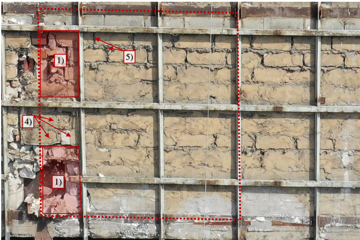
Fot. 101 Piętro 19 (Poziom +68.10) Elewacja Zachodnia – widok ściany w osiach 10 / F-G – Część 2/2
