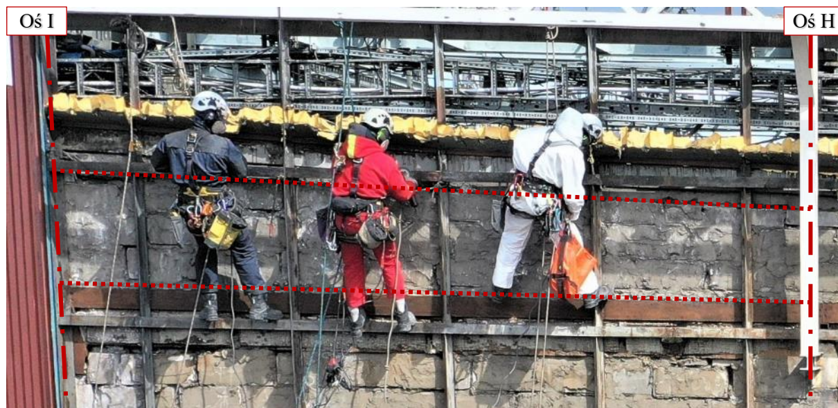
Fot. 259 Ściana nad 20 piętrem (Poziom +76.00) Elewacja Zachodnia – widok ściany w osi 10 / H-I
