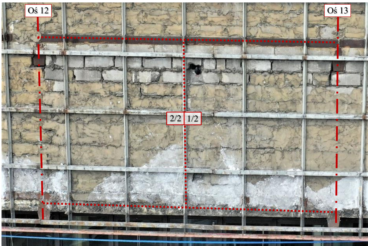
Fot. 71 Piętro 19 (Poziom +68.10) Elewacja Południowa – widok ściany w osiach 12-13 / E – zewnątrz
