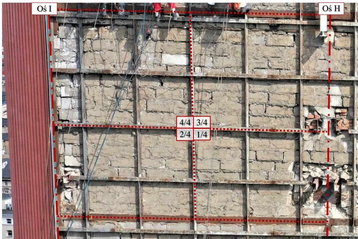
Fot. 232 Piętro 20 (Poziom +71.40) Elewacja Zachodnia – widok ściany w osi 10 / H-I – zewnątrz
