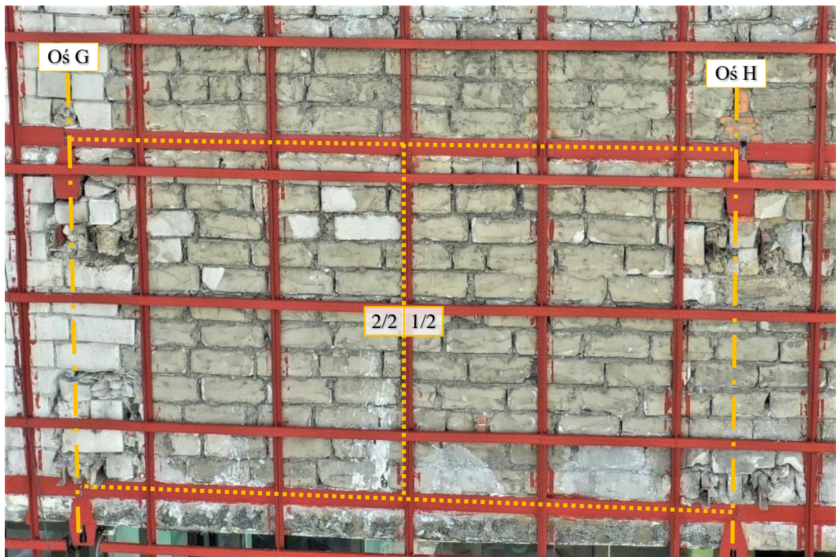
Fot. 46 Piętro 19 (Poziom +68.10) Elewacja Wschodnia – widok ściany w osiach 14 / G-H – zewnątrz
