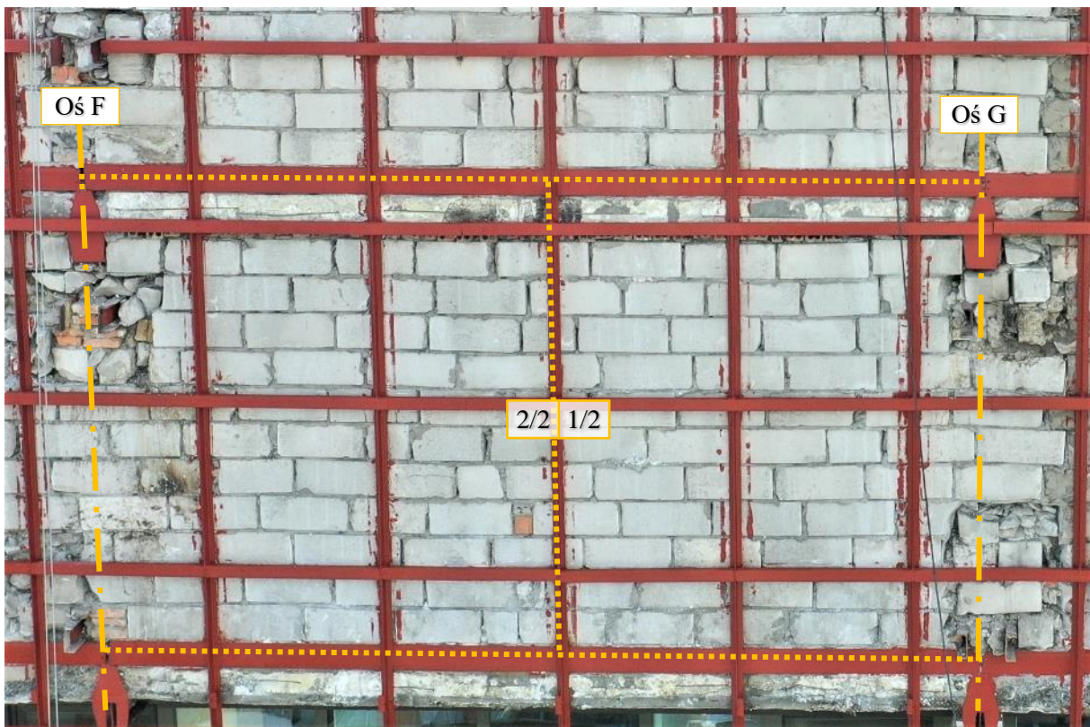
Fot. 51 Piętro 19 (Poziom +68.10) Elewacja Wschodnia – widok ściany w osiach 14 / F-G – zewnątrz
