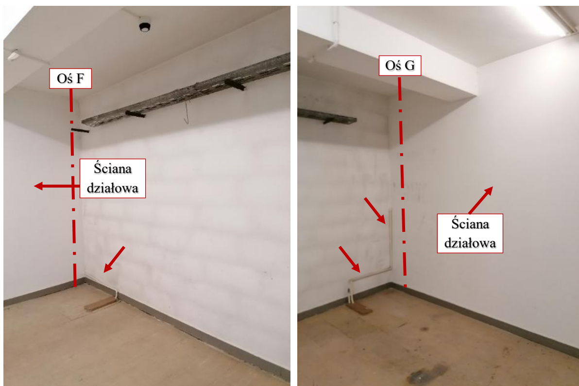
Fot. 99 Piętro 19 (Poziom +68.10) Elewacja Zachodnia – widok ściany w osiach 10 / F-G – wewnątrz
