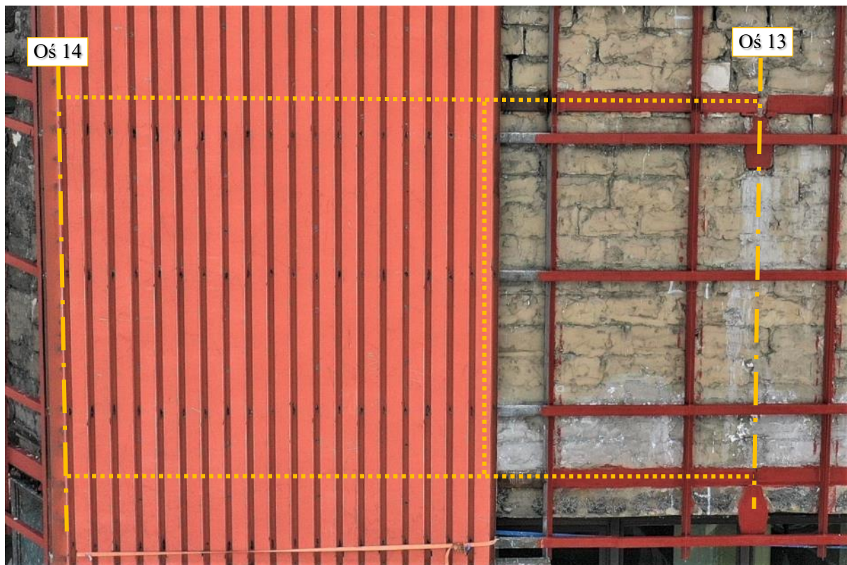
Fot. 34 Piętro 19 (Poziom +68.10) Elewacja Północna – widok ściany w osiach 13-14 / I – zewnątrz
