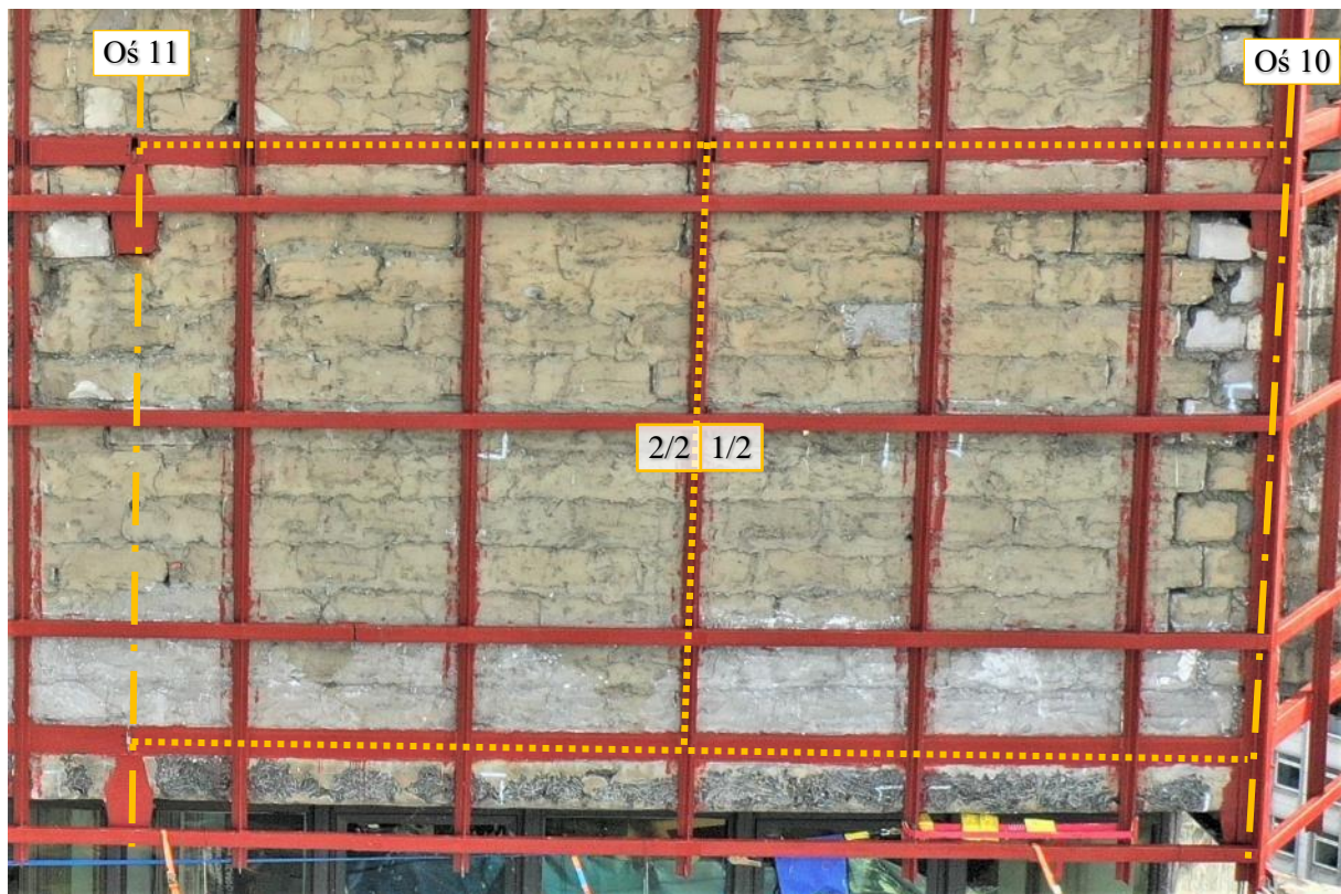
Fot. 18 Piętro 19 (Poziom +68.10) Elewacja Północna – widok ściany w osiach 10-11 / I – zewnątrz
