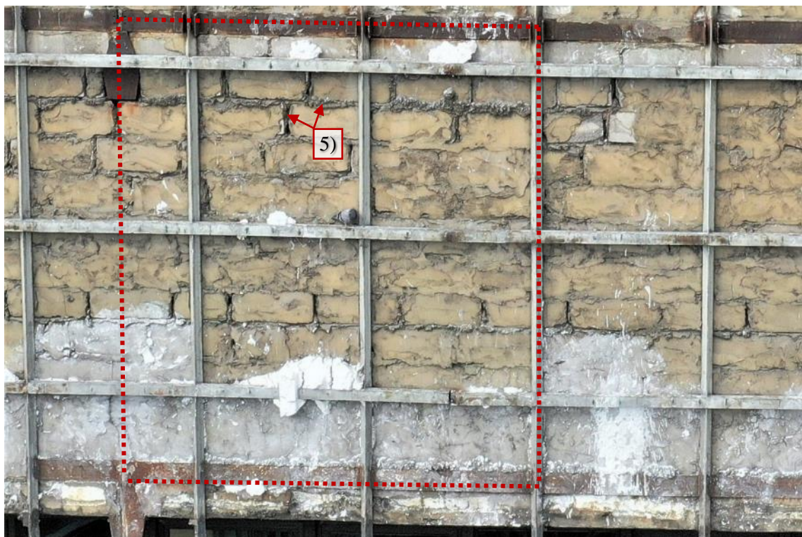
Fot. 83 Piętro 19 (Poziom +68.10) Elewacja Południowa – widok ściany w osiach 11-12 / E Część 2/2
