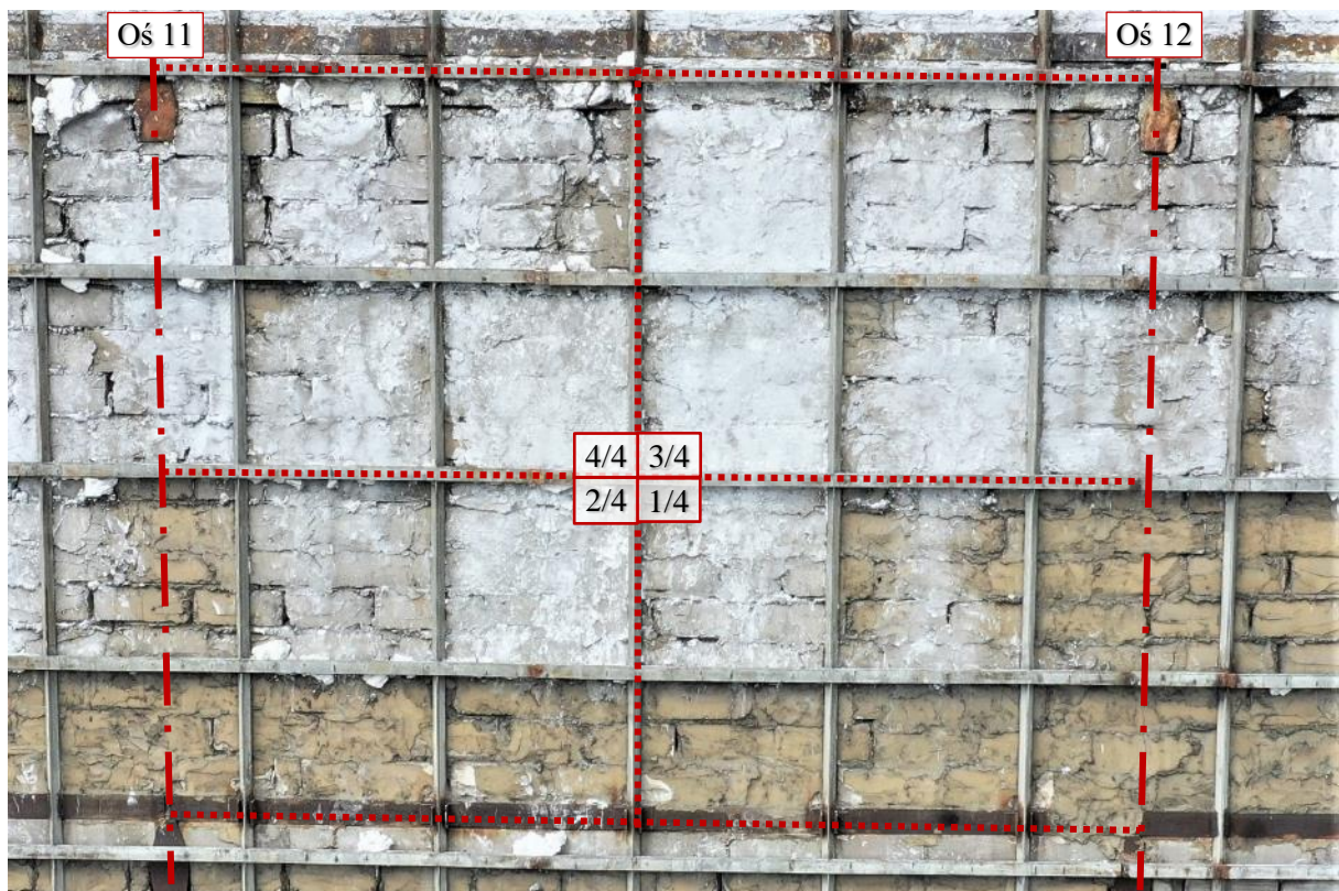
Fot. 186 Piętro 20 (Poziom +71.40) Elewacja Południowa – widok ściany w osiach 11-12 / E – zewnątrz
