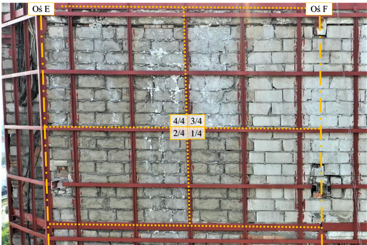
Fot. 161 Piętro 20 (Poziom +71.40) Elewacja Wschodnia – widok ściany w osi 14 / E-F – zewnątrz
