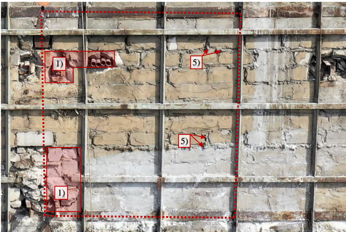
Fot. 97 Piętro 19 (Poziom +68.10) Elewacja Zachodnia – widok ściany w osiach 10 / E-F – Część 2/2
