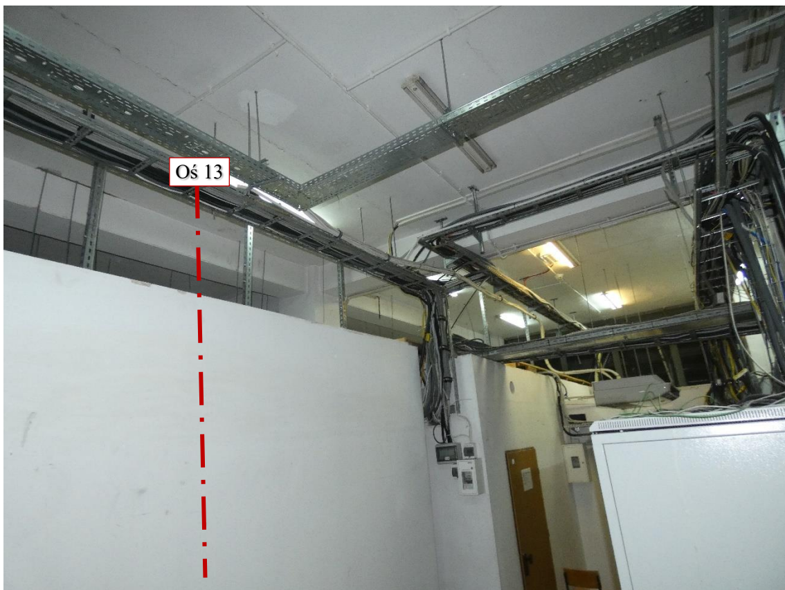
Fot. 174 Piętro 20 (Poziom +71.40) Elewacja Południowa – widok ściany w osiach 13-14 / E – wewnątrz
