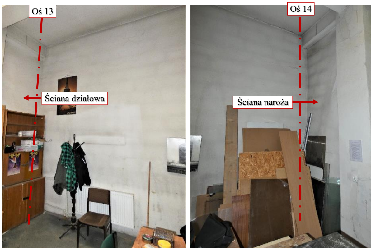
Fot. 137 Piętro 20 (Poziom +71.40) Elewacja Północna – widok ściany w osiach 13-14 / I – wewnątrz
