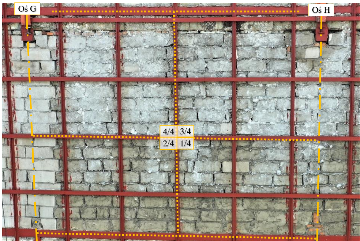
Fot. 148 Piętro 20 (Poziom +71.40) Elewacja Wschodnia – widok ściany w osi 14 / G-H – zewnątrz
