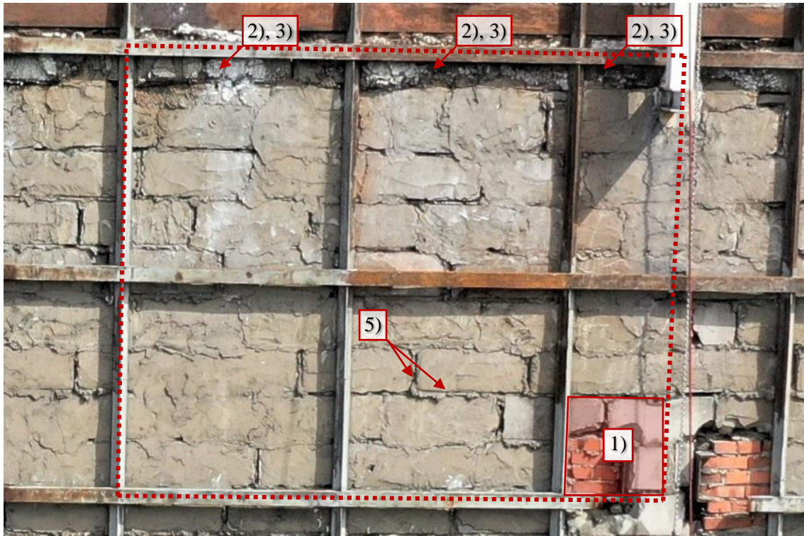
Fot. 230 Piętro 20 (Poziom +71.40) Elewacja Zachodnia – widok ściany w osiach 10 / G-H – Część 3/4
