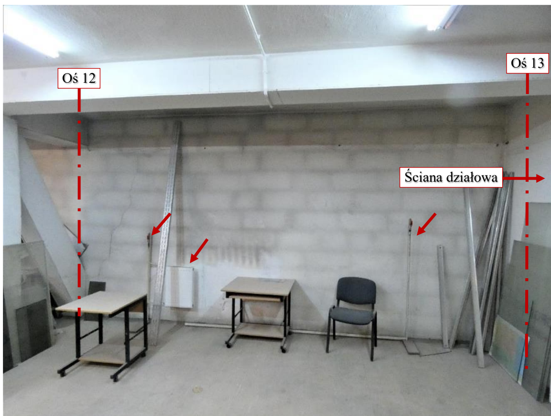
Fot. 29 Piętro 19 (Poziom +68.10) Elewacja Północna – widok ściany w osiach 12-13 / I – wewnątrz
