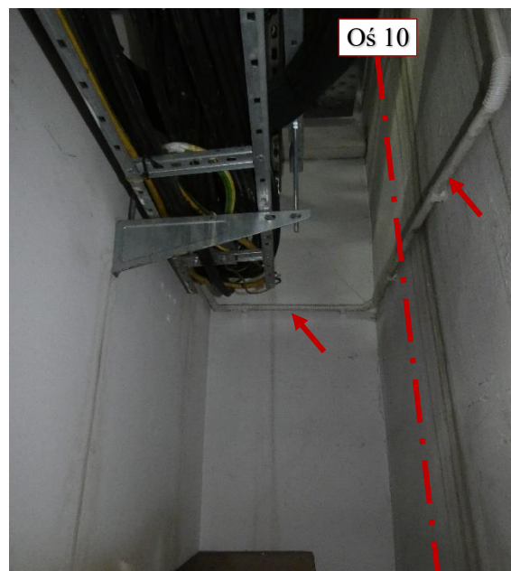
Fot. 209 Fot. 193 Piętro 20 (Poziom +71.40) Elewacja Południowa – widok naroża ściany w osi 10 / E – wewnątrz
