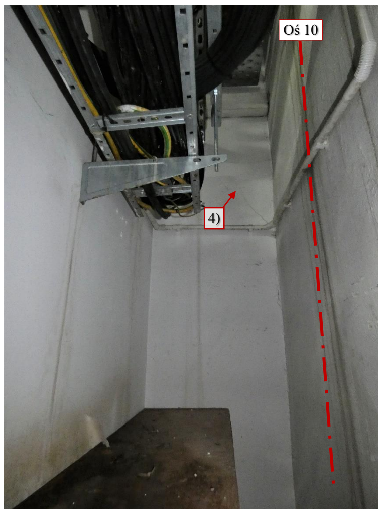
Fot. 202 Piętro 20 (Poziom +71.40) Elewacja Południowa – widok ściany w osiach 10-11 / E – wewnątrz
