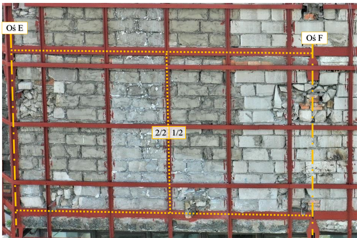
Fot. 56 Piętro 19 (Poziom +68.10) Elewacja Wschodnia – widok ściany w osiach 14 / E-F – zewnątrz
