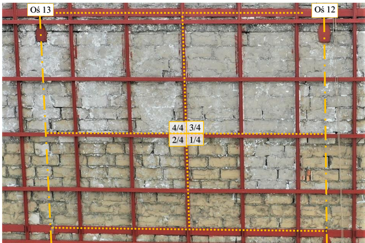
Fot. 130 Piętro 20 (Poziom +71.40) Elewacja Północna – widok ściany w osiach 12-13 / I – zewnątrz
