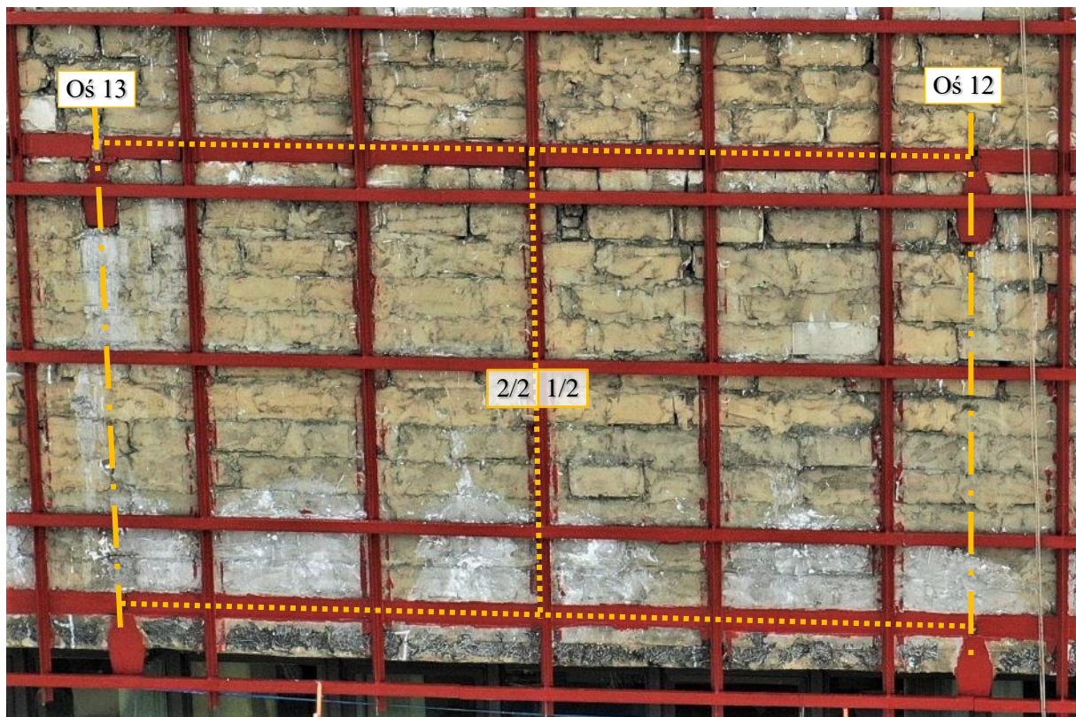
Fot. 28 Piętro 19 (Poziom +68.10) Elewacja Północna – widok ściany w osiach 12-13 / I – zewnątrz
