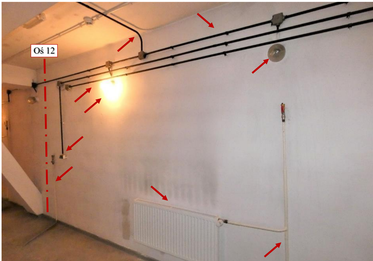
Fot. 80 Piętro 19 (Poziom +68.10) Elewacja Południowa – widok ściany w osiach 11-12 / E – wewnątrz
