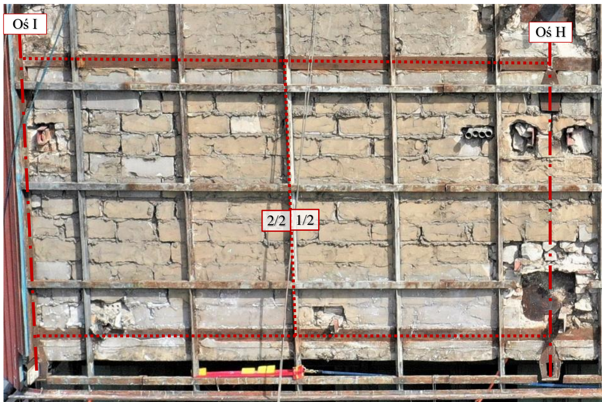
Fot. 108 Piętro 19 (Poziom +68.10) Elewacja Zachodnia – widok ściany w osiach 10 / H-I – zewnątrz
