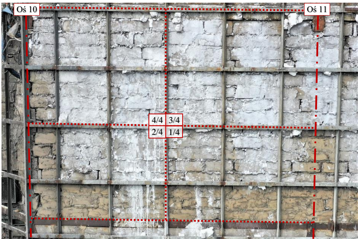
Fot. 197 Piętro 20 (Poziom +71.40) Elewacja Południowa – widok ściany w osiach 10-11 / E – zewnątrz
