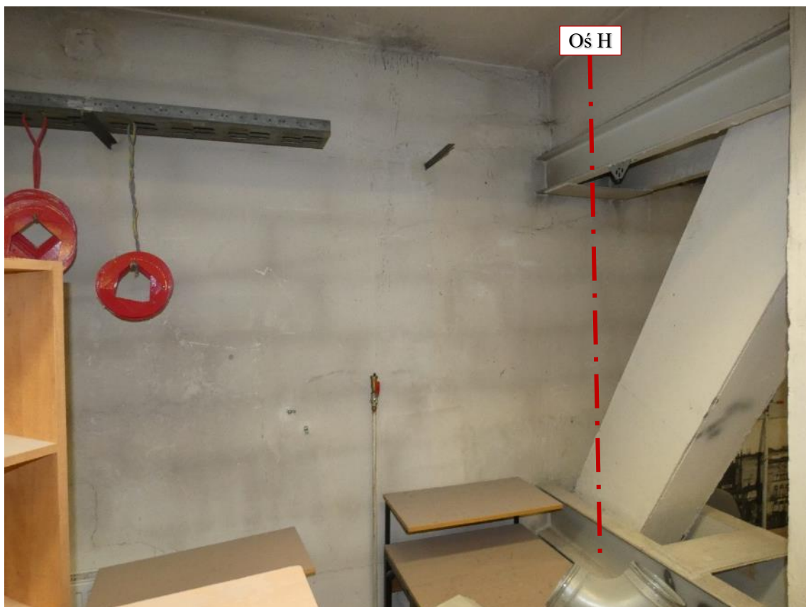
Fot. 104 Piętro 19 (Poziom +68.10) Elewacja Zachodnia – widok ściany w osiach 10 / G-H – wewnątrz
