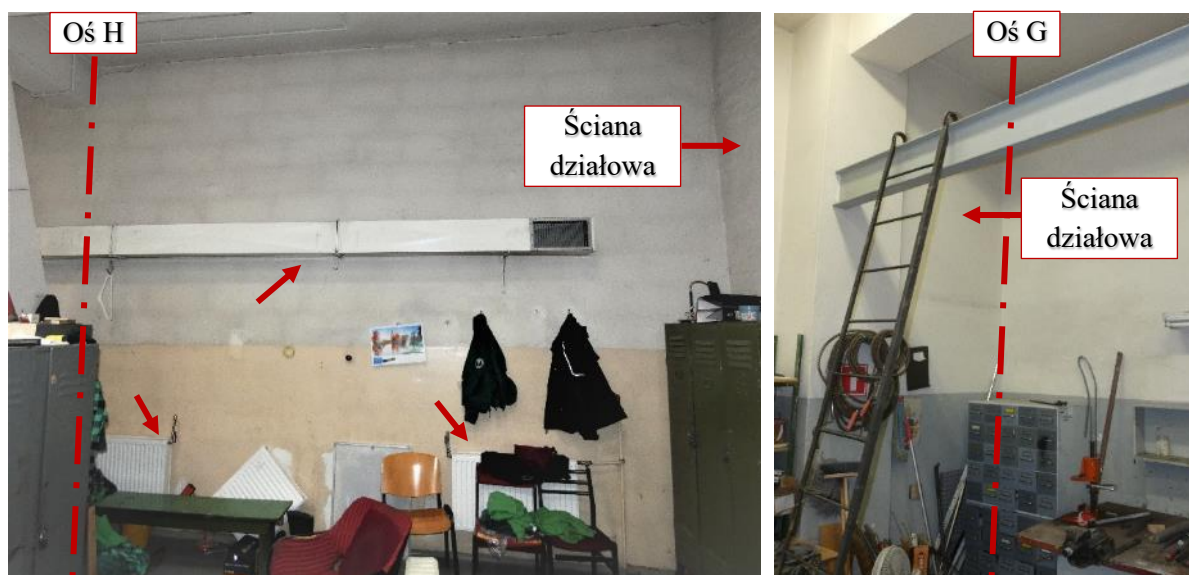
Fot. 149 Piętro 20 (Poziom +71.40) Elewacja Wschodnia – widok ściany w osi 14 / G-H – wnętrze
