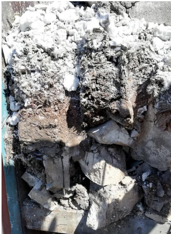
Fot. 6, 7 Gruz i materiał biologiczny w miejscu ubytków w murze oraz przestrzeni między murem, a elewacją z blachy trapezowej.
