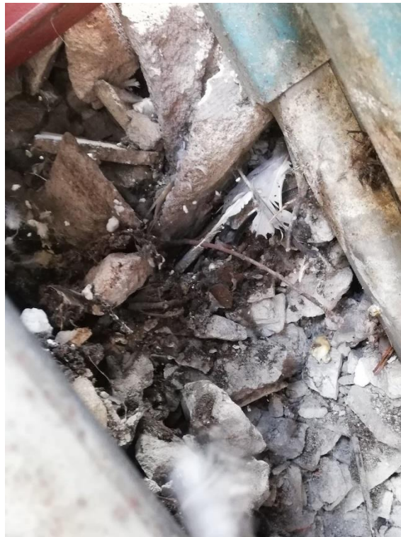
Fot. 6, 7 Gruz i materiał biologiczny w miejscu ubytków w murze oraz przestrzeni między murem, a elewacją z blachy trapezowej.
