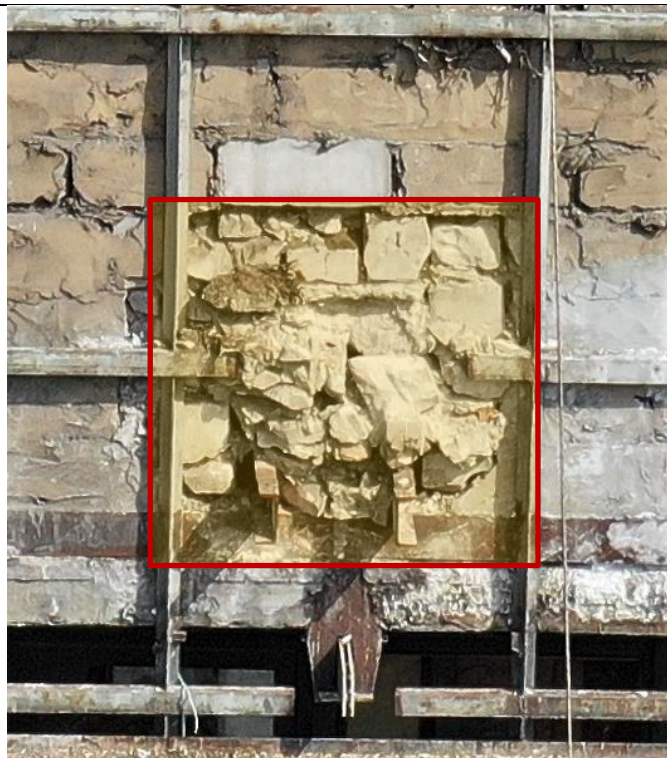
Fot. 32 Przykład fragmentu ściany murowanej do wymiany
