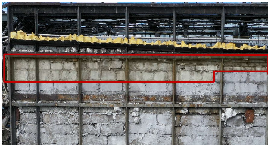
Fot. 26 Stropodach (Poziom +76.09) Elewacja Południowa – widok ściany murowanej w osiach 10-11/E.
