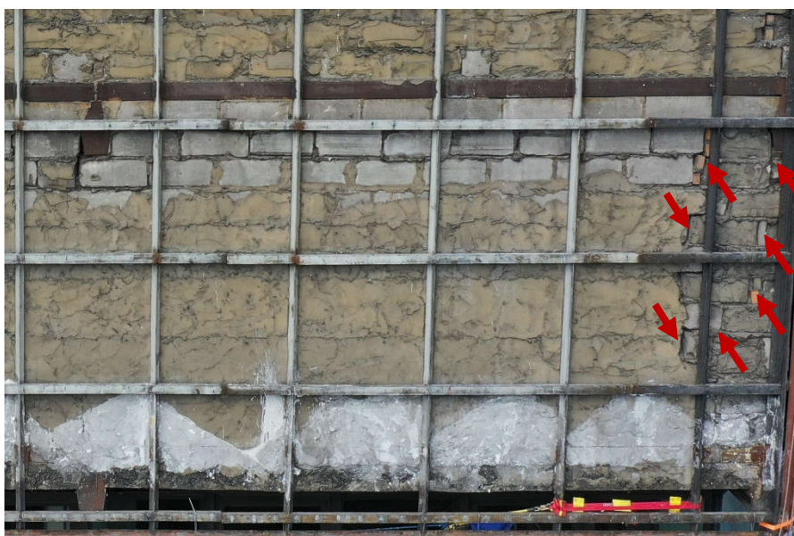
Fot. 17 Piętro 19 (Poziom +68.10) Elewacja Południowa – widok ściany murowanej w osiach 13-14/E. Zbyt duże wymiary spoin. Ubytki spoin pionowych i niewłaściwe przewiązania elementów. Ubytki między elementami wypełnione ceramicznymi elementami murowymi, zaprawą i gruzem.
