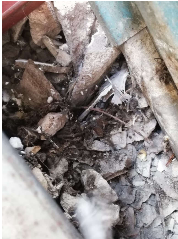
Fot. 5, 6 Gruz i materiał biologiczny w miejscu ubytków w murze oraz przestrzeni między murem, a elewacją z blachy trapezowej.
