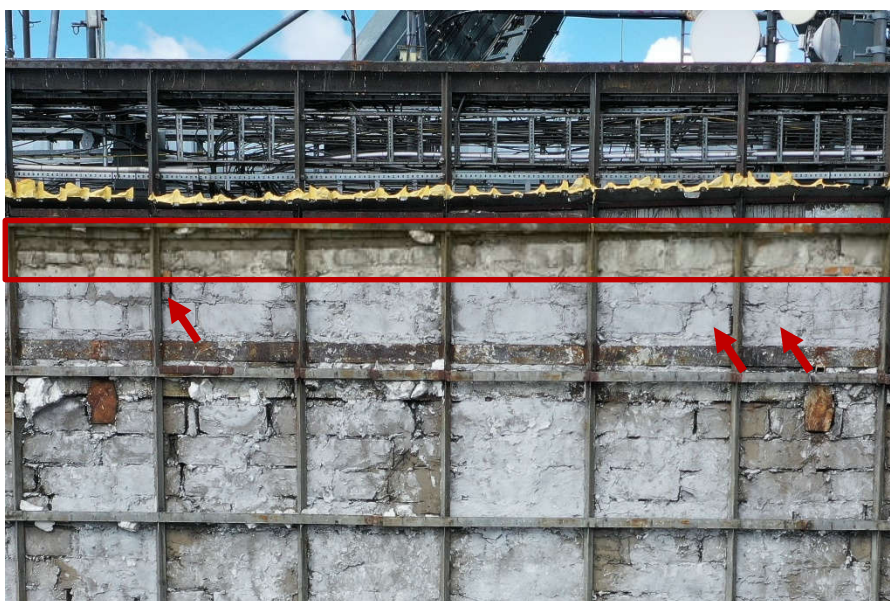
Fot. 27 Stropodach (Poziom +76.09) Elewacja Południowa – widok ściany murowanej w osiach 11-12/E.
