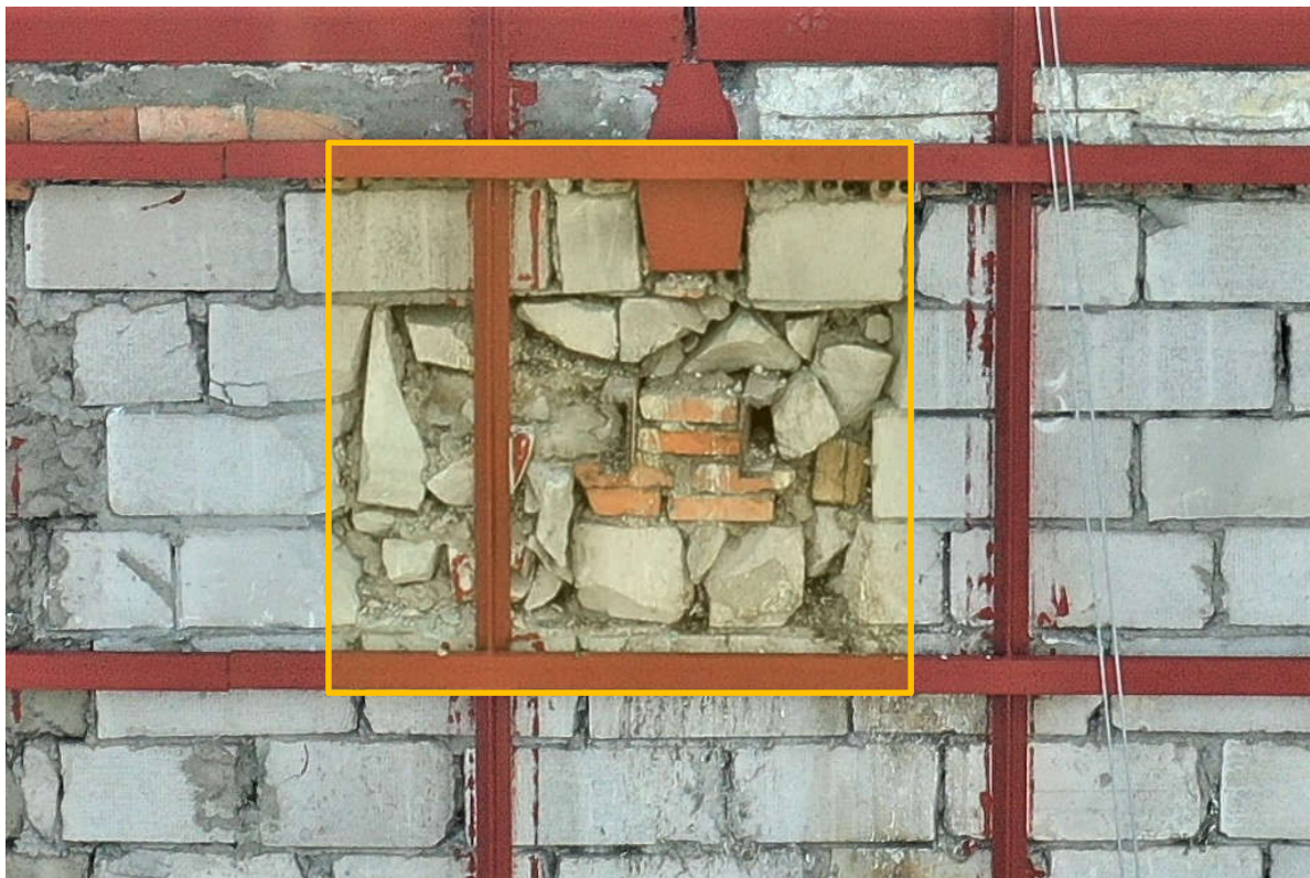
Fot. 31 Przykład fragmentu ściany murowanej do wymiany
