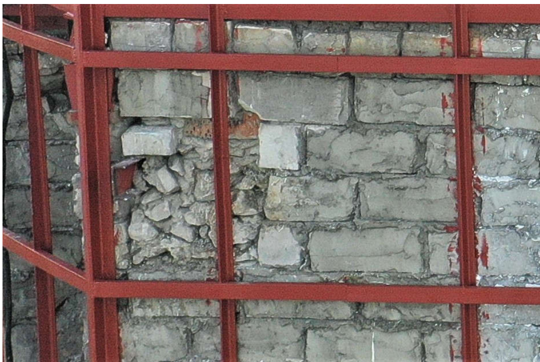
Fot. 1 Widok ściany murowanej o bardzo niskiej jakości wykonania (otwory w ścianie wypełnione zaprawą i gruzem)
