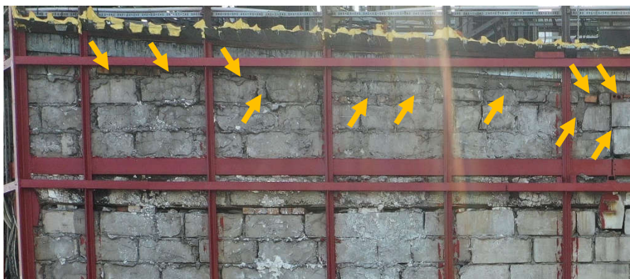
Fot. 26 Stropodach (Poziom +76.09) Elewacja Wschodnia – widok ściany murowanej w osiach 14/E-F.
