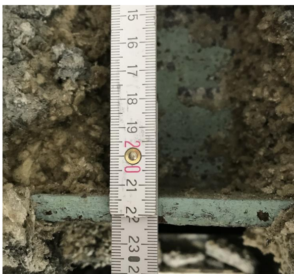
Fot. 3 Odkrywka 1 - Belka stalowa Poz. 5.3 – Pomiar odległości od spodu belki do góry kątownika
