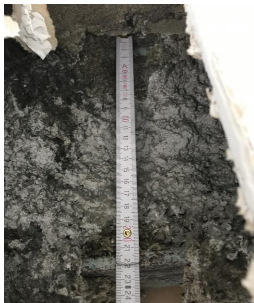
Fot. 6 Odkrywka 2 - Belka stalowa Poz. 5.3 – Pomiar wysokości kątownika
