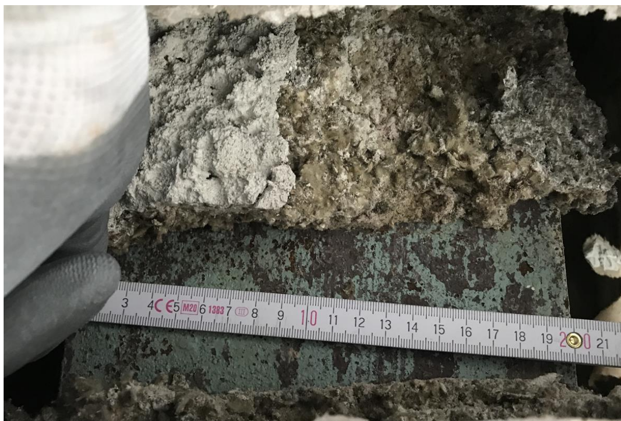
Fot. 5 Odkrywka 2 - Belka stalowa Poz. 5.3 – Pomiar szerokości pasa dolnego
