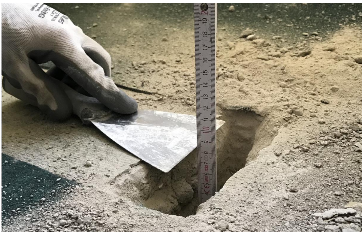
Fot. 7 Odkrywka 3 - Belka stalowa Poz. 5.3 – Pomiar grubości nadbetonu (od góry belki stalowej)
