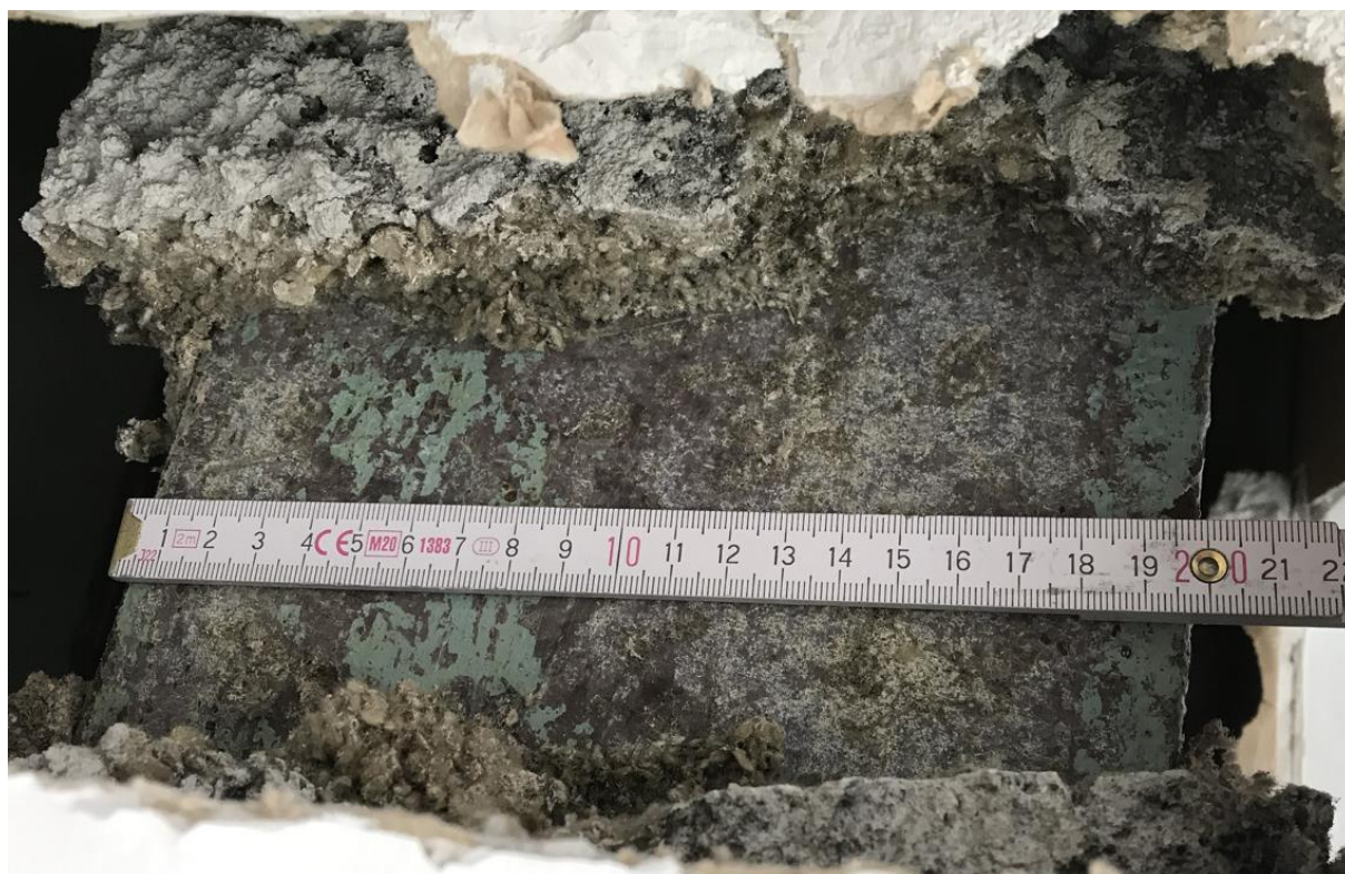
Fot. 1 Odkrywka 1 - Belka stalowa Poz. 5.3 – Pomiar szerokości pasa dolnego
