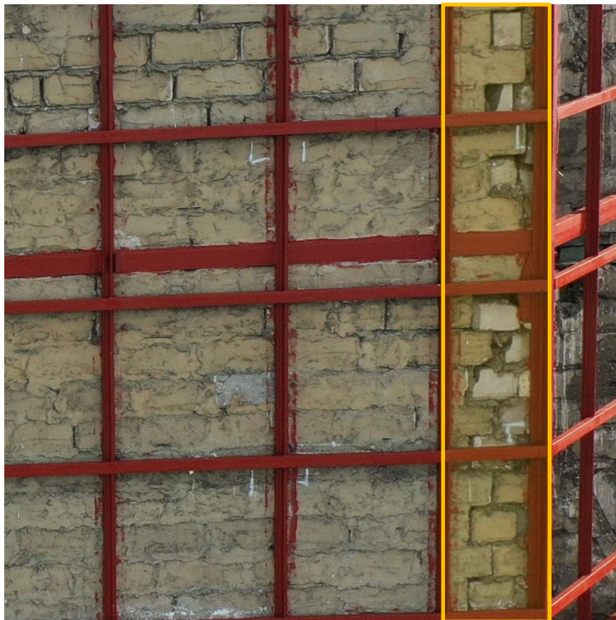
Fot. 26 Przykład fragmentu ściany murowanej do wymiany
