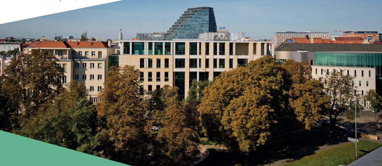
Widok na budynek C oraz D
